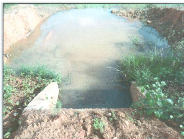
Foto 2 – Desobstrução do bueiro. Lado: Direito. Estaca: 3150. S 03.40163° W 052.74860° 13/02/2013.
