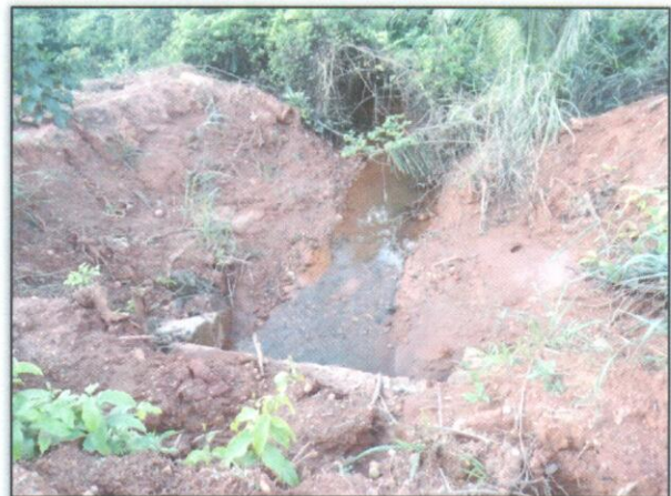
Foto 2 – Desobstrução do bueiro. Estaca: 3133. S 03. 40090° W 052. 74556° 13/02/2013.
