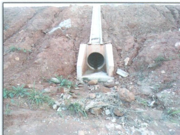
Foto 2 – Desobstrução do bueiro. Lado: Direito. Estaca: 3063. S 03.39729° W 052.73390° 13/02/2013.
