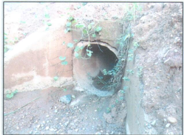
Foto 2 – Desobstrução do bueiro. Lado: Direito. Estaca: 3048. S 03.39630° W 052.73100° 13/02/2013
