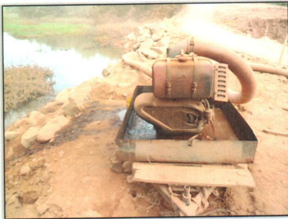
Foto 1 – Vazamento de óleo. Lado esquerdo. Estaca 2947. S 03.39049° W 052.71481° 14/08/2013
