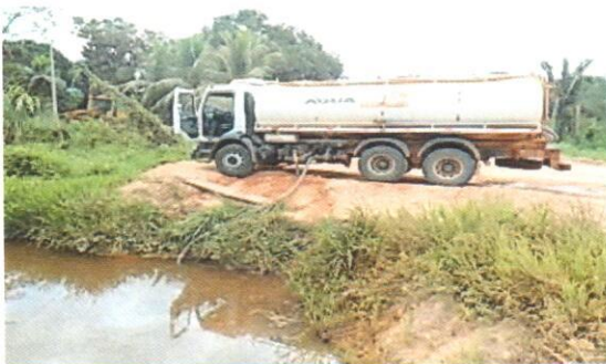
Foto 01 - Caminhão tanque sendo abastecido com água.
