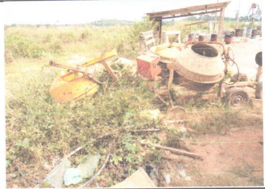
Foto 06 - Material (sucata) armazenado inadequadamente
