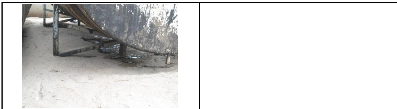
Foto 03 -vazamento de material betuminoso.
