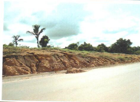
Foto 02 - Processo Erosivo na Saia do Aterro (Médio) (Km 590,96 Estaca 4840 UTM: 406374/9656683 Lado Esquerdo).
