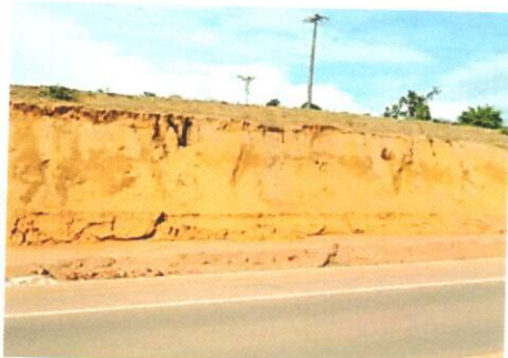
Foto 03 - Processo Erosivo na Faixa no Talude de Corte (Médio) (UTM: 406024/9656858 Lado Direito).
