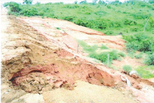
Foto 01 - Processo Erosivo na Saia de Aterro (Grave) (Km 576,92 estaca 4166 UTM: 419217/ 965072 Lado Direito).
