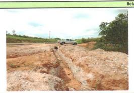
Foto 01 - Vista da drenagem com o material excedente.
