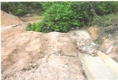
Foto 03 - Valeta de proteção.
