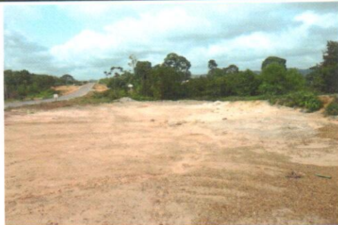
Foto 01 - Vista geral do material excedente de construção.
