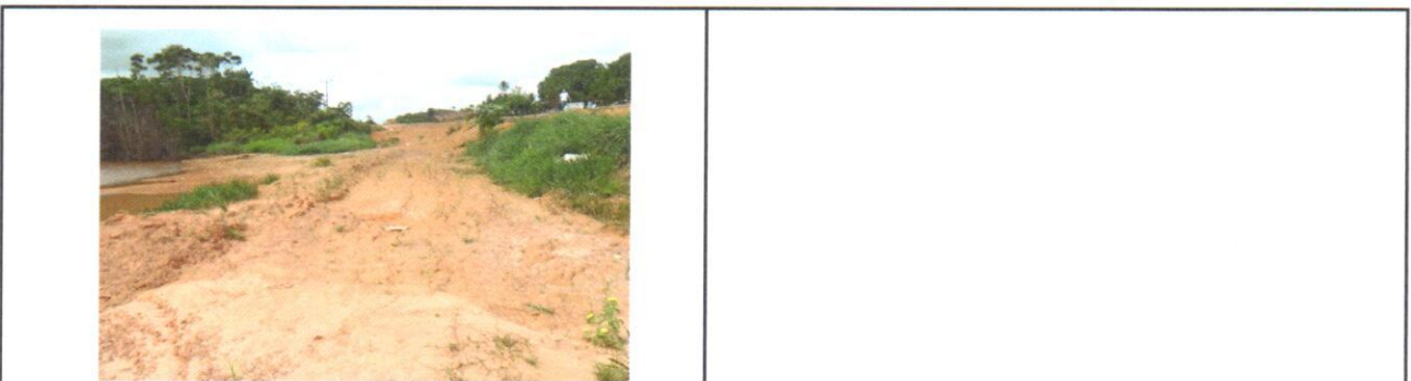
Foto 03 - Material excedente e/ou carregado à beira do córrego.
