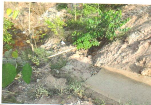
Foto 04 - Valeta de proteção (Lado Direito).
