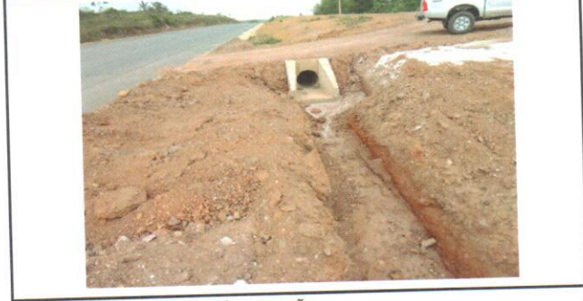
Foto 01 - Material excedente de escavação.
