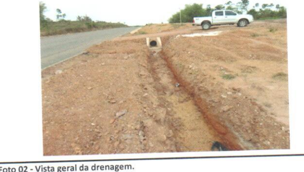
Foto 02 - Vista geral da drenagem.
