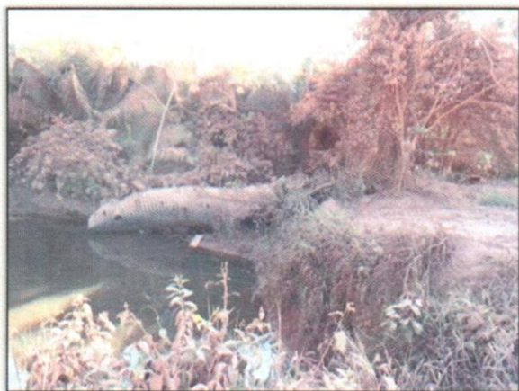
Foto 01 – Bueiro metálico em APP. Estaca 3155. Lado esquerdo. S 03.15285° W 051.57433° 06/08/2011
