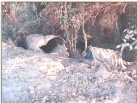
Foto 03 – Bueiro metálico em APP. Estaca 3155. Lado esquerdo. S 03.15285° W 051.57433° 06/08/2011
