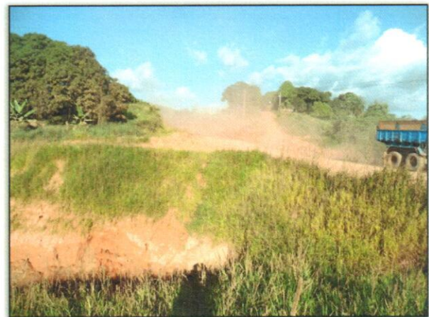
Foto 04 – Realizado hidrossemeadura para conter o processo erosivo. Estaca 4109. Lado Direito. S 03.13342° W 051.71781°. 04/07/2012.
