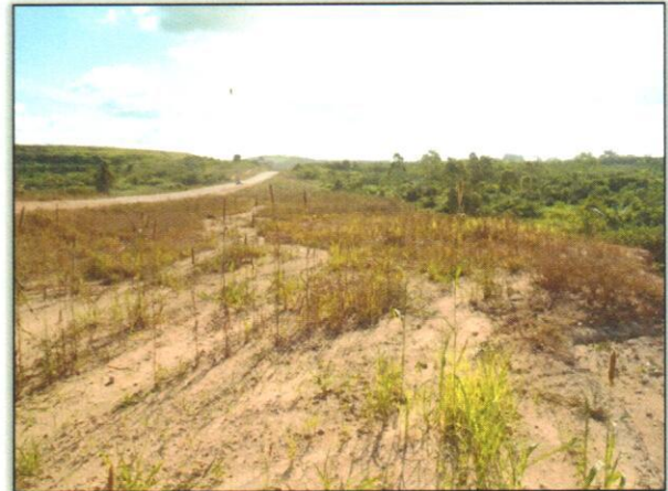
Foto 03 – Realizado hidrossemeadura e reconformação do aterro eliminado o processo erosivo. Estaca 4468. Lado Direito. S 03.12550° W 051.77995°. 04/07/2012.
