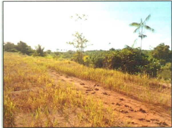
Foto 01 – Realizado hidrossemeadura e reconformação do processo erosivo. Estaca 4222. Lado Direito. S 03.12495° W 051.73584°. 04/07/2012.
