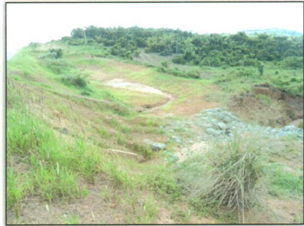
Foto 02 – Realizado hidrossemeadura e reconformação da saia do aterro, para conter o processo erosivo. Estaca 4840. Lado Direito. S 03.10783° W 051.83798°. 04/07/2012.
