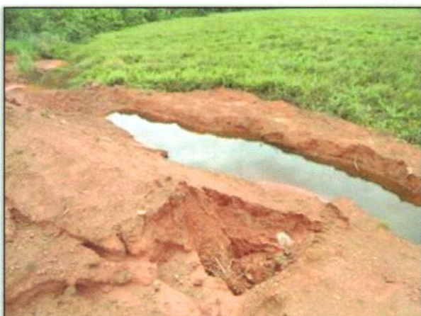
Foto 05 – Processo erosivo na saia do aterro. Estaca 4109. Lado Direito. S 03.13342° W 051.71781°. 10/02/2012.
