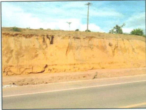
Foto 03 – Processos erosivos. Lado Direito. S 03. 10414° W 051. 84574°. 09/02/2012.
