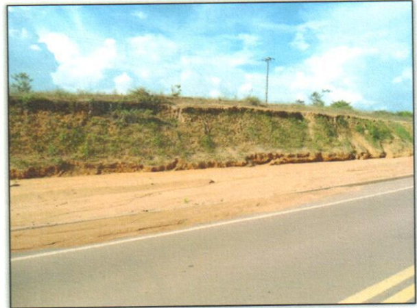
Foto 03 – Realizado hidrossemeadura para conter o processo erosivo. Lado Direito. S 03. 10414° W 051. 84574°. 28/06/2012.
