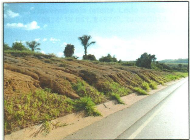
Foto 02 – Realizado hidrossemeadura para conter o processo erosivo. Estaca 4840. Lado Esquerdo. S 03. 10572° W 051. 84259°. 28/06/2012.
