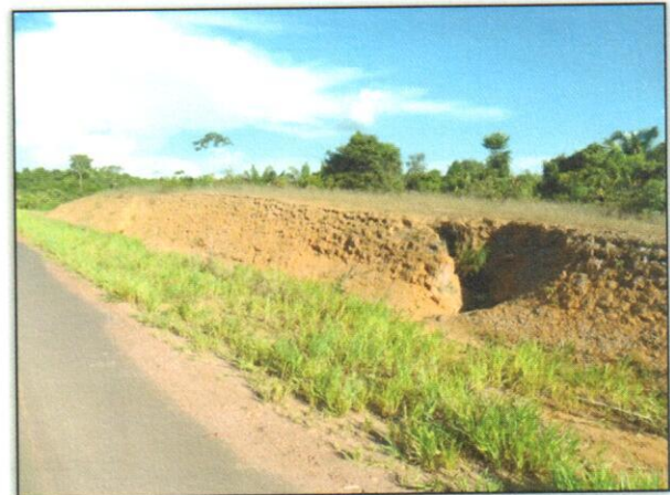
Foto 04 – Realizado hidrossemeadura, mas não houve a germinação total, recomenda-se que no próximo inverno seja refeita. Lado Esquerdo. S 03. 10414° W 051. 84574°. 28/06/2012.
