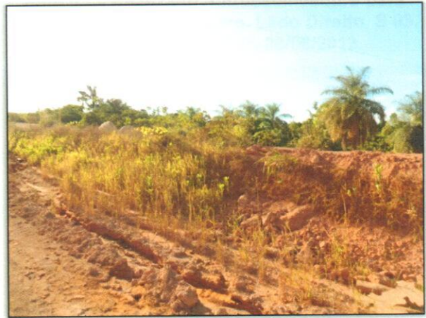
Foto 01 – Foi realizado hidrossemeadura para conter o processo erosivo e torná-lo mais estável. Lado Direito. S 03.13098° W 051.72387°. 28/06/2012.
