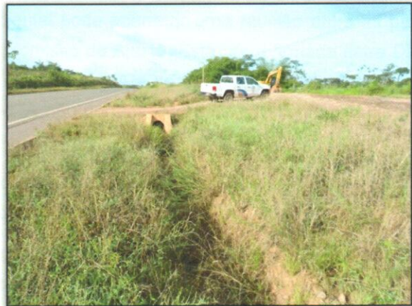
Foto 02 - Foi realizado hidrossemeadura e condução da regeneração natural. Estaca 6008 Lado Esquerdo. S 03.16281° W 052.00312° 04/06/2012
