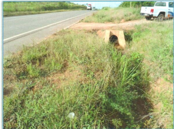
Foto 04 - Realizado hidrossemeadura, condução da regeneração natural e retirada do material excedente. Estaca 6008 Lado Esquerdo. S 03.16281° W 052.00312° 04/06/2012
