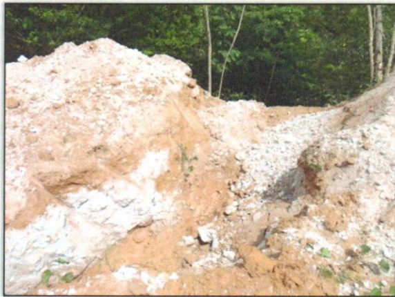
Foto 03 – Material excedente próximo à vegetação. Estaca 5832 Lado Direito. S 03.148898° W 051.974653° 08/12/2011.
