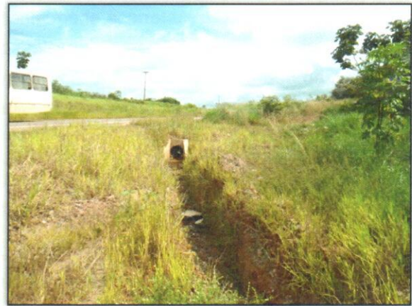
Foto 02 - Foi realizado hidrossemeadura e o material foi retirado. Estaca 5832 Lado Direito. S 03.148898° W 051.974653° 04/06/2012.
