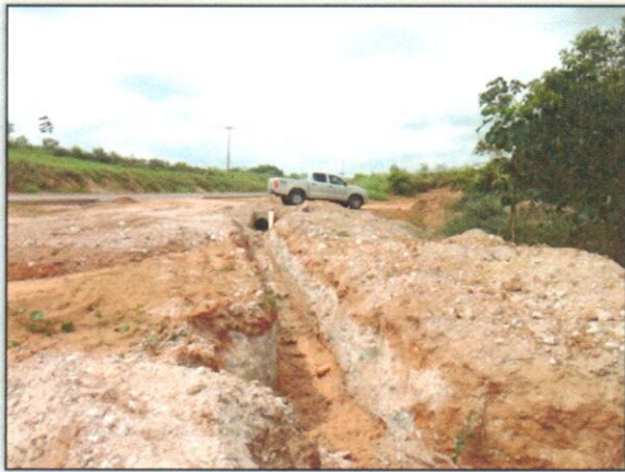
Foto 01 – Material excedente de escavação. Estaca 5832 Lado Direito. S 03.148898° W 051.974653° 08/12/2011.
