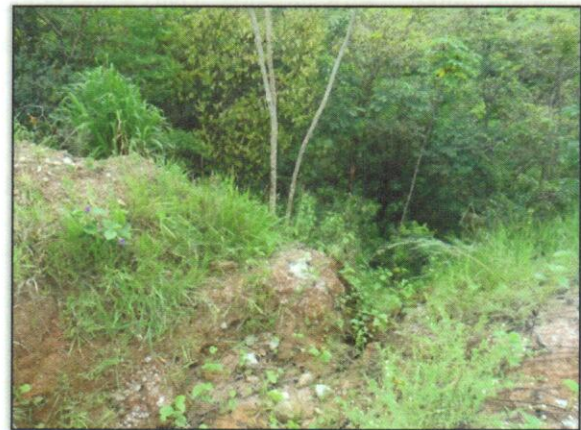
Foto 04 - Realizado hidrossemeadura e retirada do material. Estaca 5832 Lado Direito. S 03.148898° W 051.974653° 04/06/2012.
