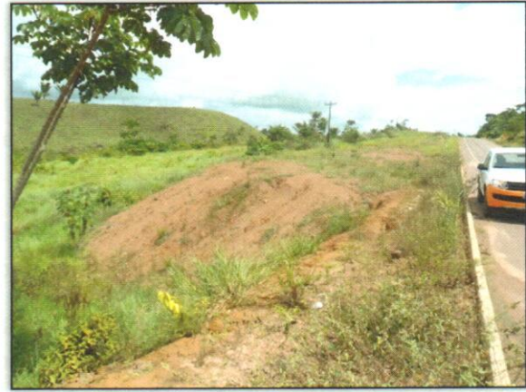
Foto 02 - Foi realizado hidrossemeadura e condução da regeneração natural para contenção da erosão. Estaca 6040 Lado Esquerdo. S 03.166434° W 052.007578° 04/06/2012.
