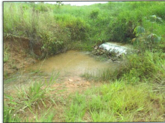
Foto 02 - Foi realizado hidrossemeadura e condução da regeneração natural. Estaca 6154 Lado Esquerdo. S 03.169761° W 052.027119° 04/06/2012
