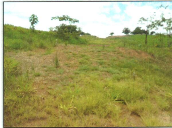
Foto 04 - Realizado hidrossemeadura, condução da regeneração natural para contenção da erosão. Estaca 6154 Lado Esquerdo. S 03.169761° W 052.027119° 04/06/2012
