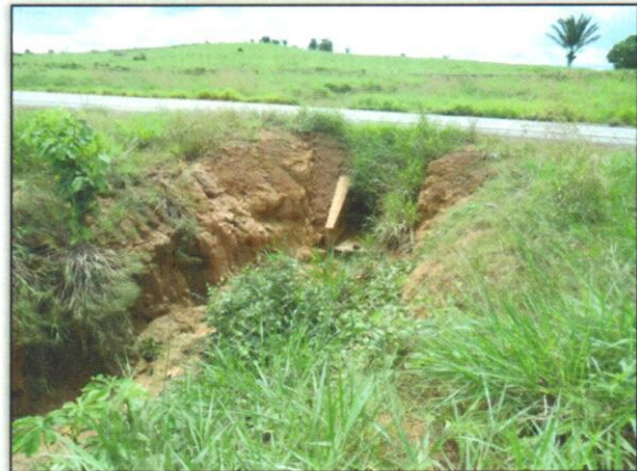
Foto 04 - Realizado hidrossemeadura, condução da regeneração natural. Estaca 6200 Lado Esquerdo. S 03.169780° W 052.035398° 04/06/2012
