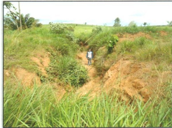
Foto 02 - Foi realizado hidrossemeadura e condução da regeneração natural. Estaca 6200 Lado Esquerdo. S 03.169780° W 052.035398° 04/06/2012
