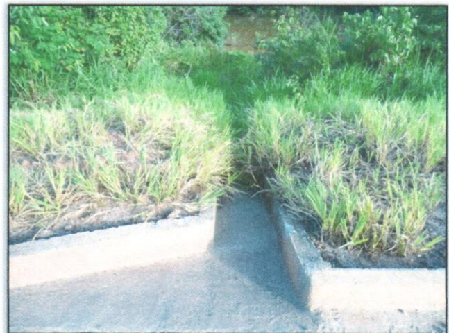
Foto 02: (Depois) Houve a construção do dispositivo de drenagem (descida d'água), hidrossemeadura e reconformação da saia de aterro. Lado esquerdo. 30/04/2013
