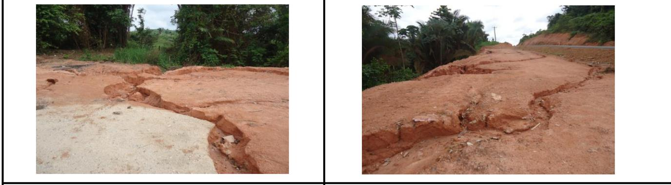
Foto 01 - Processo erosivo em aterro.
