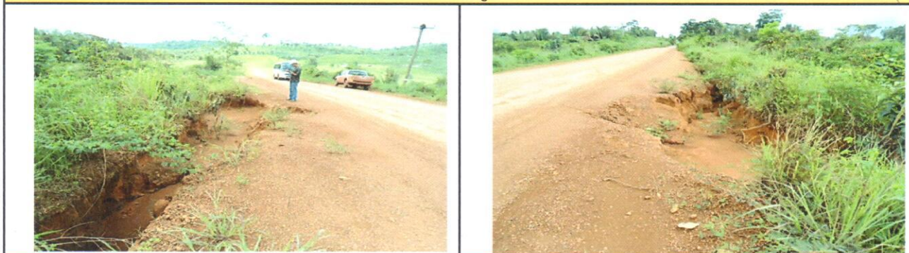
Foto 01 - Erosão lado esquerdo da pista devido a ausência de dispositivo de drenagem.
