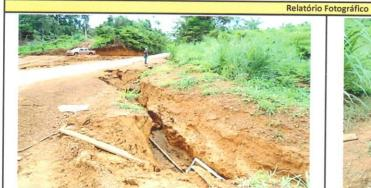
Foto 01 - Erosão lado direito da pista devido a ausência de dispositivo de drenagem.
