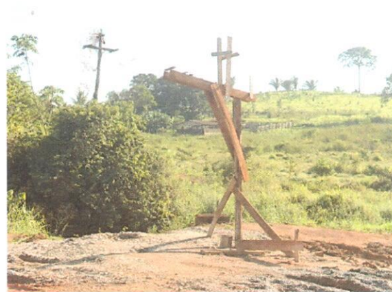
Foto 2 - (Depois) Bomba d'água retirada. Lado direito S 04.13232° W 050.23882° 24/07/2013.
