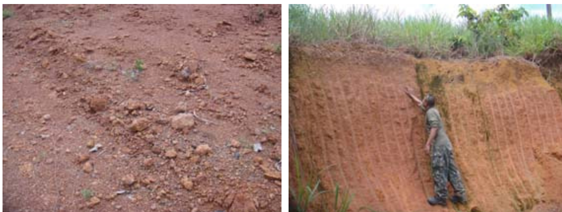
Figura 5 - Trecho com cascalho e talude mostrando a estratigrafia predominante ao longo da rodovia
