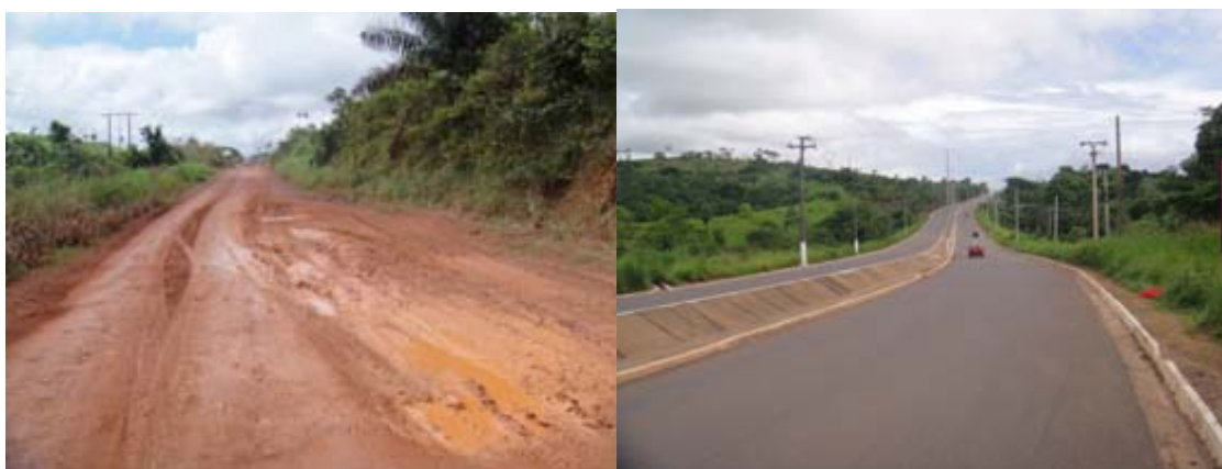
Figura 2 - Vista da rodovia na altura do km 12 e trecho pavimentado em Tucuruí
