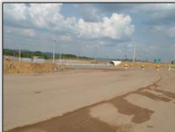
Foto 448 – Final do desvio da rodovia. Lado direito. S 03.12383° W 051.78881° 26/11/2013
