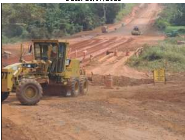
Figura 32. Aterro e terraplenagem em área da rodovia. Data: 05/08/2013
