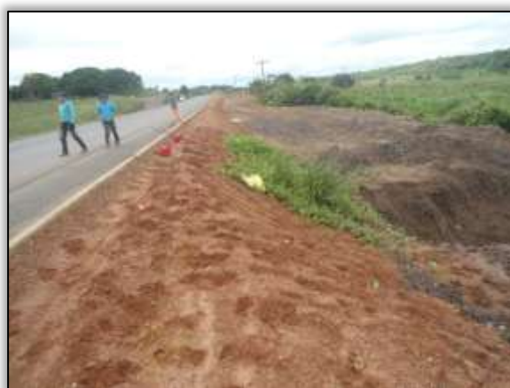
Foto 1201 - Coveamento para o plantio de gramíneas. Lado direito. S 03. 32950° W 052. 58120° 28/01/2014
