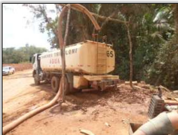
Foto 801 - Captação de água Igarapé. Jacarezinho. Lado esquerdo. Estaca 3950. S 03.39049° W 052.71481° 10/10/2013.
