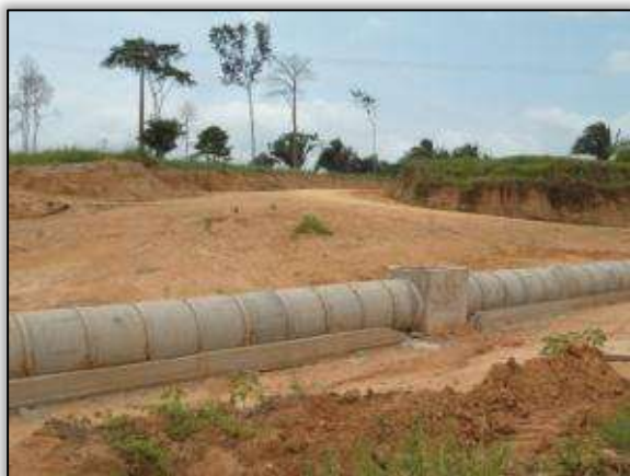
Foto 893 – Trevo na entrada da vicinal 12 no início da construção. Lado direito. S 03.28687° W 052.48946° 09/10/2013.
