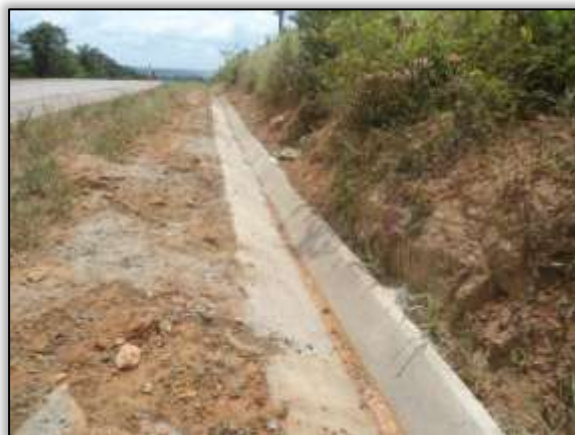
Foto 852 – Construção de valeta. Lado direito. Estaca 2557. S 03. 36918° W 052. 64856° 27/09/2013.
