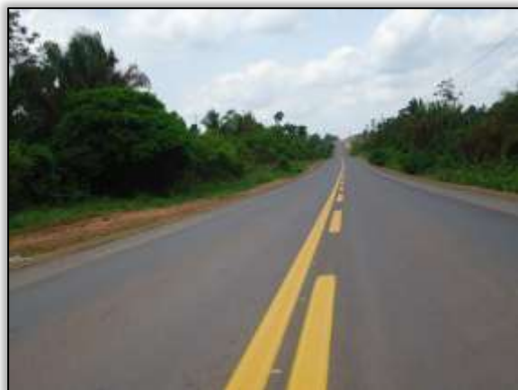
Foto 357 – Trecho entre os municípios de Novo Repartimento e Pacajá/PA – 18/12/13.
