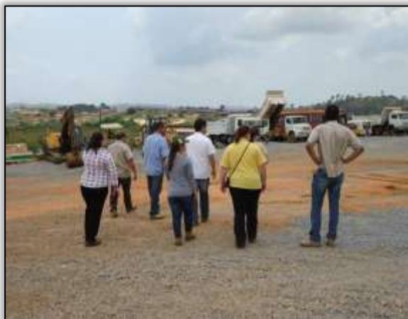
Foto 257- Os canteiros de obras das empresas de pavimentação também foram inspecionados. 17/10/2013.
