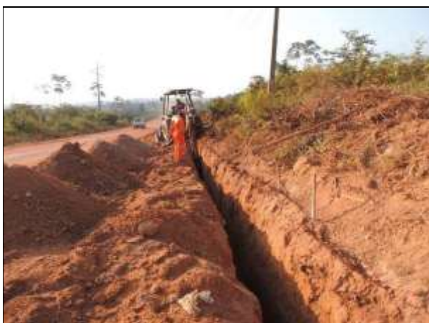
Figura 44. Abertura de vala para instalação de sistema de drenagem. Data: 26/10/2013
