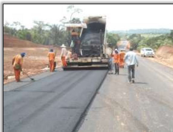
Foto 618 – Pavimentação da segunda camada. Estaca 5050. Lado esquerdo. S 03.54202° W 051.12212° 22/11/2013
