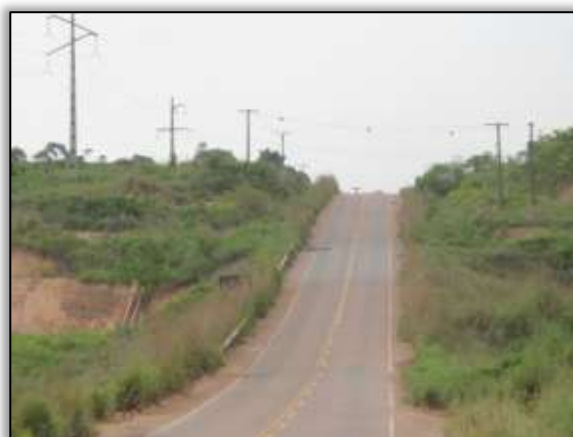
Foto 418 – Entrada para áreas de apoio do canteiro de obras. S 05.14985°W 049.38852° 03/12/2013
