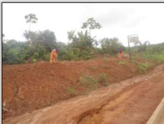
Foto 1187 – Semeadura manual. Lado esquerdo. Estaca 2168. S 03.33818° W 052.58723° 27/12/2013.
