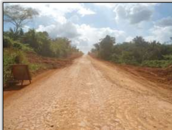
Foto 1218 – Limpeza da área. Lado Esquerdo e direito. Estaca 4987 a 4992. S 03.54960° W 051.11388° 24/08/2013
