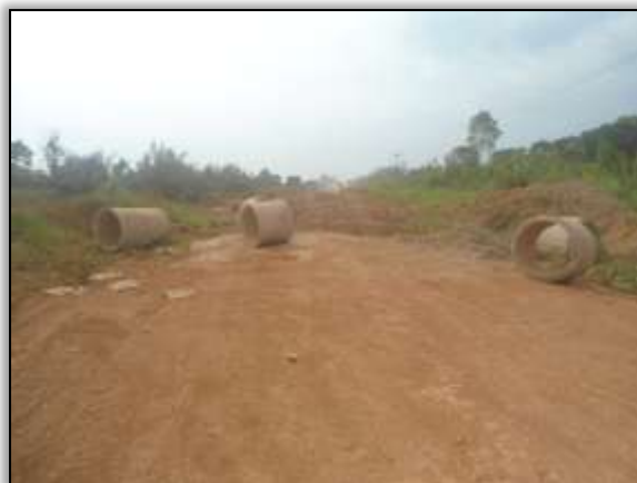
Foto 957 – Bueiro. Estaca 7920. S 03.85415° W 054.13615° 18/12/2013.
