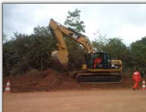
Foto 1212 – Atividade de limpeza da faixa de domínio. Lado esquerdo. Estaca 1995 lado esquerdo. S 05.17602° W 049.37257° 21/10/2013
