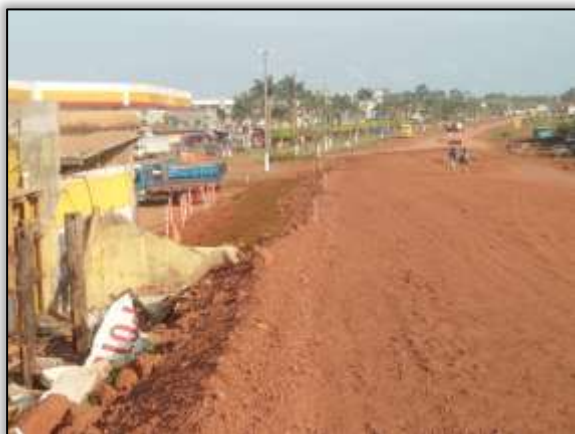
Foto 548 – Rodovia com base e sub-base. Lado esquerdo. S 04.25100° W 049.94584° 12/11/2013
