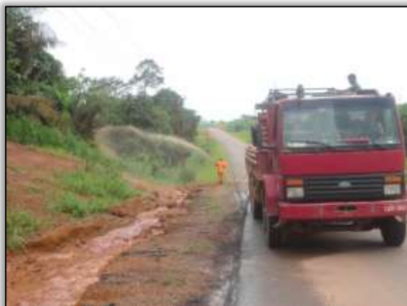
Foto 1074 – Regagem em saia de aterro. Lado esquerdo. S 04.00012º W 050.28678º 29/08/2013
