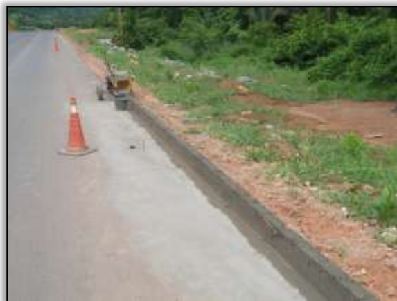
Foto 1135 – Construção de meio-fio. Lado direito. Estaca 4912. S 03.55598° W 051.10194° 24/01/2014
