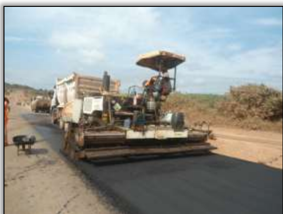
Foto 871 - Aplicação de asfalto. Estaca 2108 á 2132. S 03.33117° W 052.58248°17/10/2013.
