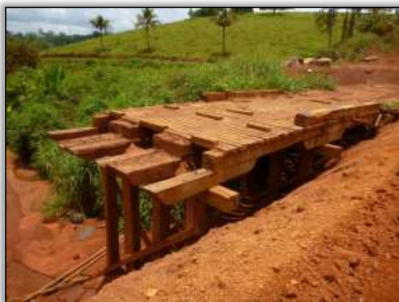
Foto 1457 – Ponto 50 – Ponte desativada. S 3.411988° W 52.777656° (09/10/2013).
