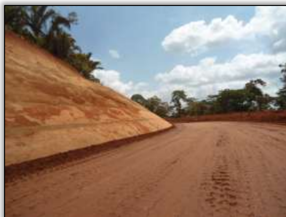
Foto 844 – Corte de talude. Lado esquerdo. S 03.43042° W 052.81324° 17/09/2013
