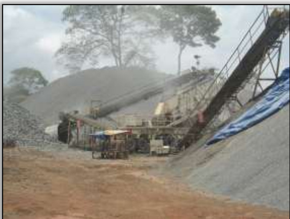
Foto 762 - Britador Sanches Tripoloni. Lado direito. Estaca 3775. S 03.44206° W 052. 85213° 10/10/2013
