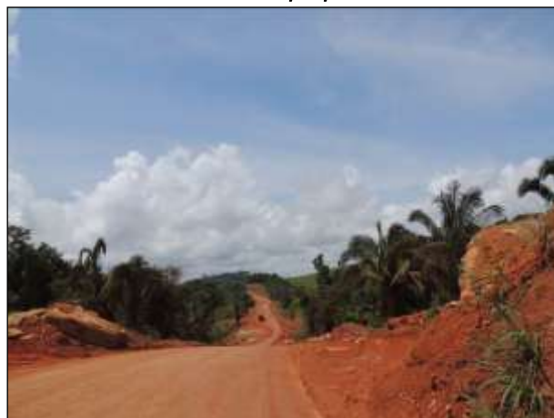
Figura 35. Trecho em obras de terraplenagem na rodovia. Data: 01/09/2013
