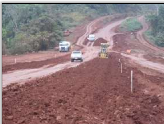
Foto 885 – Terraplanagem. Estaca 3754. S 03.44230° W 052.84764° 13/11/2013.
