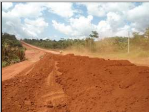
Foto 825 – Material para terraplanagem. Estaca 3542. S 03. 43032° W 052. 81293° 20/08/2013.
