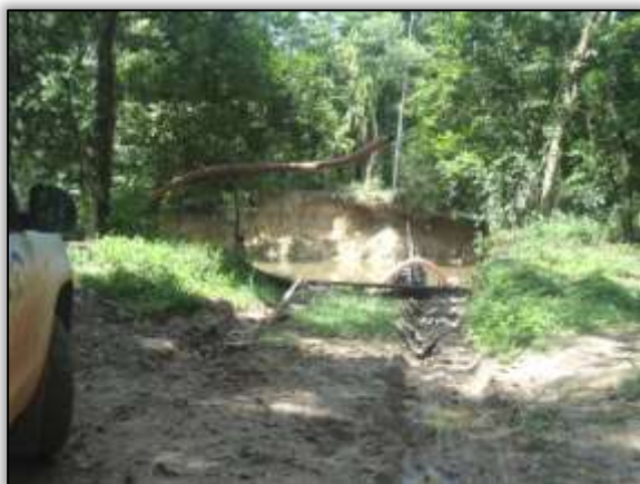
Foto 975 - Retirada de areia. Lado esquerdo. S 03.90013° W 054.27929° 02/12/2013.
