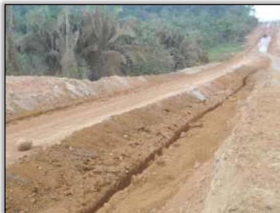
Foto 639 – Corte para dreno profundo. Lado direito e esquerdo. Estaca 5010. S 03.54778° W 051.11627° 23/10/2013
