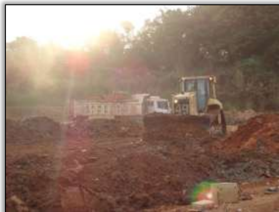
Foto 506 – Atividades de limpeza em faixa de domínio. Lado direito. S 04.24188° W 049.95153° 01/10/2013.
