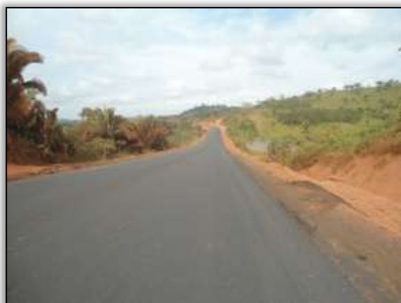
Foto 867 - Primeira camada asfáltica. Estaca 2056. S 03.32354° W 052.57369°. 17/10/2013.
