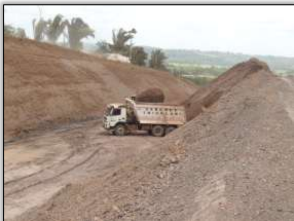
Foto 839 – Corte em talude. Lado direito. Estaca 2665. S 03.37709° W 052.66370° 17/09/2013.
