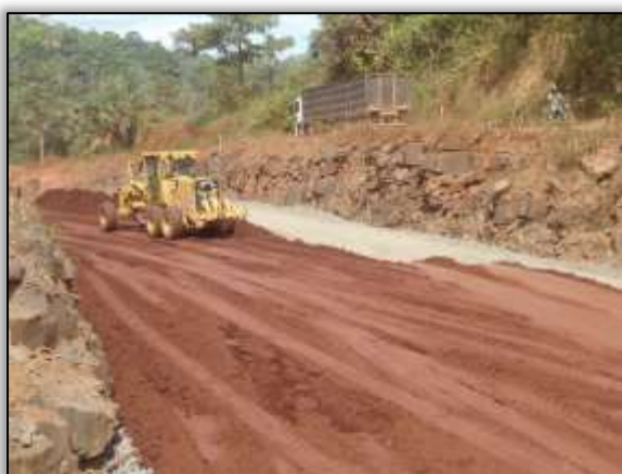
Foto 835 – Terraplanagem. estaca 3775. S 03.44206° W 052. 85213°. 20/08/2013.
