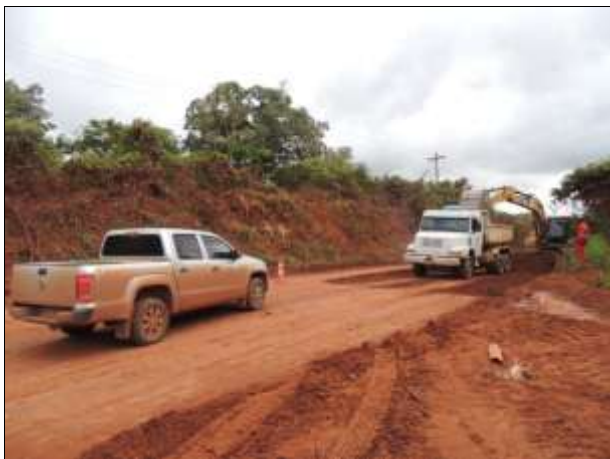
Figura 54. Equipe acompanhando obras de terraplenagem. Data: 07/11/2013 _ 22M 0797010 E / 9370268 N
