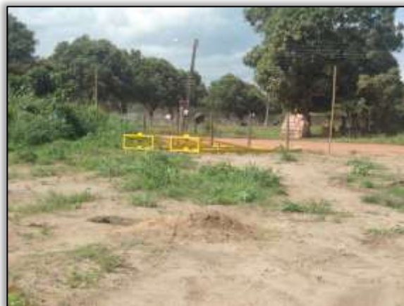
Foto 910 - Construção da fábrica de artefatos. Lado direito. S 03.866167° W 054.211694° 26/11/2013
