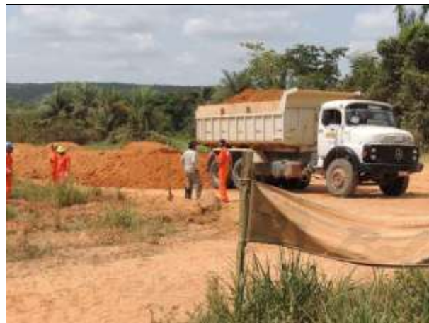
Figura 43. Bióloga do Consórcio orientando os trabalhadores da construtora. Data: 25/10/2013
