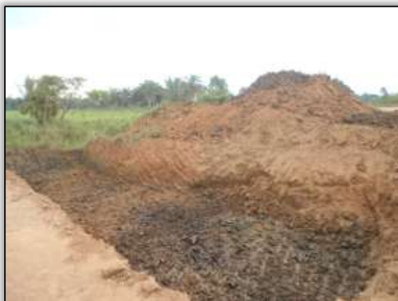
Foto 946 – Corte para Construção de bueiro. S 03.85095° W 054.15302° 11/11/2013.
