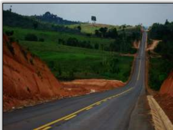
Foto 355 – Trecho entre os municípios de Novo Repartimento e Pacajá/PA – 18/12/13.
