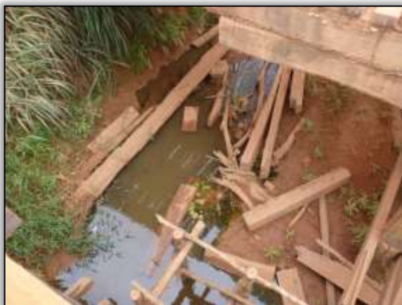
Foto 1359 – Ponto 26 – Montante – Toras de madeira. 4.024942°S 50.286151° W (12/10/2013).
