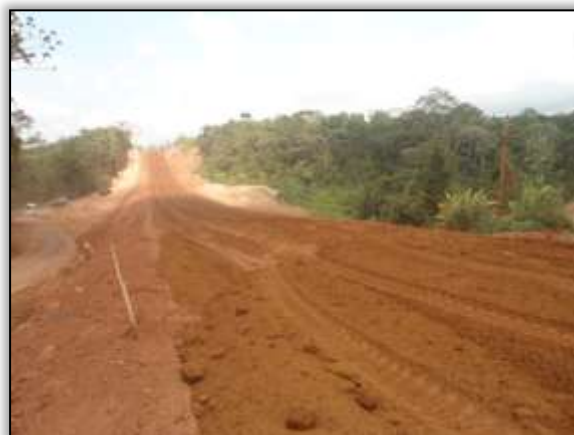
Foto 864 - Terraplenagem. Estaca 2943. S 03.39023° W 052.71381°. 10/10/2013.
