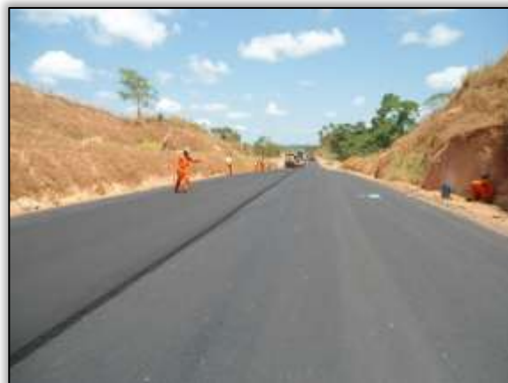
Foto 681 – Pavimentação asfáltica (2ª camada). Lado esquerdo. Estaca 3436. S 03.11900° W 051.61111° 25/09/2013
