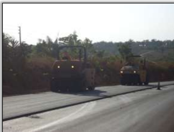
Foto 533 – Compactação asfáltica. Lado esquerdo. S 04.13449° W 050.58217° 01/10/2013
