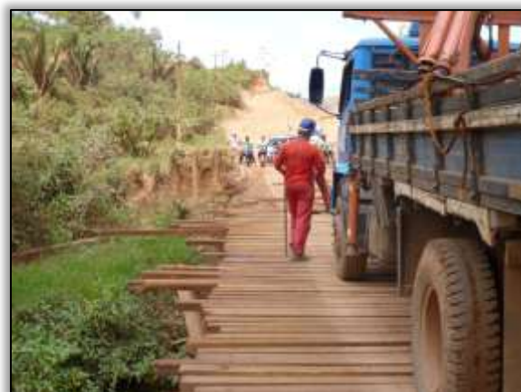
Foto 1440 – Ponto 47 – Manutenção na ponte. 3.320154° S 52.567838° W (09/10/2013).
