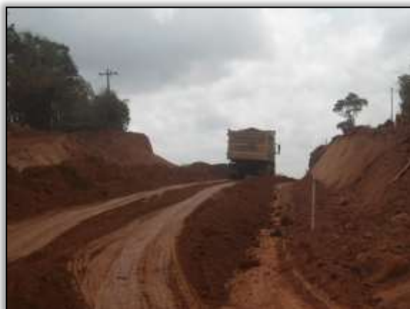
Foto 863 - Terraplenagem. Estaca 2943. S 03.39023° W 052.71381°. 10/10/2013.
