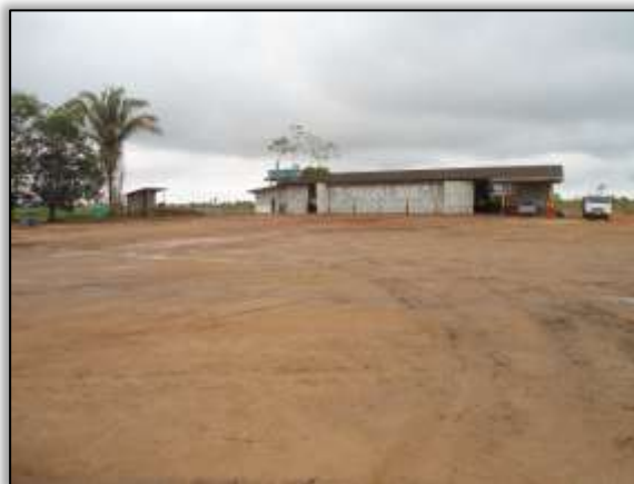
Foto 498 – Área do canteiro de obras. S 05.14392° W 049.35747° 12/11/2013
