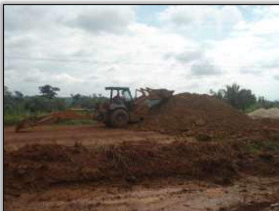
Foto 1007 - Reconformação do caminho de serviço. Lado direito. S 03.89169° W 054°33546° 21/11/2013.
