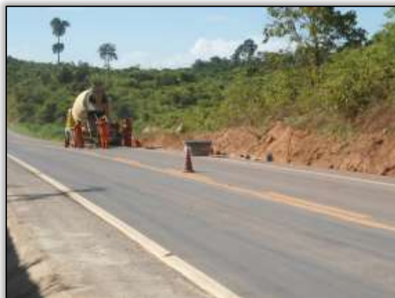
Foto 711– Construção de sarjeta. Estaca 4160. Lado Direito. S 03.13045° W 051.72620° 07/01/2014
