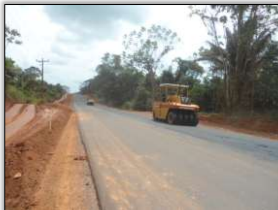
Foto 878 - Pavimentação da rodovia. Estaca 3406. S 03.41692° W 052.79198°. 23/10/2013.
