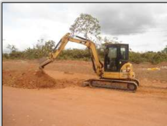
Foto 638 – Corte para dreno profundo. Lado direito. Estaca 4882. S 03.55746° W 051.09523° 30/10/2013
