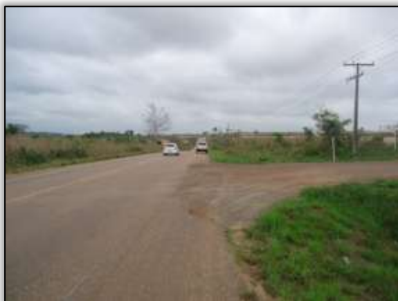
Foto 403 – Entrada para áreas de apoio do canteiro de obras. S 05.14985°W 049.38852° 17/09/2013
