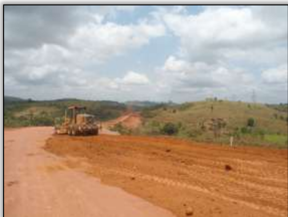
Foto 659 – Atividades de terraplenagem. Lado direito. Estaca 1080. S 03.84670° W 050.51788° 10/10/2013
