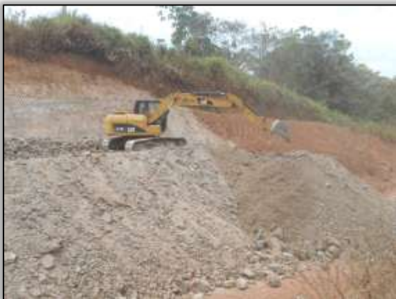
Foto 821 – Corte em talude. Lado direito. S 03. 39043° 052. 71729° 20/08/2013.
