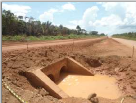
Foto 942 - Bueiro concluído. S 03.86229° W 054.19547°. 24/01/2014.
