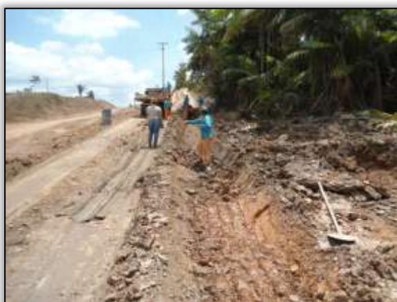
Foto 841 – Construção de valeta de drenagem. Lado direito. Estaca 2656. S 03.37706° W 052.66374° 17/09/2013.
