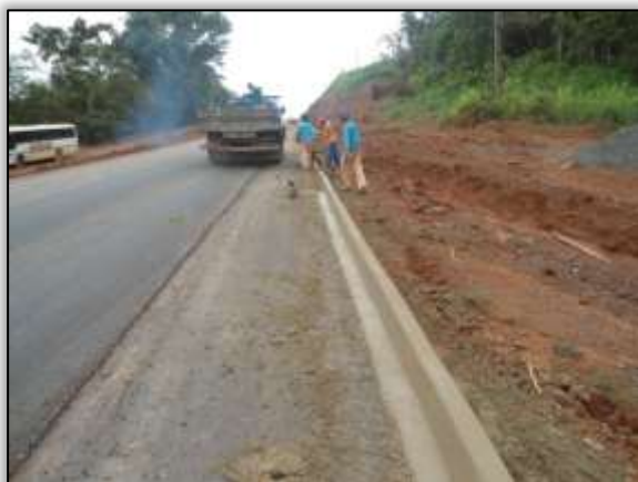
Foto 1160 – Construção de meio fio. Lado esquerdo. S 03.39028° W 052.71560° 20/11/2013.
