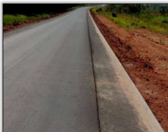
Foto 29- Andamento da pavimentação do lote 04 (sentido Anapu/Altamira).
