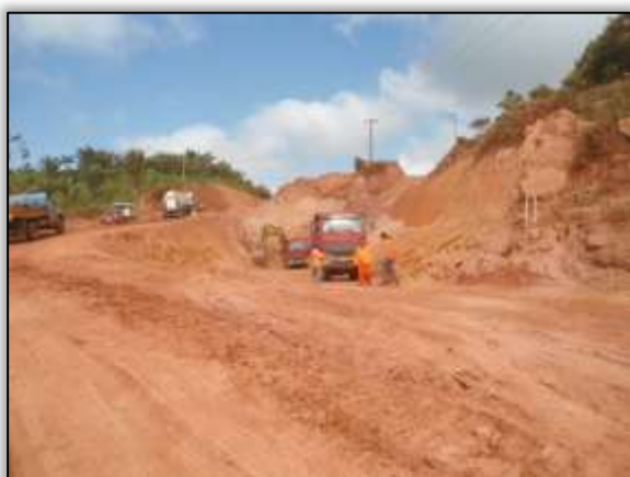
Foto 595 – Conformação do off set da rodovia. Lado direito. Estaca 1222. S 03.84615° W 050.54139° 07/08/2013
