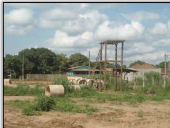
Foto 972 - Construção da fábrica de artefatos. Lado direito. S 03.866167° W 054.211694° 26/11/2013
