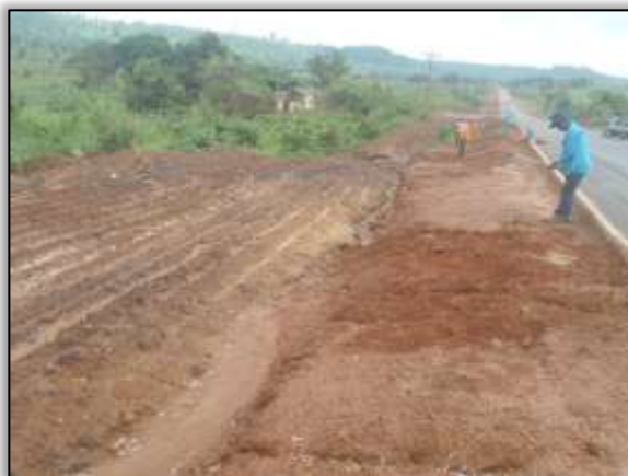
Foto 1188 – Semeadura manual. Lado esquerdo. Estaca 2168. S 03.33818° W 052.58723° 27/12/2013.
