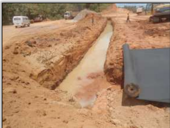
Foto 625 – Drenagem provisória. Lado esquerdo. Estaca 4770. S 03.57115° W 051.08320° 11/09/2013
