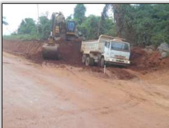
Foto 811 – Corte em talude. Estaca 3424. Lado esquerdo. S 03.41853° W 052. 79511° 14/08/2013
