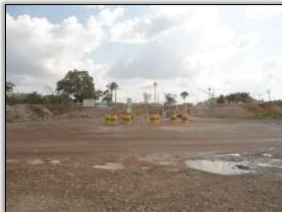
Foto 442 – Acesso ao canteiro de obras do CCBM. Lado esquerdo. S 03.12284° W 051.79378° 23/10/2013
