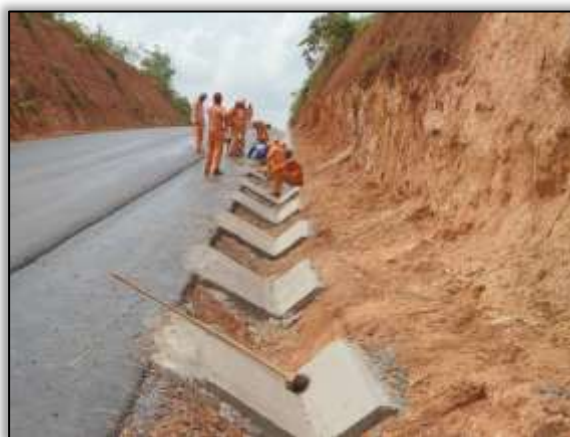
Foto 1119 – Descida d'água em fase instalação. Lado esquerdo. S 04.19574º W 050.01311º 12/11/2013
