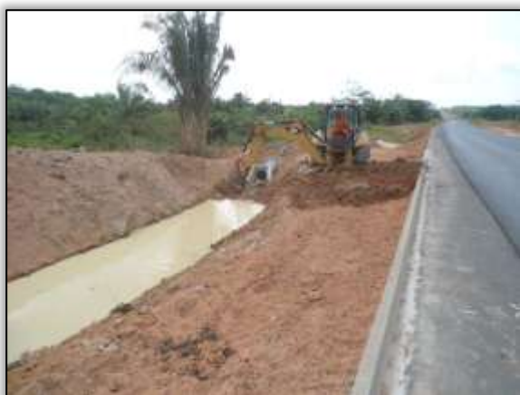
Foto 698 – Construção de sistema de drenagem. Lado esquerdo. Estaca 3274. S 03.13730° W 051.58879° 02/10/2013
