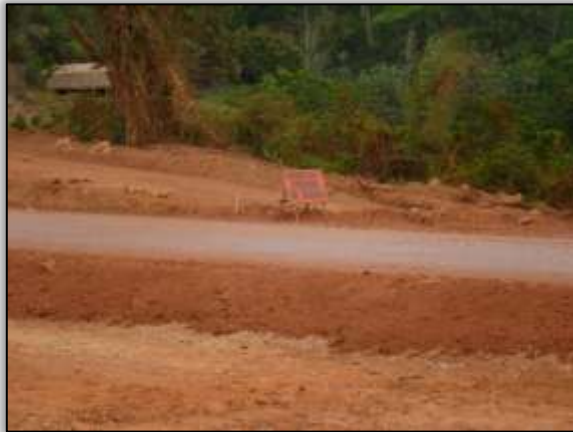
Foto 1393 – Ponto 35 – Trecho em obras 3.564519° S 51.086520° W (11/10/2013).
