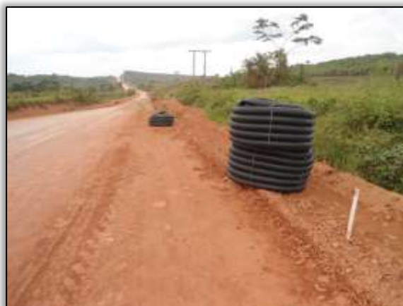
Foto 1032 – Processo erosivo recuperado. Lado direito. S 05.14222° W 049.39058° 13/11/2013
