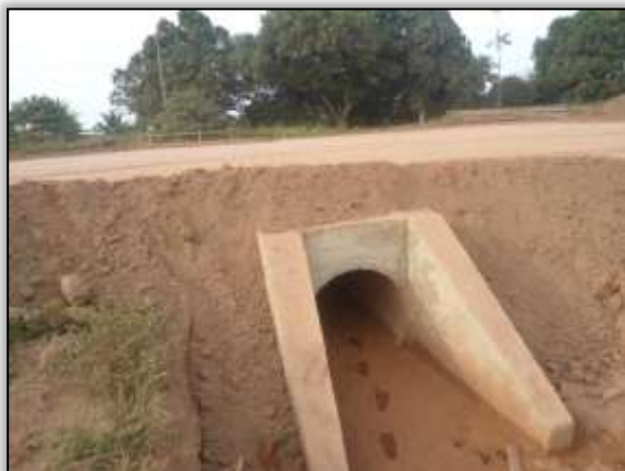
Foto 970 – Bueiro concluído. S 03.87206° W 054.22840°. 18/12/2013.
