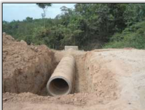
Foto 966 - Implantação de bueiro. Antes. S 03.87243° W 054.22957° 11/11/2013.
