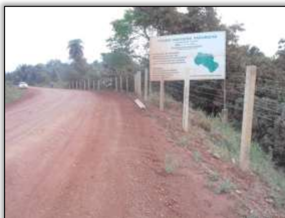
Foto 592 – Instalação de cercas na T.I. Parakanã próximo ao rio Pucuruí. Lado esquerdo. S 04.43354° W 049.92784°. 30/10/2013.
