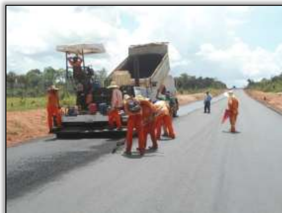
Foto 673 – Pavimentação asfáltica. Lado esquerdo. Estaca 3057. S 03.16901° W 051.56291° 21/08/2013
