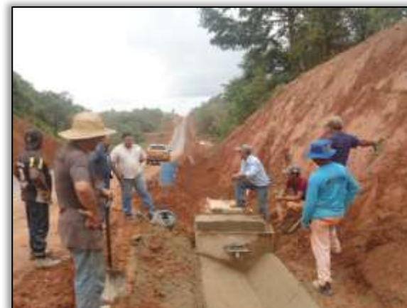
Foto 1159 - Orientação da equipe de construção de valeta. Lado esquerdo. S 03.39035° W 052.71671° 20/11/2013.
