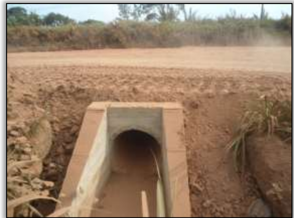
Foto 963 - Bueiro concluído. Depois. S 03.86106° W 054.18923°. 18/12/2013.
