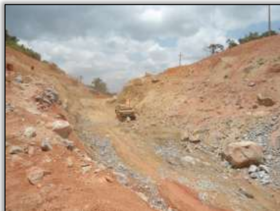
Foto 651 – Corte da rodovia e talude na ladeira do canteiro (Antes 10/10/2013). Lado direito. Estaca 1238. S 03.84726° W 050.54377°
