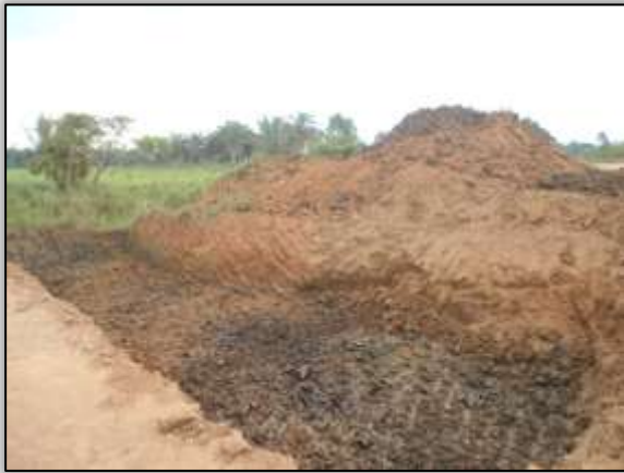
Foto 958 - Corte para construção de bueiro Antes. S 03. 85087° W 05415341°. 11/11/2013.
