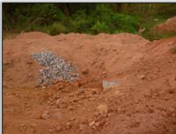
Foto 1392 – Ponto 34 – Bueiro. 3.625925° S 51.009338° W (11/10/2013).
