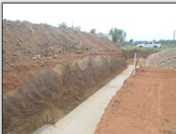
Foto 928 – Construção de bueiro. S 03. 87025° W 054.22191° 13/10/2013.
