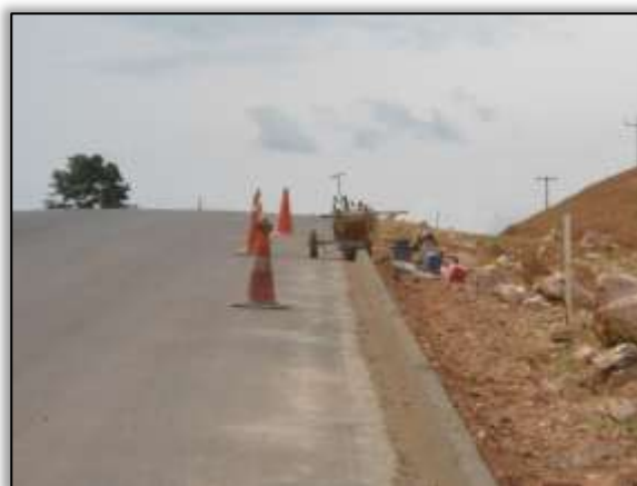
Foto 1137 – Instalação de meio-fio. Lado direito. Estaca 4583. S 03.59172° W 051.05763° 29/01/2014
