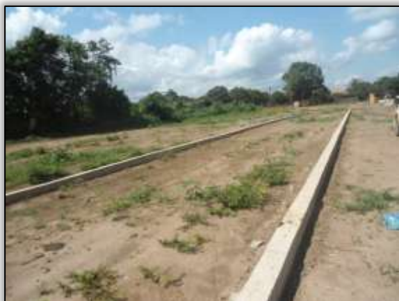
Foto 971 - Construção da fábrica de artefatos. Lado direito. S 03.866167° W 054.211694° 26/11/2013
