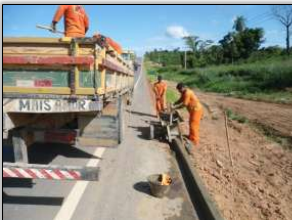
Foto 712 – Construção de meio fio. Lado Esquerdo. S 03.12519° W 051.73661° 07/01/2014
