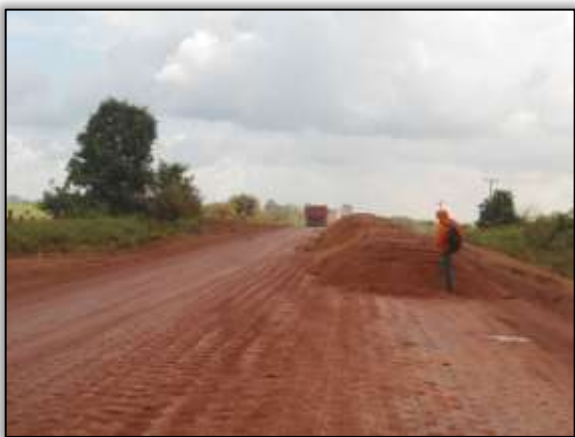
Foto 690 – Obras de terraplenagem na rodovia. Lado direito. Estaca 3748. S 03.11036° W 051.66332° 07/08/2013
