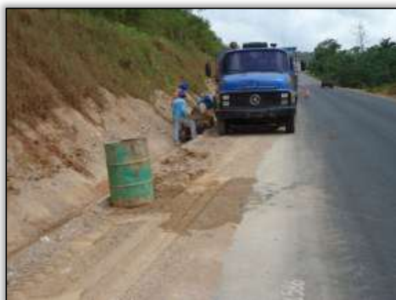
Foto 1183 – Construção de valeta. Lado direito. Estaca 1586. S 03.29901° W 052.49601° 13/12/2013.
