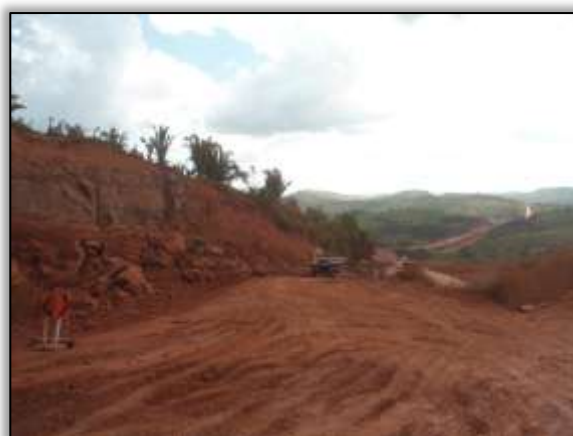
Foto 600 – Execução de corte na ladeira da velha. Lado direito/esquerdo. Estaca 1070. S 03.84672° W 050.51473° 14/08/2013
