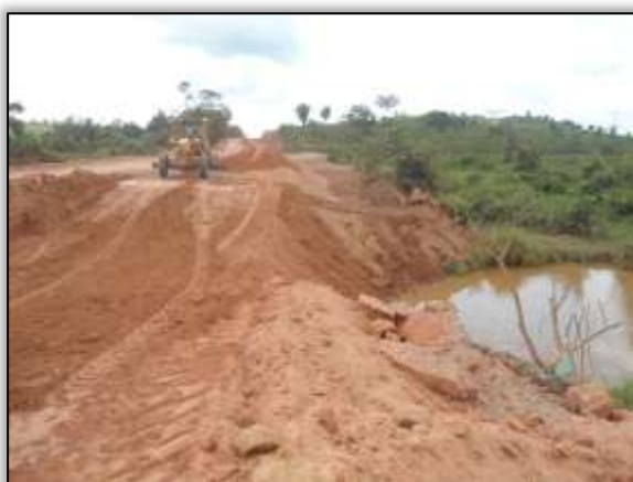
Foto 628 – Substituição de bueiro simples. Lado direito. Estaca 4467. S 03.60221° W 051.103922° 16/09/2013
