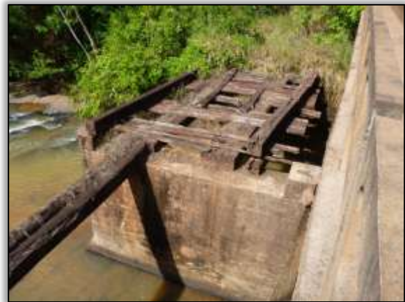
Foto 1427 – Ponto 43 – Resto de estrutura de concreto e madeira. 3.133642° S 51.941217° W (10/10/2013).
