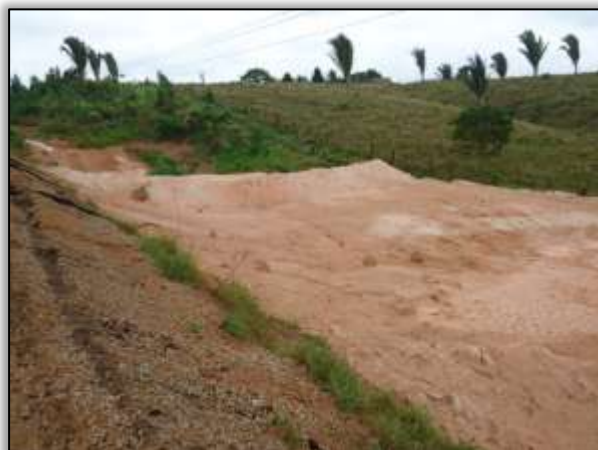
Foto 1115 – Ravinamento parcialmente recuperado (depois). Ambos os lados. S 04.15903º W 050.12743º 18/09/2013
