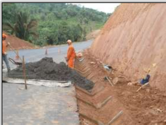
Foto 1134 – Construção de sarjeta. Lado direito. Estaca 4741. S 03.57569° W 051.08104° 09/01/2014
