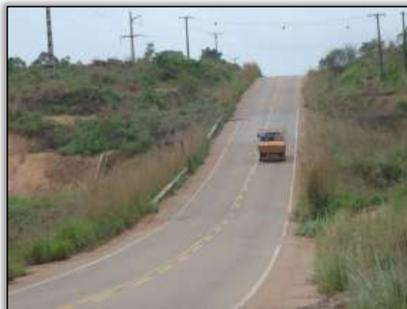
Foto 416 – Entrada para áreas de apoio do canteiro de obras. S 05.14985°W 049.38852° 23/10/2013
