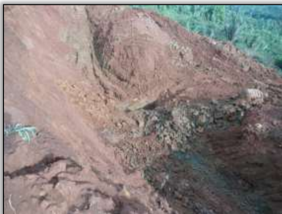
Foto 833- Implantação de sistema de drenagem . S 03.43939° W 52.83403°. 24/07/2013. Antes.
