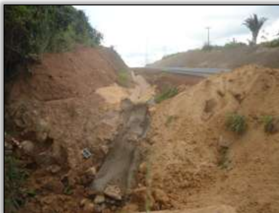
Foto 1173 – Construção de valeta. Lado esquerdo. S 03.35649° W 052.62665° 17/12/2013.
