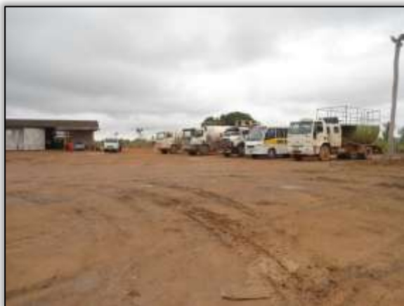
Foto 497 – Área do canteiro de obras. S 05.14392° W 049.35747° 12/11/2013
