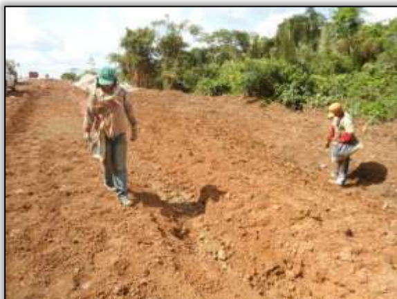
Foto 1130 – Semeadura na faixa de domínio. Estaca 5036. Lado direito. S 03.54425° W 051.11996° 12/11/2013
