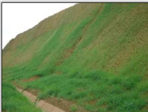
Foto 1086 – Talude após revestimento vegetal. Lado direito. S 03.92887° W 050.33671° 15/01/2014
