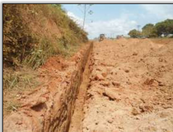
Foto 1044 – Abertura de vala para instalação de dreno longitudinal. Lado esquerdo. S 05.21550° W 049.34774° 04/12/2013
