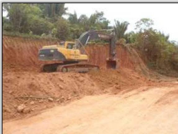
Foto 615 – Conformação do talude de corte. Estaca 4096. Lado esquerdo. S 03.64277° W 050.98798° 20/11/2013
