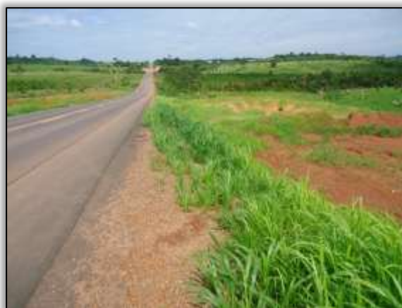
Foto 562 – Revestimento vegetal em bacia de contenção. Lado direito. S 04.18025° W 050.03599° 29/01/2014
