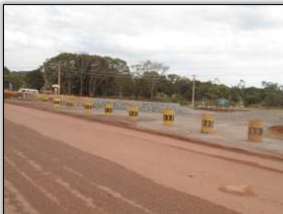
Foto 429 – Local da saída do desvio. Lado direito. S 03.12435° W 051.78915° 17/08/2013
