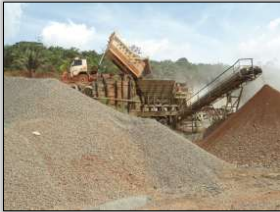
Foto 752 – Britador Sanches Tripoloni. Lado direito. Estaca 3775. S 03.44206° W 052. 85213°. 20/08/2013.
