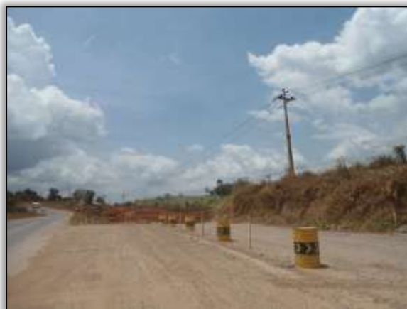
Foto 436 – Acesso ao porto do CCBM. Lado esquerdo. S 03.12021° W 051.79644° 03/09/2013
