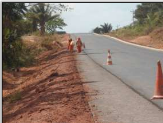
Foto 731. Preparo para construção de sistema de drenagem (meio fio). Estaca: 3186. S 03.14890° W 051.57792° 22/10/2013
