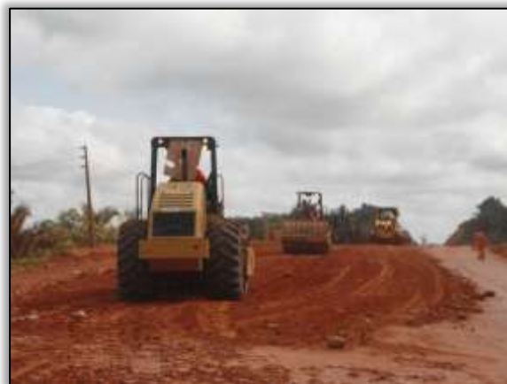
Foto 510 – Atividade de terraplenagem. S 05.13080° W 049.62889° 20/08/2013
