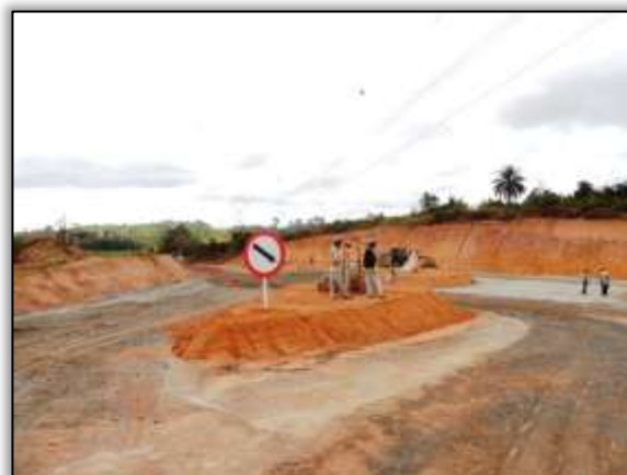
Foto 181 – Registro das atividades de desvio no trecho da BR-230/PA, que atravessa o canteiro do Sítio Belo Monte. Data: 16/08/2013.
