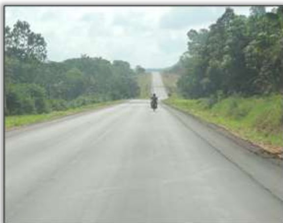
Foto 365 – Trecho entre os municípios de Pacajá e Anapu/PA, fase de sinalização de pista. 11/12/13.
