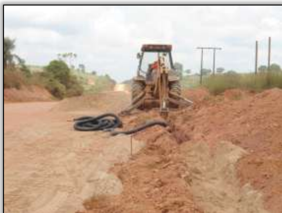
Foto 1047 – Abertura de vala para instalação de dreno longitudinal. Lado esquerdo. S 05.11456° W 049.40417° 04/12/2013
