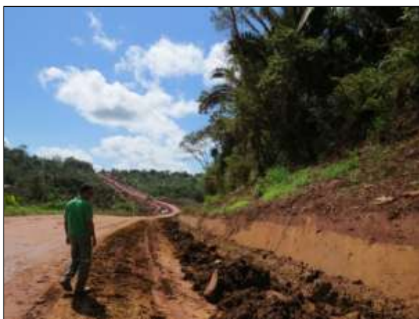
Figura 28. Biólogo acompanhando os serviços de terraplenagem e limpeza. Data: 10/07/2017
