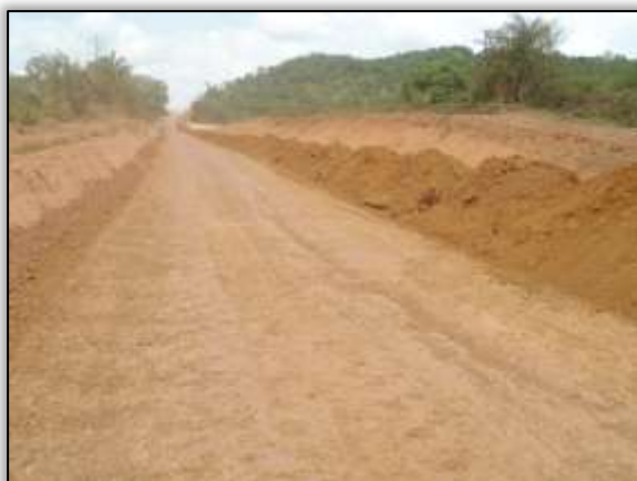
Foto 665 – Material para terraplenagem. Lado direito. Estaca 4675. S 03.58238° W 051.07098° 23/10/2013
