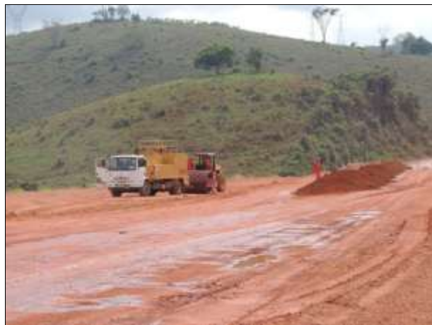
Figura 55. Obra de terraplenagem na rodovia acompanhada pela equipe. Data: 11/11/2013 _ 22M 0552111 E / 9575053 N
