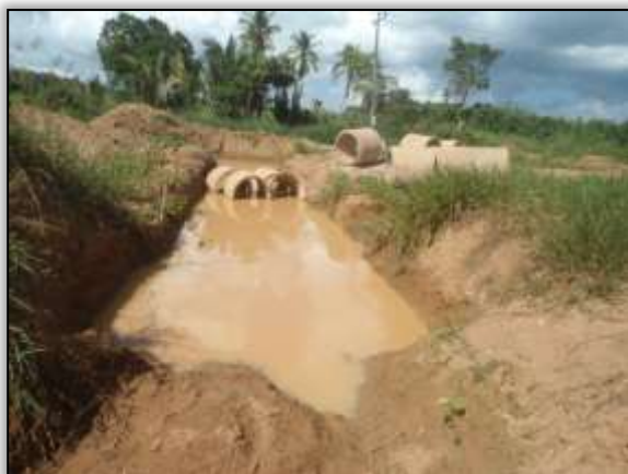
Foto 956 – Bueiro. Estaca 7920. S 03.85415° W 054.13615° 18/12/2013.
