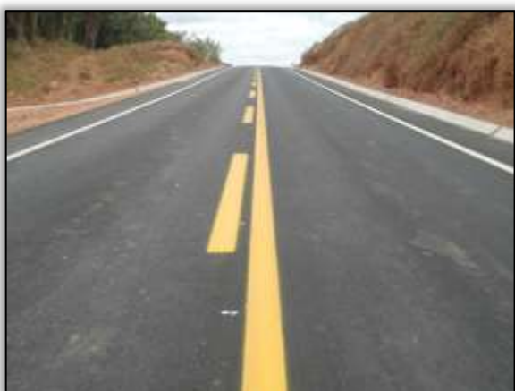
Foto 744- sinalização horizontal na rodovia. Lado direito e Esquerdo. Estaca 3376. S 03.12473° W 051.60197° 29/10/2013
