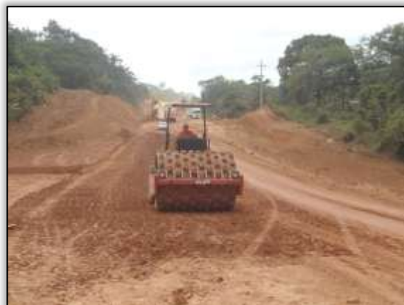
Foto 645 – Atividades de terraplenagem. Lado esquerdo. Estaca 4958. S 03.55399° W 051.10952° 16/09/2013
