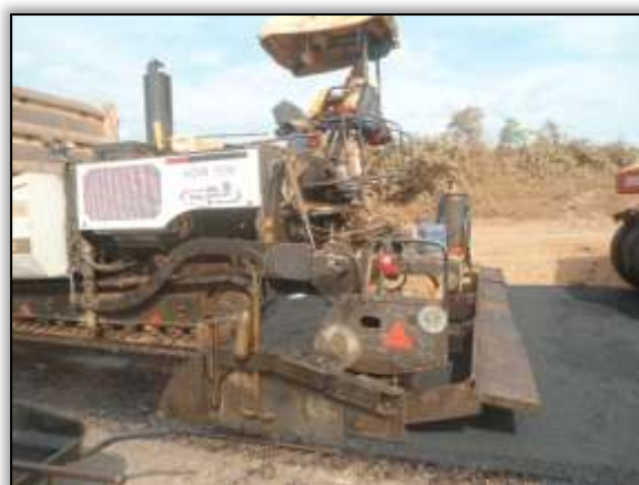
Foto 872 - Aplicação de asfalto. Estaca 2108 á 2132. S 03.33117° W 052.58248°17/10/2013.
