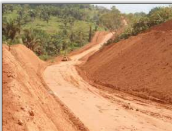
Foto 601 – Corte e conformação de talude. Lado direito. Estaca 4740. S 03.57618° W 050.08078° 07/08/2013
