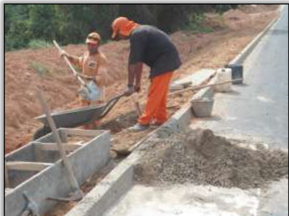
Foto 726 – Construção de sistema de drenagem (descida d'água). Lado esquerdo. Estaca: 3410. S 03.12191° W 051.60747° 09/10/2013
