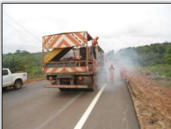
Foto 722 – Sinalização horizontal. Lado direito. Estaca 4029. S 03.12942° W 051.70623° 20/11/2013
