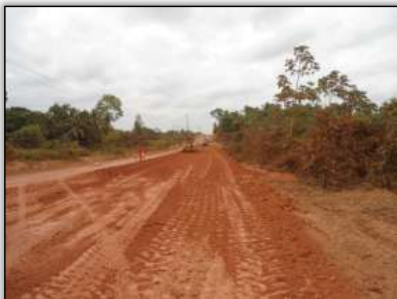
Foto 516 – Atividade de terraplenagem. S 04.25048° W 049.04613° 24/10/2013
