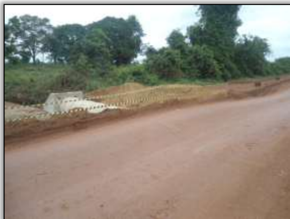
Foto 991 - Bueiro concluído. Estaca 8673. S 03.88625° W 054.26497° 29/01/2014
