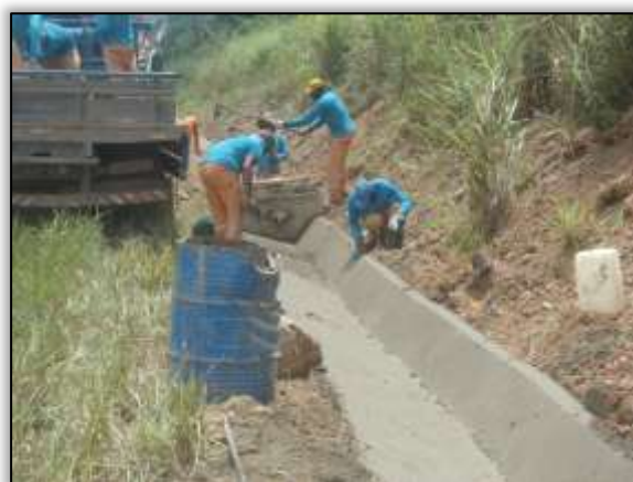
Foto 1152 – Construção de valeta. Lado direito. Estaca 2564. S 03. 36999. W 052. 65012° 27/09/2013
