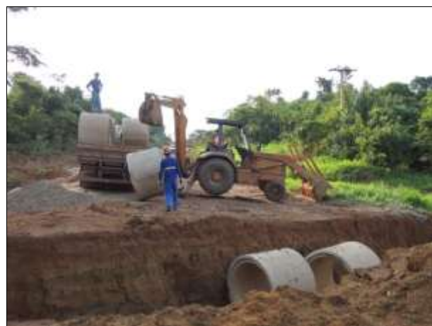
Figura 57. Colocação de manilhas para desvio de curso d'água. Data: 21/11/2013 _ 22M 0798649 E / 9569412 N
