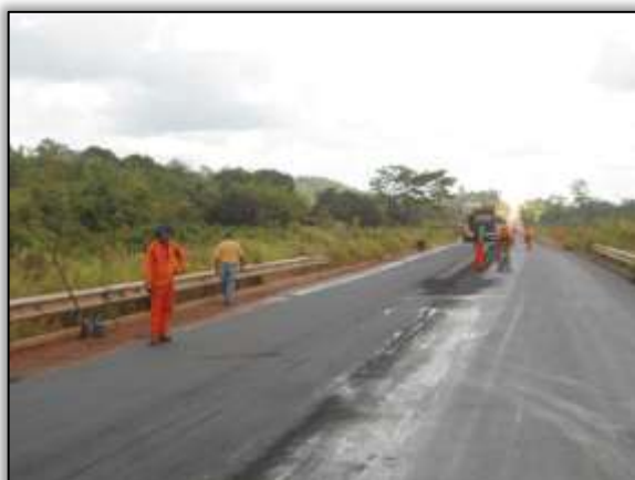
Foto 672 – Recapeamento asfáltico de trecho da rodovia. Lado esquerdo. Estaca 2512. S 03.639° W 051.49280° 07/08/2013
