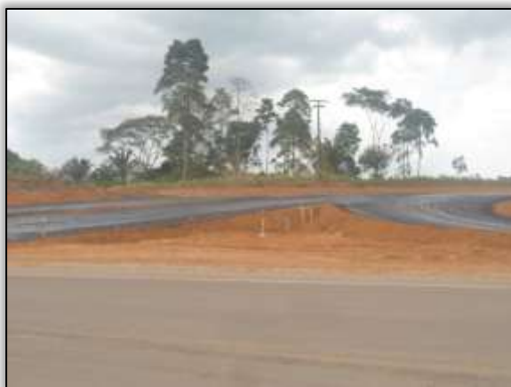
Foto 895 – Implantação de piche na entrada da vicinal 12. Lado direito. S 03.28687° W 052.48946° 19/11/2013.
