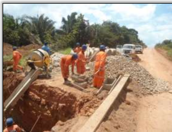
Foto 932 - Implantação de bueiro. Estaca 7680. S 03.86258° W 054.09551° 21/01/2014
