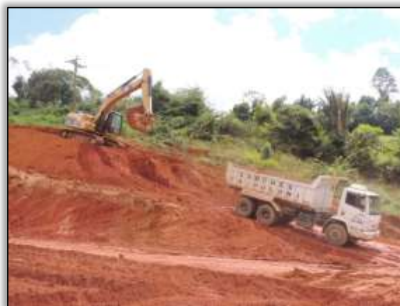
Foto 508 – Execução de corte em talude. S 03.72712° W 050.38986° 31/07/2013
