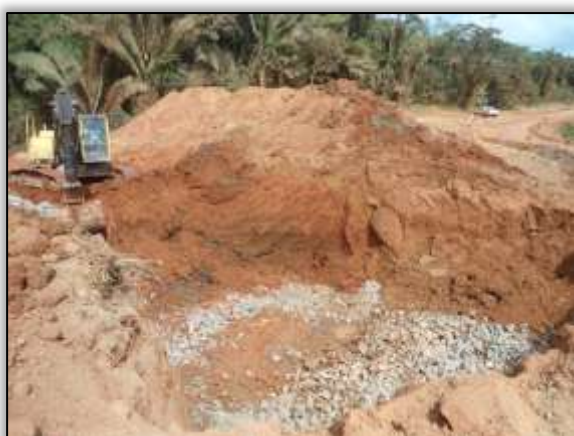
Foto 605 – Implantação de bueiro simples. Lado esquerdo. Estaca 4345. S 03.62321° W 051.01489° 21/08/2013
