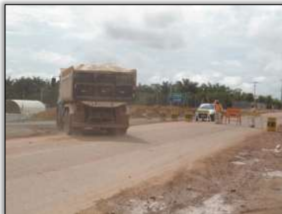
Foto 430 – Liberação do desvio após a vistoria. Lado esquerdo (sentido Altamira/Marabá). S 03.12435° W 051.78915° 17/08/2013
