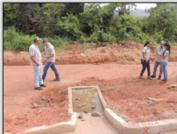
Foto 1147 - Descida D'água. Lado direito. Estaca 1732. S 03. 30709° W 052. 53133° 20/08/2013.
