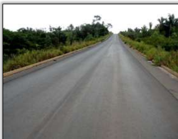
Foto 28- Andamento da pavimentação do lote 04 (sentido Altamira/Anapu.
