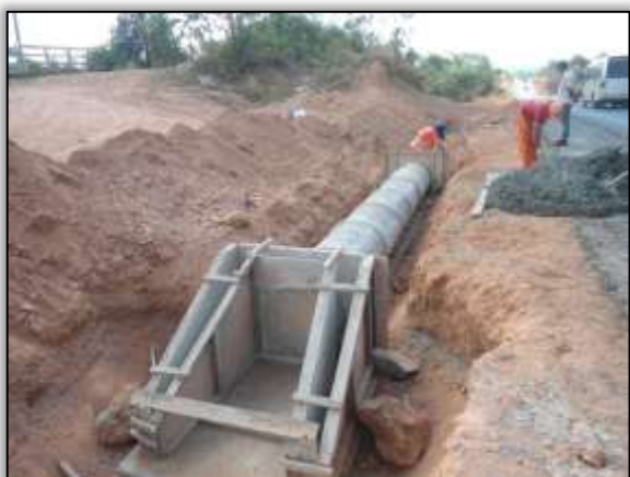
Foto 734 - Construção de sistema de drenagem. Lado esquerdo. Estaca 3852. S 03.11769° W 051.61365° 22/10/2013
