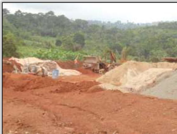
Foto 775 – Construção de artefato de concreto. Lado esquerdo. Estaca 3512. S 03.42750° W 052.80790° 14/11/2013.
