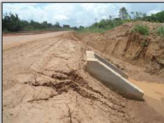
Foto 937 - Bueiro concluído. Estaca 7920. S 03.85407° W 054.13626° 24/01/2014
