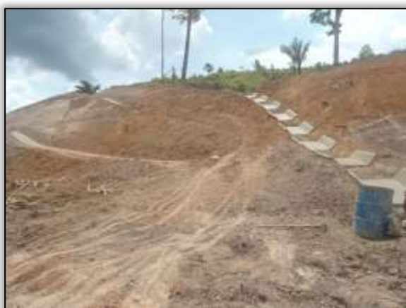
Foto 853 – Construção de drenagem. Lado direito. Estaca 2665. S 03. 37793°. W 052. 66531 27/09/2013.
