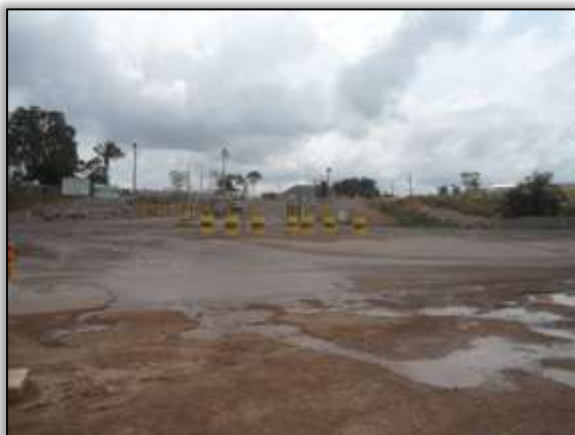
Foto 435 – Acesso ao canteiro de obras do CCBM. Lado esquerdo. S 03.12284° W 051.79378° 03/09/2013
