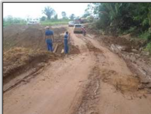
Foto 1008 - Reconformação do caminho de serviço. Lado direito. S 03.89169° W 054.33546° 21/11/2013.
