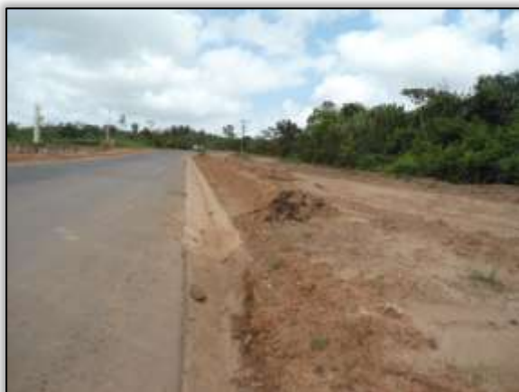
Foto 1149 – Construção de valeta. Lado direito. Estaca 1714. S03. 30678° W052. 51721° 17/09/2013.
