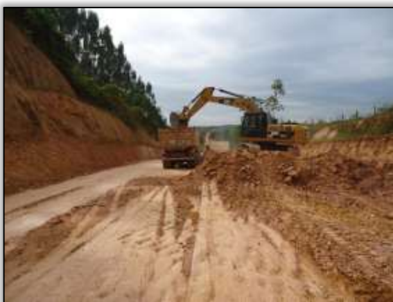
Foto 491 – Corte em talude. Lado esquerdo. S 05.12872° W 049.39721° 12/11/2013
