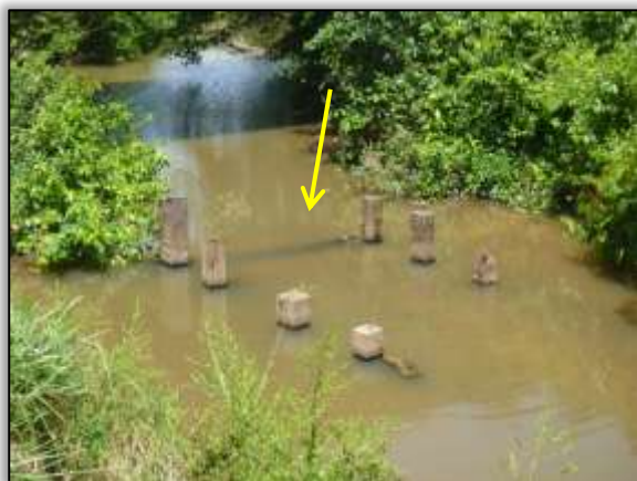
Foto 1278 – Ponto 01 – Toras de madeira. 5.657471° S 48.396884° W (15/10/2013).
