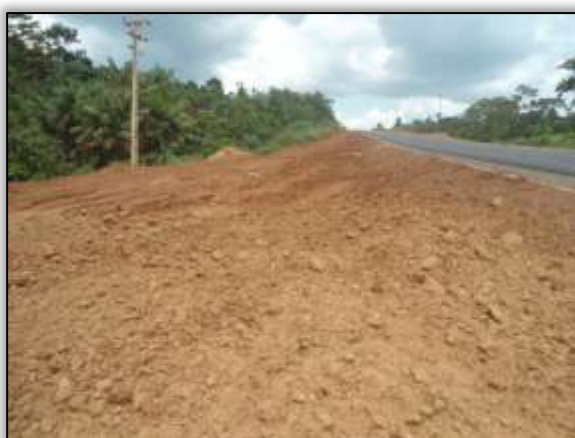
Foto 1178 – Solo gradeado aguardando o plantio de gramíneas. Lado direito. Estaca 3530. S 03.42930° W 052.81036° 17/12/2013.
