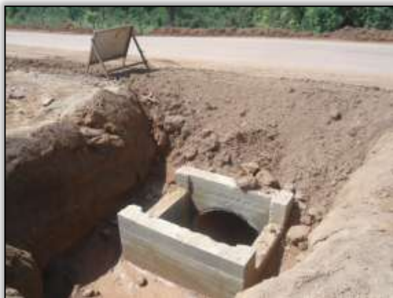
Foto 944 - Bueiro concluído. S 03.87558° W 054.24048°. 24/01/2014.
