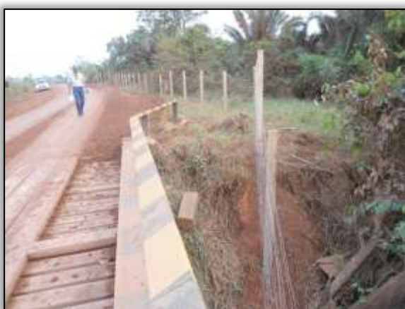
Foto 589 – Cercas instaladas na T.I. Parakanã próximo ao rio Xarayra (baiano). Lado esquerdo. S 04.52939° W 049.83068°. 30/10/2013.
