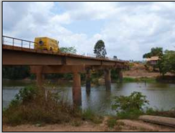
Foto 1399 – Ponto 36 – Ponte de concreto. 3.473318° S 51.196224° W (11/10/2013).
