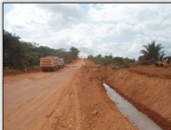
Foto 626 – Drenagem provisória. Lado direito e esquerdo. Estaca 4764. S 03.57167° W 051.08305° 16/09/2013
