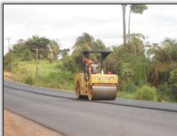
Foto 523 – Compactação asfáltica. Lado direito. S 04.15945° W 050.13220° 21/08/2013
