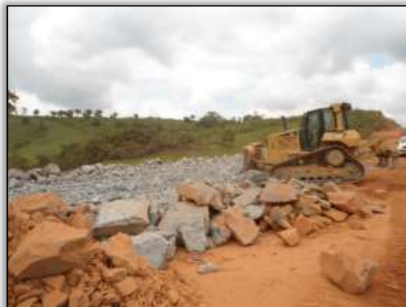
Foto 594 – Conformação da área do bota-fora. Lado esquerdo. S 03.70329° W 050.91545° 11/12/2013
