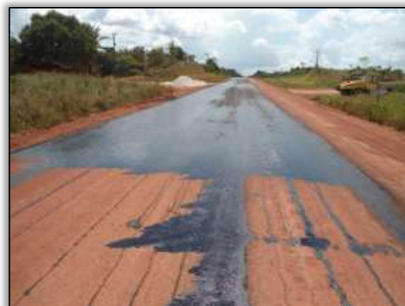
Foto 675 – Imprimação. Lado direito/esquerdo. Estaca 3160. S 03.15280° W 051.57512° 21/08/2013
