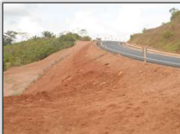
Foto 709–Gabião. Estaca 6063. Lado esquerdo. S 03.16919° W 051.01170° 17/12/2013.
