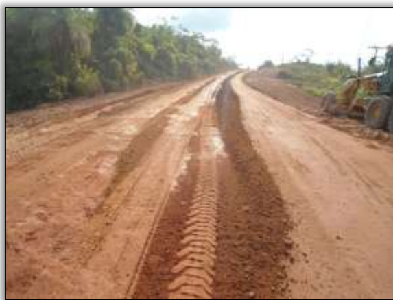
Foto 694 – Atividades de terraplenagem. Lado direito e esquerdo. Estaca 4304. S 03.12571° W 051.74994° 02/10/2013
