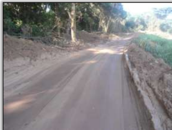
Foto 1010 – Caminho de serviço. Lado esquerdo. S03. 89098° W 054.31071°. 26/11/2013.
