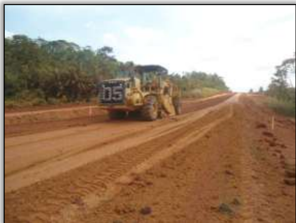
Foto 873 - Máquina recicladora na pista. Estaca 3532. S 03.42967° W 052.81073°. 17/10/2013.
