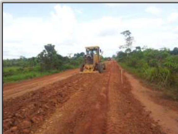
Foto 989 - Terraplanagem. Estaca 8786. S 03. 88940° W 054. 28294° 23/10/2013.
