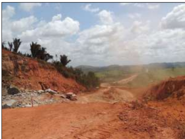
Figura 36. Atividade de empréstimo de material para terraplenagem na rodovia. Data: 10/09/2013
