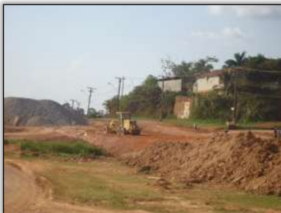
Foto 512 – Atividade de terraplenagem. S 04.15993° W 049.56414° 01/10/2013
