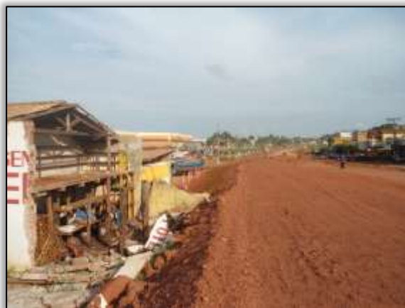
Foto 549 – Rodovia com base e sub-base. Lado esquerdo. S 04.25100° W 049.94584° 12/11/2013
