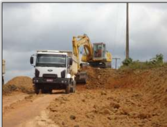
Foto 489 – Retirada de material de talude. Lado direito. S 05.14524° W 049.38962° 21/10/2013
