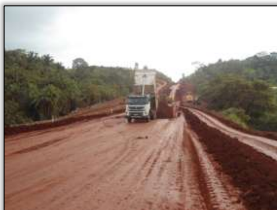
Foto 886 – Terraplanagem. Estaca 3754. S 03.44230° W 052.84764° 13/11/2013.
