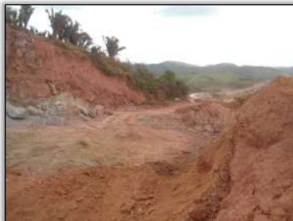
Foto 598 – Conformação do off set da rodovia. Ladeira da velha. Lado esquerdo. Estaca 1070. S 03.84652° W 050.51519° 20/08/2013
