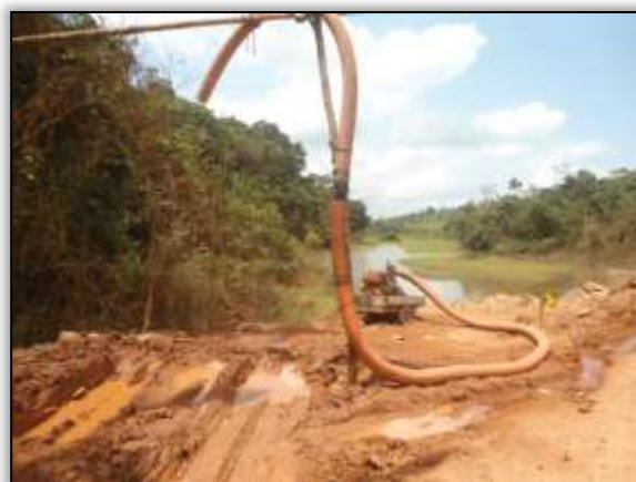
Foto 802 - Captação de água Igarapé. Jacarezinho. Lado esquerdo. Estaca 3950. S 03.39049° W 052.71481° 10/10/2013.
