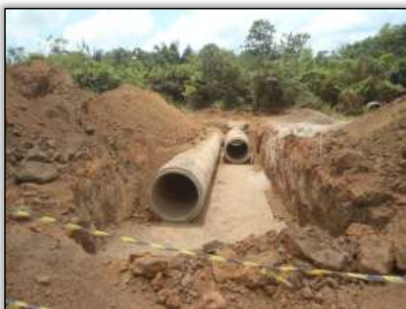
Foto 948 – Construção de bueiro. S 03.86237° W 054. 19567° 17/10/2013. Antes.
