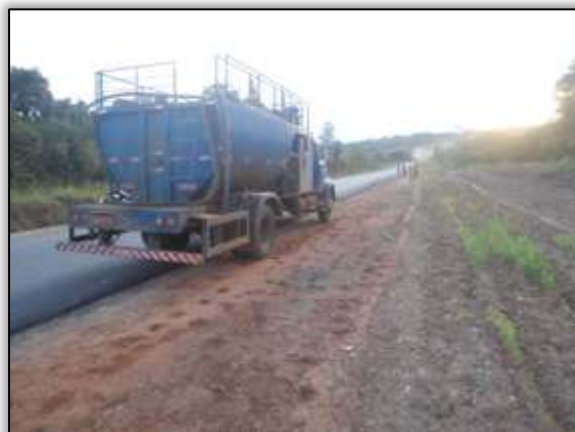
Foto 1199 – Hidrossemeadura. Lado direito. Estaca 1657. S 03. 30209° W 052. 50866° 21/01/2014
