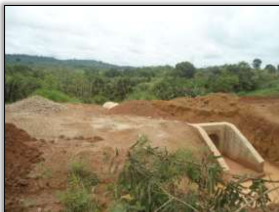
Foto 998 - Bueiro em construção Estaca 8948. S 03.89120° W 054.31135° 29/01/2014
