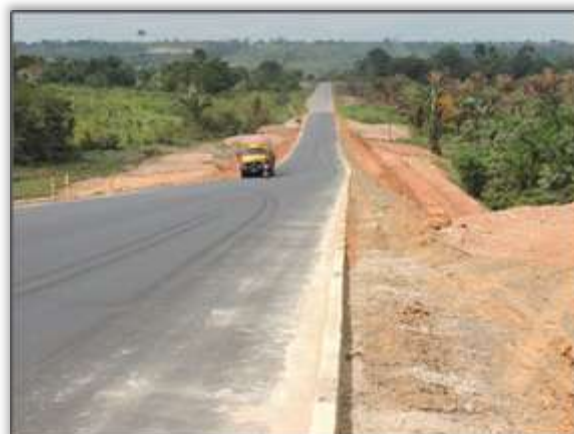
Foto 368 – Trecho entre os municípios de Altamira, e Medicilândia, fase de sinalização. 04/12/13.
