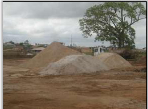
Foto 796 - Deposito de areia. Estaca 1880. Lado direito. S 03. 30814° W 052. 54790° 10/10/2013
