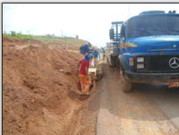
Foto 891 – Construção de valeta. Lado direito. Estaca 2904. S 03. 38952° W 053. 70567° 21/01/2014
