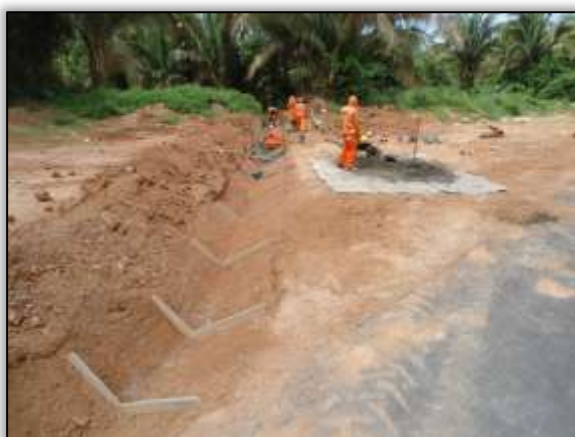
Foto 1136 – Construção de sarjeta. Lado esquerdo. S 03.58687° W 051.06422° 24/01/2014
