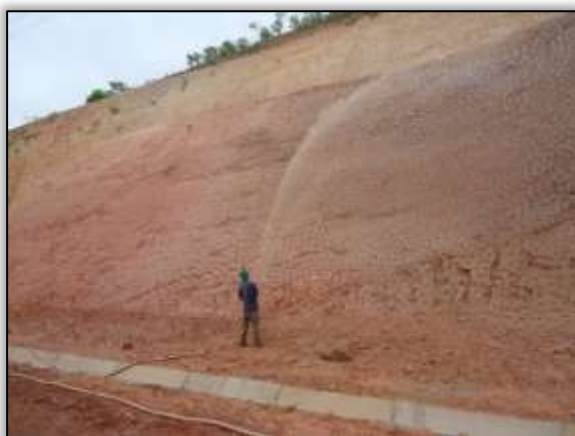
Foto 1080 – Aplicação de hidrossemeadura. Lado direito. S 04.20101° W 049.99736° 15/01/2014
