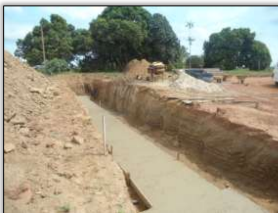
Foto 926 – Construção de bueiro. S 03. 87207° W 054.22810° 23/10/2013.
