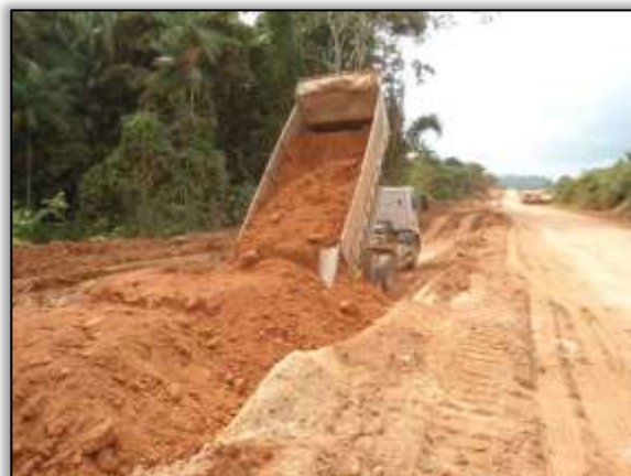
Foto 616 – Conformação e aterro da faixa de domínio. Estaca 4077. Lado esquerdo. S 03.64414° W 050.98542° 20/11/2013
