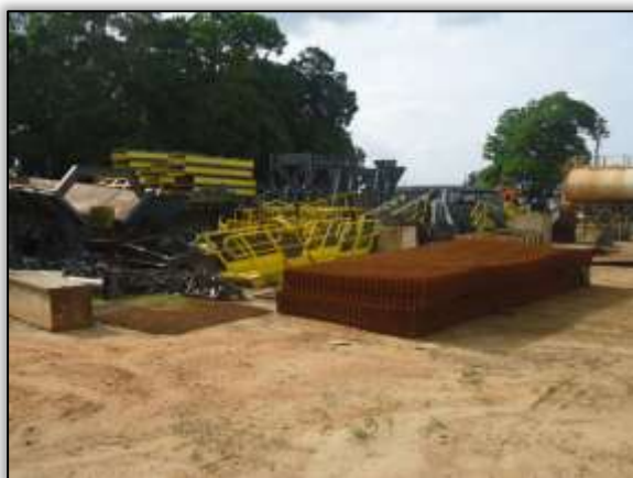
Foto 499 – Material de instalação do canteiro e da britagem. S 05.14392° W 049.35747° 26/12/2013
