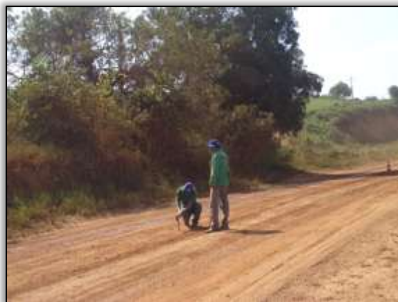
Foto 486 – Atividades de Topografia. Eixo da rodovia. S 05.12288° W 049. 39055° 24/09/2013
