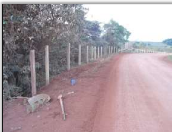
Foto 590 – Instalação de cercas na T.I. Parakanã próximo ao rio Pucuruí. Lado esquerdo. S 04.43354° W 049.92784°. 30/10/2013.
