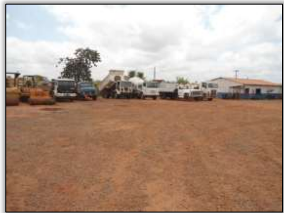
Foto 755 – Canteiro de obra. Lado esquerdo. Estaca 1827. S 03.30872° W 052. 53631 17/09/2013.
