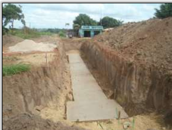
Foto 927 – Construção de bueiro. S 03. 87025° W 054.22191° 13/10/2013.
