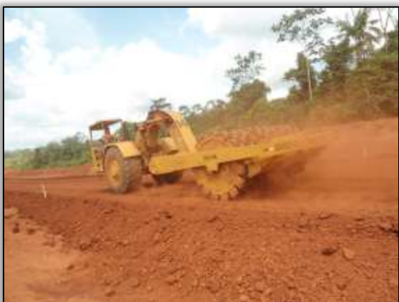
Foto 831 – Rolo compactando. Estaca 3645. S 03. 43803° W 052. 82837° 20/08/2013.
