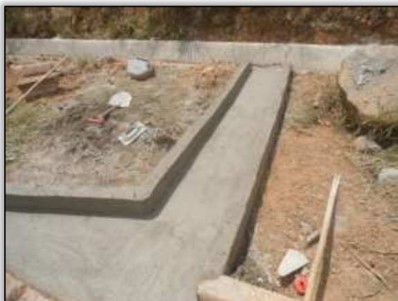
Foto 851 – Construção de descida d’água. Lado direito. Estaca 2557. S 03. 36918° W 052. 64856° 27/09/2013.
