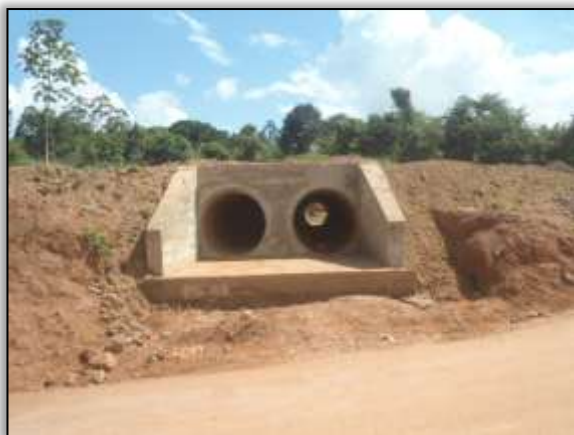
Foto 945 - Bueiro concluído. S 03.87590° W 054.24349°. 24/01/2014.
