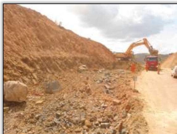
Foto 647 – Retirada de material no corte. Lado esquerdo. S 03.57884° W 050.07539° 02/10/2013
