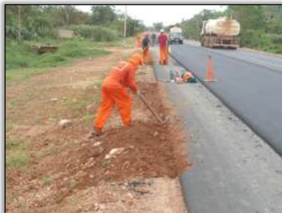
Foto 1129 – Construção de meio fio. Estaca 5148. Lado esquerdo. S 03.53180° W 051.13532° 26/11/2013
