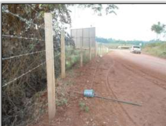
Foto 591 – Instalação de cercas na T.I. Parakanã próximo ao rio Pucuruí. Lado esquerdo. S 04.43354° W 049.92784°. 30/10/2013.
