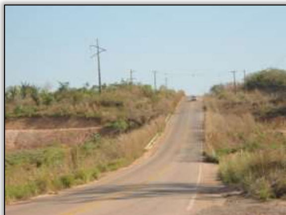
Foto 411 – Entrada para áreas de apoio do canteiro de obras. S 05.14985°W 049.38852° 29/08/2013
