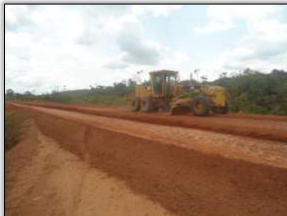
Foto 850 – Terraplanagem. Estaca 2273. S 03. 34434° W 052. 60472° 27/09/2013.
