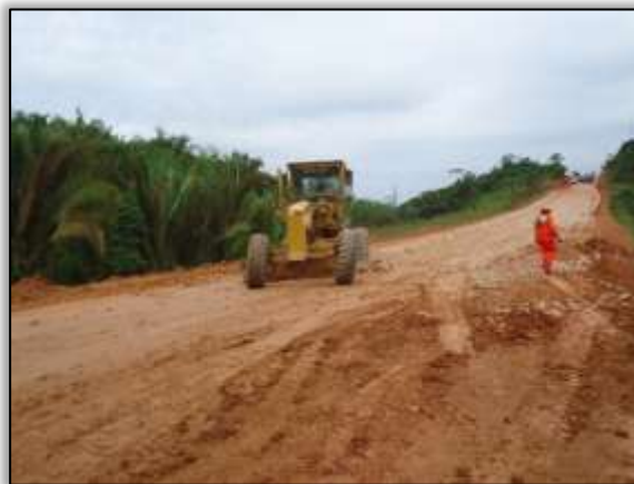
Foto 494 – Atividade de terraplenagem. Eixo da rodovia. S 04.26239° W 049.94836° 12/11/2013
