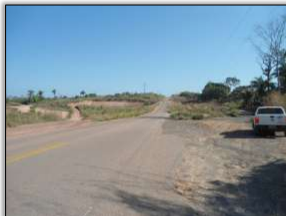
Foto 412 – Entrada para áreas de apoio do canteiro de obras. S 05.14985°W 049.38852° 29/08/2013
