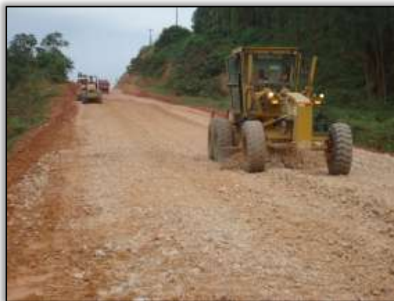
Foto 496 – Atividade de terraplenagem. Eixo da rodovia. S 04.26239° W 049.94836° 12/11/2013
