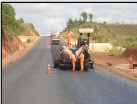
Foto 526 – Pavimentação da rodovia. Lado direito. S 04.15949° W 050.12640° 21/08/2013
