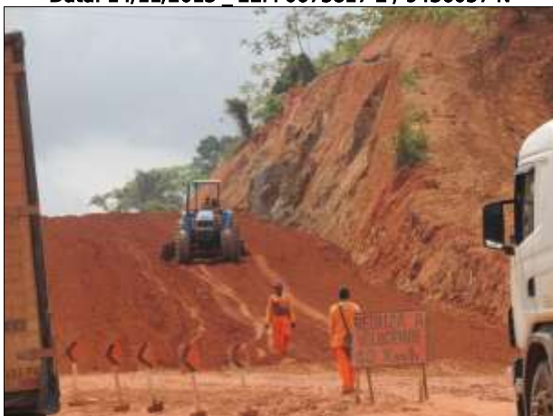
Figura 58. Equipe acompanhando obras de terraplenagem na rodovia. Data: 27/11/2013 _ 22M 0332688 E / 9634953 N
