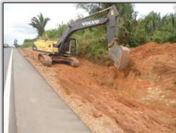
Foto 720 – Escavação para construção do dispositivo de drenagem. Lado direito. S 03.10784° W 051.65619° 20/11/2013
