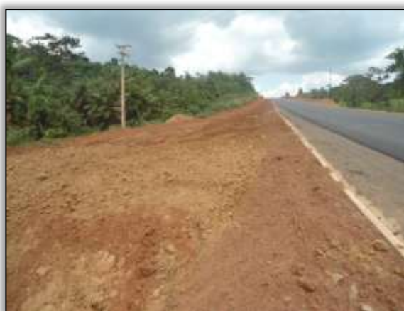
Foto 1179 – Solo gradeado aguardando o plantio de gramíneas. Lado direito. Estaca 3530. S 03.42930° W 052.81036° 17/12/2013.
