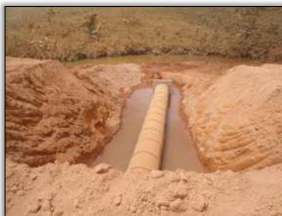
Foto 635 – Bueiro simples. Lado esquerdo. S 03.67477° W 050.94420° 23/10/2013
