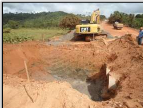
Foto 604 – Implantação de bueiro tubular duplo. Lado esquerdo. Estaca 4115. S 03.63841° W 050.99704° 21/08/2013
