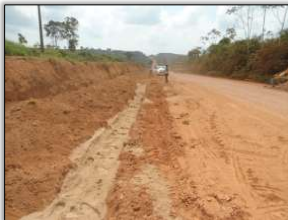
Foto 1046 – Instalação de dreno longitudinal. Lado direito. S 05.21551° W 049.34773° 04/12/2013
