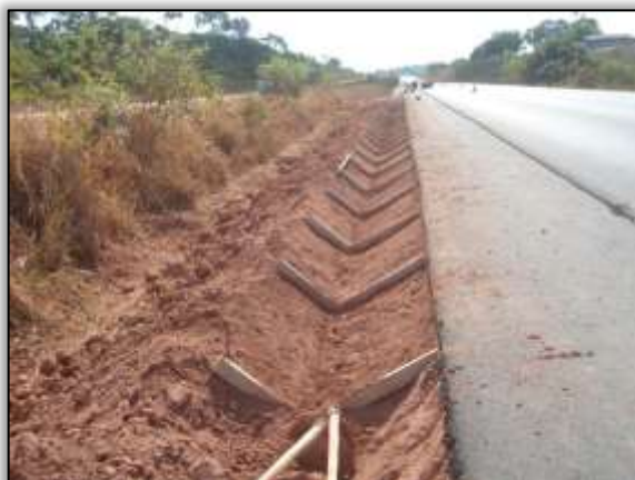
Foto 737-- Construção de sistema de drenagem (sarjeta). Lado esquerdo. Estaca 3812. S 03.11362° W 051.67389° 22/10/2013
