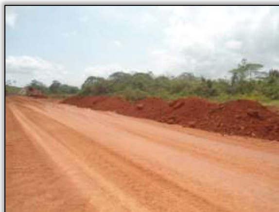
Foto 860 – Serviços de terraplenagem. Estaca 2815. S 03.38699° W 052.69066°. 10/10/2013.
