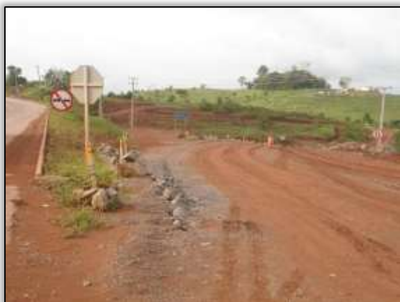
Foto 457– Acesso ao porto do CCBM. Lado esquerdo. Estaca 4572. S 03.12021° W 051.79644° 26/12/2013.
