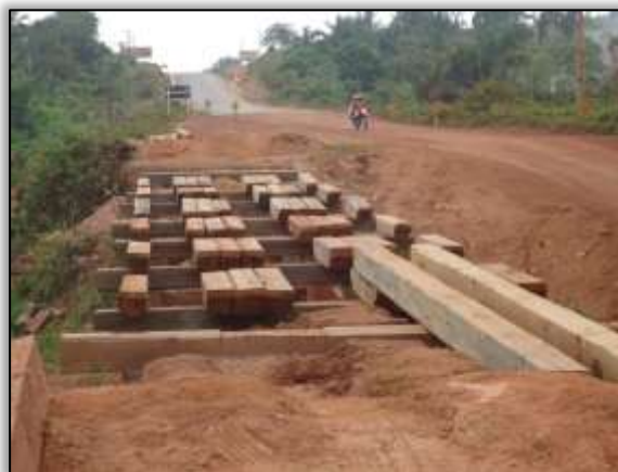
Foto 547 – Atividades de conserva na ponte. S 04.13264° W 050.23944° 24/10/2013
