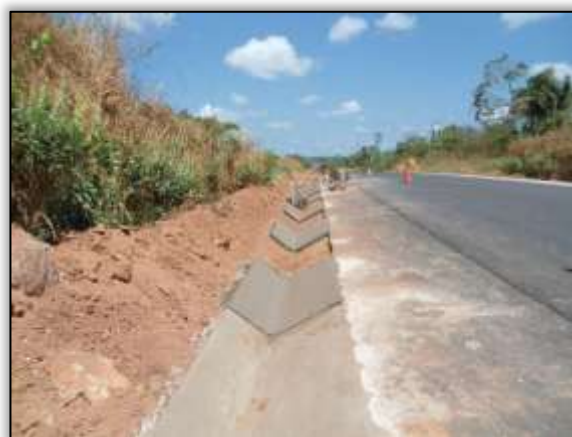
Foto 701 – Construção de sistema de drenagem (sarjeta). Lado esquerdo. Estaca 3472. S 03.11606° W 051.61711° 25/09/2013
