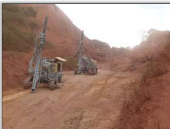
Foto 607 – Perfuração para detonação na ladeira da velha. Lado esquerdo. Estaca 1070. S 03.84910° W 050.51409° 20/08/2013
