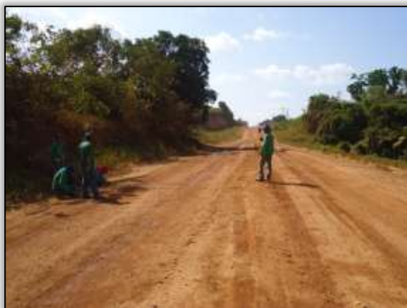
Foto 485 – Atividades de Topografia. Eixo da rodovia. S 05.12288° W 049. 39055° 24/09/2013
