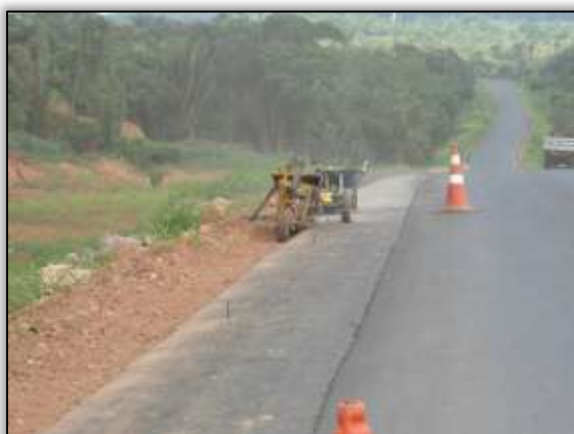
Foto 1132 – Construção de meio-fio. Lado esquerdo. Estaca 5042. S 03.54373° W 051.12030° 08/01/2014
