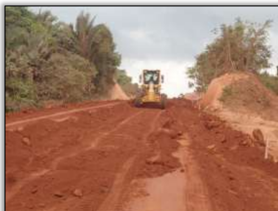
Foto 670 – Terraplenagem. Lado direito. Estaca 4421. S 03.60613° W 051.03190° 30/10/2013
