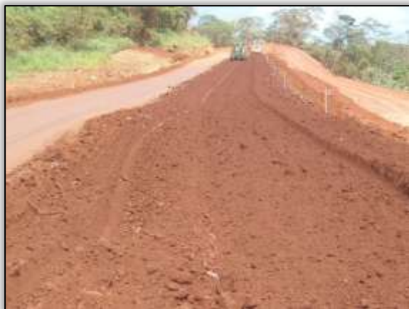
Foto 813 – Gradiamento do solo. Estaca 3535. Lado direito. S 03. 42988° W 052. 81137° 14/08/2013
