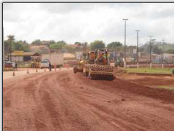
Foto 518 – Atividades de compactação do solo. S 04.24449° W 049.94828° 30/10/2013
