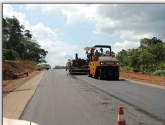
Foto 371 – Trecho entre os municípios de Altamira e Medicilândia, fase de recapeamento. 04/12/13.
