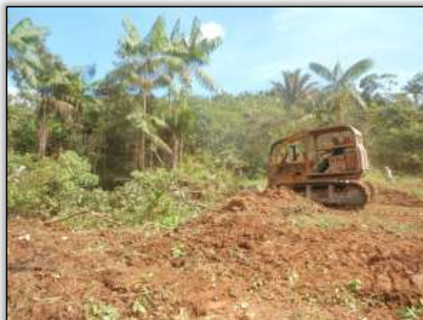
Foto 1240 – Limpeza com trator de esteira. S 03.43011° W 052.81179°. 18/07/2013.
