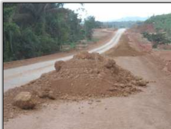
Foto 610 – Material para terraplenagem. Lado direito. Estaca 4485. S 03.60068° W 051.04232° 12/11/2013
