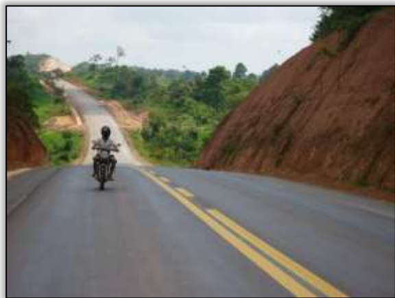
Foto 353 – Trecho entre os municípios de Novo Repartimento e Pacajá/PA – 18/12/13
