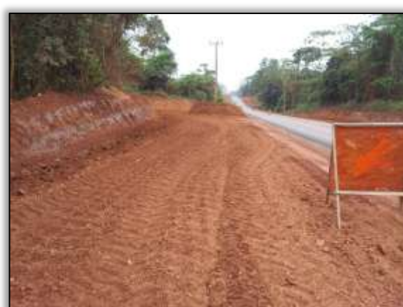
Foto 1157 - Escarificação do solo. Lado direito. Estaca 3408. S 03.41835° W 052.79528° 31/10/2013
