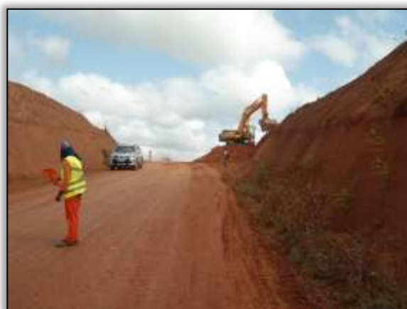
Foto 602 – Corte de talude. Lado direito. Estaca 4581. S 03.59170° W 051.05856° 21/08/2013
