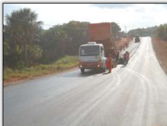
Foto 679 – Pavimentação asfáltica (2ª camada). Lado esquerdo. Estaca 4018. S 03.12861° W 051.70395° 02/10/2013
