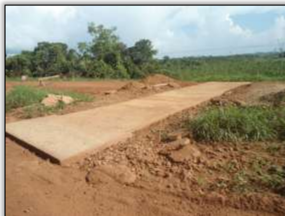
Foto 1022 - Bueiro. S 03.89171° W 054.33097°. 27/12/2013.
