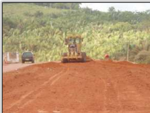
Foto 509 – Atividade de compactação do solo. S 04.75595° W 049.62889° 20/08/2013
