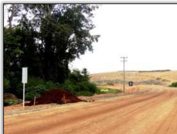
Foto 183 – Registro do desvio no trecho da BR-230/PA, que atravessa o canteiro do Sítio Belo Monte. Data: 16/08/2013.
