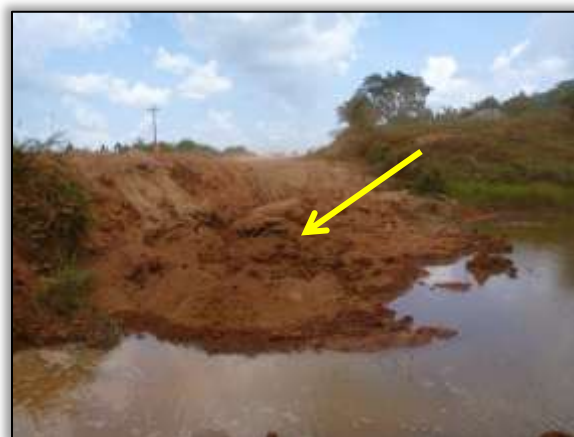
Foto 1391 – Ponto 34 – Assoreamento no local 3.625925° S 51.009338° W (11/10/2013).
