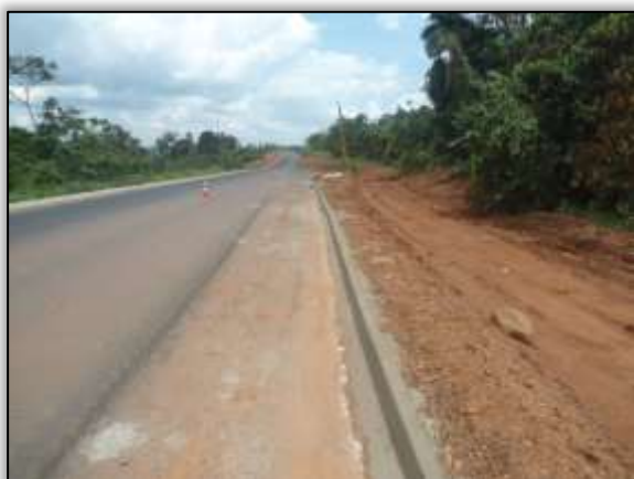
Foto 1174 – Construção de meio fio. Lado esquerdo. Estaca 3690. S 03.44005° W 052.83631° 17/12/2013.
