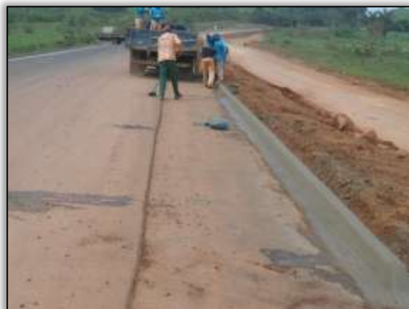
Foto 1161 – Construção de meio fio. Lado direito. Estaca 2827. S 03.38815° W 052.69304° 28/11/2013.
