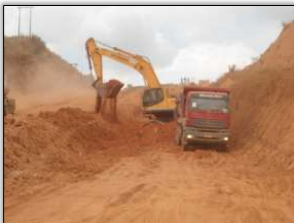
Foto 654 – Corte e conformação da rodovia. Lado direito. Estaca 3574. S 03.70292° W 050.91600° 23/10/2013
