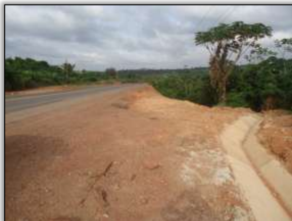
Foto 1121 – Descida d’água em fase instalação. Lado direito. S 04.22884° W 049.97191° 12/11/2013
