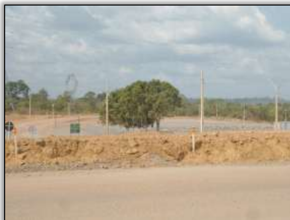
Foto 440 – Final do desvio da rodovia. Lado direito. S 03.12383° W 051.78881° 23/10/2013
