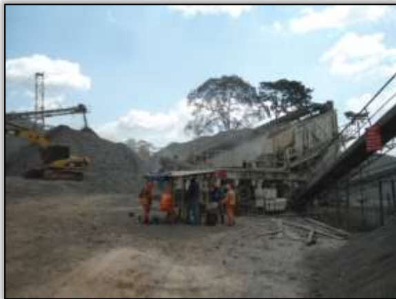
Foto 756 – Britador Sanches Tripoloni. Lado direito. Estaca 3775. S 03.44206° W 052. 85213° 17/09/2013.
