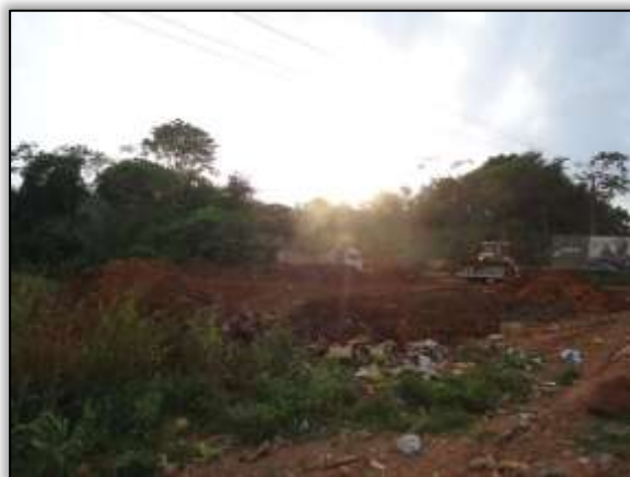
Foto 505 – Atividades de limpeza em faixa de domínio. Lado direito. S 04.24188° W 049.95153° 01/10/2013.
