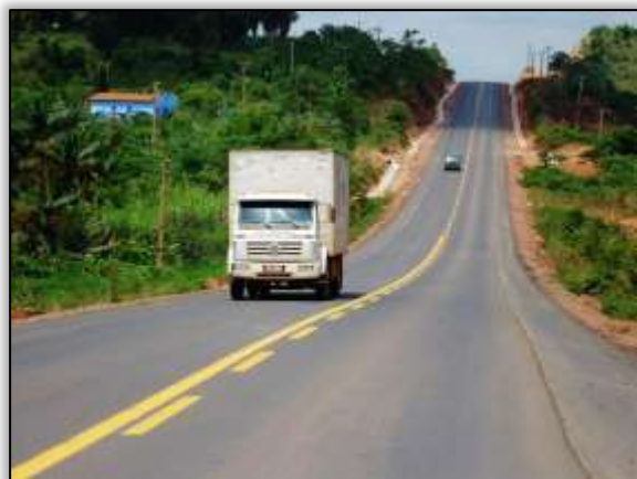
Foto 351 – Trecho entre os municípios de Novo Repartimento e Pacajá/PA – 18/12/13
