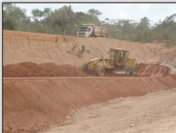
Foto 884 – Máquina fazendo terraplanagem. S 03.30003° W 052.49889° 13/11/2013.
