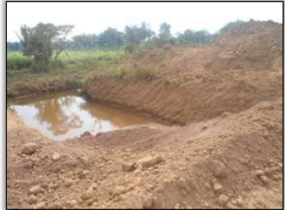
Foto 959 - Bueiro. Depois. S 03.85087° W 054.15341°. 18/12/2013.
