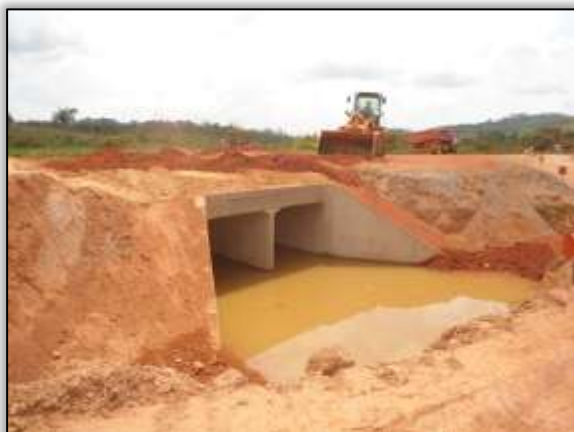
Foto 632 – Construção de bueiro celular duplo. Lado direito. Estaca 3904. S 03.66207° W 050.95924° 02/10/2013
