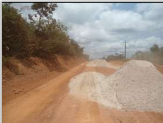
Foto 849 – Terraplanagem. Estaca 2067. S 03. 32461° W 052. 57510° 27/09/2013.
