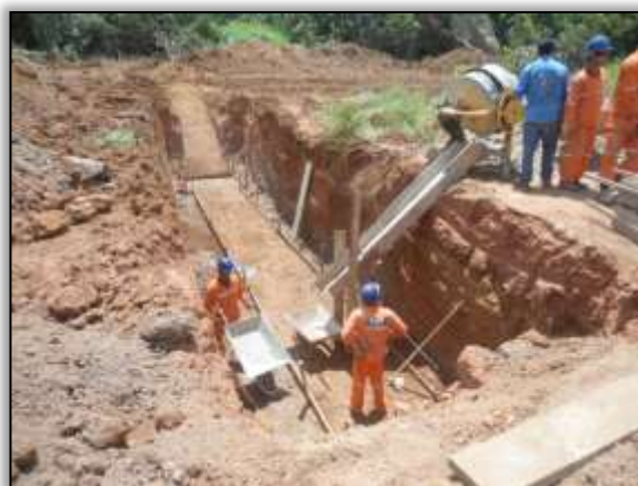
Foto 931 – Implantação de bueiro. Estaca 7680. S 03.86258° W 054.09551° 21/01/2014
