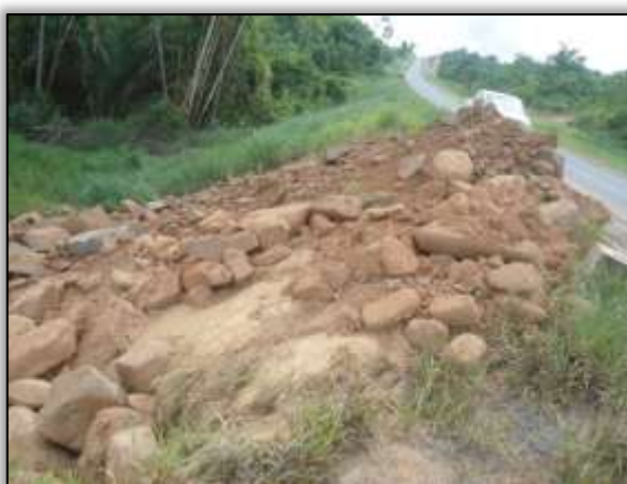
Foto 1195 – Material rochoso na faixa de domínio. Lado esquerdo. Estaca 2591. S 03.37218° W 052.65399° 17/12/2013.
