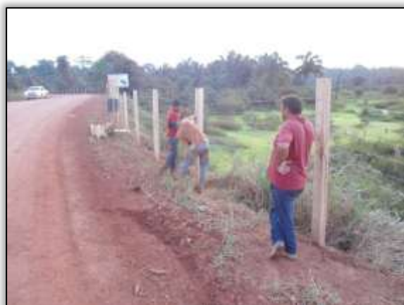
Foto 574 – Instalação de cercas na T.I. Parakanã próximo ao rio Pucuruí. Lado esquerdo. S 04.43354° W 049.92784°. 30/10/2013.
