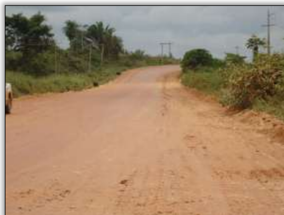
Foto 473 – Trecho após a execução da atividade de terraplenagem. S 05.26046° W 049.33260° 29/10/2013
