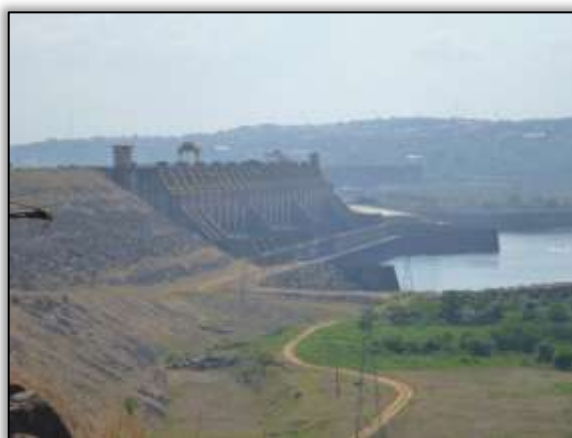
Foto 1510 – Usina de Tucuruí – Comportas fechadas 3.856135° S 49.678537° W (12/10/2013).
