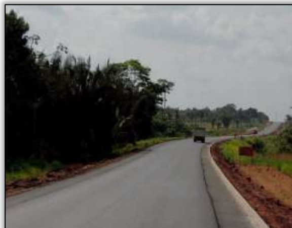
Foto 27- Andamento da obra de pavimentação do lote 04 (sentido Altamira/Anapu.
