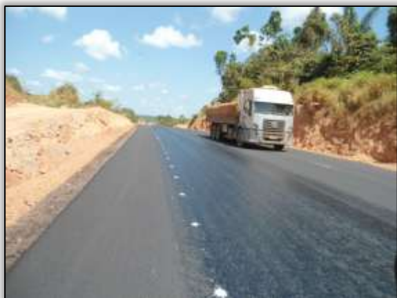
Foto 680 – Pavimentação asfáltica (1ª camada). Lado direito e esquerdo. Estaca 3448. S 03.11817° W 051.61281° 25/09/2013
