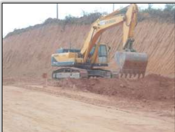
Foto 642 – Corte e conformação de talude. Lado direito. Estaca 4588. S 03.59184° W 051.05843° 16/09/2013
