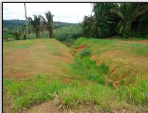
Foto 566 – Revestimento vegetal em aterro. Lado esquerdo. S 03.93081° W 050.33004° 29/01/2014
