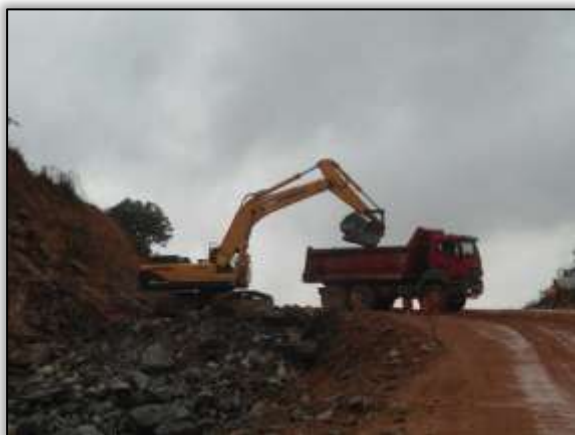
Foto 656 – Corte de talude e conformação da rodovia. Lado direito. S 03.70137° W 050.91754° 30/10/2013
