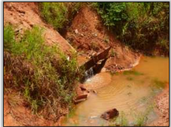
Foto 1416 – Ponto 40 – Montante – Bueiro de concreto. 3.133422° S 51.717803° W (10/10/2013).
