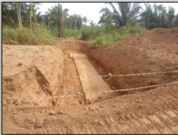
Foto 960 - Bueiro. S 03.85141° W 054.15584°. 18/12/2013
