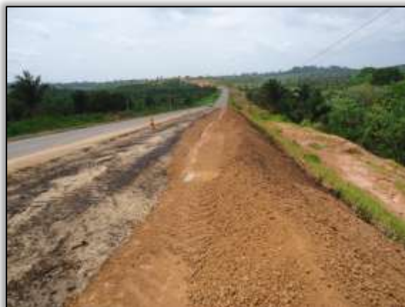
Foto 537 – Recuperação da plataforma. Lado direito. S 03.97974° W 050.31995° 24/09/2013
