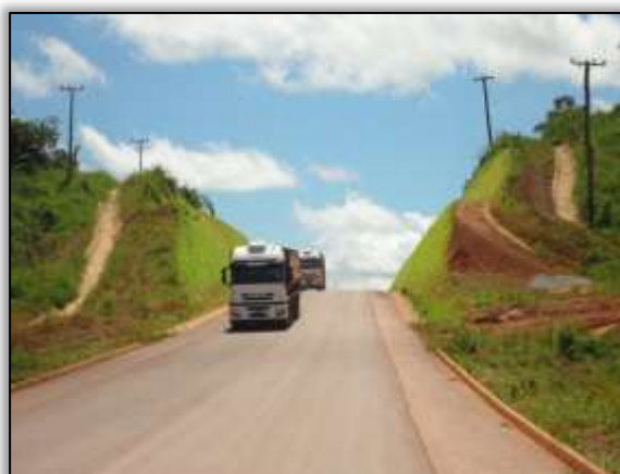
Foto 1071 – Revestimento vegetal em talude de corte. Ambos os lados. S 04.03120° W 050.28943° 25/07/2013
