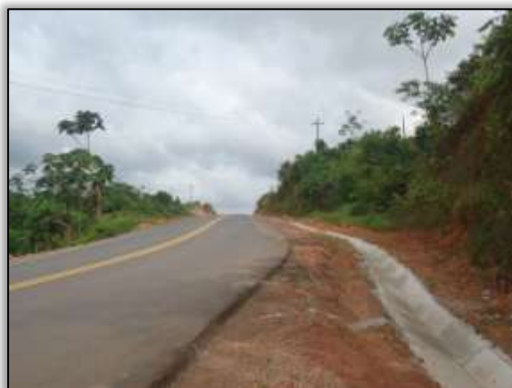
Foto 1123 – Descida d’água em fase instalação. Lado direito. S 04.22105° W 049.97817° 12/11/2013
