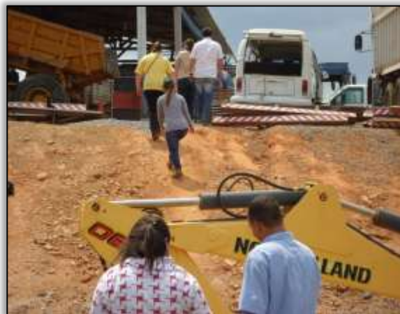
Foto 258- Em companhia dos colaboradores do DNIT e da Gestão Ambiental, todo o canteiro de obra da Torc, situado em Anapu-PA, foram avaliados pela equipe do IBAMA. 17/10/2013.
