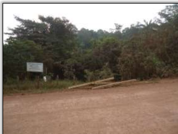
Foto 572 – Instalação de cercas na T.I. Parakanã próximo ao rio Xataopawa. Lado esquerdo. S 04.59291° W 049.78441°. 23/10/2013.
