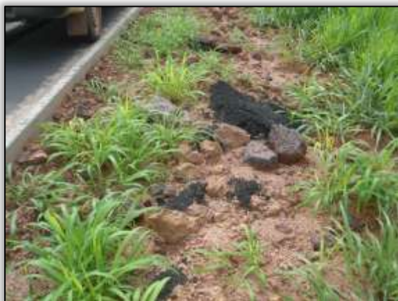
Foto 686– Resíduos de obra. Estaca 3138. Lado Esquerdo. S 03.11550° W 051.57214° 24/01/2014
