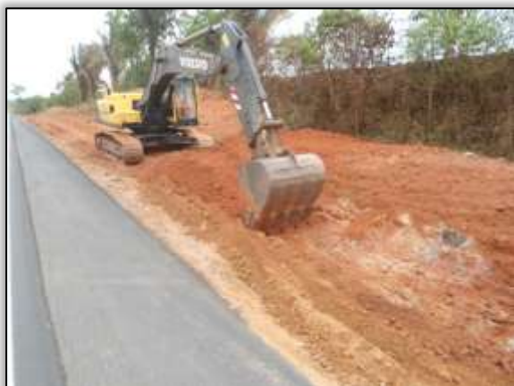
Foto 719 – Escavação para construção do dispositivo de drenagem. Lado esquerdo. Estaca 3716. S 03.10853° W 051.65794° 20/11/2013
