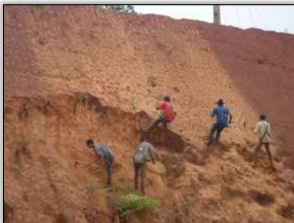
Foto 1078 – Preparação de talude para realização da hidrossemeadura. Lado esquerdo. S 05.22779° W 049.33834° 15/01/2014
