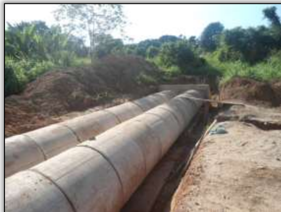
Foto 953– Construção de bueiro. S 03.87593° W 054.24310° 26/11/2013.
