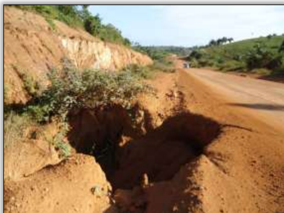
Foto 1062 – Erosão avançando para pista de rolamento em 23/07/2013. Lado direito. S 05.12553° W 049.39888°.
