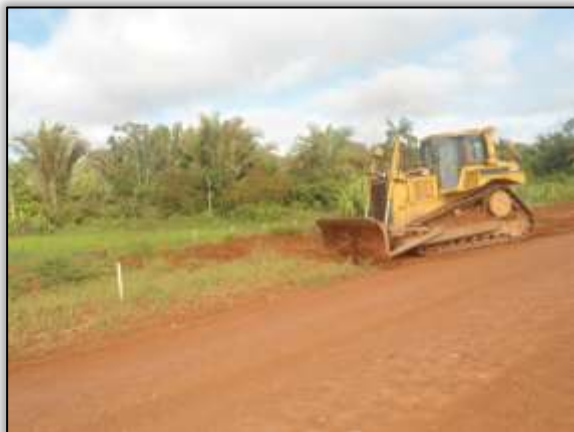
Foto 1215 – Limpeza com máquina. Lado Esquerdo. Estaca 5192. S 03.52804° W 051.14214° 24/08/2013
