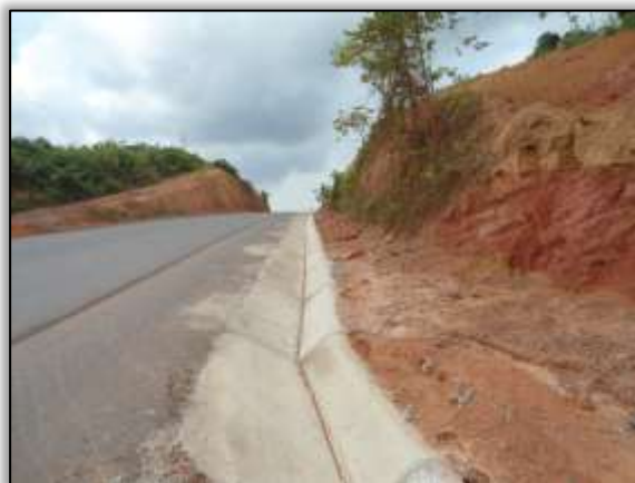
Foto 1117 – Descida d'água instalada. Lado direito. S 04.23015º W 049.96973º 27/11/2013
