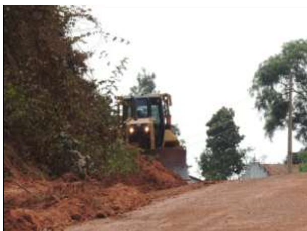
Figura 64. Limpeza de área nas proximidades da rodovia. Data: 11/12/2013 22M 0683061 E / 9423353 N
