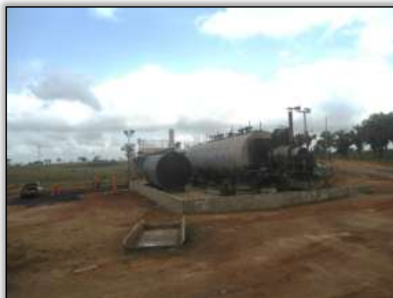
Foto 760 - Usina de asfalto. Estaca 1880. Lado direito. S03. 30814° W052. 54790° 10/10/2013.
