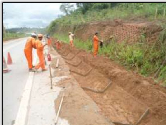
Foto 713 – Construção de sarjeta. Lado Esquerdo. S 03.12588 ° W 051.75270° 13/12/2013
