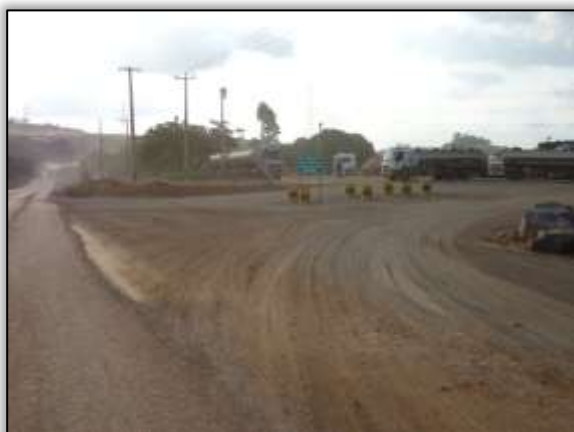
Foto 423 – Entrada para o estacionamento do CCBM. Lado direito. S 03.12371 ° W 051.78945 ° 28/08/2013
