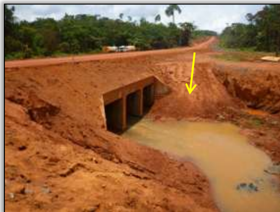
Foto 1454 – Ponto 50 – Jusante – Galeria e deslizamento de terra para o igarapé. S 3.411988° W 52.777656° (09/10/2013).
