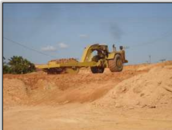
Foto 513 – Atividade de compactação do solo. S 04.15108° W 049.56407° 01/10/2013
