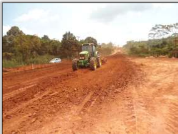
Foto 845 – Gradição do solo. Estaca 3682. S 03.43962° W 052.83486° 17/09/2013.
