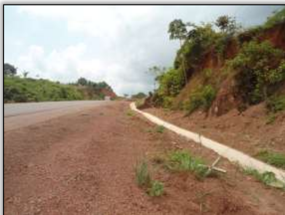
Foto 1116 – Descida d'água instalada. Lado direito. S 04.23566º W 049.96146º 27/11/2013
