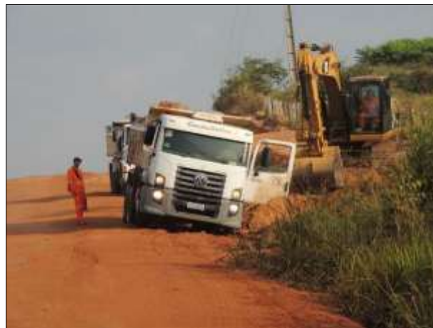
Figura 49. Limpeza de área na margem da rodovia. Data: 28/10/13 _ 22M 0679563 E / 9428912 N
