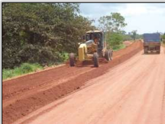
Foto 692 – Obras de terraplenagem na rodovia. Lado esquerdo. Estaca 3564. S 03.10972° W 051.63248° 29/08/2013
