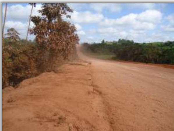
Foto 1104 – Processo erosivo no bordo da pista (antes). Lado esquerdo. S 04.19880º W 050.00027º 18/06/2013
