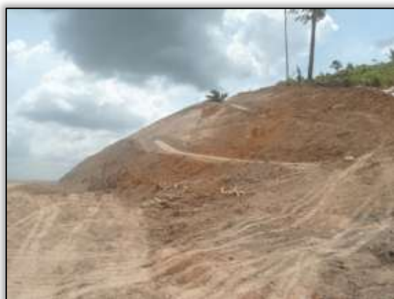
Foto 854 – Construção de drenagem. Lado direito. Estaca 2665. S 03. 37793°. W 052. 66531° 27/09/2013.
