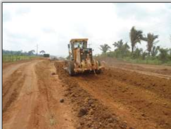
Foto 478 – Atividades de terraplenagem. Lado direito. S 05.21997° W 049.34412° 04/12/2013
