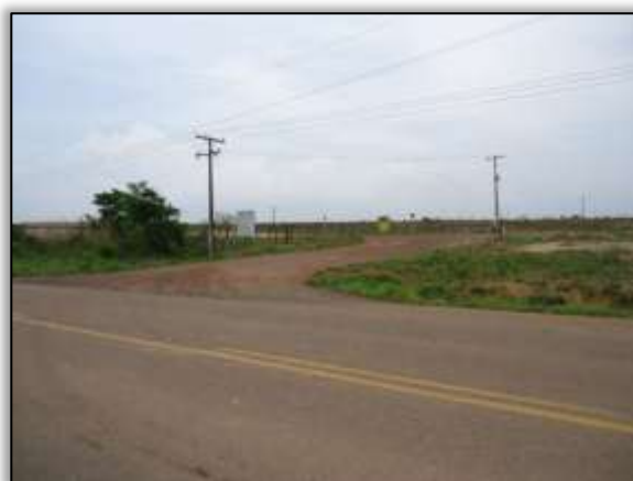
Foto 406 – Entrada para áreas de apoio do canteiro de obras. S 05.14985°W 049.38852° 23/10/2013
