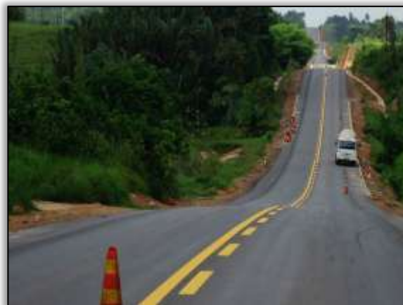
Foto 358 – Trecho entre os municípios de Novo Repartimento e Pacajá/PA – 18/12/13.
