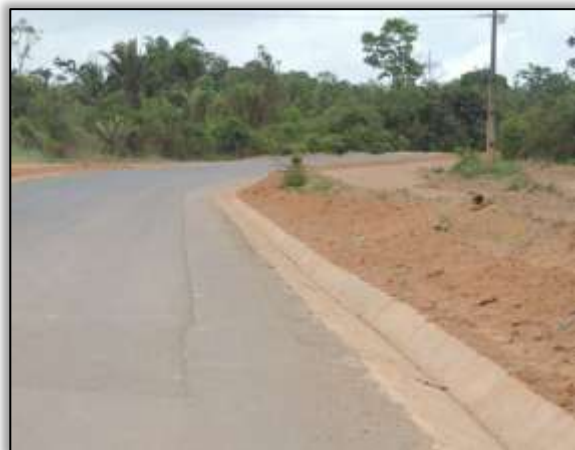
Foto 31- Andamento da pavimentação do lote 05 (sentido Brasil Novo e Altamira).
