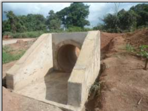
Foto 1015 – Construção de bueiro. Estaca 8674. S 03.88626° W 054.26497° 27/12/2013.
