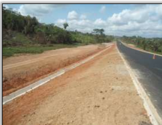
Foto 1167 – Valeta de drenagem. Lado direito. Estaca 1608. S 03.29980° W 052.49967° 17/12/2013.
