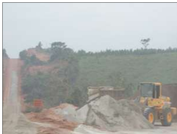
Figura 67. Colocação de subpiso para pavimentação de trecho da rodovia.
