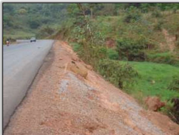
Foto 1091 – Processo erosivo reconformado (depois). Lado direito. S 04.23299° W 049.96426° 18/09/2013
