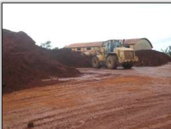
Foto 837 – Retirada de material. Lado direito. S 03. 43860° W 052. 86596° 20/08/2013.
