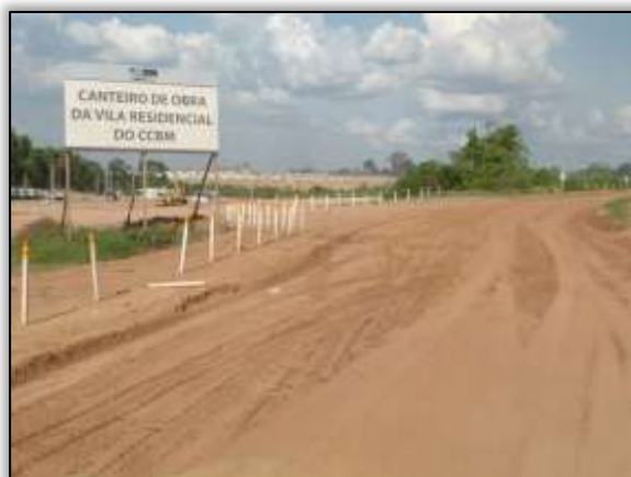
Foto 446 - Acesso a vila residencial CCBM. Lado direito. Estaca 4230. S 03.1251° W 051.74237° 26/11/2013
