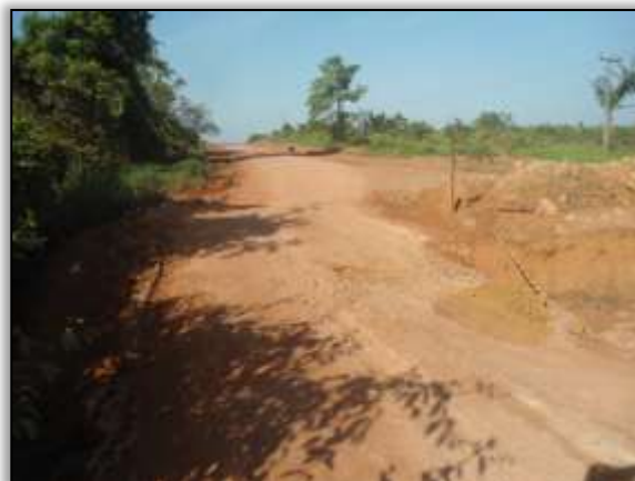
Foto 1014 - Caminho de serviço. Lado esquerdo. Estaca 8671. S 03.88644° W 054.26514°. 26/11/2013.
