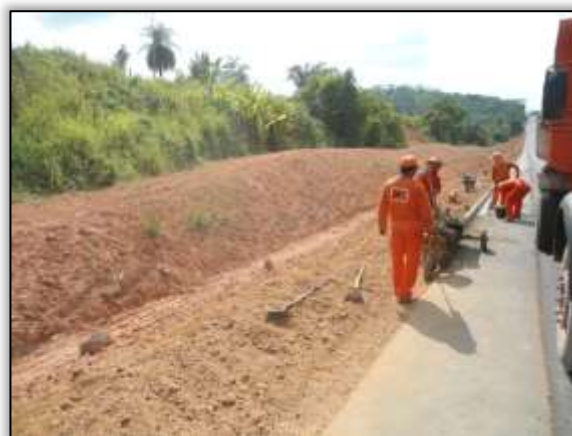
Foto 699 – Construção de sistema de drenagem (meio-fio). Lado esquerdo. Estaca 3396. S 03.12261° W 051.60519° 02/10/2013
