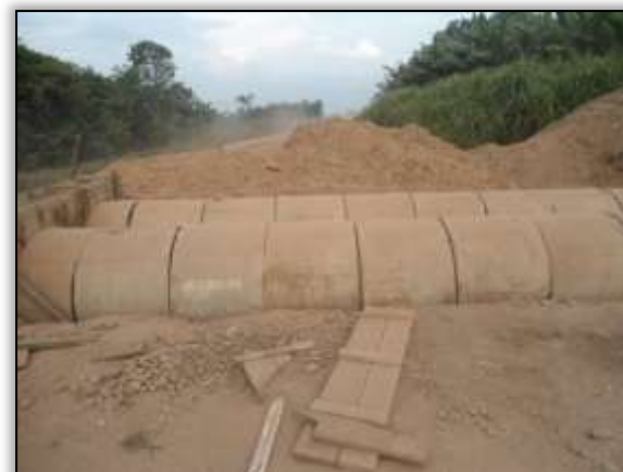
Foto 969 – Construção de bueiro. S 03.87603° W 054.24352° 18/12/2013.
