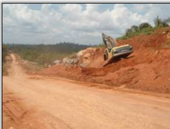
Foto 613 – Conformação do talude de corte. Estaca 4207. Lado direito. S 03.63260° W 051.00341° 12/11/2013
