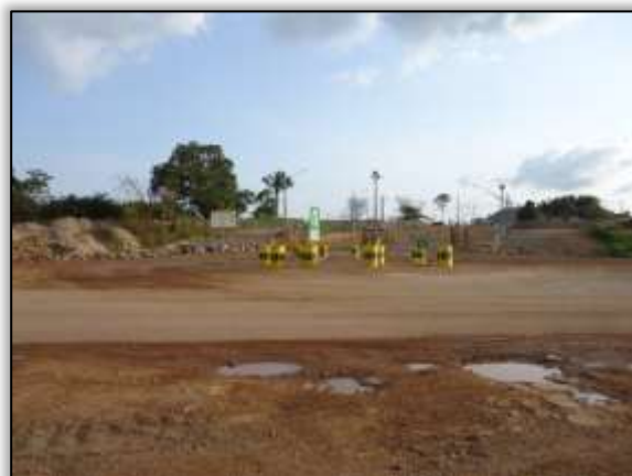
Foto 424 – Acesso ao canteiro de obras do CCBM. Lado esquerdo. S 03.12284° W 051.79378° 28/08/2013
