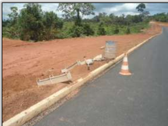
Foto 1176 – Construção de descida d'água. Lado direito. Estaca 3578. S 03.43419° W 052.81722° 17/12/2013.
