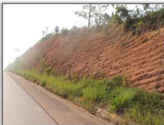
Foto 363 – Trecho entre os municípios de Pacajá e Anapu/PA, fase de hidrossemeadura. 11/12/13.
