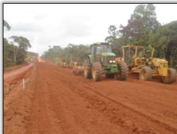
Foto 866 - Serviços de terraplenagem. Estaca 3325. S 03.41220° W 052.77825°. 10/10/2013.
