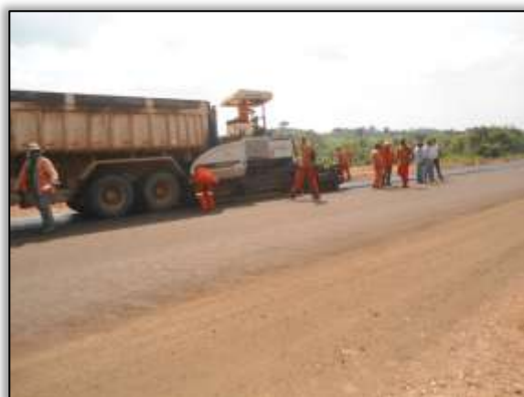
Foto 624 – Pavimentação da primeira camada. Lado esquerdo. Estaca 4510. S 03.59880° W 051.04626° 05/12/2013
