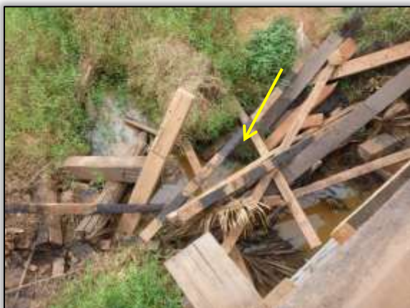
Foto 1363 – Ponto 27 – Toras de madeira. 3.905142° S 50.363235° W (12/10/2013).
