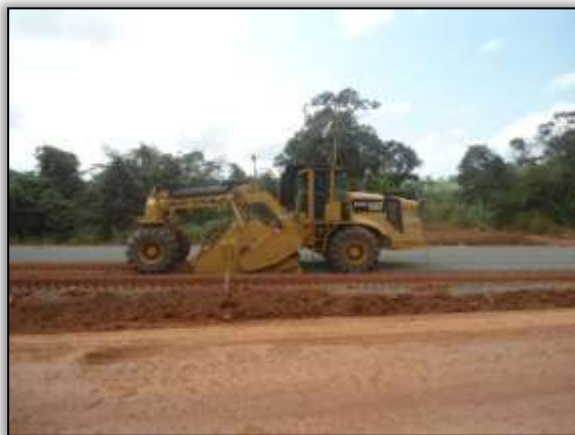
Foto 875 - Máquina Recicladora. Estaca 3607. S 03.43663° W 052.82151°. 23/10/2013.
