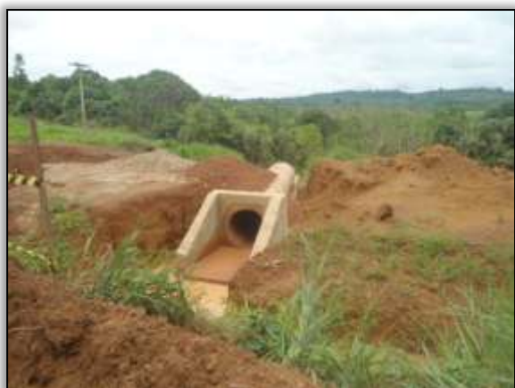
Foto 997 – Bueiro em construção. Estaca 8948. S 03.89120° W 054.31135° 29/01/2014
