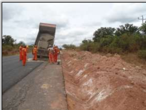
Foto 743- Construção de sarjeta. Lado Direito. Estaca 3791. S 03.11270° W 051.67028° 29/10/2013
