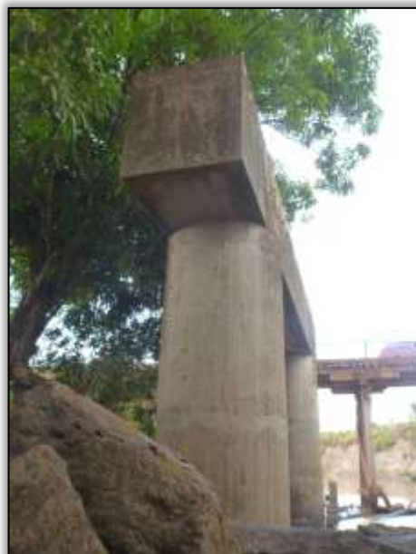
Foto 1448 – Ponto 49 – Estrutura de concreto. S 3.387970° W 52.692354° (09/10/2013).
