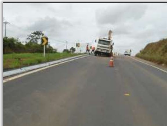
Foto 715 – Instalação de defesa metálica. Estaca 6072. Lado Esquerdo. S 03.45068° W 051.21939° 28/01/2014
