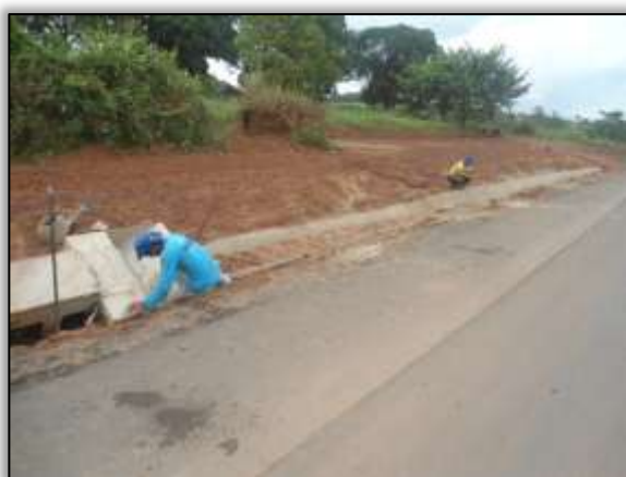
Foto 1190 – Construção de valeta. Lado esquerdo. Estaca 2241. S 03.34256° W 052.59921° 27/12/2013.
