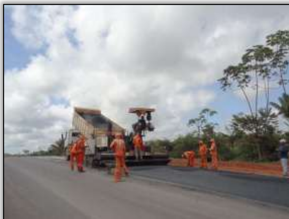
Foto 528 – Primeira camada asfáltica. Lado direito. S 04.25975° W 050.10349° 31/07/2013
