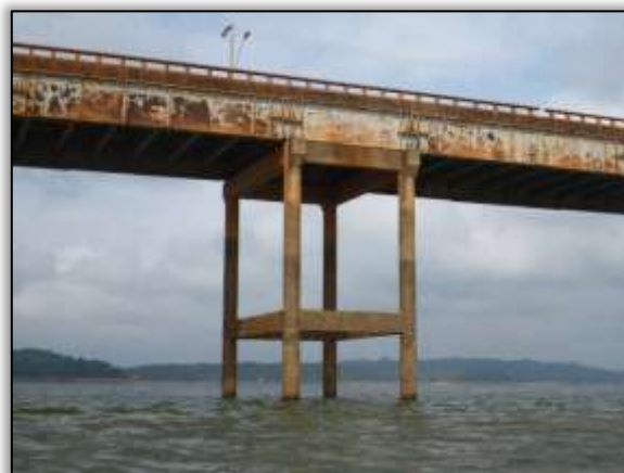
Foto 1513 – Ponto 21 – Ponte de concreto com estrutura metálica. 3.856135° S 49.678537° W (13/10/2013).
