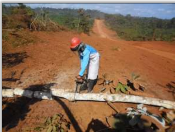
Foto 1237 – Corte para enleiramento. Lado esquerdo. S 03. 43275° W 052. 81514° 13/05/2013
