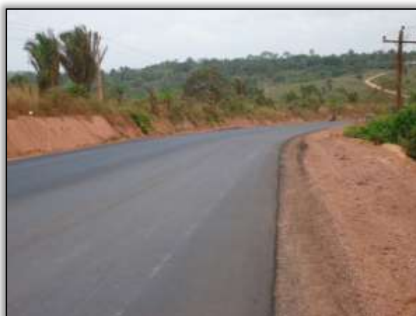
Foto 1095 – Processo erosivo reconformado (depois). Lado direito. S 04.22874° W 049.97234° 18/09/2013
