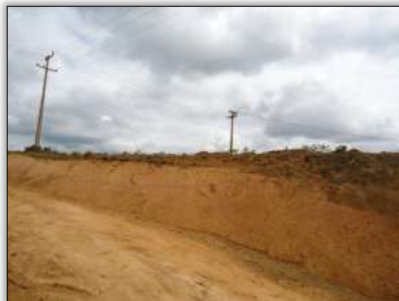
Foto 490 – Local após a retirada de material. Lado direito S 05.14524° W 049.38962° 21/10/2013
