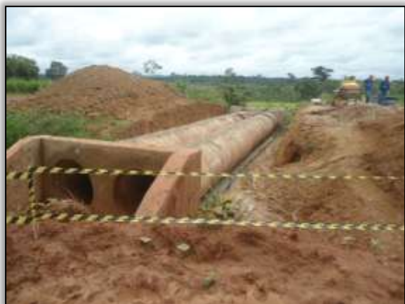
Foto 1001 - Bueiro em construção. S 03.89170° W 054.33467° 29/01/2014
