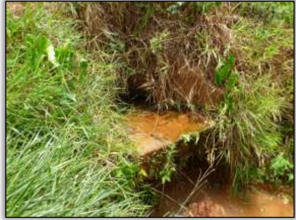
Foto 1347 – Ponto 22 – Jusante – Bueiro (seco) 4.161368° S 50.094273° W (12/10/2013).
