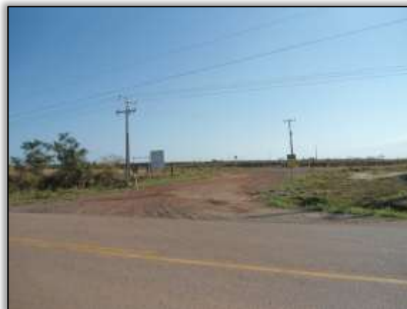
Foto 402 – Entrada para áreas de apoio do canteiro de obras. S 05.14985°W 049.38852° 29/08/2013
