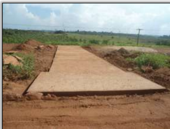
Foto 1021 – Bueiro. S 03.89171° W 054.33097°. 27/12/2013.
