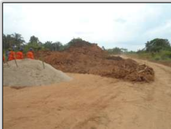
Foto 947 – Construção de bueiro. S 03.85095° W 054.15302° 11/11/2013.
