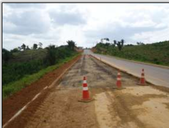
Foto 542 – Recuperação da rodovia. Lado esquerdo. S 03.97974° W 050.31995° 24/09/2013
