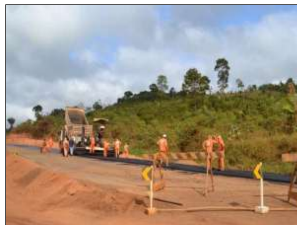
Figura 41. Funcionários da construtora em obras de pavimentação. Data: 16/10/2013
