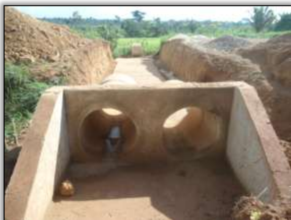
Foto 1023 – Construção de bueiro. S 03.89175° W 054.33456°. 27/12/2013.
