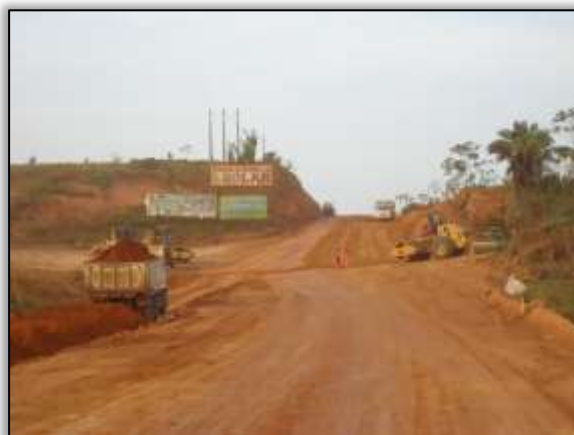
Foto 515 – Atividade de compactação do solo. S 04.26239° W 049.94836° 24/10/2013
