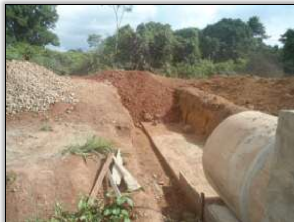
Foto 1016 – Construção de bueiro. Estaca 8674. S 03.88626° W 054.26497° 27/12/2013.
