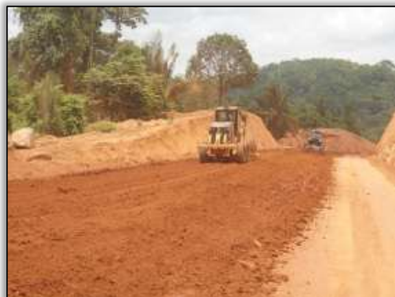
Foto 662 – Atividades de terraplenagem. Lado esquerdo. Estaca 4727. S 03.57777° W 051.07808° 23/10/2013
