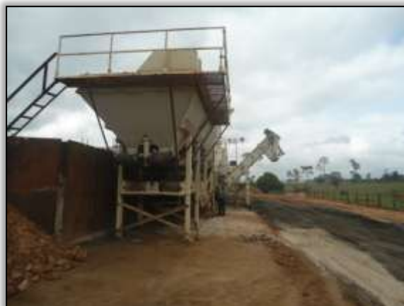
Foto 761 - Usina de asfalto. Estaca 1880. Lado direito. S03. 30814° W052. 54790° 10/10/2013.
