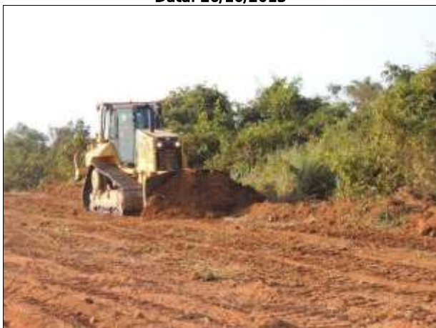
Figura 46. Limpeza em área próxima à rodovia. Data: 26/10/2013
