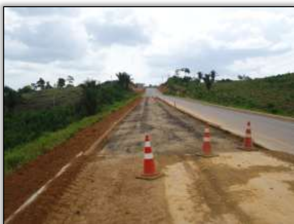
Foto 538 – Recuperação da plataforma. Lado esquerdo. S 03.97974° W 050.31995° 24/09/2013
