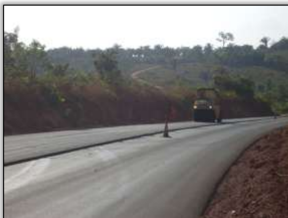
Foto 532 – Compactação asfáltica. Lado esquerdo. S 04.13449° W 050.58217° 01/10/2013
