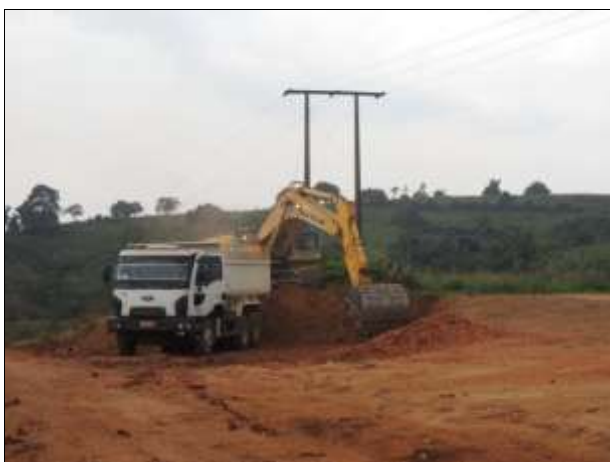
Figura 56. Empréstimo de material para obra de terraplenagem. Data: 14/11/2013 _ 22M 0675817 E / 9436057 N
