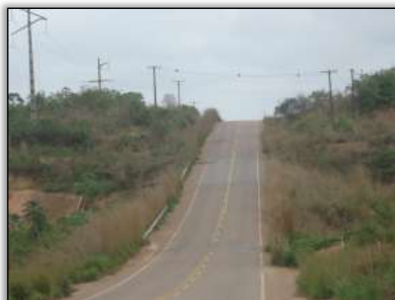
Foto 414 – Entrada para áreas de apoio do canteiro de obras. S 05.14985°W 049.38852° 17/09/2013
