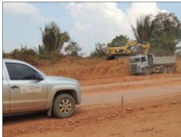
Figura 61. Equipe acompanhando atividade de empréstimo de material para obra. Data: 04/12/2013 _ 22M 0676127 E / 9435731N
