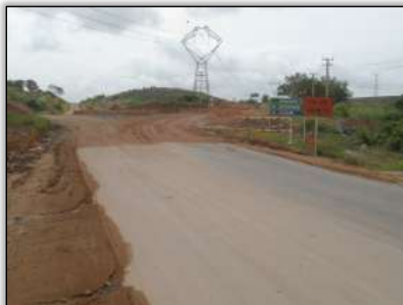
Foto 454– Entrada do desvio da rodovia. Lado direito. Estaca 4370. S 03.12614° W 051.76251° 26/12/2013.
