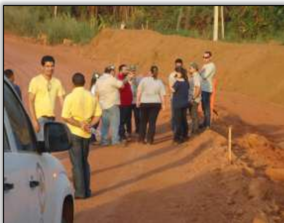
Foto 259- IBAMA e participantes da vistoria discutem situação dos trechos em obras- 17/10/2013.
