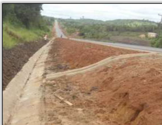
Foto 890 – Sarjeta concluída. Lado esquerdo. S 03. 34004° W 052. 59074° 28/01/2014
