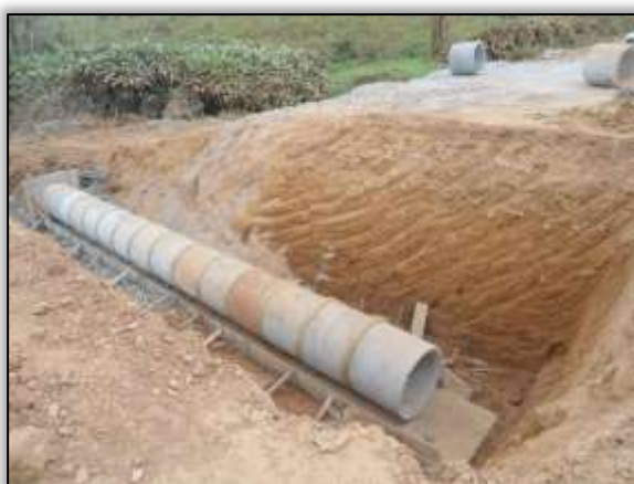
Foto 634 – Bueiro simples. Lado esquerdo. Estaca 3646. S 03.69408° W 050.92722° 23/10/2013
