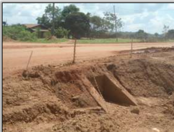
Foto 943 – Bueiro concluído. S 03.87191° W 054.22857°. 24/01/2014
