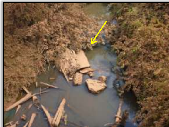
Foto 1388 – Ponto 33 – Resto de bueiro de concreto. 3.727251° S 50.876172° W (11/10/2013).
