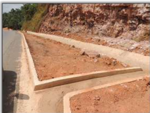
Foto 369 – Trecho entre os municípios de Altamira e Medicilândia, fase construção de obras-de-arte correntes. 04/12/13.
