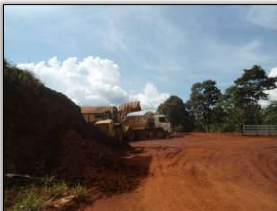
Foto 838- Retirada de material. Lado direito. S 03. 43860° W 052. 86596° 20/08/2013.
