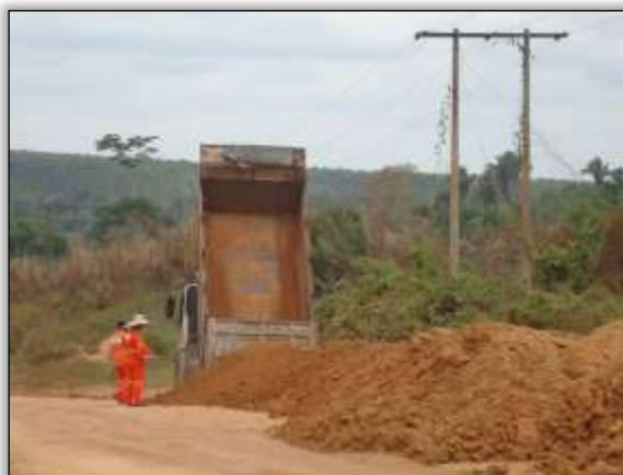
Foto 492 – Utilização de material de corte. Lado direito. S 05.14375° W 049.39030° 21/10/2013
