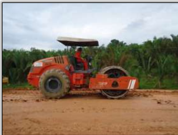
Foto 493 – Atividade de compactação do solo. Lado esquerdo. S 04.25050° W 049.04603° 12/11/2013
