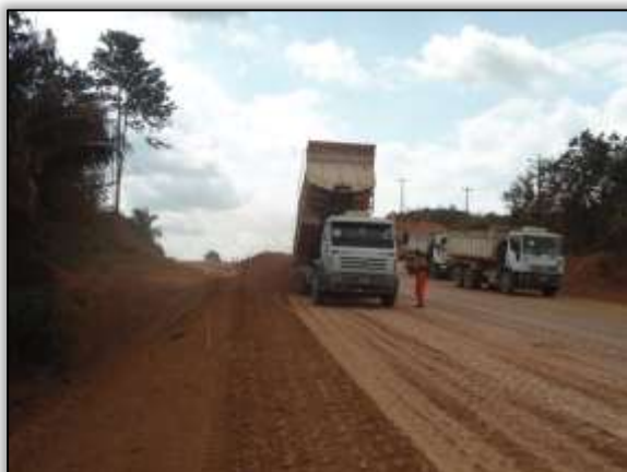
Foto 644 – Atividades de terraplenagem. Lado esquerdo. Estaca 4588. S 03.59185° W 051.05843° 16/09/2013
