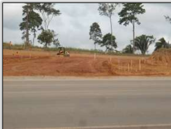
Foto 894 – Construção de trevo na entrada da vicinal 12. Lado direito. S 03.28687° W 052.48946° 13/11/2013.
