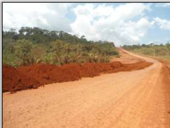
Foto 826– Material para terraplanagem. Estaca 3542. S 03. 43032° W 052. 81293° 20/08/2013.
