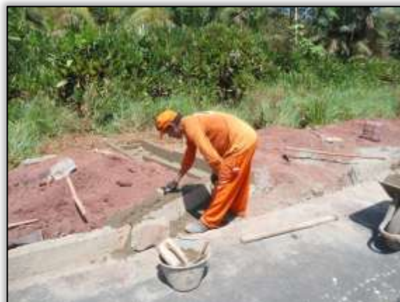
Foto 703 – Construção de sistema de drenagem (descida d'água). Lado esquerdo. Estaca 3084. S 03.16293° W 051.56593° 25/09/2013
