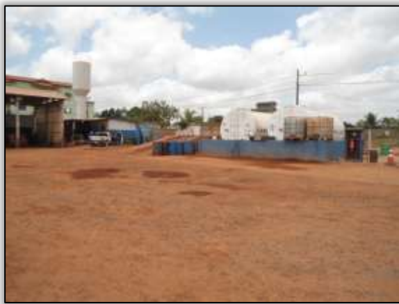
Foto 754 – Canteiro de obra. Lado esquerdo. Estaca 1827. S 03.30872° W 052. 53631 17/09/2013.
