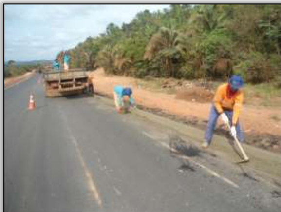
Foto 1154 - Construção de meio-fio. Lado direito Estaca 1903. S 03.31085° W 052. 54976°. 17/10/2013
