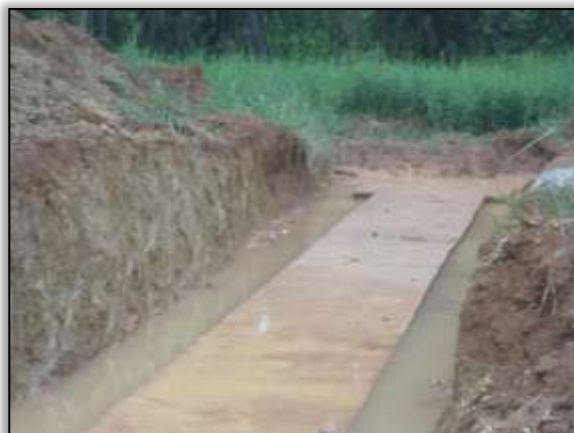
Foto 1004 - Bueiro em construção. Estaca 9246. S 03.88422° W 054.36125° 30/01/2014
