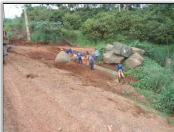
Foto 1163 – Construção de valeta. Lado direito. Estaca 3350. S 03.41366° W 052.78276° 28/11/2013.
