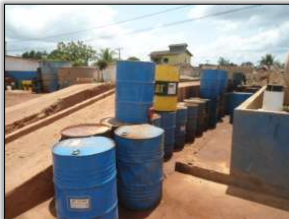
Foto 759 - Canteiro de obra. Lado esquerdo. Estaca 1827. S 03.30872° W 052. 53631 10/10/2013.
