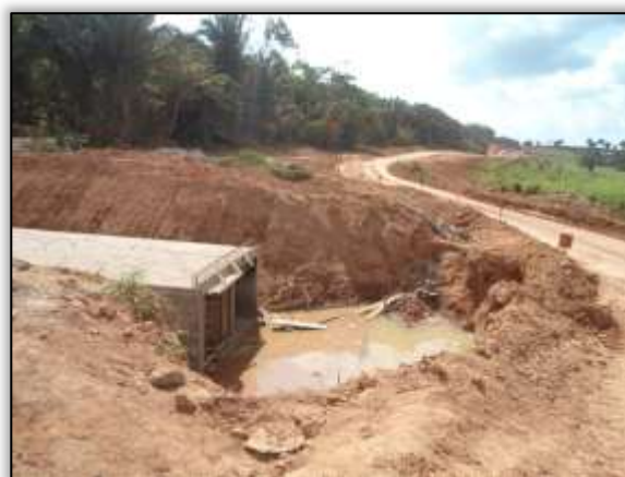
Foto 629 – Construção de bueiro celular duplo. Lado esquerdo. Estaca 4282. S 03.62357° W 051.01411° 16/09/2013
