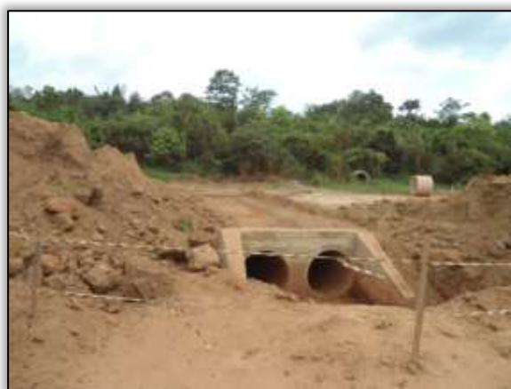
Foto 949 – Construção de bueiro. S 03.86237° W 054. 19567° 11/11/2013. Depois.
