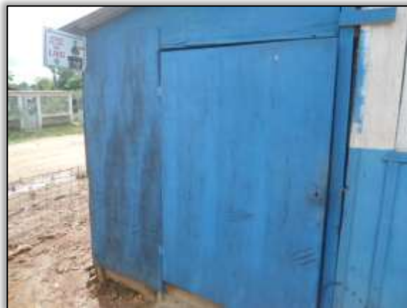
Foto 777 - Armazenamento de resíduos. Lado esquerdo. Estaca 1827. S 03.30872° W 052.53631° 28/01/2014
