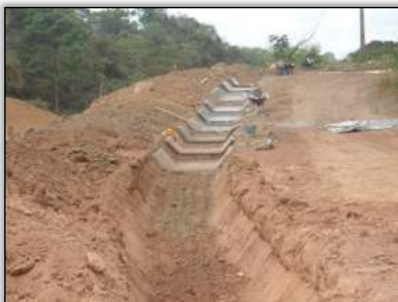
Foto 636 – Dispositivo de drenagem (valeta). Lado direito. Estaca 4953. S 03.55435° W 051.10819° 30/10/2013
