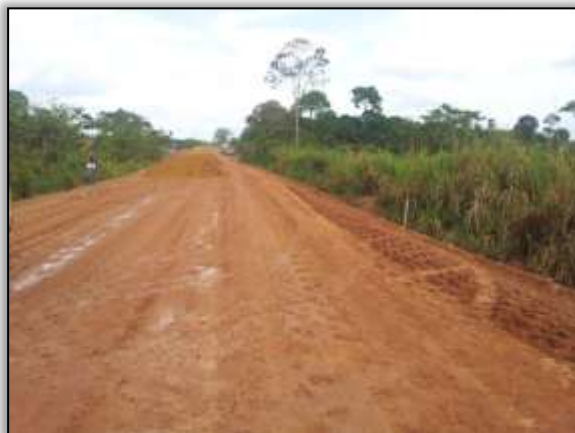
Foto 987 - Terraplanagem. Estaca 8786. S 03. 88940° W 054. 28294° 23/10/2013.
