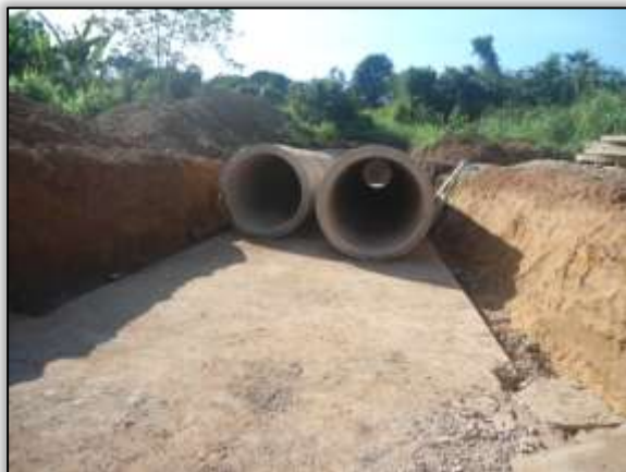
Foto 952 – Construção de bueiro. S 03.87593° W 054.24310° 26/11/2013.
