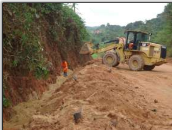
Foto 1040 – Material para aterro de dreno longitudinal. Lado esquerdo. S 05.05820° W 049.44608° 21/01/2014
