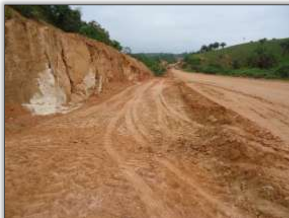
Foto 1063 – Área parcialmente recuperada. Lado direito. S 05.12553° W 049.39888°. 13/11/2013
