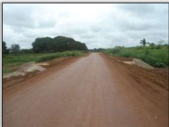
Foto 993 – Bueiro concluído. Estaca 8751. S 03.89060° W 054.27680 29/01/2014
