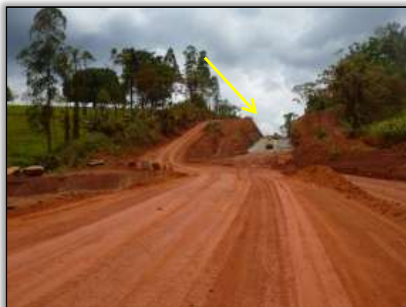
Foto 1456 – Ponto 50 – Obras no trecho. S 3.411988° W 52.777656° (09/10/2013).
