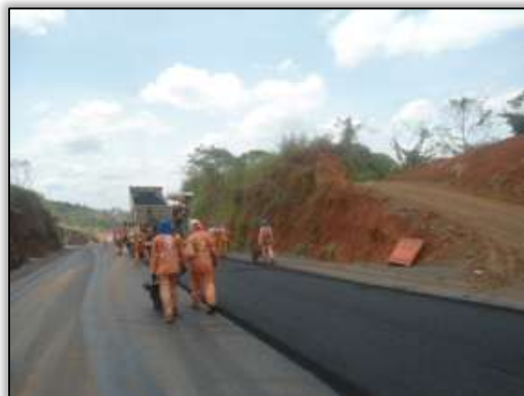
Foto 906 – Segunda camada asfáltica. Estaca 3702. S 03.44061° W 052.83834° 18/12/2013.
