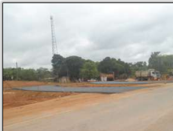
Foto 900 - Pavimentação do trevo na vicinal 11. Lado esquerdo. S 03.29595° W 052.48883° 20/11/2013.
