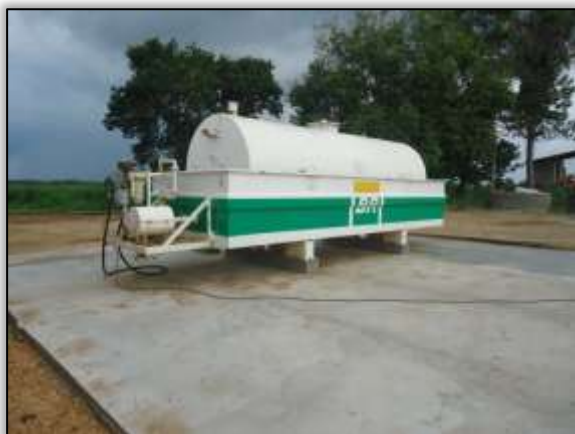
Foto 501 – Instalação do tanque de combustível no canteiro de obras. S 05.14421° W 049.35834° 22/01/2013
