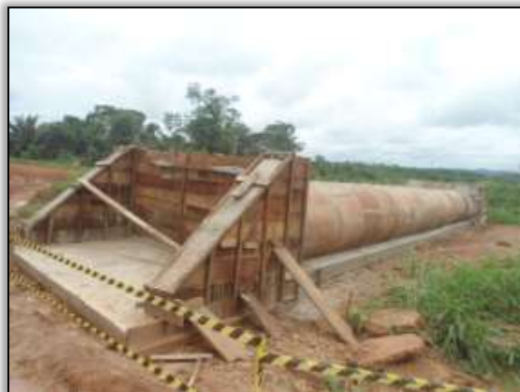
Foto 1000 - Bueiro concluído. S 03.89171° W 054.33133° 29/01/2014
