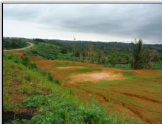
Foto 1083 – Bacia de contenção após o revestimento vegetal. Lado direito. S 03.03093° W 050.32953° 15/01/2014
