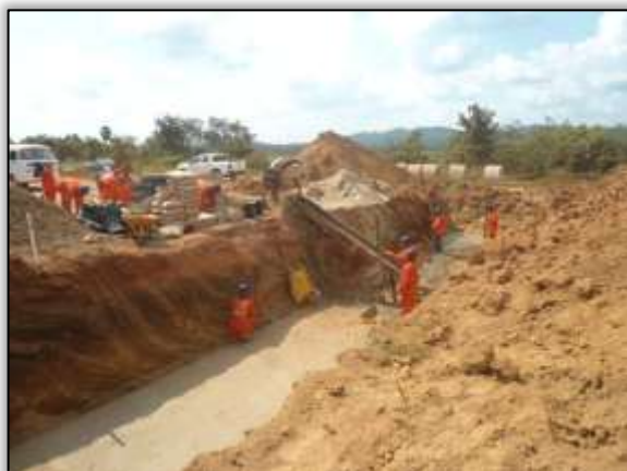
Foto 923 – Construção de bueiro. S 03.86237° W 054. 19567° 17/10/2013.
