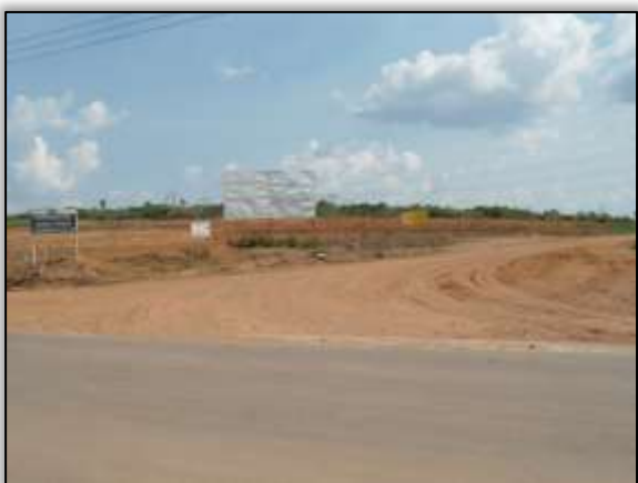
Foto 445 – Acesso ao Canteiro Bela Vista - canais e diques. Lado Esquerdo. Estaca 4258. S 03.12479° W 051.73776° 26/11/2013
