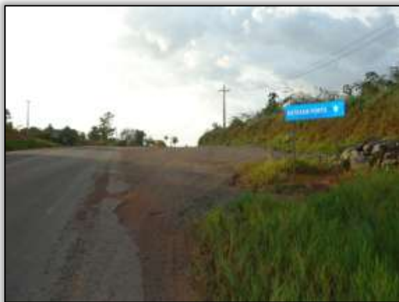
Foto 425 – Acesso ao porto do CCBM. Lado esquerdo. S 03.12021° W 051.79644° 28/08/2013
