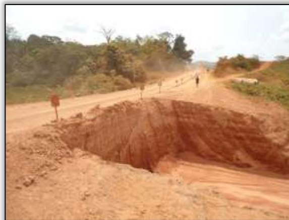
Foto 631 – Construção de bueiro celular. Lado direito. Estaca 3861. S 03.66458° W 050.95529 02/10/2013
