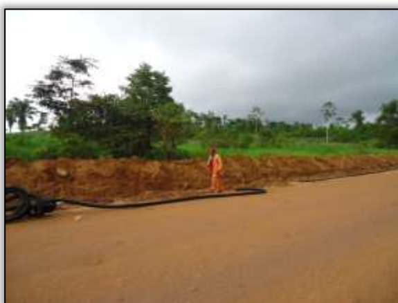
Foto 1035 – Alocação de dreno longitudinal. Lado esquerdo. S 05.20109° W 049.35786° 21/01/2014
