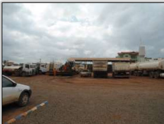
Foto 764 – Canteiro de obra. Lado esquerdo. Estaca 1827. S 03.30872° W 052.53631° 13/11/2013.
