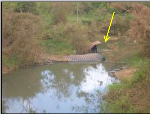
Foto 1483 – Ponto 57 – Montante – Bueiro ARMCO. S 3.704800° W 53.673930° (08/10/2013).
