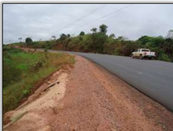
Foto 1099 – Processo erosivo reconformado (depois). Lado esquerdo. S 04.22207º W 049.97798º 18/09/2013
