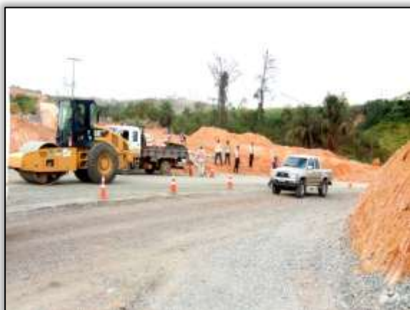
Foto 180 – Registro das atividades de desvio no trecho da BR-230/PA, que atravessa o canteiro do Sítio Belo Monte. Data: 16/08/2013.
