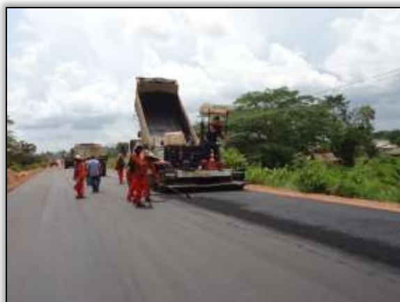
Foto 674 – Pavimentação asfáltica. Lado direito. Estaca 3272. S 03.13802° W 051.58896° 29/08/2013
