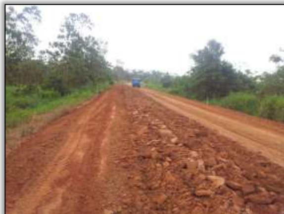
Foto 990 - Terraplanagem. Estaca 8786. S 03. 88940° W 054. 28294° 23/10/2013.
