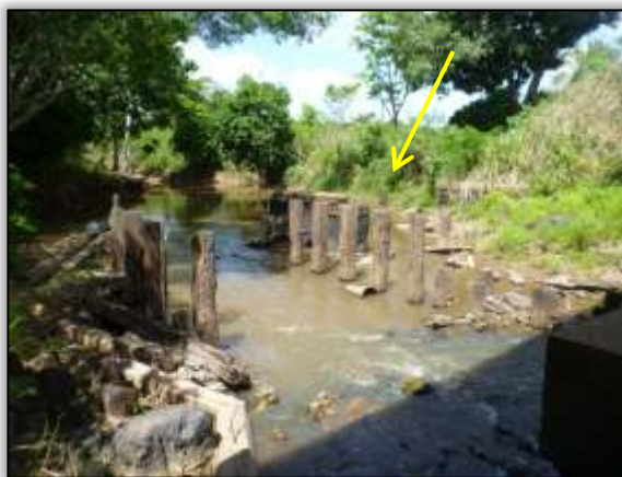
Foto 1309 – Ponto 10 – Montante – Toras de madeira. 5.298303° S 49.278890° W (14/10/2013).
