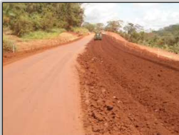
Foto 814 – Gradição do solo. Estaca 3535. Lado direito. S 03. 42988° W 052. 81137° 14/08/2013
