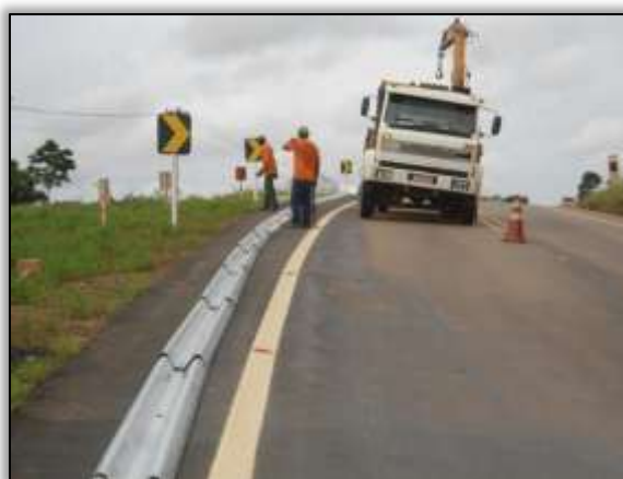
Foto 716– Instalação de defesa metálica. Estaca 6072. Lado Esquerdo. S 03.45068° W 051.21939° 28/01/2014
