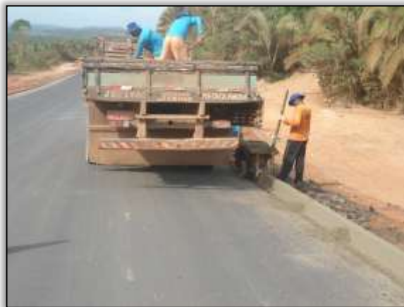
Foto 1155 - Construção de meio-fio. Lado direito Estaca 1903. S 03.31085° W 052. 54976°. 17/10/2013.
