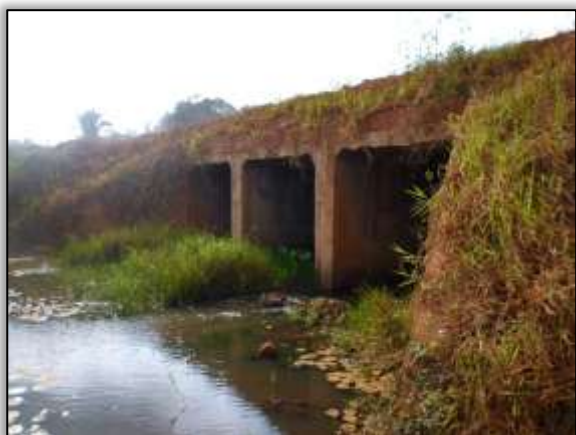
Foto 1371 – Ponto 29 – Galeria tripla. 3.852984° S 50.472992° W (12/10/2013).
