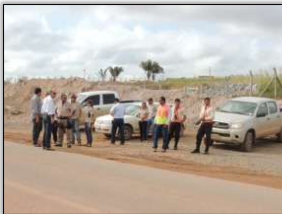
Foto 9 - Visita à obra de desvio da Rodovia Transamazônica em Belo Monte - Município de Altamira/PA, 17/08/2013.
