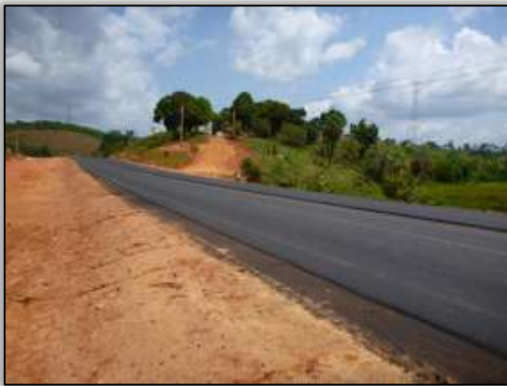
Foto 1415 – Ponto 40 – Trecho asfaltado. 3.133422° S 51.717803° W (10/10/2013).
