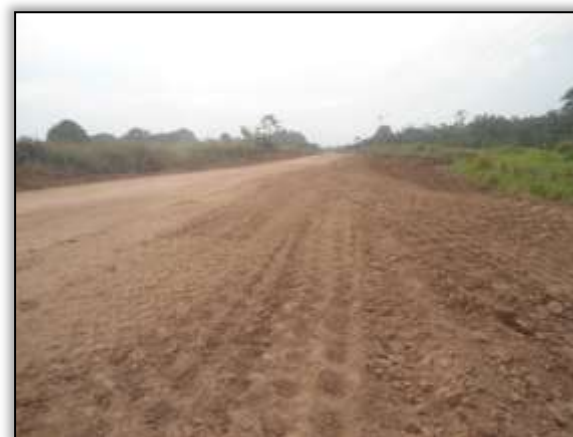
Foto 967 – Bueiro reconformado. Depois. S 03.87243° W 054.22957° 18/12/2013.
