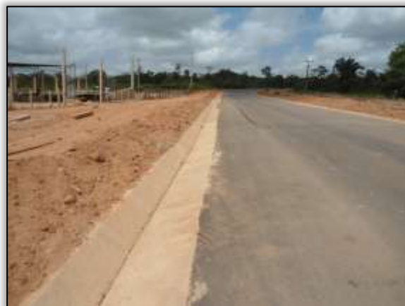
Foto 1150 – Construção de valeta. Lado esquerdo. Estaca 1714. S03. 30678° W052. 51721° 17/09/2013.
