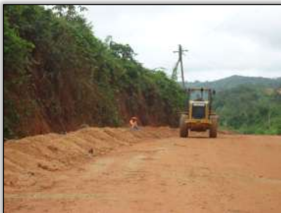
Foto 1039 – Material para aterro de dreno longitudinal. Lado esquerdo. S 05.05821° W 049.44607° 21/01/2014
