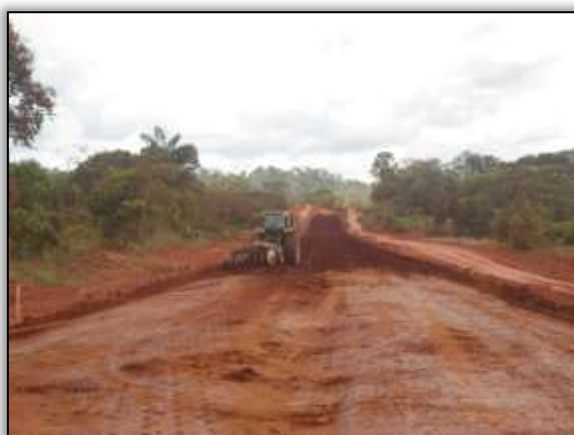
Foto 830 – Terraplanagem. Estaca 3573. S 03 43316° W 052. 81557° 20/08/2013.
