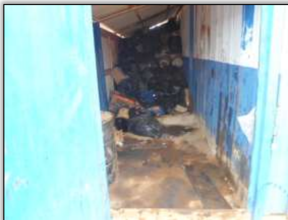
Foto 769 – Armazenamento de resíduos no canteiro de obra. Lado esquerdo. Estaca 1827. S 03.30872° W 052.53631° 13/11/2013.
