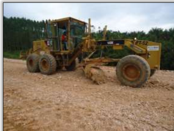
Foto 1054 – Processo erosivo em fase de recuperação. Lado direito. S 05.13041° W 049.39634° . 12/11/2013
