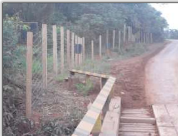
Foto 588 – Cercas instaladas na T.I. Parakanã próximo ao rio Xarayra (baiano). Lado esquerdo. S 04.52939° W 049.83068°. 30/10/2013.
