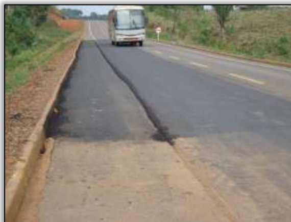
Foto 543 – Recuperação da rodovia com recapeamento. Lado esquerdo. S 03.97974° W 050.31995° 24/10/2013
