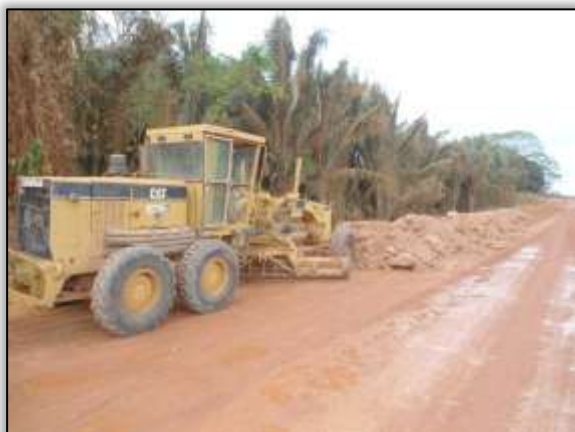
Foto 661 – Atividades de terraplenagem. Lado esquerdo. Estaca 4257. S 03.62567° W 051.01047° 23/10/2013
