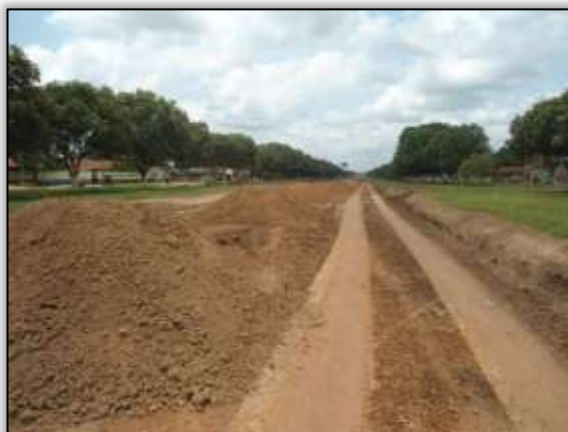
Foto 930 – Terraplanagem na área urbana de Placas. Estaca 8364. S 03. 86700° W 054. 21354° 23/10/2013.
