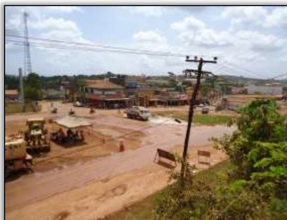
Foto 545 – Vista ampla da duplicação em Novo Repartimento. Eixo da rodovia. S 04.25214° W 049.94487° 01/10/2013
