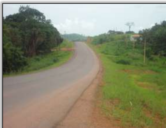
Foto 1073 – Revestimento vegetal em saia de aterro. Lado direito. S 03.99417° W 050.27017° 28/08/2013
