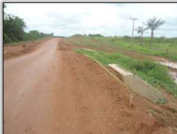
Foto 992 - Bueiro concluído. Estaca 8673. S 03.88625° W 054.26497° 29/01/2014
