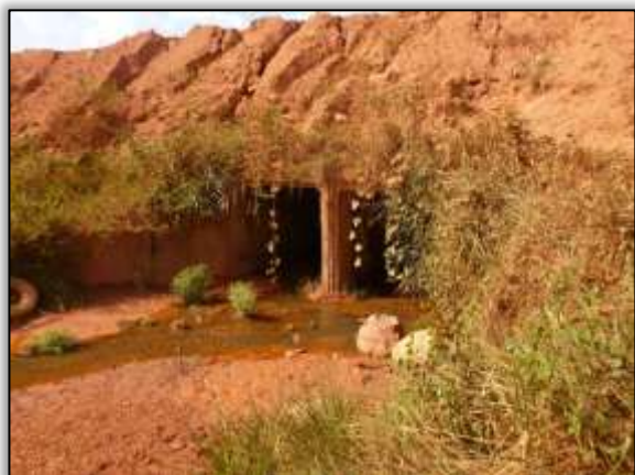
Foto 1384 – Ponto 32 – Bueiro duplo. 3.795758° S 50.763908° W (11/10/2013).
