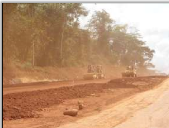
Foto 832– Rolo compactando. Estaca 3645. S 03. 43803° W 052. 82837° 20/08/2013.
