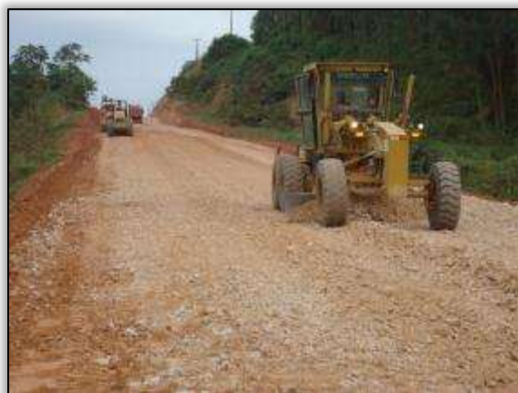
Foto 1065 – Atividade de terraplenagem. Eixo da rodovia. S 04.26239° W 049.94836° 12/11/2013
