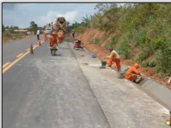
Foto 1138 – Construção de valeta de proteção de corte. Lado direito. Estaca 3978. S 03.11806° W 051.69270° 12/11/2013
