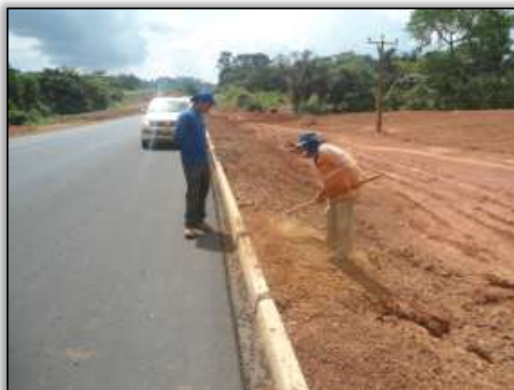
Foto 1177 – Construção de descida d'água. Lado direito. Estaca 3578. S 03.43419° W 052.81722° 17/12/2013.
