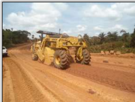
Foto 874 - Máquina recicladora na pista. Estaca 3532. S 03.42967° W 052.81073°. 17/10/2013
