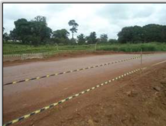
Foto 994 - Bueiro concluído. Estaca 8751. S 03.89060° W 054.27680 29/01/2014
