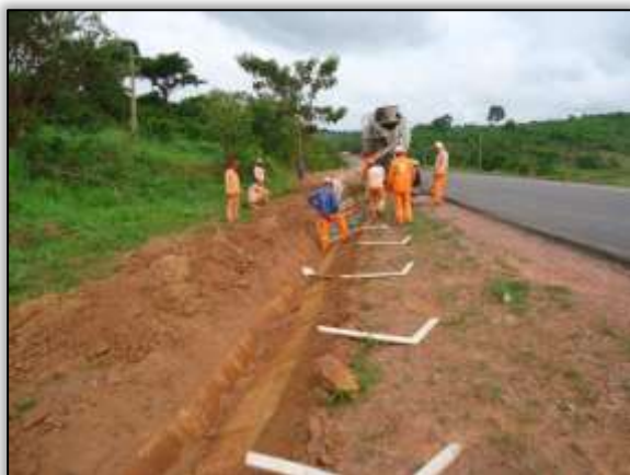
Foto 1124 – Instalação de descida d’água. Lado esquerdo. S 04.20771° W 049.98799° 27/11/2013
