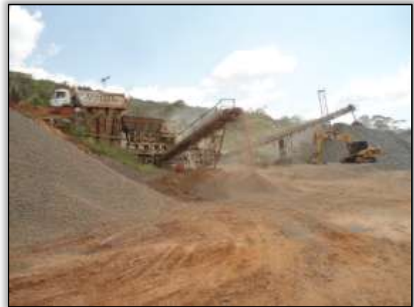
Foto 757 – Britador Sanches Tripoloni. Lado direito. Estaca 3775. S 03.44206° W 052. 85213° 17/09/2013.
