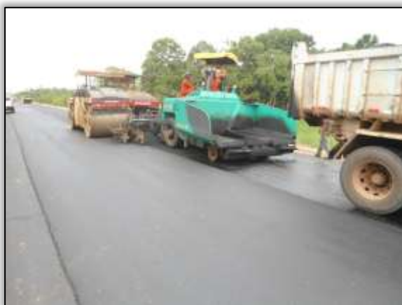
Foto 619 – Pavimentação da segunda camada. Estaca 5236. Lado direito. S 03.54428° W 051.1498° 26/11/2013
