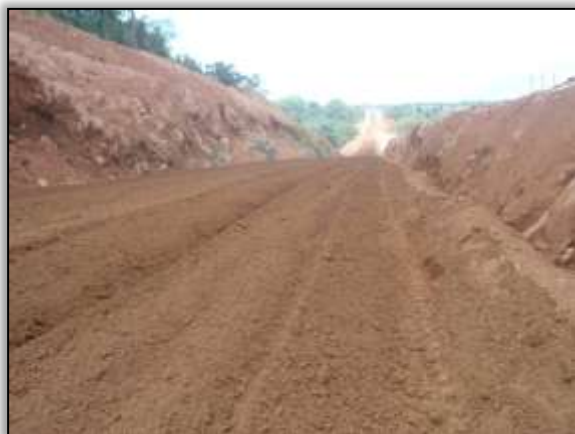
Foto 861 - Serviços de terraplenagem. Estaca 2902. S 03.38943° W 052.70567°. 10/10/2013.
