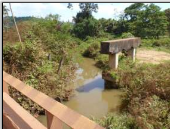
Foto 1326 – Ponto 15 – Jusante – Estrutura de ponte de concreto na lateral da ponte de madeira 4.810354° S 49.566275° W (14/10/2013).
