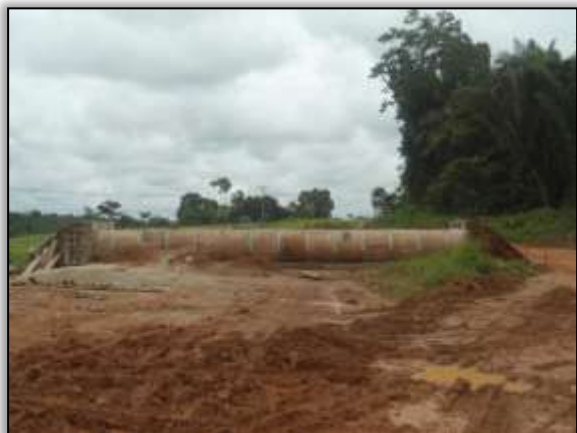
Foto 999 – Bueiro concluído. S 03.89171° W 054.33133° 29/01/2014
