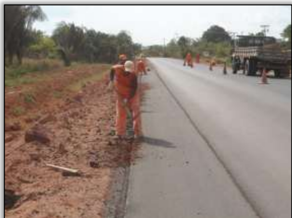
Foto 728 – Preparo para construção de meio fio. Lado esquerdo. S 03.11026° W 051.63110° 09/10/2013
