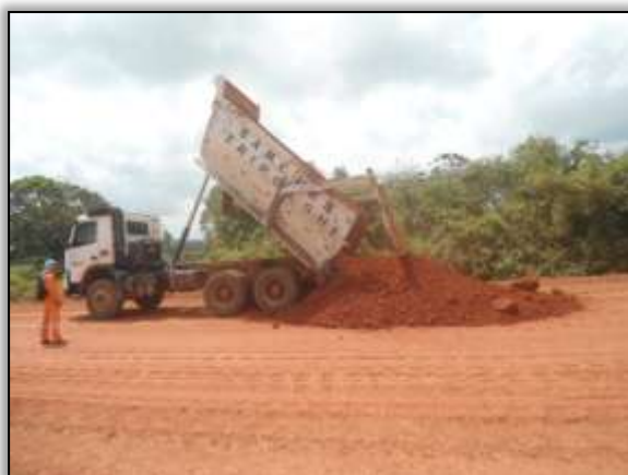
Foto 859 – Serviços de terraplenagem. Estaca 2815. S 03.38699° W 052.69066°. 10/10/2013.
