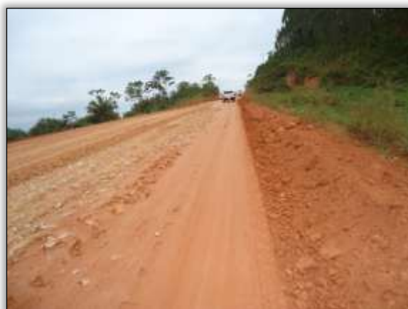
Foto 1042 – Processo erosivo recuperado. Lado direito. S 05.14288° W 049. 39047°. 13/11/2013
