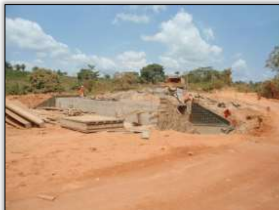
Foto 633 – Construção de bueiro celular duplo. Lado direito. S 03.64310° W 050.98654° 02/10/2013
