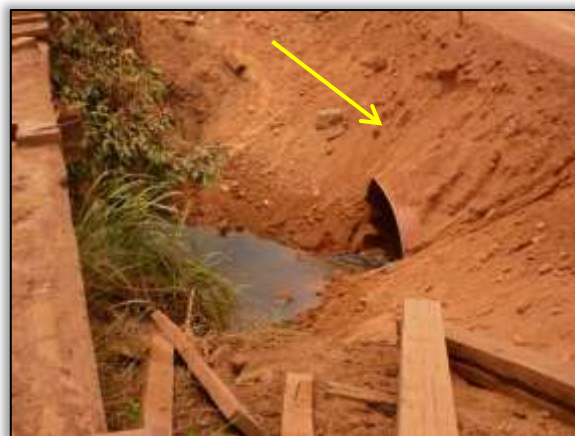
Foto 1354 – Ponto 24 – Construção do bueiro. 4.132819° S 50.239324° W (12/10/2013).
