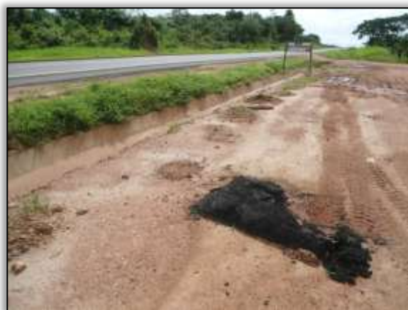
Foto 685– Resíduos de obra. Estaca 3214. Lado Esquerdo. S 03.14527° W 051.58142° 24/01/2014
