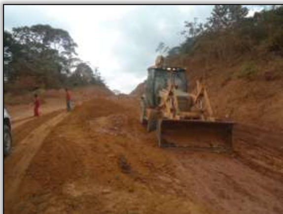
Foto 954 - Reconformação de buracos. S 03.76812° W 053.86707° 18/12/2013
