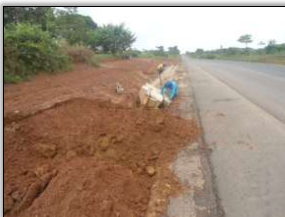
Foto 1189 – Construção de valeta. Lado esquerdo. Estaca 2241. S 03.34256° W 052.59921° 27/12/2013.
