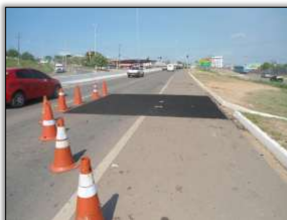
Foto 464 – Instalação de redutores de velocidade. S 05.35052° W 049.10483° 02/10/2013
