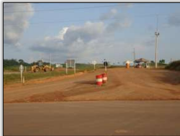
Foto 426 – Acesso ao sítio Pimental. Lado esquerdo. S 03.15093° W 051.97894° 28/08/2013
