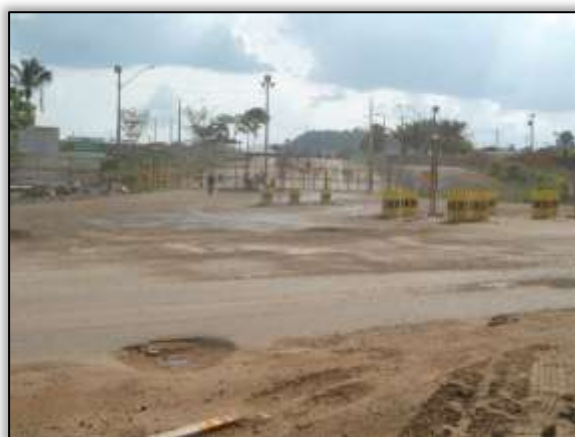
Foto 450 – Acesso ao canteiro de obras do CCBM. Lado esquerdo. S 03.12284° W 051.79378° 26/11/2013
