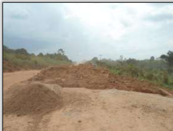
Foto 951 – Corte para implantação de bueiro. S 03.87565.W 054.24110° 11/11/2013.
