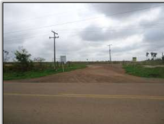
Foto 404 – Entrada para áreas de apoio do canteiro de obras. S 05.14985°W 049.38852° 17/09/2013
