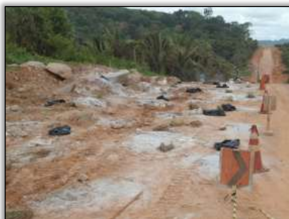
Foto 606 – Preparação para desmanche de rocha. Lado esquerdo. Estaca 5008. S 03.54804° W 051.11628° 21/08/2013
