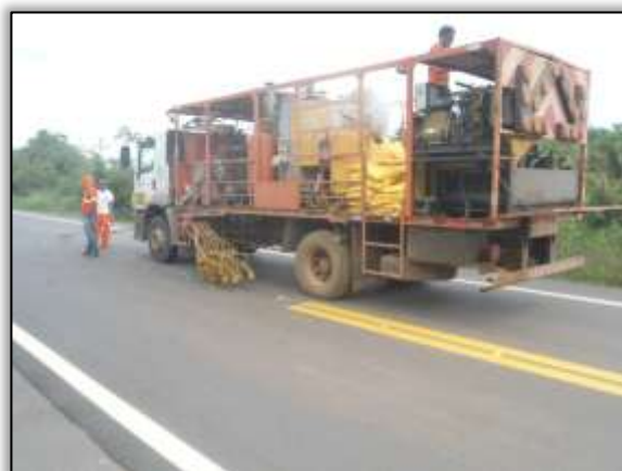
Foto 723 – implantação de sinalização horizontal. Estaca 3100. Lado direito. S 03.16066° W 051.56785° 26/11/2013
