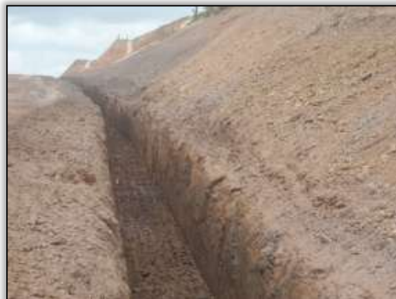
Foto 858 - Construção de drenagem profunda. Lado direito. Estaca 2653. S 03.37715° W 052.66383°. 10/010/2013
