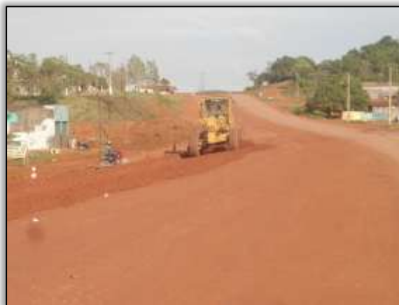
Foto 519 – Atividade de terraplenagem. S 04.24449° W 049.94828° 30/10/2013
