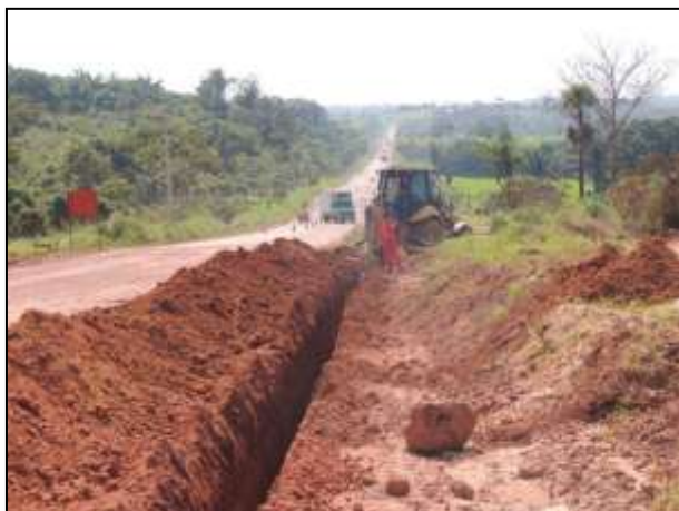
Figura 60. Equipe acompanhando escavação para localização de drenos. Data: 02/12/2013 _ 22M 0630530 E / 9548910 N
