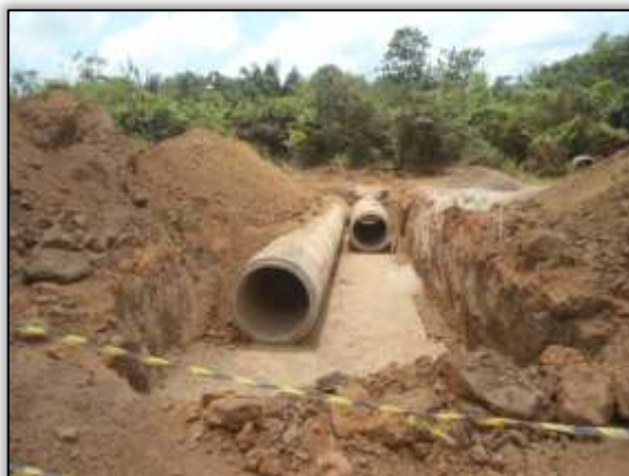
Foto 924 – Construção de bueiro. S 03.86237° W 054. 19567° 17/10/2013.
