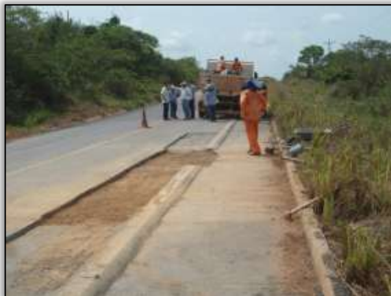
Foto 725 – Recuperação da pista. Lado direito. Estaca: 722. S 03.43128° W 051.24100° 09/10/2013
