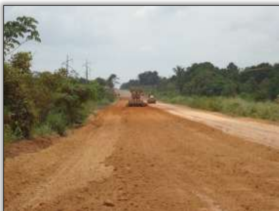
Foto 472 Atividade de terraplenagem. Lado esquerdo. S 05.26043° W 049.33250° 29/10/2013
