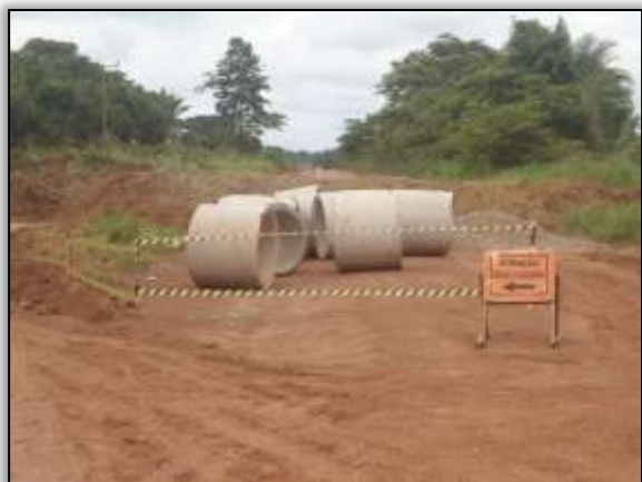
Foto 1003 – Bueiro em construção. Estaca 9246. S 03.88422° W 054.36125° 30/01/2014
