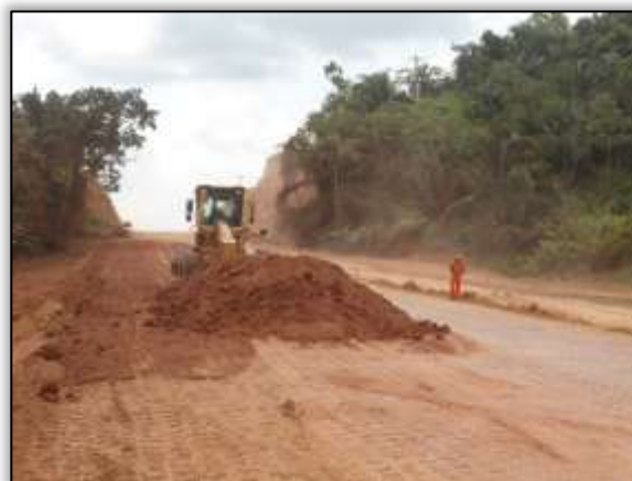
Foto 643 – Atividades de terraplenagem. Lado esquerdo. Estaca 4691. S 03.58081° W 051.07347° 16/09/2013
