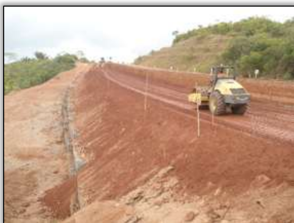
Foto 717 – Reconformação da rodovia e da saia de aterro (Gabião). Lado esquerdo. S 03.16962° W 052.01243° 12/11/2013
