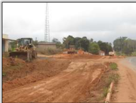
Foto 898 – Construção do trevo na entrada da vicinal 11. Lado esquerdo. S 03.29595° W 052.48883° 13/11/2013.
