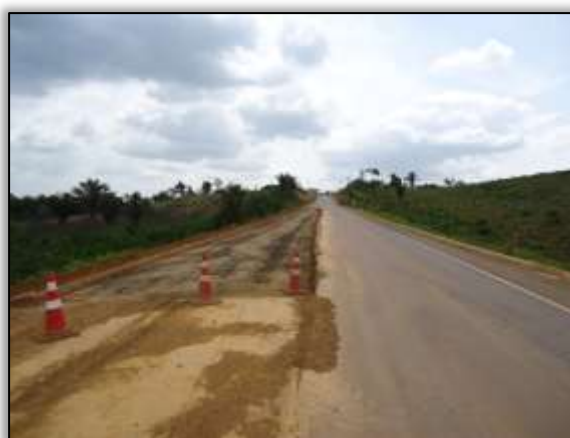
Foto 539 – Recuperação da plataforma. Lado esquerdo. S 03.97974° W 050.31995° 24/09/2013
