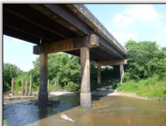
Foto 1300 – Ponto 07 – Ponte de alvenaria. 5.376823° S 49.015351° W (15/10/2013).
