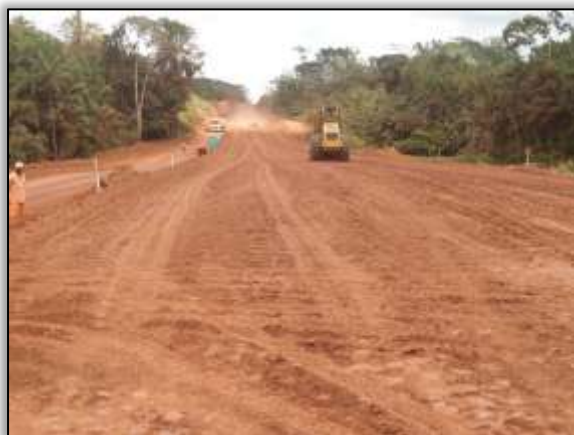
Foto 810 – Rolo compactador de solo. Estaca 3321. S 03. 41170° W 052. 77778° 14/08/2013
