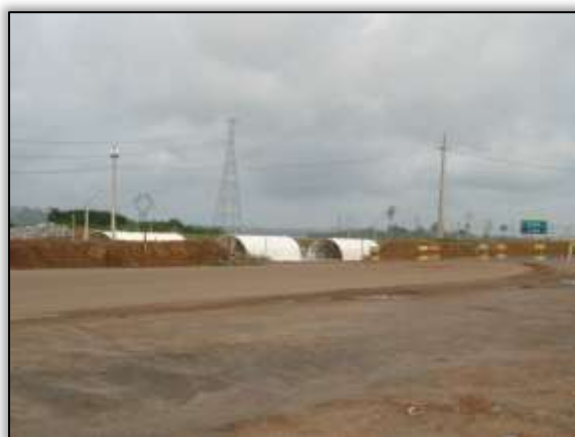
Foto 456– Saída do desvio da rodovia. Lado direito. Estaca 4370. S 03.12614° W 051.76251° 26/12/2013.
