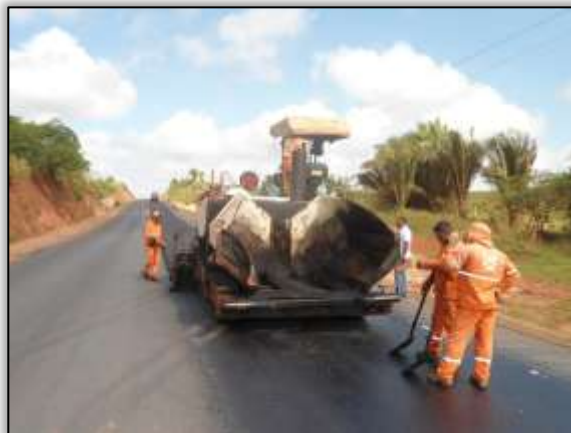
Foto 525 – Pavimentação da rodovia. Lado direito. S 04.15949° W 050.12640° 21/08/2013
