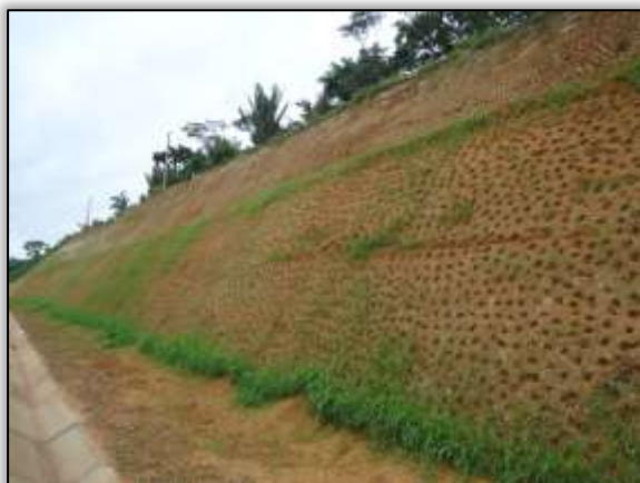
Foto 1088 – Talude após revestimento vegetal. Lado direito. S 03.92425° W 050.34090° 15/01/2014
