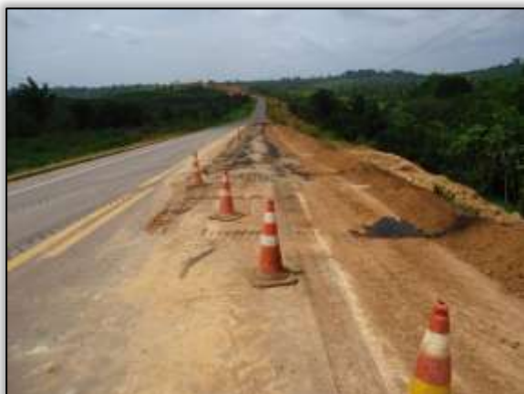
Foto 536 – Recuperação da plataforma. Lado direito. S 03.97974° W 050.31995° 24/09/2013
