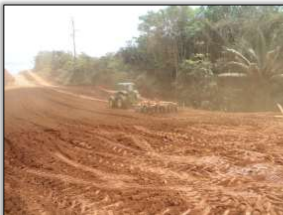
Foto 824– Máquina gradeando a pista. Estaca 3455. S 03. 42138° W 052. 79944° 20/08/2013.
