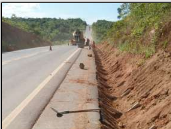
Foto 710– Construção de sarjeta. Estaca 4160. Lado Direito. S 03.13045° W 051.72620° 07/01/2014
