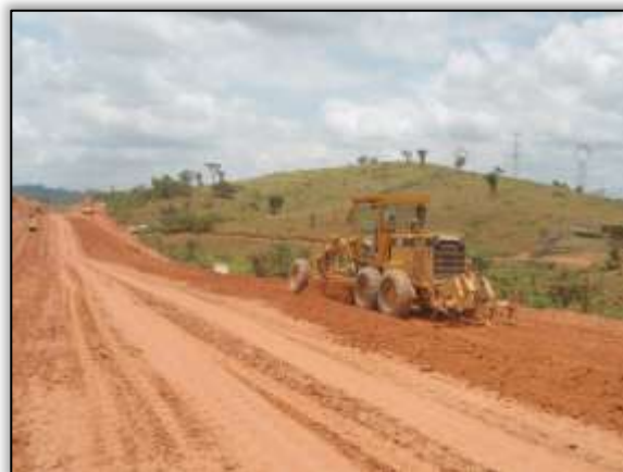
Foto 660 – Atividades de terraplenagem (revolvimento de aterro). Lado direito. Estaca 1100. S 03.84679° W 050.52027° 10/10/2013
