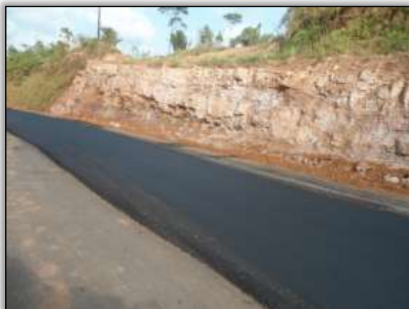
Foto 877 - Segunda camada de asfalto. Estaca 1885. S 03. 30814° W 052. 54790° 23/03/2013.
