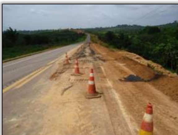
Foto 540 – Recuperação da rodovia. Lado direito. S 03.97974° W 050.31995° 24/09/2013
