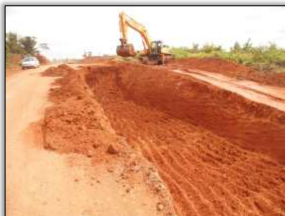
Foto 596 – Conformação do off set da rodovia. Lado direito. Estaca 4815. S 03.56403° W 051.08730° 07/08/2013
