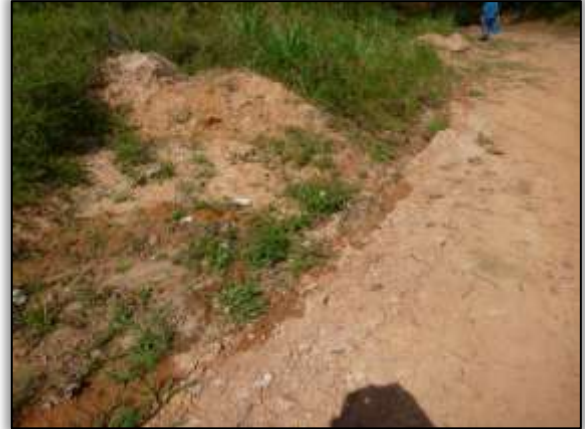
Foto 1425 – Ponto 43 – Erosões as margens. 3.133642° S 51.941217° W (10/10/2013).
