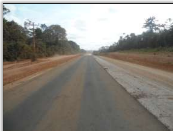
Foto 868 - Pavimentação da pista. Estaca 2108. S 03.33117° W 052.58248°. 17/10/2013.
