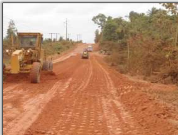
Foto 517 – Atividade de terraplenagem. S 04.25047° W 049.04613° 24/10/2013
