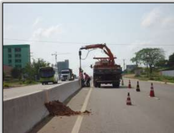
Foto 466 – Instalação de iluminação na rodovia. S 05.35074° W 049.10011° 29/10/2013
