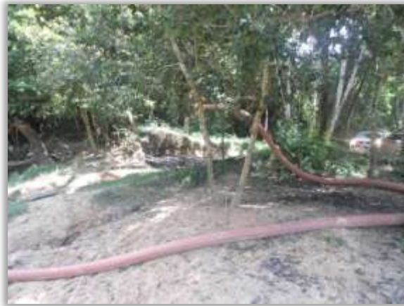
Foto 976 - Retirada de areia. Lado esquerdo. S 03.90013° W 054.27929° 02/12/2013.
