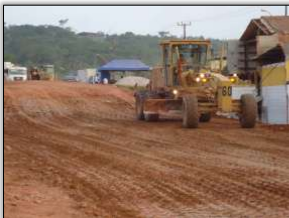
Foto 514 – Atividade de terraplenagem. S 04.25050° W 049.04603° 24/10/2013
