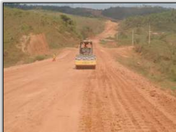
Foto 668 – Compactação do solo. Lado direito. Estaca 1176. S 03.84361° W 050.53456° 22/10/2013
