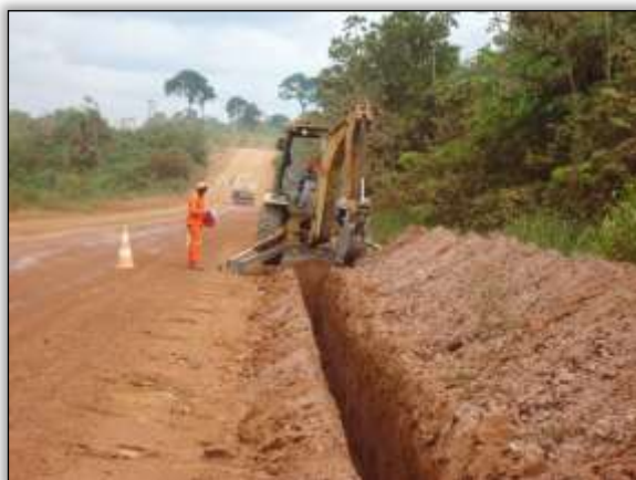
Foto 467 – Abertura para sistema de drenagem. Lado direito. S 05.23284° W 049.33612°. 29/10/2013
