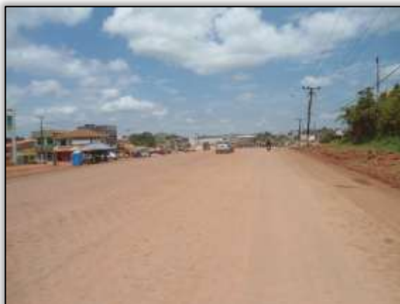
Foto 552 – Rodovia com aplicação da primeira camada asfáltica. Eixo da rodovia. S 04.25213° W 049.94488° 20/11/2013
