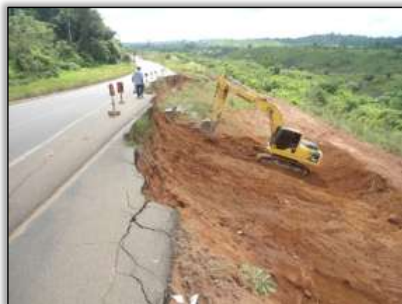
Foto 696 – Reconformação da saia de aterro. Lado esquerdo. Estaca 6071. S 03.16971° W 052.01240° 16/08/2013.
