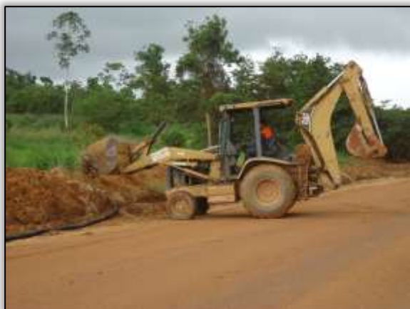
Foto 1037 – Material para aterro de dreno longitudinal. Lado esquerdo. S 05.08560° W 049.42741° 21/01/2014
