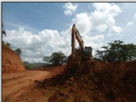
Foto 828– Corte em talude. Lado direito. Estaca 3549. S 03. 43055° W 052. 81358° 20/08/2013.
