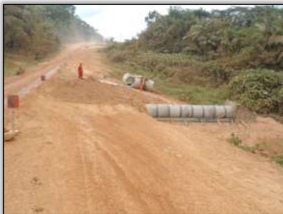
Foto 630 – Construção de bueiro simples. Lado direito. Estaca 3854. S 03.6665° W 050.95118° 02/10/2013
