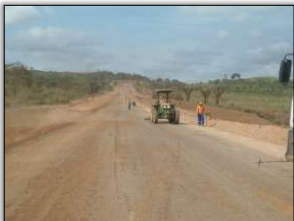
Foto 869 - Limpeza para aplicação de asfalto. Estaca 2108 á 2132. S 03.33117° W 052.58248°17/10/2013.
