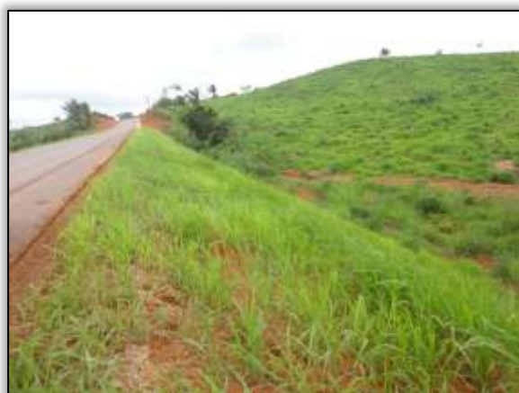
Foto 1072 – Revestimento vegetal em saia de aterro. Lado direito. S 04.00136° W 050.27429° 28/08/2013
