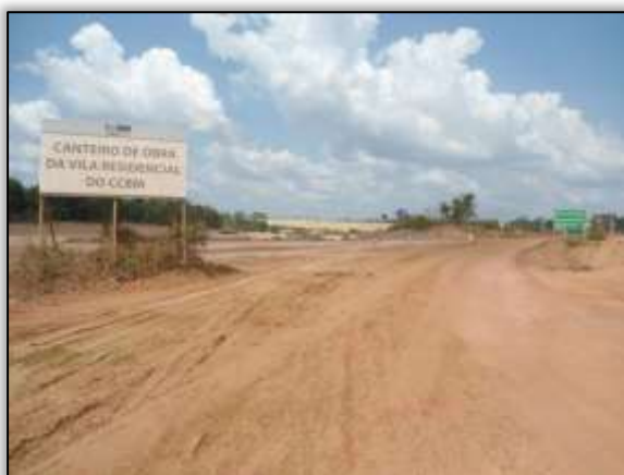
Foto 438 - Acesso a vila residencial CCBM. Lado direito. Estaca 4230. S 03.1251° W 051.74237° 23/10/2013
