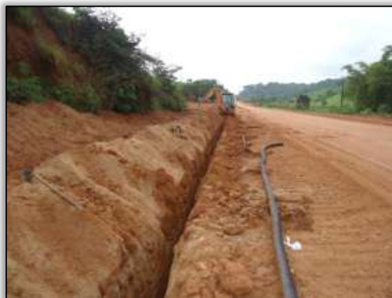
Foto 1038 – Instalação de dreno longitudinal. Lado esquerdo. S 05.08560° W 049.42741° 21/01/2014
