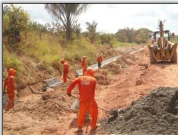
Foto 695 – Construção de valeta. Lado esquerdo. Estaca 3220. S 03.14480° W 051.58258° 07/08/2013
