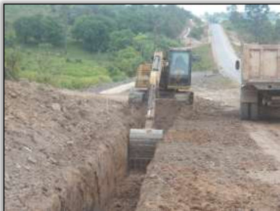
Foto 857 – Construção de drenagem profunda. Lado direito. Estaca 2653. S 03.37715° W 052.66383°. 10/010/2013.
