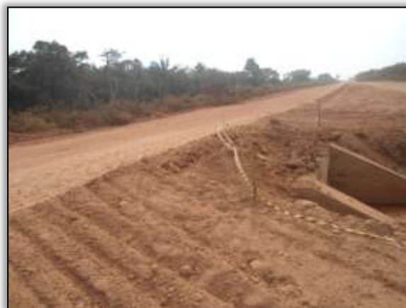
Foto 965 – Bueiro concluído. Depois. S 03.86231° W 054.19566° 18/12/2013.
