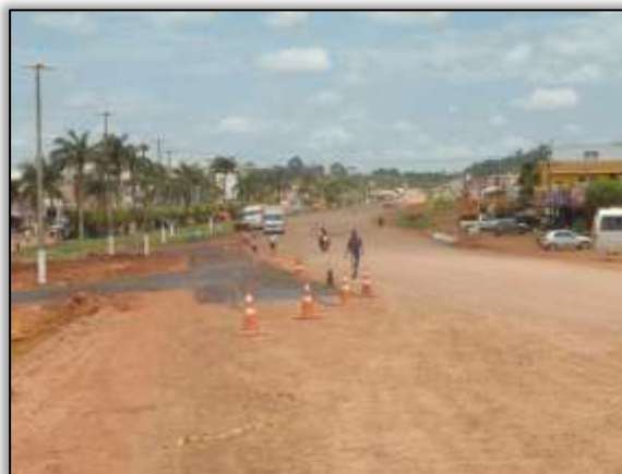
Foto 551 – Aplicação de emulsão asfáltica. Lado esquerdo. S 04.25100° W 049.94584° 13/11/2013
