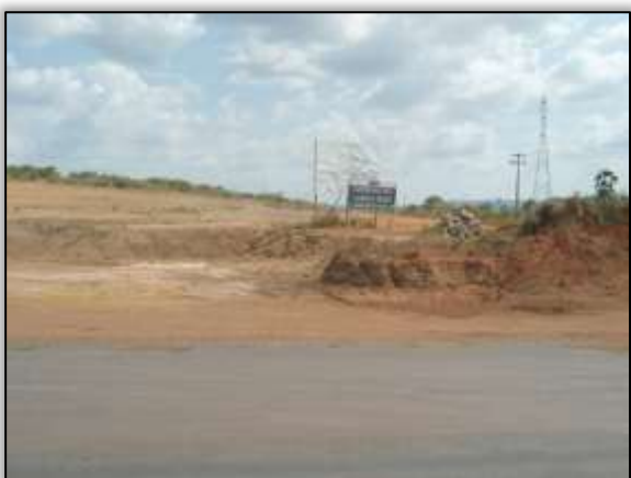
Foto 437 – Acesso ao Canteiro Belo Vista - canais e diques. Lado Esquerdo. Estaca 4258. S 03.12479° W 051.73776° 23/10/2013
