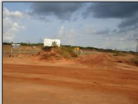
Foto 420 – Acesso ao Canteiro Bela Vista - canais e diques. Lado Esquerdo. Estaca 4258. S 03.12479° W 051.73776° 28/08/2013
