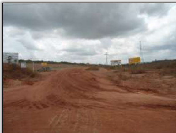
Foto 431 – Acesso ao Canteiro Belo Vista - canais e diques. Lado Esquerdo. Estaca 4258. S 03.12479° W 051.73776° 03/10/2013
