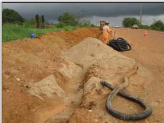
Foto 1033 – Material para aterro de dreno longitudinal. Lado esquerdo. S 05.20498° W 049.35582° 21/01/2014
