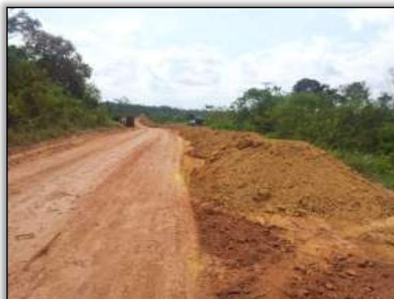
Foto 986 - Terraplanagem. Estaca 8773. S 03. 88901° W 054. 28034° 23/10/2013.
