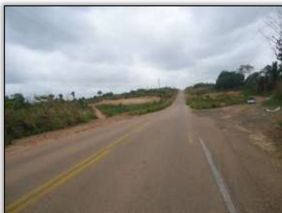
Foto 413 – Entrada para áreas de apoio do canteiro de obras. S 05.14985°W 049.38852° 17/09/2013
