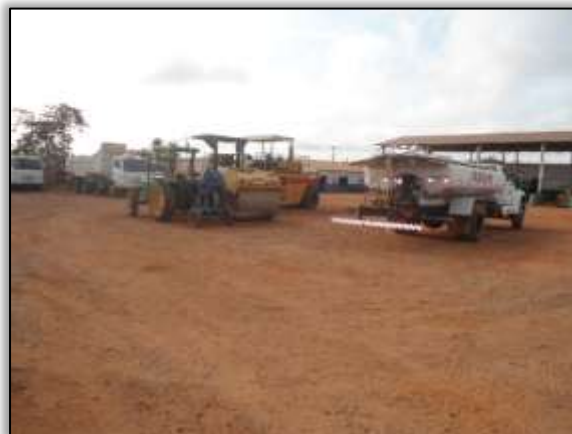
Foto 749 - Canteiro de obra da Sanches Tripoloni. Lado esquerdo. Estaca 1827. S 03.30872° W 052. 53631 14/08/2013
