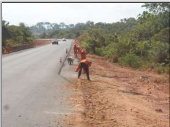
Foto 736- Preparo para construção de meio fio. Lado direito. Estaca 3614. S 03.10540° W 051.64023° 22/10/2013
