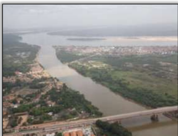
Foto 1303 – Ponto 08 – Vista aérea - Jusante. 5.357422° S 49.121869° W (01/08/2013).
