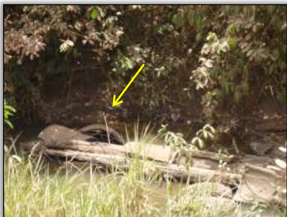
Foto 1334 – Ponto 18 – Montante – Manilha de concreto 4.592502° S 49.784170° W (13/10/2013).
