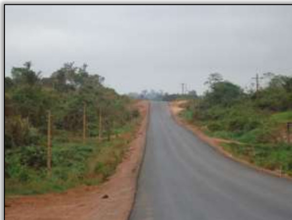
Foto 1097 – Processo erosivo reconformado (depois). Lado esquerdo. S 04.21316º W 049.98400º 18/09/2013
