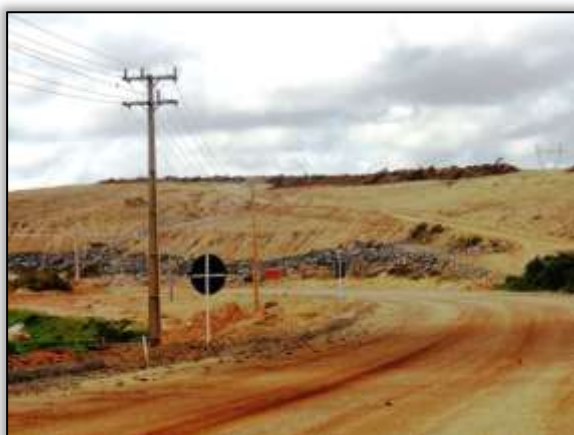
Foto 182 – Registro do desvio no trecho da BR-230/PA, que atravessa o canteiro do Sítio Belo Monte. Data: 16/08/2013.
