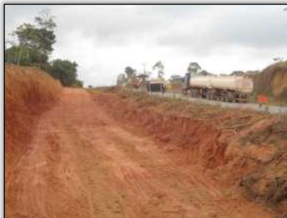
Foto 882 – Corte em talude. Lado esquerdo. S 03.29027° W 052.48940° 13/11/2013.
