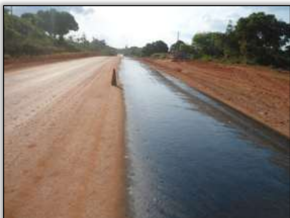
Foto 678 – Imprimação. Lado direito. Estaca 4094. S 03.13427° W 051.71517° 02/10/2013
