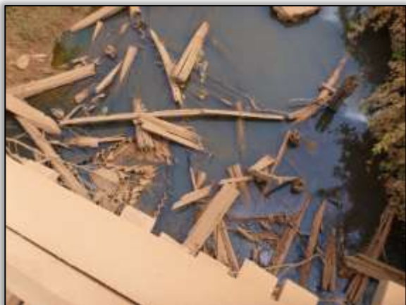
Foto 1387 – Ponto 33 – Galhos sob a ponte. 3.727251° S 50.876172° W (11/10/2013).
