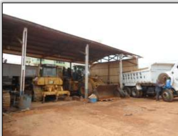
Foto 765 - Canteiro de obra. Lado esquerdo. Estaca 1827. S 03.30872° W 052.53631° 13/11/2013.
