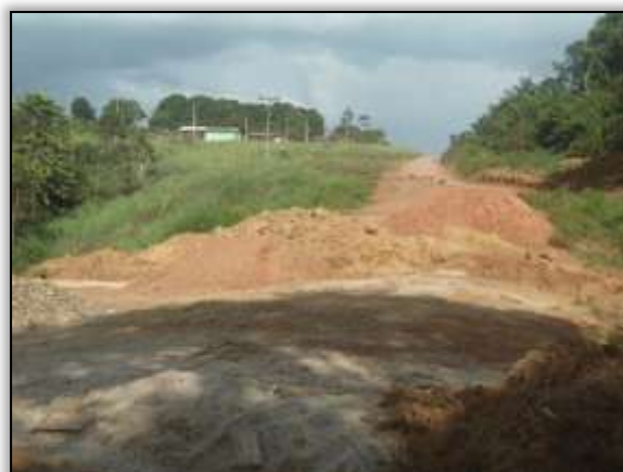
Foto 1020 – Construção de bueiro. Estaca 8950. S 03.89117° W 054.31134° 27/12/2013.
