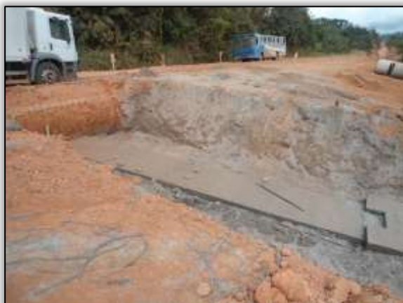
Foto 603 – Implantação de bueiro simples. Lado direito. Estaca 4121. S 03.64225° W 050.98910° 21/08/2013
