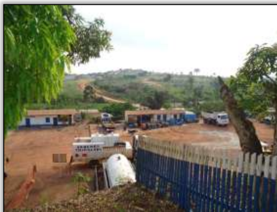
Foto 555 – Canteiro de Obras. S 04.23928° W 049.95531° 27/11/2013
