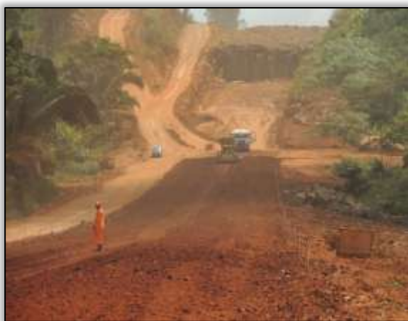
Foto 32- Andamento da pavimentação do lote 05 (sentido Brasil Novo/Altamira).
