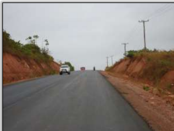
Foto 1103 – Processo erosivo reconformado (depois). Ambos os lados. S 04.20362º W 049.99275º 18/09/2013
