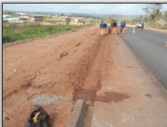
Foto 820 - Corte para construção de meio fio. Estaca 1878. Lado esquerdo. S 03. 30799° W 052. 54592° 14/08/2013
