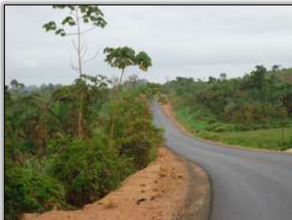
Foto 1105 – Processo erosivo reconformado (depois). Lado esquerdo. S 04.19880º W 050.00027º 18/09/2013
