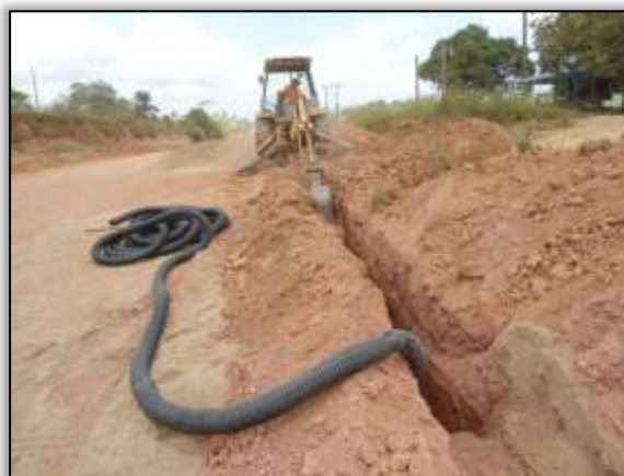
Foto 1048 – Abertura de vala para instalação de dreno longitudinal. Lado esquerdo. S 05.11456° W 049.40417° 04/12/2013
