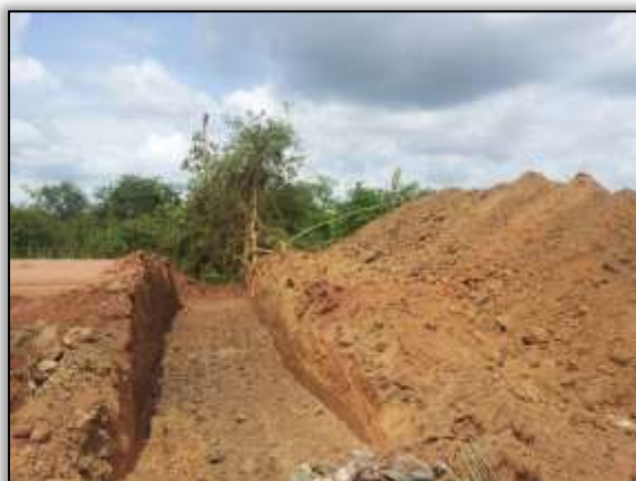
Foto 981 - Construção de bueiro. S 03.89094° W 054. 27748° 23/10/2013.
