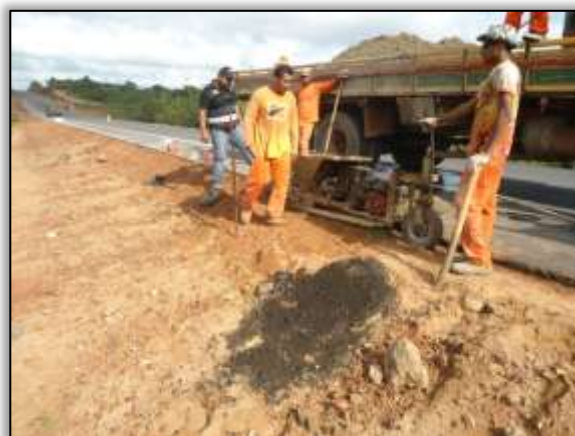
Foto 1143 – Construção de meio fio. Estaca 4134. Lado esquerdo. S 03.13250° W 051.72222° 26/11/2013
