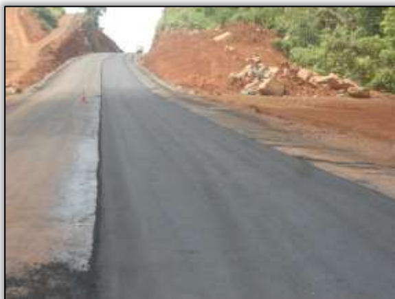
Foto 905 – Aplicação de camada asfáltica. Estaca 3702. S 03.44061° W 052.83834° 18/12/2013.
