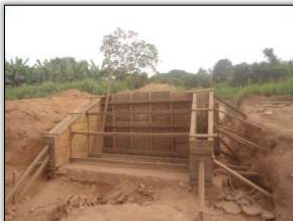
Foto 968 – Construção de bueiro. S 03.87603° W 054.24352° 18/12/2013.
