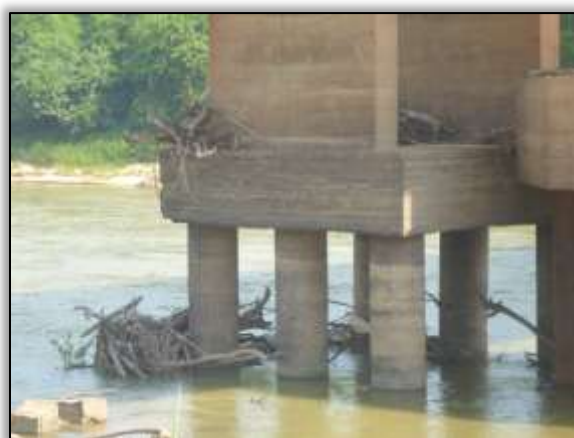
Foto 1304 – Ponto 08 – Ponte de alvenaria – Galhos. 5.357422° S 49.121869° W (14/10/2013).
