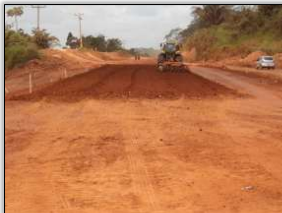
Foto 846 – Gradição do solo. Estaca 3682. S 03.43962° W 052.83486° 17/09/2013.
