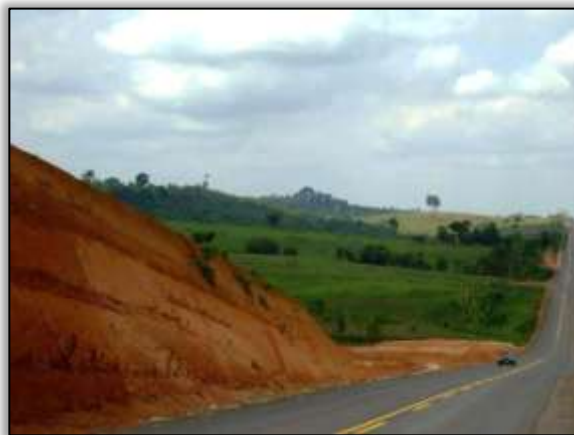
Foto 354 – Trecho entre os municípios de Novo Repartimento e Pacajá/PA – 18/12/13
