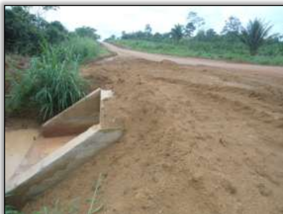
Foto 996 – Bueiro concluído. S 03.88804° W 054.29916° 29/01/2014
