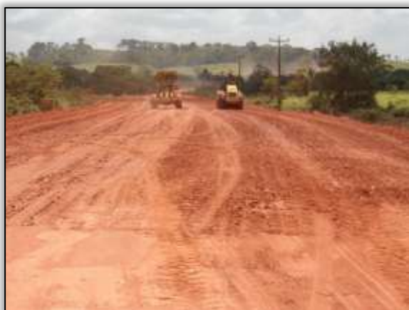
Foto 843 – Terraplanagem. Estaca 2803. S 03.38657° W 052.68878° 17/09/2013.
