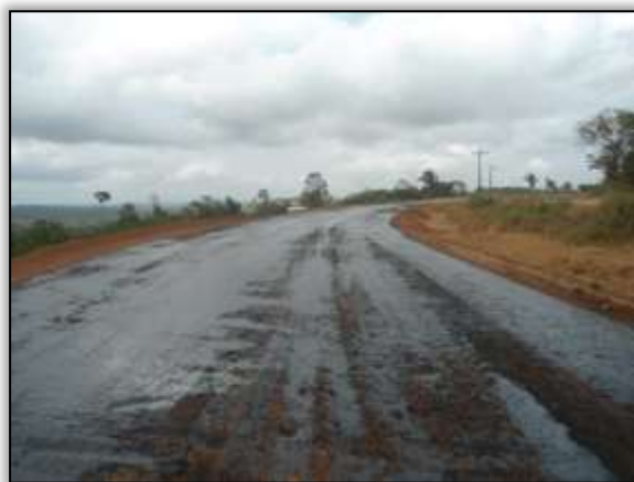
Foto 856 – Imprimação na pista. Estaca 2458. S 03.36099° W 052.63317°. 10/10/2013.
