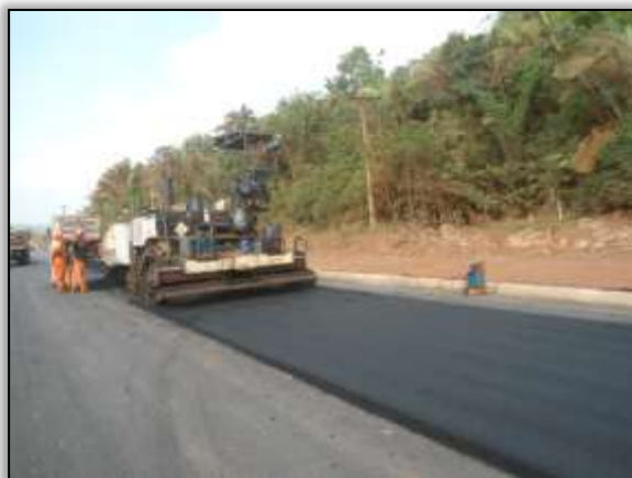
Foto 879 - Segunda camada de asfalto. S 03. 31051° W 052. 54897° 23/10/2013.
