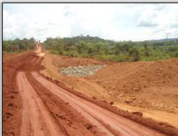
Foto 834 - Implantação de sistema de drenagem. S 03.43939° W 52.83403°. 20/08/2013. Depois
