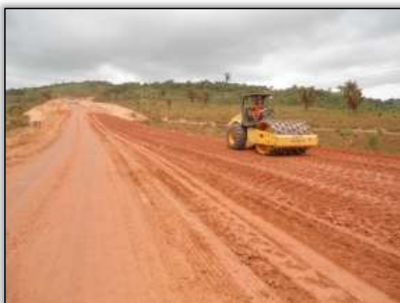
Foto 646 – Atividades de terraplenagem. Lado direito. Estaca 1404. S 03.84382° W 050.53889° 02/10/2013
