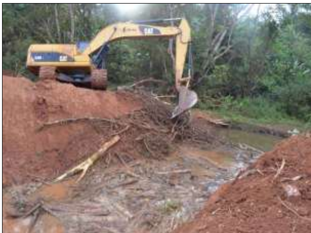
Figura 42. Limpeza do corpo hídrico, retirada de restos de madeira. Data: 17/10/2013
