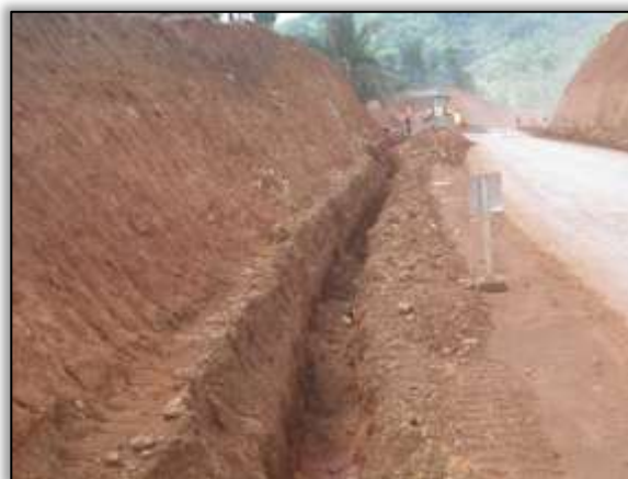
Foto 1127 – Dreno profundo. Estaca 4730. Lado esquerdo. S 03.57708° W 051.07933° 12/11/2013
