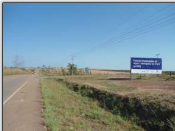
Foto 401 – Entrada para áreas de apoio do canteiro de obras. S 05.14985°W 049.38852° 29/08/2013
