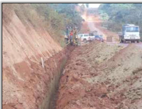
Foto 818 - Sistema de drenagem profunda. Estaca 3669. Lado esquerdo. S 03. 43908° W 052. 83287° 14/08/2013
