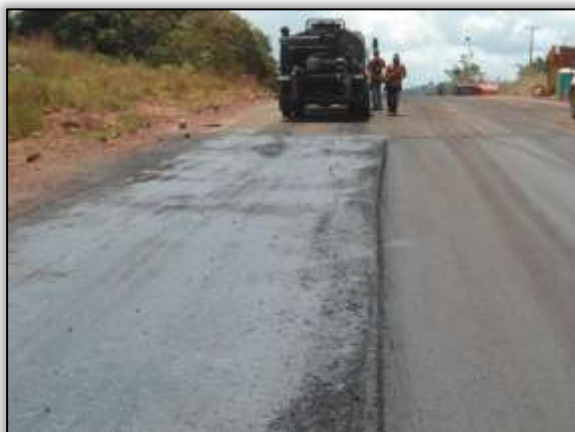
Foto 676 – Imprimação. Lado esquerdo. Estaca 3060. S 03.16607° W 051.56462° 21/08/2013
