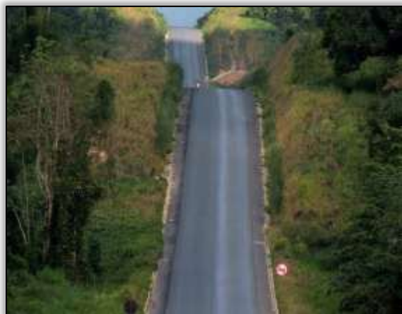
Foto 26 Andamento da obra de pavimentação do lote 04 (sentido Anapu/Altamira)
