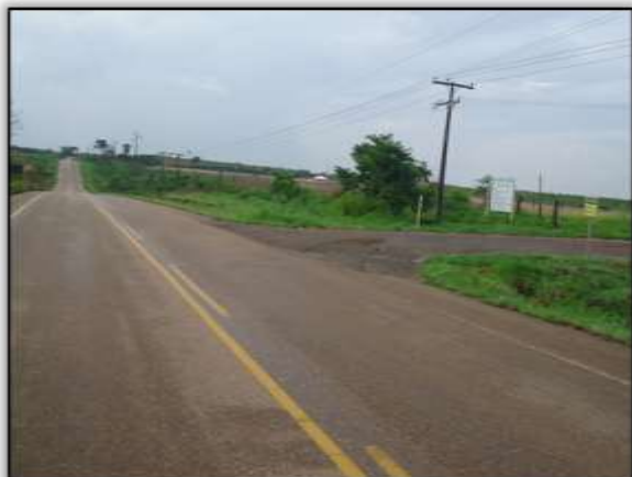
Foto 409 – Entrada para áreas de apoio do canteiro de obras. S 05.14985°W 049.38852° 26/12/2013
