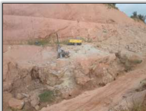
Foto 608 – Perfuração para detonação na ladeira da velha. Lado esquerdo. Estaca 1070. S 03.84711° W 050.51480° 21/08/2013
