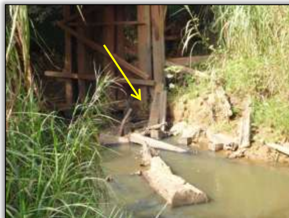
Foto 1476 – Ponto 55 – Toras de madeira. S 3.621538° W 53.362591° (09/10/2013).
