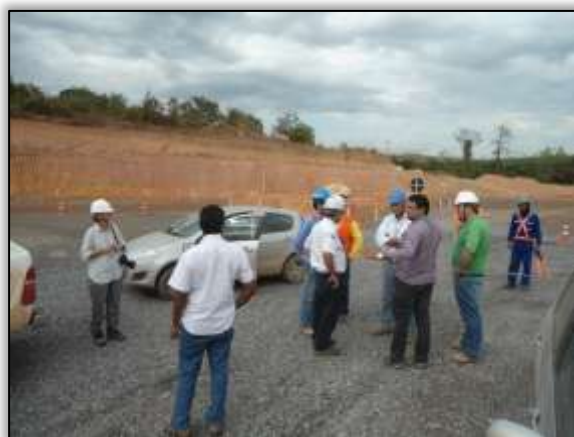
Foto 427 – Representantes do DNIT/UL Altamira, Norte Energia e CCBM vistoriando o início do desvio. S 03.12409° W 051.78971° 17/08/2013
