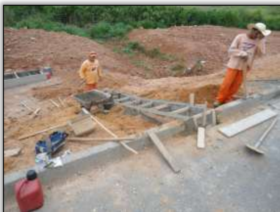
Foto 1142 – Descida d'água. Lado direito. Estaca 3538. S 03.11170° W 051.62818° 20/11/2013
