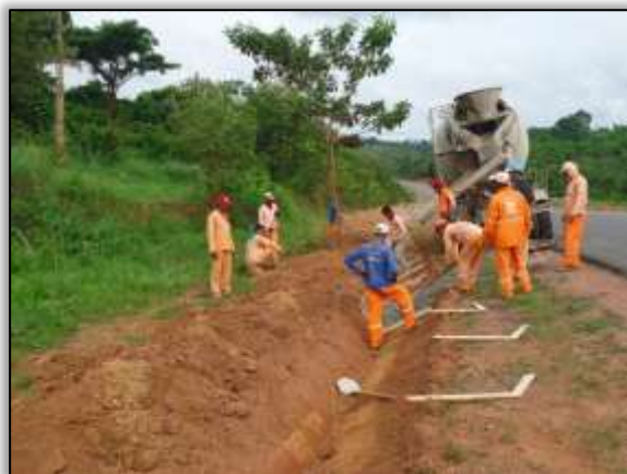
Foto 1125 – Instalação de descida d’água. Lado esquerdo. S 04.20771° W 049.98799° 27/11/2013
