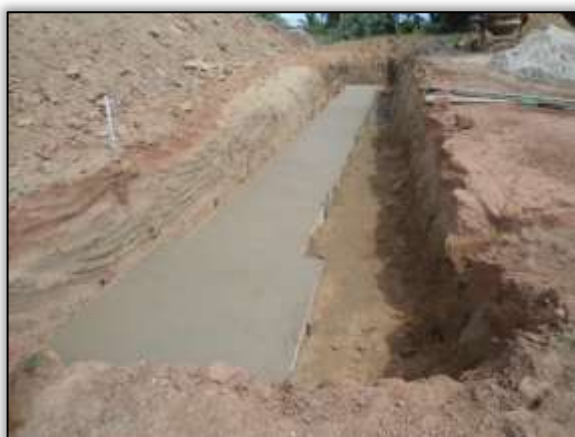
Foto 925 – Construção de bueiro. S 03. 87207° W 054. 22810° 23/10/2013.
