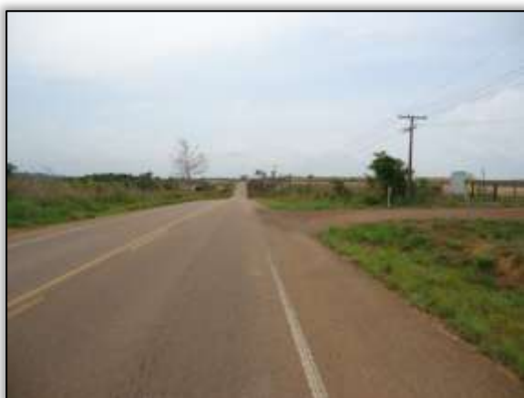
Foto 405 – Entrada para áreas de apoio do canteiro de obras. S 05.14985°W 049.38852° 23/10/2013
