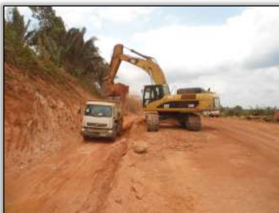
Foto 658 – Corte e conformação da rodovia. Lado esquerdo. Estaca 4245. S 03.62679° W 051.00840° 23/10/2013
