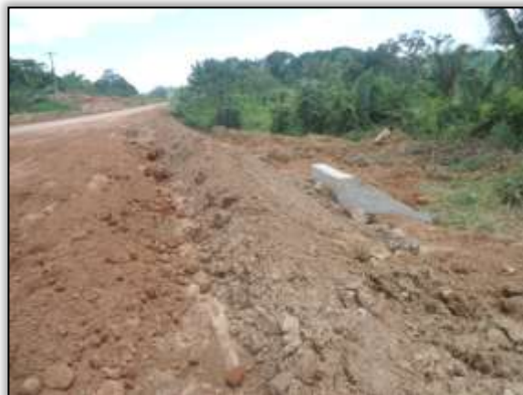
Foto 936 - Bueiro concluído. Estaca 7906. S 03.85446° W 054.13381° 21/01/2014
