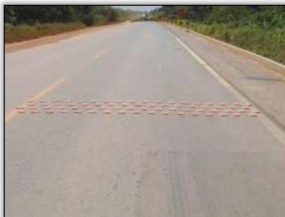
Foto 721 – Instalação de sonorizadores antes de ponte. Lado direito. Estaca 962. S 03.40539° W 051.27521° 24/09/2013
