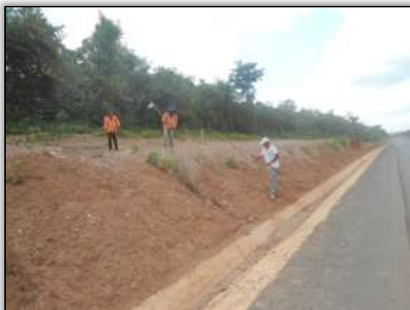
Foto 1170 – Semeadura manual. Lado esquerdo. Estaca 2050. S 03.32312° W 052.57280° 17/12/2013.
