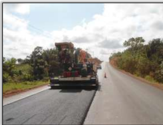
Foto 527 – Pavimentação da rodovia. Lado direito. S 04.15949° W 050.12640° 21/08/2013
