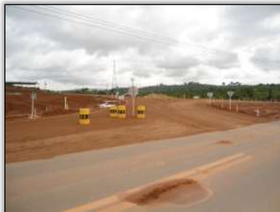
Foto 460- Acesso ao Canteiro Bela Vista - canais e diques. Lado Esquerdo. Estaca 4258. S 03.12479° W 051.73776° 26/12/2013.
