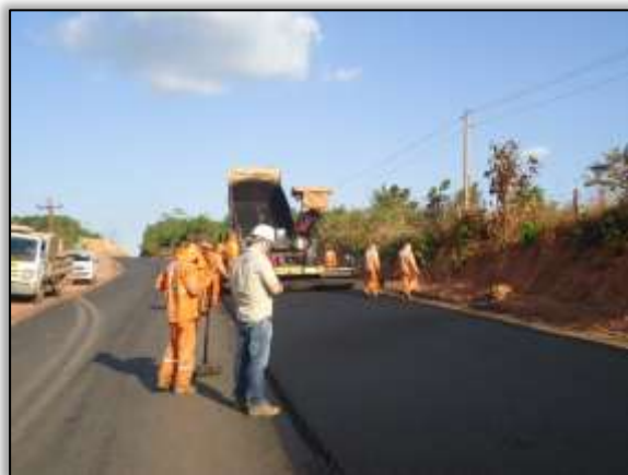
Foto 531 – Segunda camada asfáltica. Lado esquerdo. Outro ponto. S 04.13452° W 049.58199° 01/10/2013
