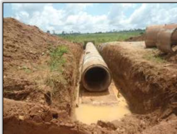
Foto 934 – Construção de bueiro. S 03.85787° W 054.11796° 21/01/2014
