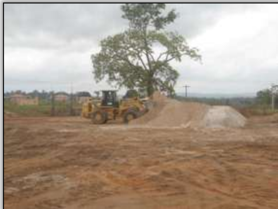
Foto 795 - Deposito de areia. Estaca 1880. Lado direito. S 03. 30814° W 052. 54790° 10/10/2013.
