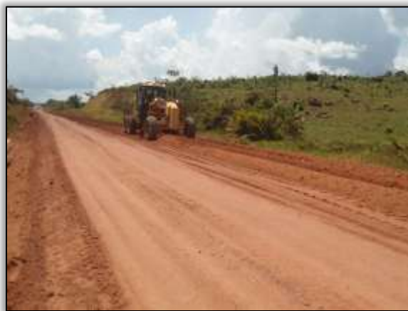
Foto 691 – Obras de terraplenagem na rodovia. Lado direito. Estaca 3134. S 03.15623° W 051.57190° 21/08/2013
