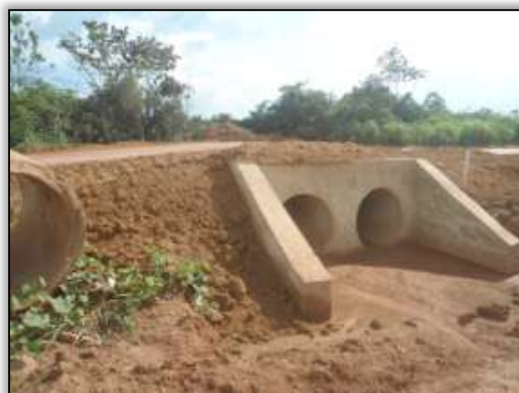
Foto 1018 – Bueiro concluído. S 03.88797° W 054.29877° 27/12/2013.
