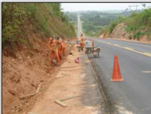
Foto 704– Implantação de sarjeta Triangular de concreto. Estaca 605. Lado Esquerdo. S 03.44531° W 051.22649° 05/12/2012.
