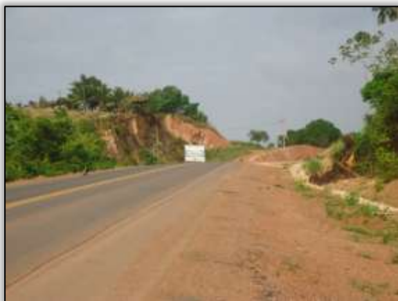
Foto 1120 – Descida d’água em fase instalação. Lado direito. S 04.23525° W 049.96141° 27/11/2013
