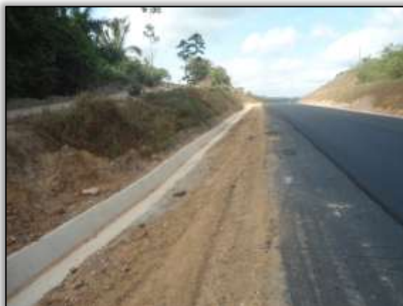
Foto 1165 – Construção de valeta. Lado esquerdo. Estaca 1583. S 03.29863° W 052.49510° 17/12/2013.
