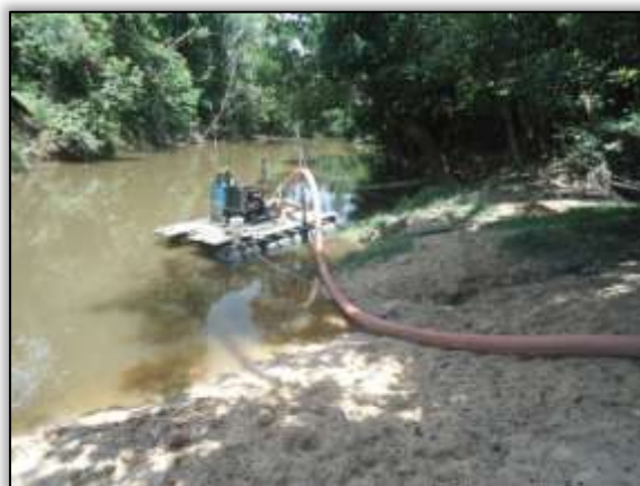
Foto 920 - Retirada de areia. Lado esquerdo. S 03.90013° W 054.27929° 02/12/2013.
