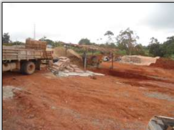
Foto 774 – Construção de artefato de concreto. Lado esquerdo. Estaca 3512. S 03.42750° W 052.80790° 14/11/2013.
