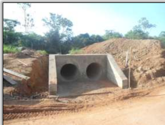
Foto 1012 - Construção de bueiro. S 03.88807° W 054.29888°. 26/11/2013.
