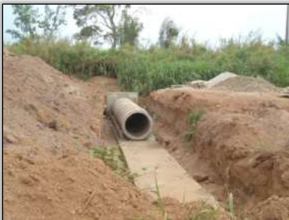
Foto 962 - Construção de bueiro. Antes. S 03.86106° W 054.18923°. 11/11/2013.
