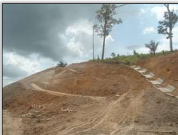
Foto 1151 – Construção de drenagem. Lado direito. Estaca 2665. S 03. 37793° W 052. 66531° 27/09/2013.
