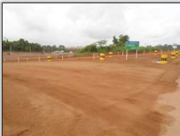
Foto 459- Acesso a vila residencial CCBM. Lado direito. Estaca 4230. S 03.1251° W 051.74237° 26/12/2013.
