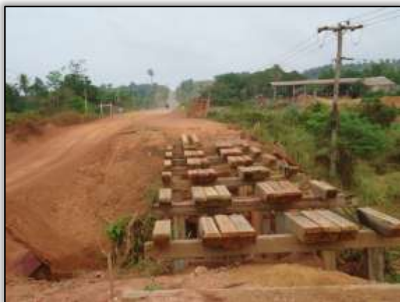
Foto 546 – Atividades de conserva na ponte. S 04.13264° W 050.23944° 24/10/2013
