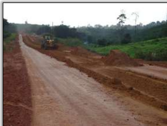
Foto 693 – Obras de terraplenagem na rodovia. Lado direito. Estaca 4084. S 03.13522° W 051.71356° 29/08/2013
