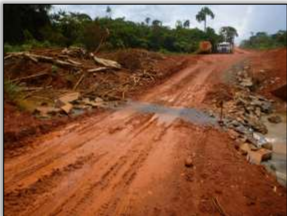
Foto 1459 – Ponto 50 – Caminho de serviço. S 3.411988° W 52.777656° (09/10/2013).
