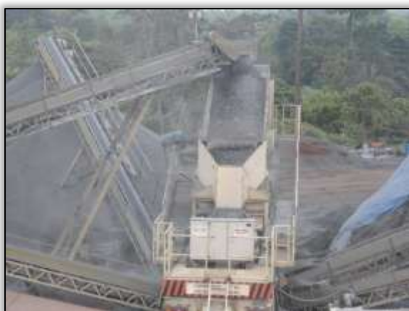
Foto 772 – Britador Sanches Tripoloni. Lado direito. Estaca 3775. S 03.44206° W 052.85213° 14/11/2013.
