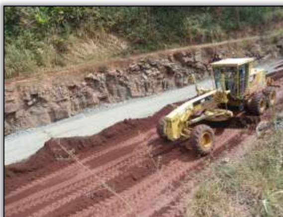
Foto 836 – Terraplanagem. estaca 3775. S 03.44206° W 052. 85213°. 20/08/2013.
