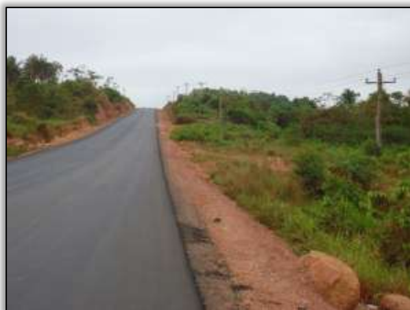
Foto 1101 – Processo erosivo reconformado (depois). Lado direito. S 04.20422º W 049.99193º 18/09/2013
