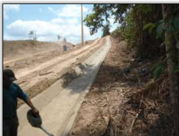
Foto 842 – Construção de valeta de drenagem. Lado direito. Estaca 2656. S 03.37706° W 052.66374° 17/09/2013.
