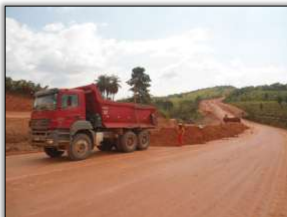
Foto 664 – Material para terraplenagem. Lado esquerdo. Estaca 1198. S 03.84369° W 050.53843° 22/10/2013
