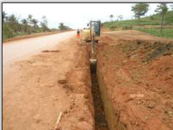
Foto 1128 – Escavação para o dreno profundo. Estaca 4496. Lado direito. S 03.60003° W 051.04389° 20/11/2013
