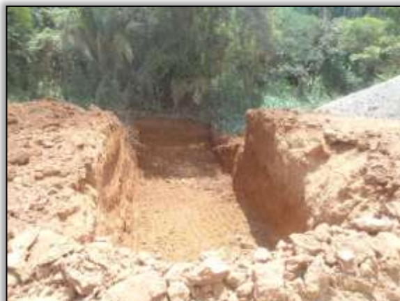
Foto 933 – Escavação para construção de bueiro de bueiro. S 03.86268° W 054.09820° 21/01/2014
