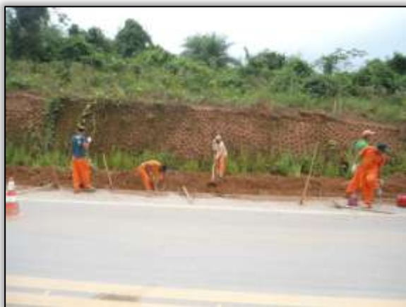
Foto 714 – Construção de sarjeta. Lado Esquerdo. S 03.12588 ° W 051.75270° 24/01/2014
