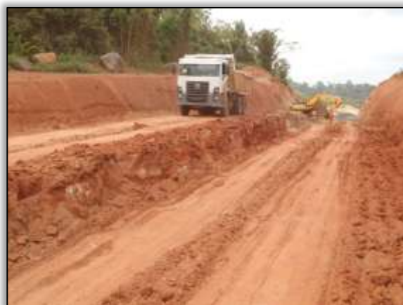
Foto 614 – Corte e conformação da rodovia ( off set ). Estaca 4815. Lado direito. S 03.56404° W 051.08714° 20/11/2013
