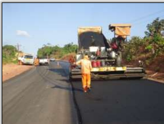
Foto 530 – Segunda camada asfáltica. Lado esquerdo, S 04.13452° W 049.58199° 01/10/2013
