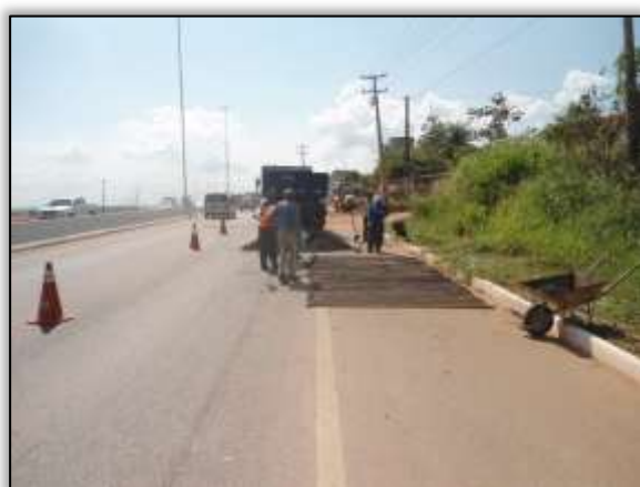
Foto 463 – Instalação de redutores de velocidade. S 05.35050° W 049.10486° 02/10/2013
