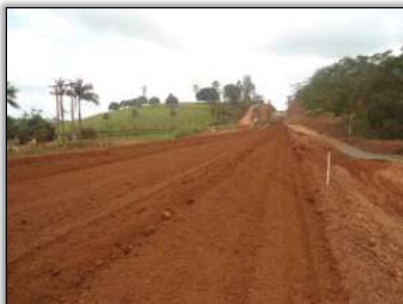
Foto 865 - Serviços de terraplenagem. Estaca 3325. S 03.41220° W 052.77825°. 10/10/2013.
