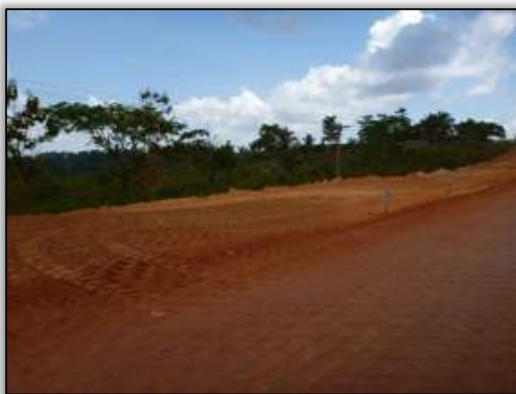
Foto 1395 – Ponto 35 – Terraplenagem. 3.564519° S 51.086520° W (11/10/2013).
