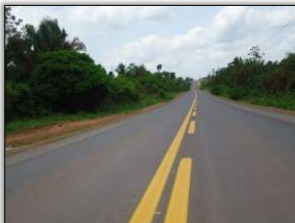
Foto 356 – Trecho entre os municípios de Novo Repartimento e Pacajá/PA – 18/12/13.
