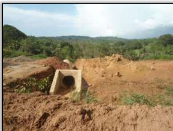
Foto 1019 – Construção de bueiro. Estaca 8950. S 03.89117° W 054.31134° 27/12/2013.
