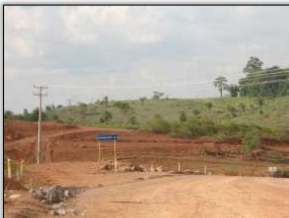
Foto 451 – Acesso ao porto do CCBM. Lado esquerdo. Estaca 4572. S 03.12021° W 051.79644° 26/11/2013
