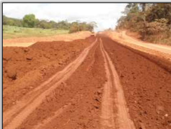
Foto 816 – Terraplenagem. . Estaca 3619. S 03. 43696° W 052. 82394° 14/08/2013
