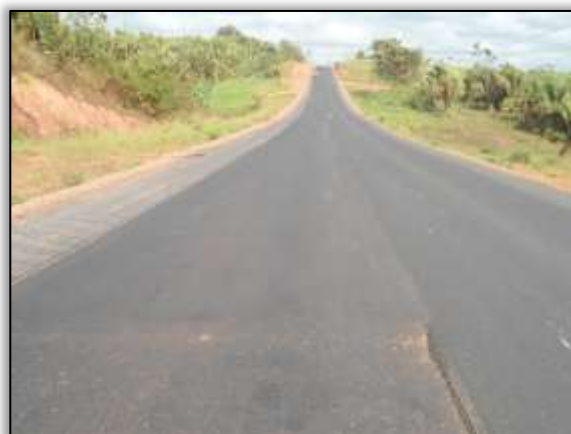
Foto 521 – Primeira camada asfáltica. Eixo da rodovia. S 04.15926° W 050.14647° 21/08/2013
