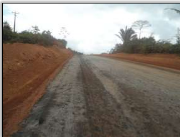
Foto 855 – Imprimação na rodovia. Estaca 2021. S 03.31917° W 052.56637°. 10/10/2013.
