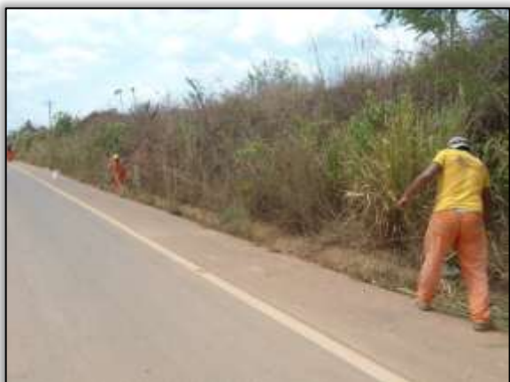
Foto 730. Limpeza da sarjeta. Lado esquerdo e direito. S 03.51722° W 051.15888° 22/10/2013
