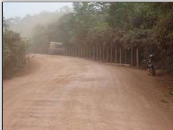
Foto 570 – Instalação de cercas na T.I. Parakanã próximo ao rio Xataopawa. Lado esquerdo. S 04.59291° W 049.78441°. 23/10/2013.
