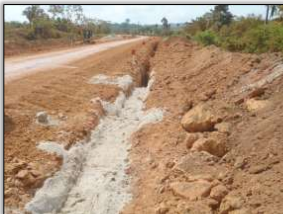
Foto 627 – Construção de dreno profundo. Lado direito e esquerdo. Estaca 5103. S 03.53549° W 051.12777° 02/10/2013
