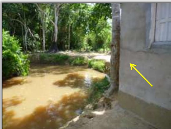
Foto 1307 – Ponto 10 – Montante (Propriedade nas margens do Igarapé). 5.298303° S 49.278890° W (14/10/2013).
