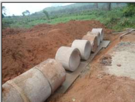
Foto 939 - Implantação de bueiro. S 03.85133° W 054.15569°. 24/01/2014.
