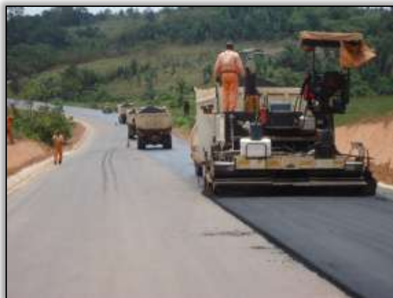
Foto 535 – Aplicação da segunda camada asfáltica. Lado direito. S 04.23867° W 049.95618° 18/08/2013
