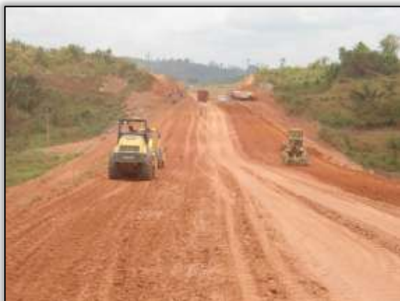
Foto 667 – Compactação do solo. Lado esquerdo. Estaca 1100. S 03.84679° W 050.52027° 10/10/2013
