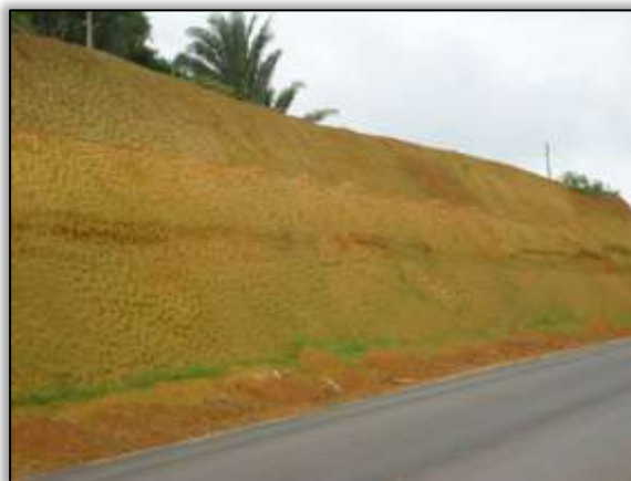
Foto 1085 – Talude após o revestimento vegetal. Lado esquerdo. S 04.93067° W 049.33046° 15/01/2014
