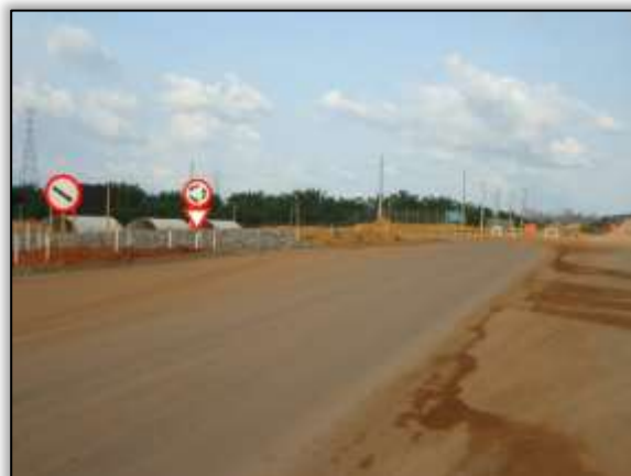
Foto 422 – Final do desvio da rodovia. Lado direito. S 03.12383° W 051.78881 ° 28/08/2013
