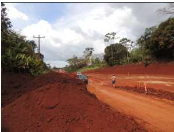
Figura 34. Trecho com obras de terraplenagem na BR-230/PA Data: 17/08/2013
