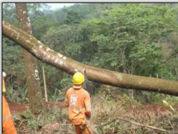
Foto 1235 – Derrubada com motosserra. S 03.43193° W 052. 81411°. 29/08/2013
