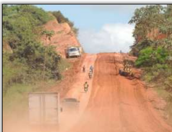
Foto 511 – Atividade de Terraplena. Lado direito S 04.14070° W 049.95374° 31/07/2013
