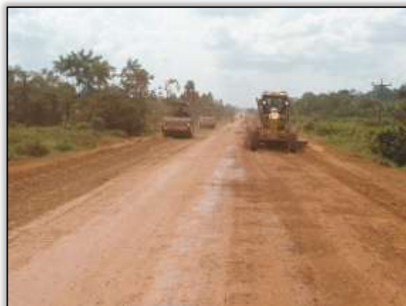
Foto 649 – Atividades de terraplenagem. Estaca 5125. S 03.53325° W 050.13079° 02/10/2013
