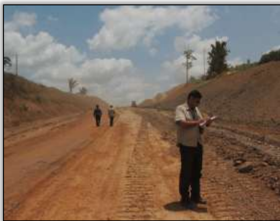
Foto 34- Andamento da pavimentação do lote 05 (sentido Brasil Novo/Altamira).
