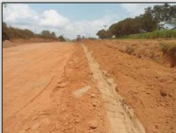
Foto 1045 – Instalação de dreno longitudinal. Lado direito. S 05.21551° W 049.34773° 04/12/2013
