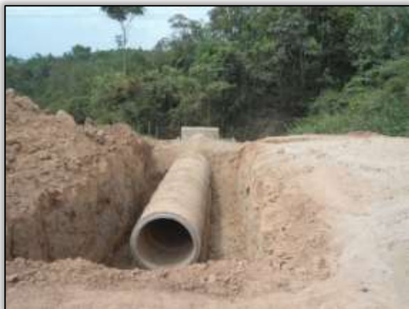
Foto 950 – Implantação de bueiro. S 03.87565 W 054.24110° 11/11/2013.
