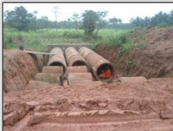
Foto 938 - Implantação de bueiro. S 03.85084° W 054.15321° 24/01/2014
