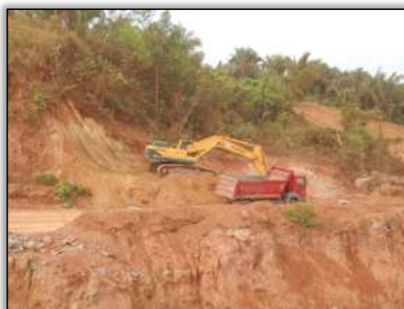
Foto 653 – Corte para conformação de talude. Lado esquerdo. S 03.84638° W 050.51608° 23/10/2013
