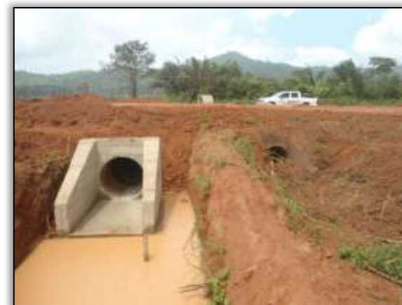
Foto 940 - Bueiro concluído. S 03.85133° W 054.15569°. 24/01/2014.
