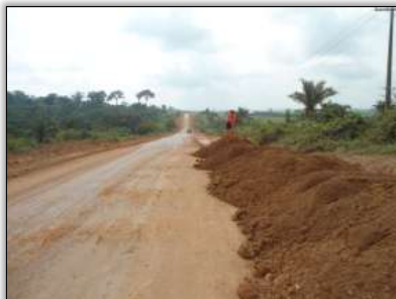
Foto 475 – Material para aterro. Lado esquerdo. S 05.22124° W 049.34314° 04/12/2013
