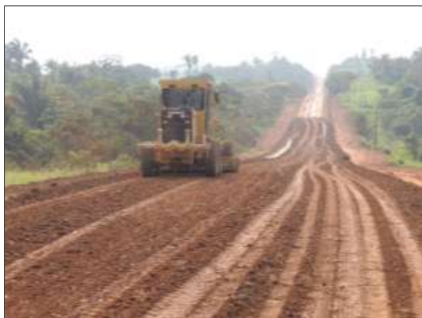
Figura 66. Acompanhamento de terraplenagem na rodovia.
