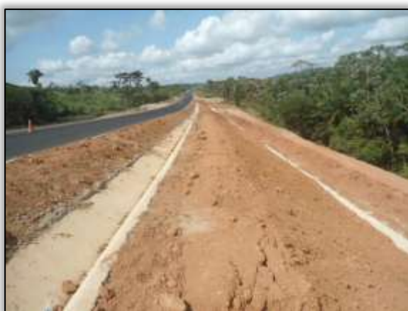
Foto 1166 – Valeta de drenagem. Lado direito. Estaca 1608. S 03.29980° W 052.49967° 17/12/2013.
