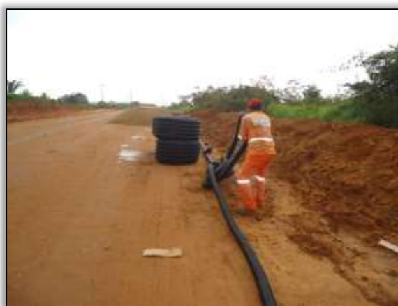
Foto 1036 – Alocação de dreno longitudinal. Lado esquerdo. S 05.20109° W 049.35786° 21/01/2014
