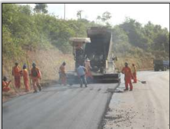
Foto 740- Máquina colocando camada de asfalto. Lado esquerdo. Estaca 4798. S 03.10933° W 051.83132° 22/10/2013
