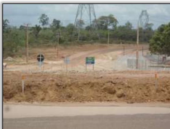
Foto 433 – Final do desvio da rodovia. Lado direito. S 03.12383° W 051.78881° 03/09/2013
