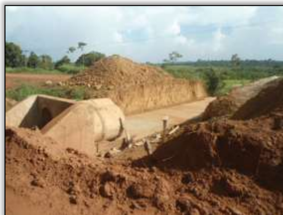
Foto 1024 – Construção de bueiro. S 03.89175° W 054.33456°. 27/12/2013.
