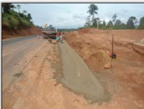
Foto 1162 – Construção de valeta. Lado direito. Estaca 2904. S 03.38952° W 052.70567° 28/11/2013.
