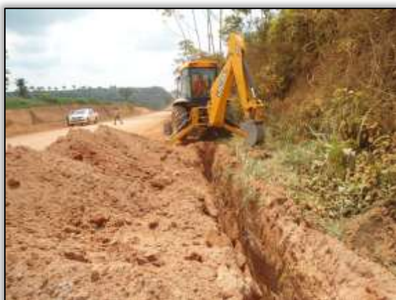
Foto 1043 – Abertura de vala para instalação de dreno longitudinal. Lado esquerdo. S 05.21550° W 049.34774° 04/12/2013
