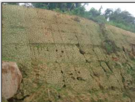
Foto 1082 – Talude após o revestimento vegetal. Lado direito. S 04.04116° W 050.29460° 15/01/2014
