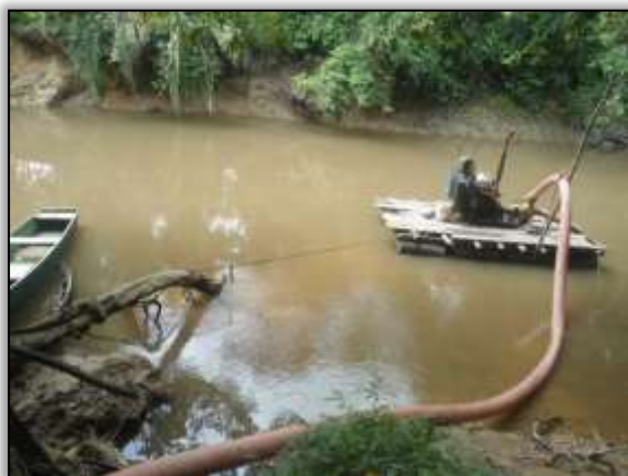
Foto 921 - Retirada de areia. Lado esquerdo. S 03.90013° W 054.27929° 17/01/2014
