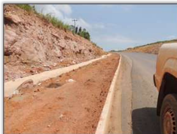
Foto 370 – Trecho entre os municípios de Altamira e Medicilândia, fase construção de obras-de-arte correntes. 04/12/13.
