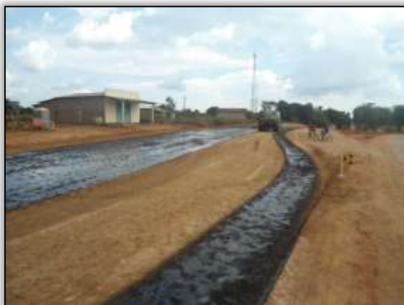
Foto 899 - Aplicação de piche na entrada da vicinal 11. Lado esquerdo. S 03.29595° W 052.48883° 19/11/2013.
