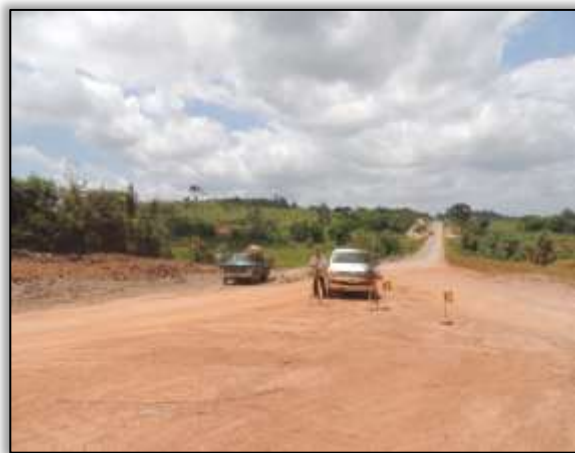
Foto 35- Andamento da pavimentação do lote 05 (sentido Brasil Novo/ Altamira).
