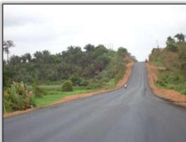
Foto 1111 – Processo erosivo recuperado (depois). Ambos os lados. S 04.16943º W 050.06872º 18/09/2013
