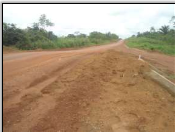
Foto 995 – Bueiro concluído. S 03.88804° W 054.29916° 29/01/2014
