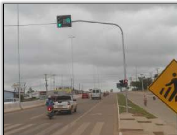
Foto 462 – Semáforo recuperado. S 05.35776° W 049.08637° 03/10/2013
