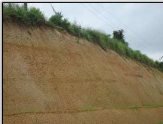
Foto 1089 – Talude após revestimento vegetal. Lado esquerdo. S 03.92425° W 050.34090° 15/01/2014
