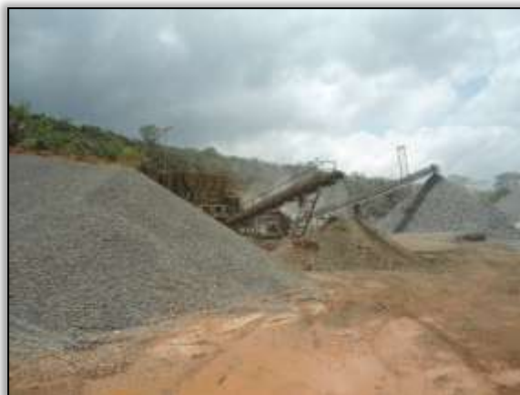
Foto 763 - Britador Sanches Tripoloni. Lado direito. Estaca 3775. S 03.44206° W 052. 85213° 10/10/2013
