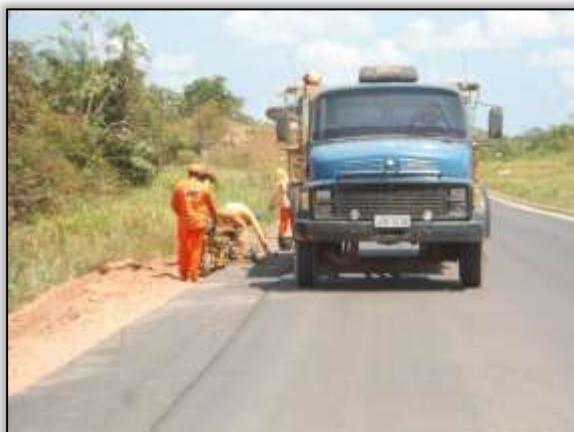
Foto 702 – Construção de sistema de drenagem (meio-fio). Lado esquerdo. Estaca 3134. S 03.15316° W 051.57401° 25/09/2013
