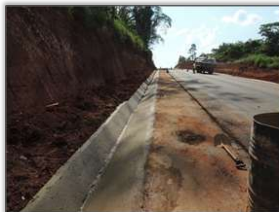
Foto 374 – Trecho entre os municípios de Altamira e Medicilândia, fase de construção de obras-de-arte - sarjeta. 04/12/13.
