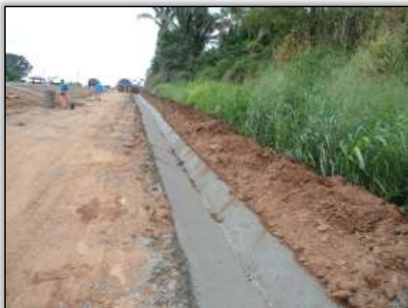
Foto 1146 - Construção de drenagem. Lado esquerdo. Estaca 1794. S 03. 30709° W 052. 53133° 20/08/2013.
