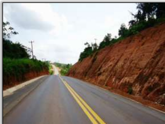
Foto 352 – Trecho entre os municípios de Novo Repartimento e Pacajá/PA – 18/12/13
