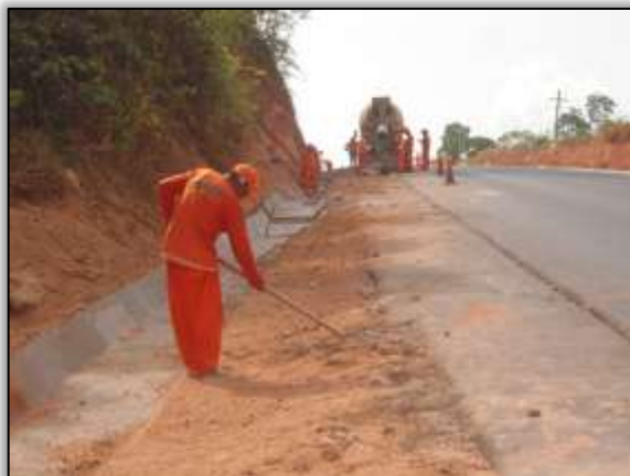
Foto 727 – Construção de sistema de drenagem (sarjeta). Lado esquerdo. Estaca: 3424. S 03.12040° W 051.60982° 09/10/2013
