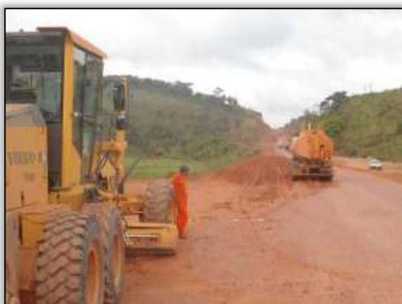
Foto 663 – Atividades de terraplenagem. Lado esquerdo. Estaca 1141. S 03.84473° W 051.52826° 23/10/2013
