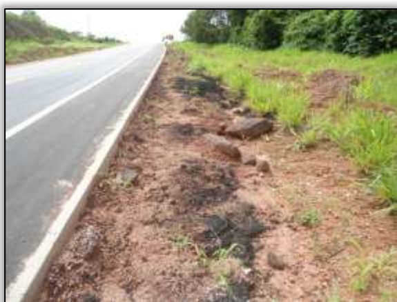
Foto 688– Resíduo de obra. Estaca 33407. Lado Esquerdo. S 03.16438° W 051.56507° 24/01/2014
