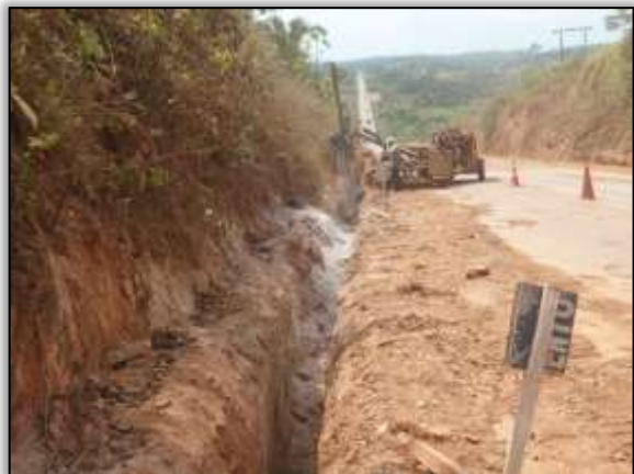
Foto 724 – Construção de sistema de drenagem (dreno profundo). Lado esquerdo. Estaca: 3410. S 03.44524° W 051.22652° 09/10/2013
