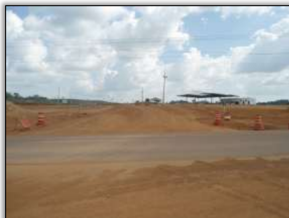
Foto 444 – Acesso Sítio Pimental. Lado esquerdo. Estaca 5960. S 03.15075° W 051.97823° 23/10/2013
