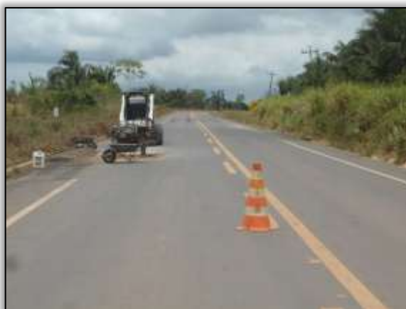
Foto 747- Reconformação da pista. Lado esquerdo. Estaca 39594° W 051.28965° 29/10/2013
