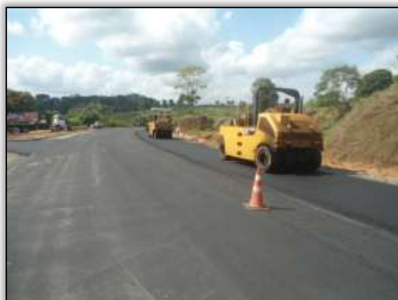
Foto 904 - Conclusão da segunda camada asfáltica do trevo da vicinal 11. Lado esquerdo. S 03.29511° W 052.48823° 17/12/2013.
