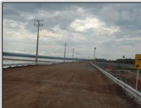
Foto 428 – Local do desvio com a via sinalizada. S 03.11912° W 051.77243° 17/08/2013
