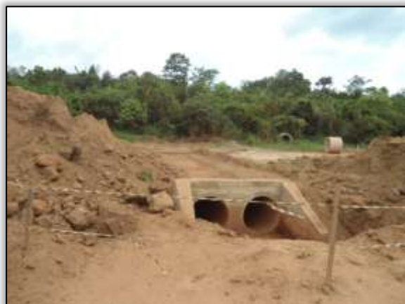
Foto 964- Construção de bueiro. Antes. S 03.86231° W 054.19566° 11/11/2013.
