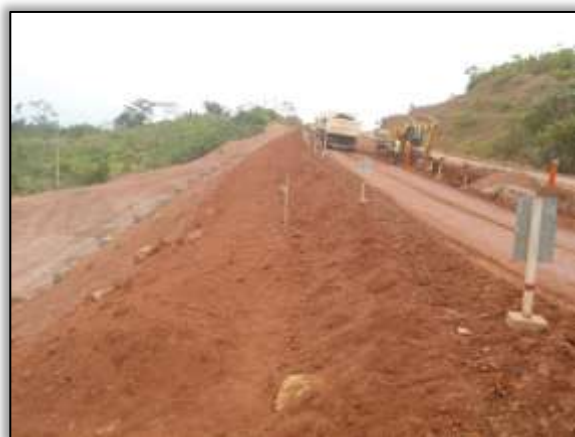
Foto 718 – Reconformação da rodovia e da saia de aterro (Gabião). Lado esquerdo. S 03.16962° W 052.01243° 20/11/2013
