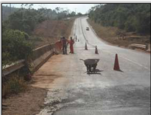
Foto 738-Limpeza da ponte. Estaca 4684. S 03.11787° W 051.81585° 22/10/2013
