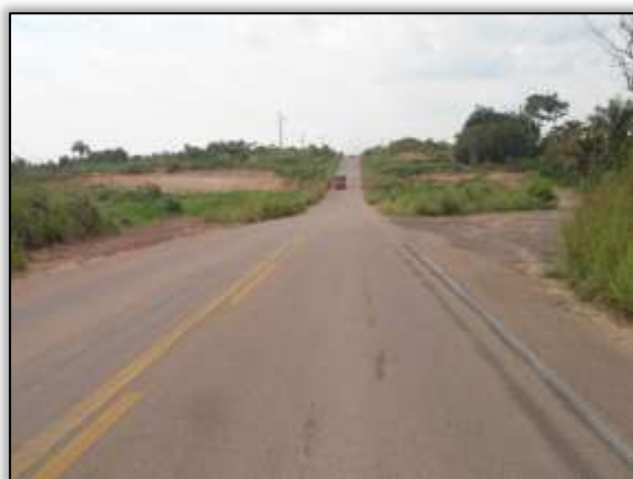
Foto 417 – Entrada para áreas de apoio do canteiro de obras. S 05.14985°W 049.38852° 03/12/2013
