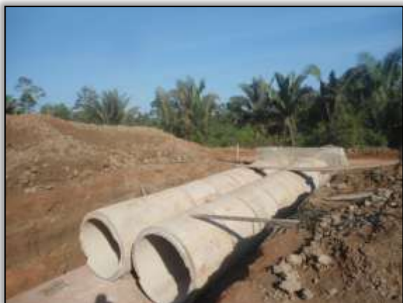
Foto 1011 – Construção de bueiro. S 03.88807° W 054.29888°. 26/11/2013.
