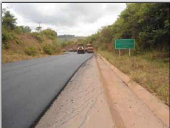
Foto 742- Asfaltamento da rodovia. Lado esquerdo. Estaca 4972. S 03.09462° W 051.85629° 29/10/2013
