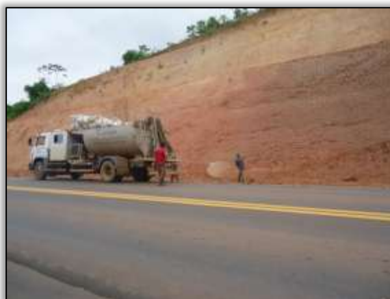
Foto 1081 – Aplicação de hidrossemeadura. Lado direito. S 04.20101° W 049.99736° 15/01/2014
