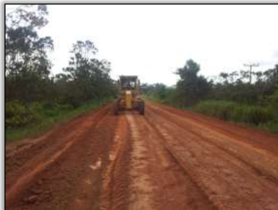
Foto 988 - Máquina fazendo a terraplanagem. Estaca 8786. S 03. 88940° W 054. 28294° 23/10/2013.
