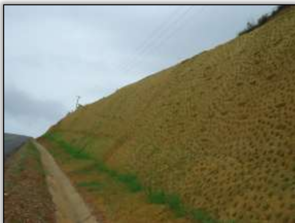
Foto 1084 – Talude após o revestimento vegetal. Lado direito. S 04.93067° W 049.33046° 15/01/2014
