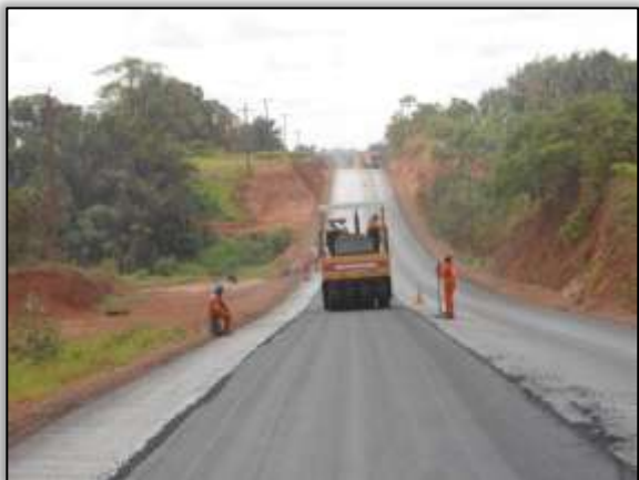
Foto 524 – Compactação asfáltica. Lado direito, S 04.15977° W 050.13210° 21/08/2013
