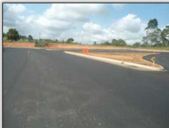
Foto 902 - Conclusão de trevo da vicinal 12 pavimentado. Lado direito. Estaca 1492. S 03.29901° W 052.48932° 17/12/2013.
