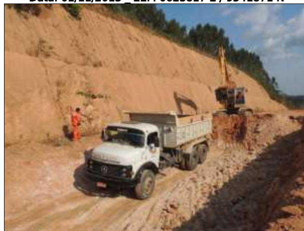
Figura 53. Obras de terraplenagem em área da rodovia. Data: 04/11/2013 _ 22M 0677634 E / 9432932 N
