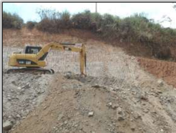
Foto 822– Corte em talude. Lado direito. S 03. 39043° 052. 71729° 20/08/2013.
