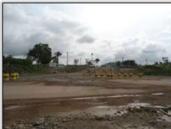
Foto 458– Acesso ao canteiro de obras do CCBM. Lado esquerdo. S 03.12284° W 051.79378° 26/12/2013.
