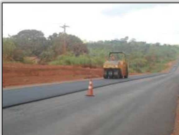
Foto 887 – Segunda camada asfáltica. Estaca 3294. S 03.41000° W 052.77272° 26/11/2013.
