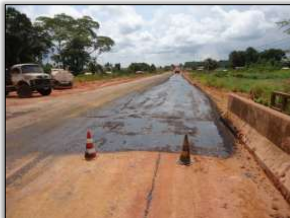
Foto 677 – Imprimação. Lado direito. Estaca 3293. S 03.13485° W 051.59189° 29/08/2013
