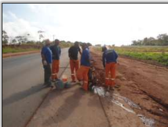
Foto 819 – Corte para construção de meio fio. Estaca 1878. Lado esquerdo. S 03. 30799° W 052. 54592° 14/08/2013
