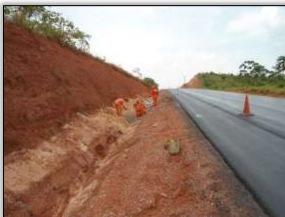
Foto 1118 – Descida d'água em fase instalação. Lado esquerdo. S 04.20299º W 049.99453º 27/11/2013
