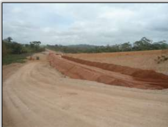
Foto 883 – Aterro e terraplanagem. S 03.30003° W 052.49889° 13/11/2013.
