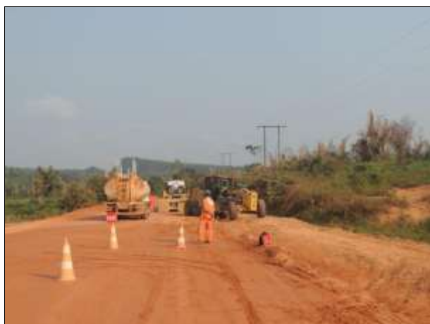
Figura 62. Obras de terraplenagem acompanhadas pela equipe. Data: 05/12/2013 22M 0683841 E / 9422360 N
