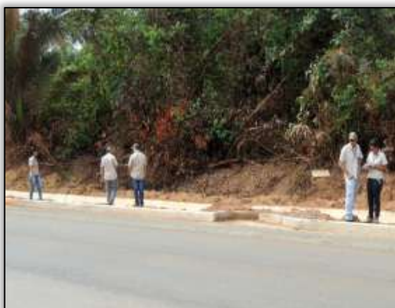
Foto 1148 - - Sistema de drenagem. Lado esquerdo. S 03. 30709° W 052. 53133° 20/08/2013.
