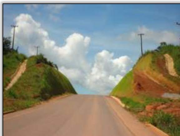
Foto 1070 – Revestimento vegetal em talude de corte. Ambos os lados. S 04.03120° W 050.28943° 25/07/2013
