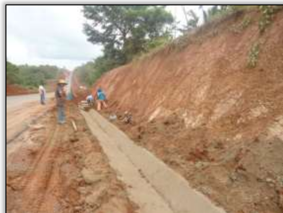
Foto 1158 - Construção de Valeta. Lado esquerdo. S 03.39035° W 052.71671° 20/11/2013.
