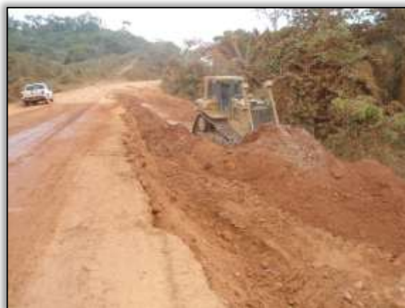
Foto 655 – Corte e conformação da rodovia. Lado direito. S 03.70292° W 050.91600° 23/10/2013
