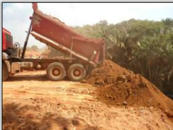
Foto 593 – Depósito de aterro no bota-fora. Lado esquerdo. Estaca 4318. S 03.61907° W 051.01874° 05/12/2013
