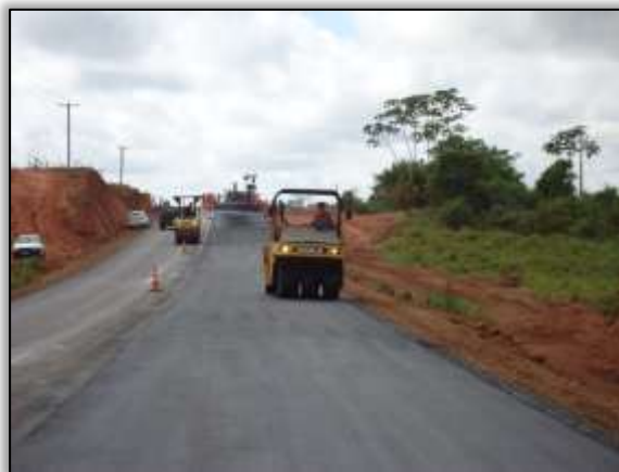
Foto 529 – Aplicação camada asfáltica. Lado direito. S 04.25967° W 050.11670° 31/07/2013
