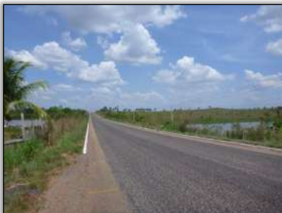
Foto 1293 – Ponto 06 – Trecho asfaltado. 5.473208° S 48.794871° W (15/10/2013).
