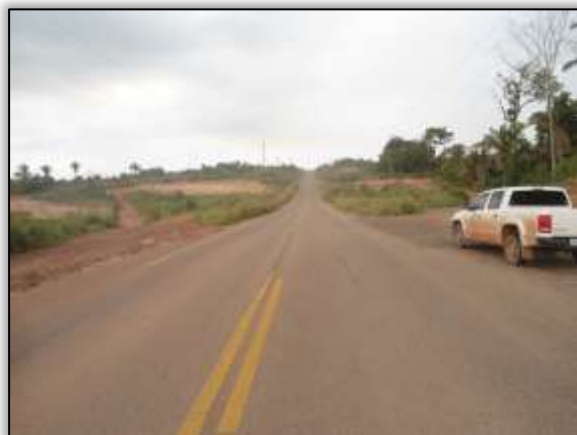
Foto 415 – Entrada para áreas de apoio do canteiro de obras. S 05.14985°W 049.38852° 23/10/2013
