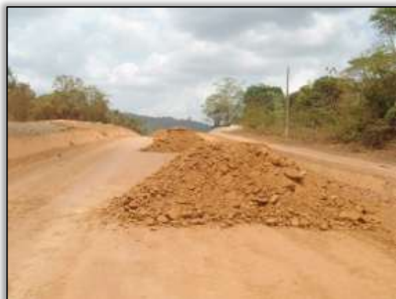
Foto 666 – Material para terraplenagem. Lado direito. Estaca 4890. S 03.55730° W 051.09771° 23/10/2013
