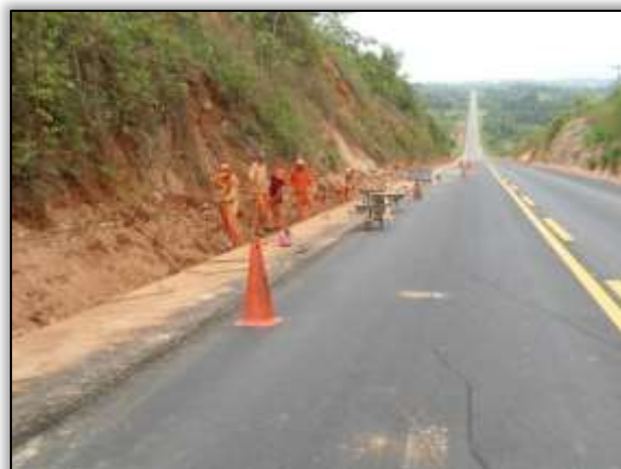
Foto 705– Sarjeta triangular de concreto. Estaca 605. Lado Esquerdo. S 03.44531° W 051.22649° 05/12/2012.
