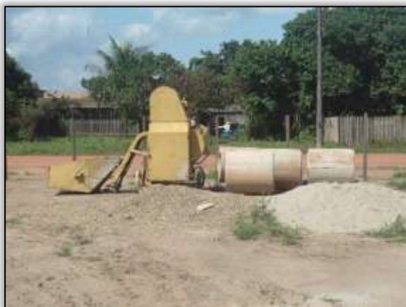
Foto 909 – Construção da fábrica de artefatos. Lado direito. S 03.866167° W 054.211694° 26/11/2013
