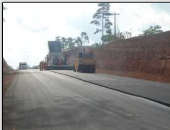
Foto 888 – Segunda camada asfáltica. Estaca 3294. S 03.41000° W 052.77272° 26/11/2013.
