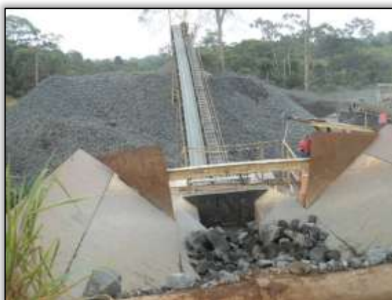
Foto 773 – Britador Sanches Tripoloni. Lado direito. Estaca 3775. S 03.44206° W 052.85213° 14/11/2013.
