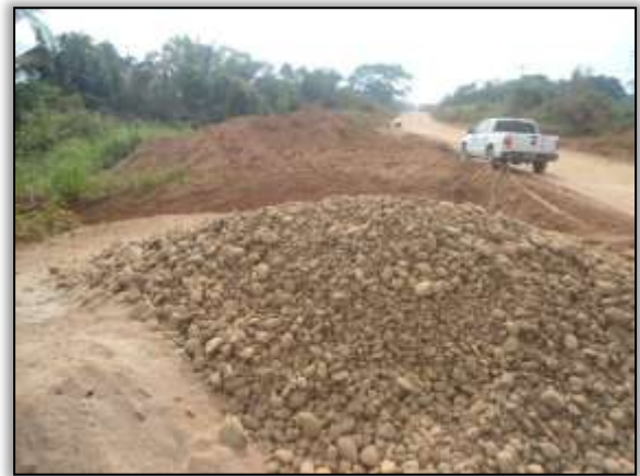
Foto 961 - Bueiro. S 03.85141° W 054.15584°. 18/12/2013
