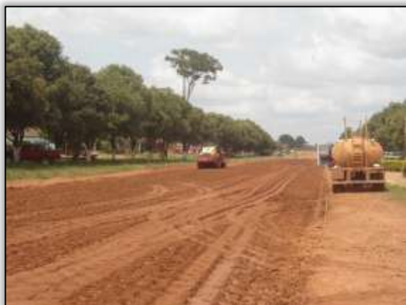
Foto 929 – Terraplanagem e compactação do solo na área urbana de Placas. Estaca 8380. S 03. 86808° W 054. 21615° 23/10/2013.
