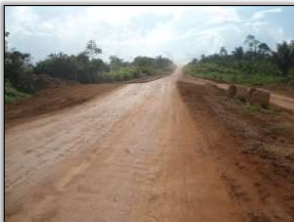
Foto 1017 – Rodovia sobre bueiro. S 03.88797° W 054.29877° 27/12/2013.
