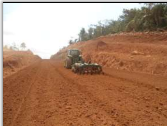
Foto 862 - Máquina gradeando o solo. Estaca 2902. S 03.38943° W 052.70567°. 10/10/2013.
