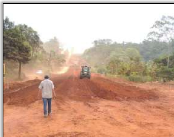
Foto 33- Andamento da pavimentação do lote 05 (sentido Brasil Novo/ Altamira).
