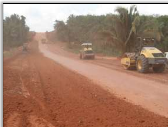
Foto 612 – Compactação e revolvimento de material. Estaca 4193. Lado direito/esquerdo. S 03.63462° W 051.00212° 12/11/2013
