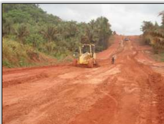
Foto 669 – Terraplenagem. Lado esquerdo. Estaca 4187. S 03.6344° W 051.00151° 30/10/2013
