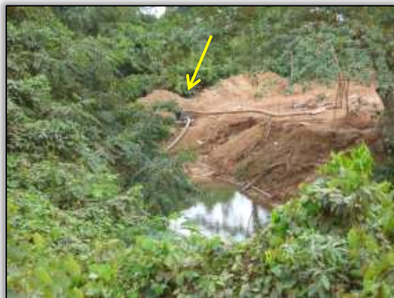
Foto 1442 – Ponto 47 – Montante – Captação de água. 3.320154° S 52.567838° W (09/10/2013).
