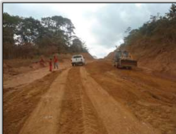
Foto 955 - Reconformação de buracos. S 03.76812° W 053.86707° 18/12/2013
