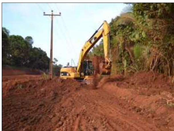
Figura 40. Limpeza e terraplenagem em obra da rodovia. Data: 16/10/2013
