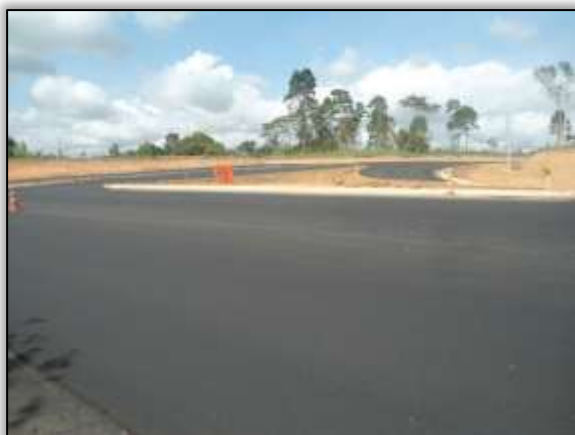
Foto 901 - Conclusão de trevo da vicinal 12 pavimentado. Lado direito. Estaca 1492. S 03.29901° W 052.48932° 17/12/2013.
