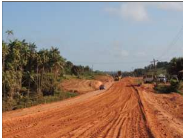
Figura 31. Limpeza e terraplenagem em área da BR-230/PA. Data: 30/07/2013
