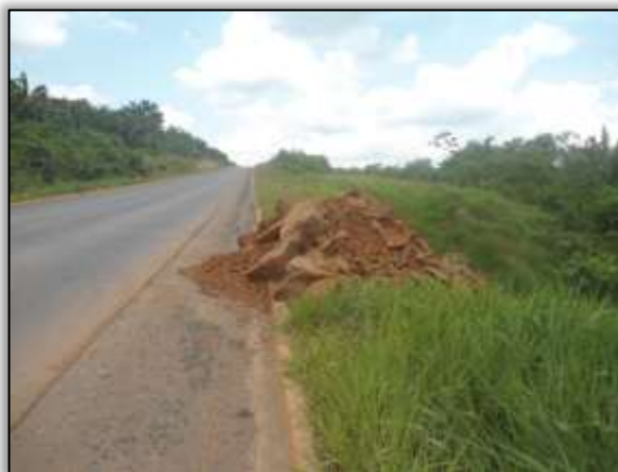
Foto 1194 – Material na faixa de domínio. Lado esquerdo. Estaca 2591. S 03.37218° W 052.65399° 17/12/2013.
