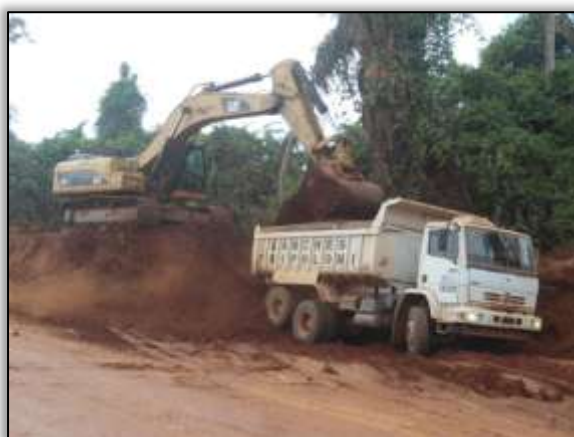
Foto 812 – Carregamento de material. Estaca 3424. Lado esquerdo. S 03.41853° W 052. 79511° 14/08/2013
