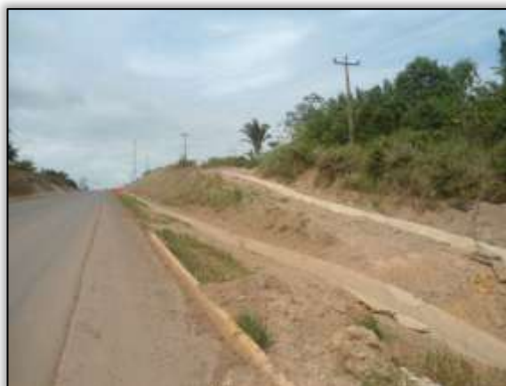
Foto 892 – Valeta concluída. Lado direito. Estaca 2413. S 03.35632° W 052. 62643°
