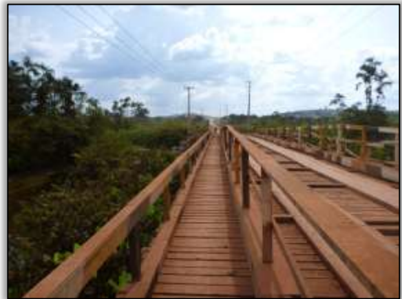
Foto 1431 – Ponto 45 – Construção da passarela. 3.194507° S 52.195891° W (09/10/2013).
