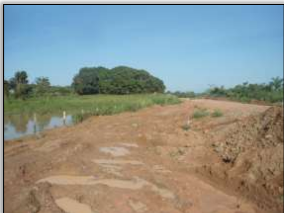
Foto 1013 – Caminho de serviço desativado. Lado esquerdo. Estaca 8751. S 03.89072° W 054.27675° 26/11/2013.
