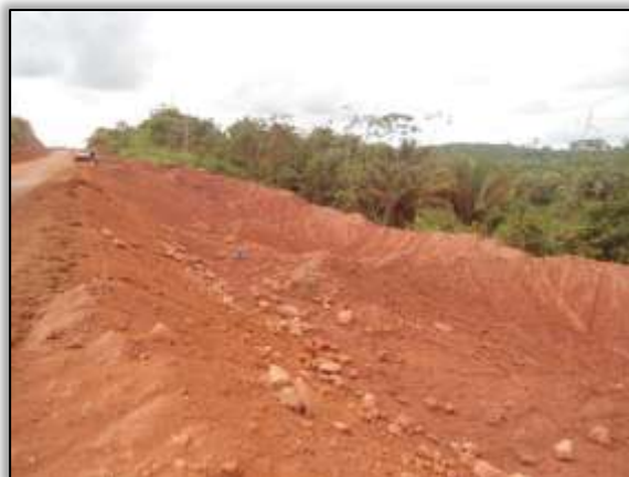
Foto 1069 – Correção da saia de aterro. Lado esquerdo. S 04.16764° W 050.07422° 15/08/2013
