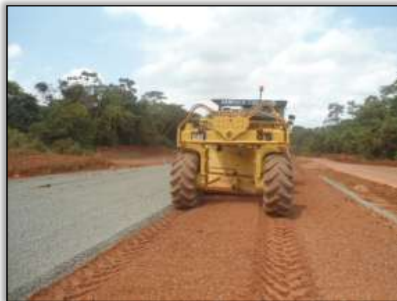
Foto 876 - Máquina Recicladora. Estaca 3607. S 03.43663° W 052.82151°. 23/10/2013
