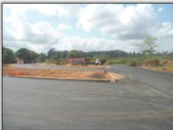
Foto 903 - Conclusão da segunda camada asfáltica do trevo da vicinal 11. Lado esquerdo. S 03.29511° W 052.48823° 17/12/2013.
