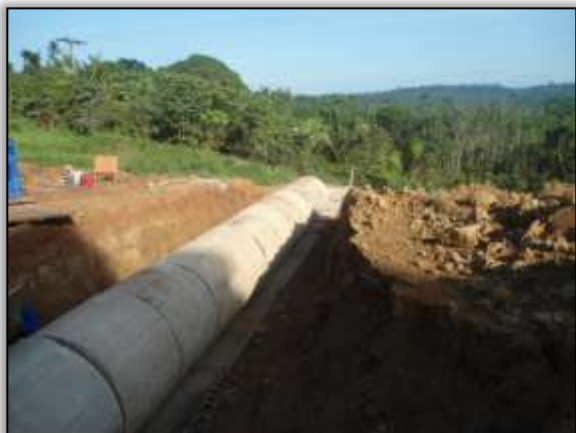
Foto 1009 – Construção de bueiro. S03. 89098° W 054.31071°. 26/11/2013.
