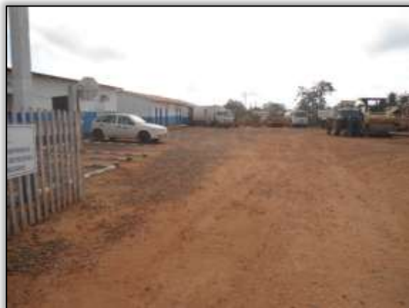
Foto 748 - Canteiro de obra da Sanches Tripoloni. Lado esquerdo. Estaca 1827. S 03.30872° W 052. 53631 14/08/2013
