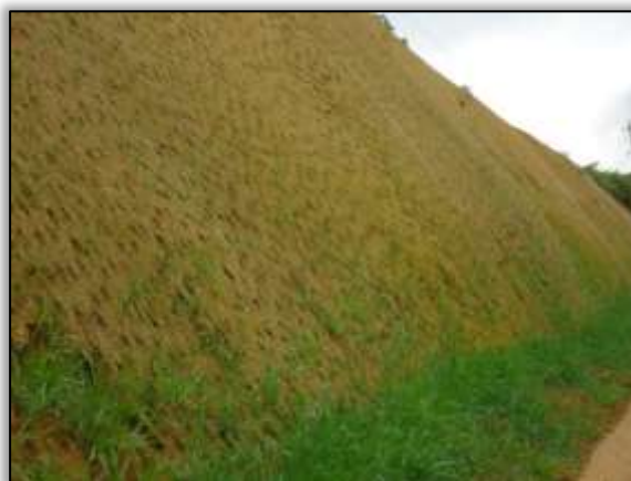
Foto 1087 – Talude após revestimento vegetal. Lado esquerdo. S 03.92887° W 050.33671° 15/01/2014
