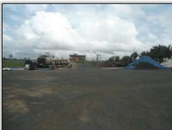
Foto 782 - Usina de asfalto. Lado direito. Estaca 1880. S 03.30814° W 052.54790° 23/01/2014
