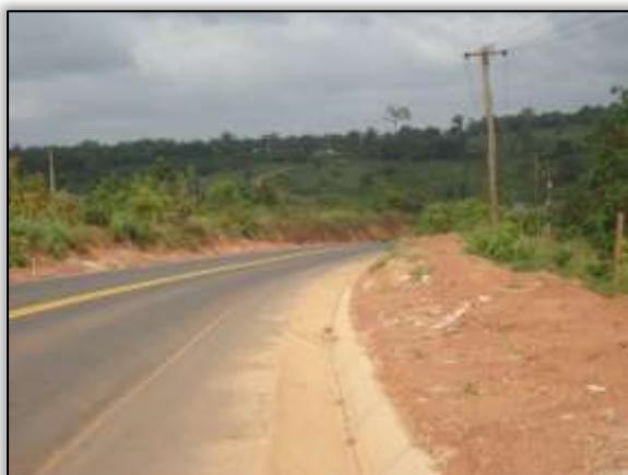
Foto 1122 – Descida d’água em fase instalação. Lado direito. S 04.22874° W 049.97234° 27/11/2013
