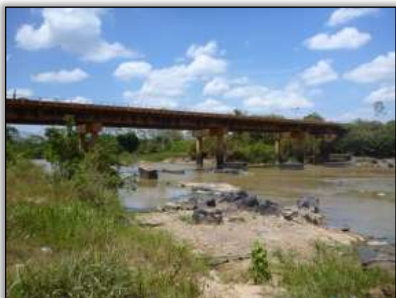
Foto 1318 – Ponto 13 – Ponte sobre o Rio Cajazeiros – Jusante. 4.961607° S 49.451885° W (14/10/2013).
