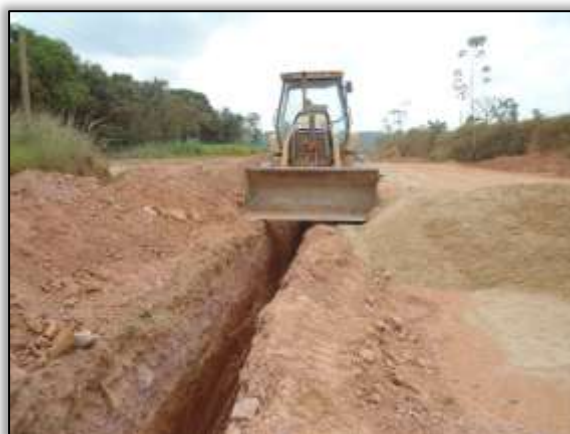
Foto 1050 – Abertura de vala para instalação de dreno longitudinal. Lado esquerdo. S 05.11277° W 049.41587° 04/12/2013
