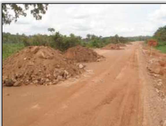
Foto 611 – Material para terraplenagem. Lado esquerdo. Estaca 4536. S 03.59676° W 051.05060° 26/11/2013
