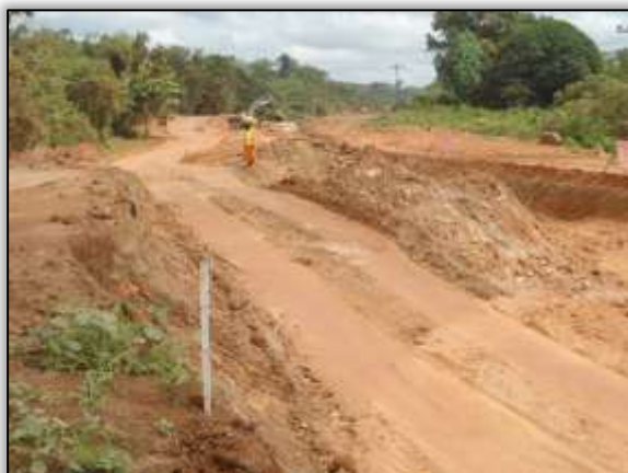
Foto 597 – Conformação do off set da rodovia. Lado direito. Estaca 4947. S 03.55503° W 051.10783° 07/08/2013
