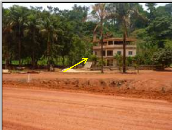
Foto 1453 – Ponto 50 – Jusante – Propriedade aos fundos. S 3.411988° W 52.777656° (09/10/2013).
