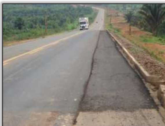
Foto 541 – Recuperação da rodovia com recapeamento. Lado direito. S 03.97974° W 050.31995° 24/10/2013
