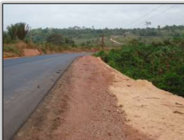
Foto 1093 – Processo erosivo reconformado (depois). Lado direito. S 04.22884° W 049.97191° 18/09/2013
