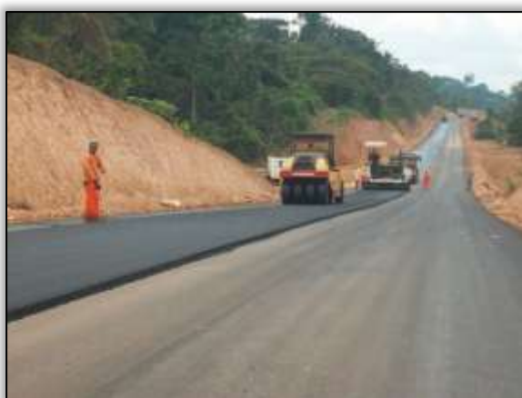
Foto 617 – Pavimentação da segunda camada. Estaca 4954. Lado esquerdo. S 03.55396° W 051.10946° 12/11/2013
