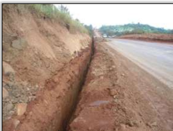
Foto 817 – Sistema de drenagem profunda. Estaca 3669. Lado esquerdo. S 03. 43908° W 052. 83287° 14/08/2013
