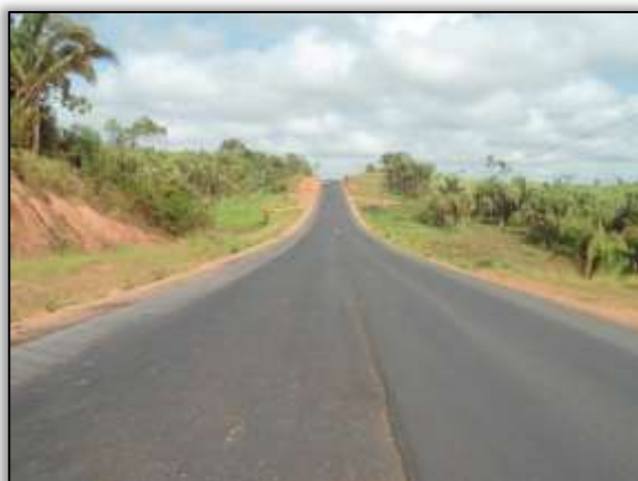
Foto 520 – Primeira camada asfáltica. Lado direito. S 04.15926° W 050.14647° 21/08/2013
