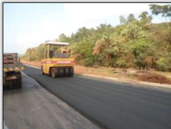
Foto 880 - Segunda camada de asfalto. S 03. 31051° W 052. 54897° 23/10/2013.
