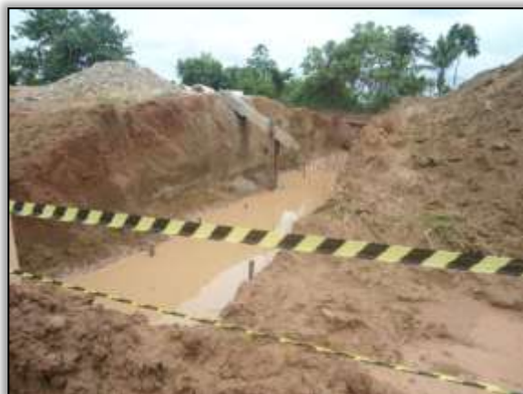
Foto 1002 – Escavação para construção de bueiro. S 03.88947° W 054.34155° 30/01/2014
