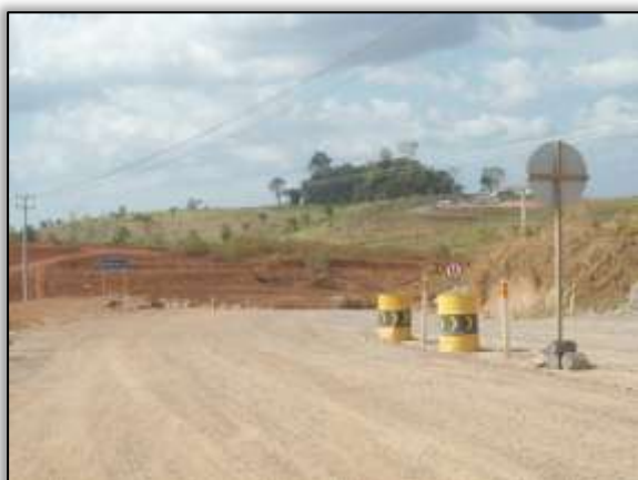
Foto 443 – Acesso ao porto do CCBM. Lado esquerdo. Estaca 4572. S 03.12021° W 051.79644° 23/10/2013
