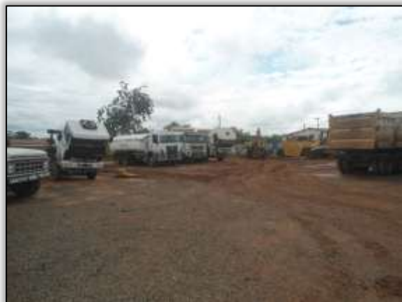
Foto 776 - Canteiro de obras. Lado esquerdo. Estaca 1827. S 03.30872° W 052.53631° 28/01/2014
