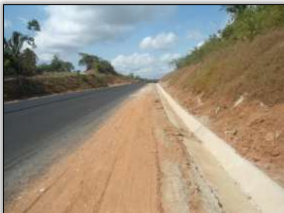
Foto 1164 – Construção de valeta. Lado direito. Estaca 1583. S 03.29863° W 052.49510° 17/12/2013.
