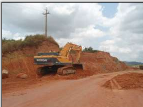
Foto 650 – Corte da rodovia. Lado esquerdo. Estaca 1114.
