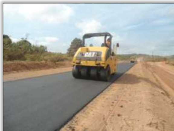
Foto 870 - Compactação da pista. Estaca 2108 á 2132. S 03.33117° W 052.58248°17/10/2013.
