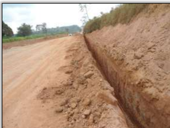
Foto 1049 – Abertura de vala para instalação de dreno longitudinal. Lado esquerdo. S 05.11277° W 049.41587° 04/12/2013
