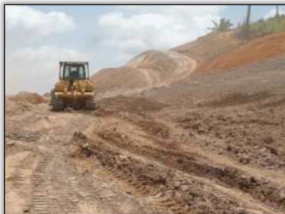
Foto 840 – Corte e construção de banquetas. Lado direito. Estaca 2665. S 03.37709° W 052.66370° 17/09/2013.
