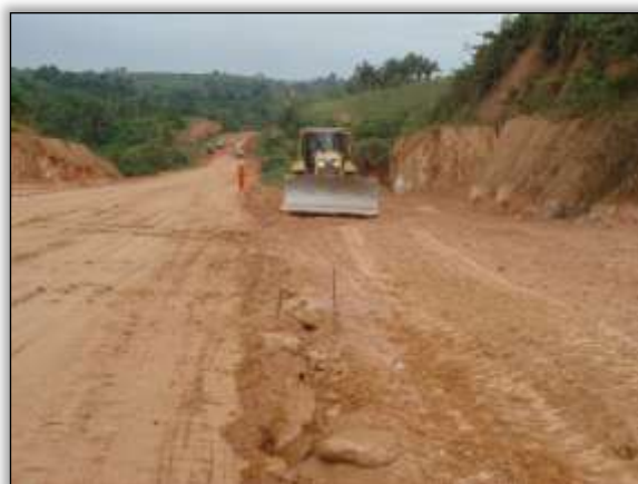
Foto 1059 – Recuperação de processo erosivo. Lado direito. S 05.25879° W 049.39858° 12/11/2013
