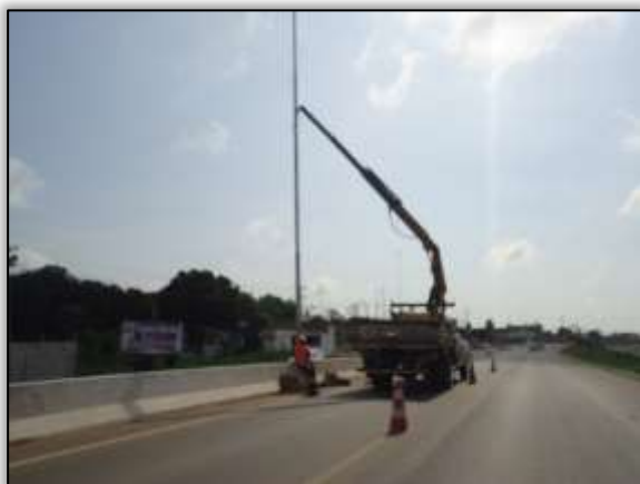
Foto 465 – Instalação de iluminação na rodovia. S 05.35075° W 049.10010° 29/10/2013
