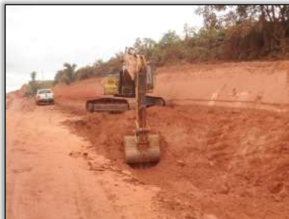
Foto 657 – Corte e conformação da rodovia. Lado direito. Estaca 4309. S 03.61989° W 051.01729° 30/10/2013
