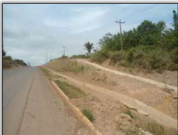
Foto 1156 - Valetas de proteção. Lado direito. Estaca 2413. S 03.35632° W 052.62643°. 17/10/2013.
