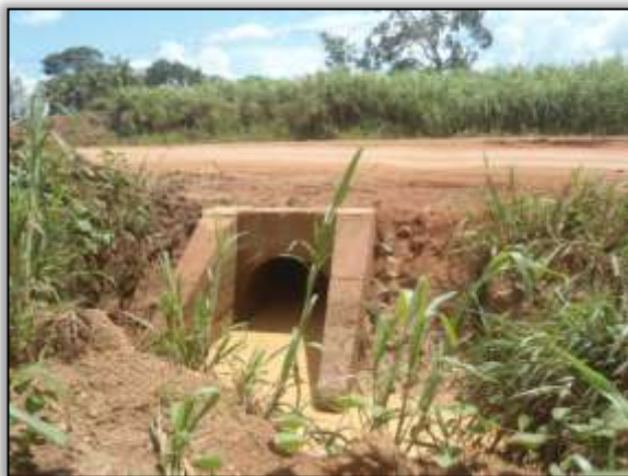
Foto 941 - Bueiro concluído. Estaca 8224. S 03.86076° W 054.18909°. 24/01/2014.
