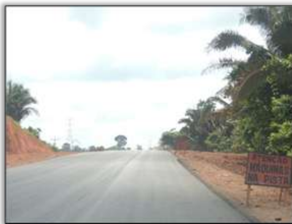
Foto 366 – Trecho entre os municípios de Pacajá e Anapu/PA, fase de sinalização de pista. 11/12/13.
