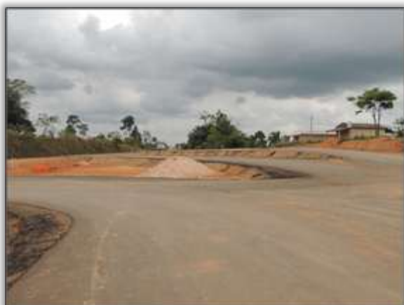
Foto 367 – Trecho entre os municípios de Altamira e Brasil Novo, fase de sinalização rotatória de acesso à rodovia BR-230/PA. 04/12/13.
