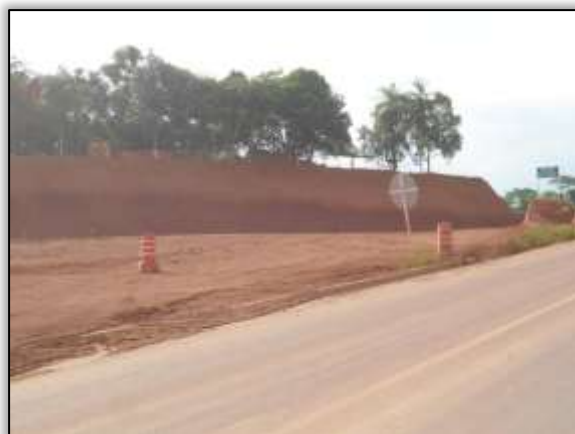
Foto 452 – Rotatória para acesso ao porto do CCBM. Lado esquerdo. S 30.12021° W 051.79644° 26/11/2013
