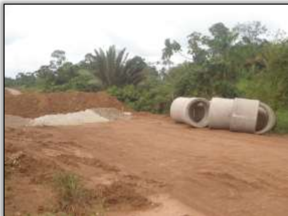
Foto 1005 – Construção de bueiro. S 03.88794° W 054.39463° 30/01/2014
