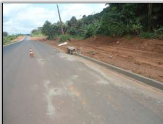
Foto 1175 – Construção de meio fio. Lado esquerdo. Estaca 3690. S 03.44005° W 052.83631° 17/12/2013.
