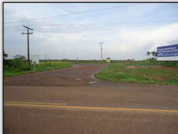
Foto 410 – Entrada para áreas de apoio do canteiro de obras. S 05.14985°W 049.38852° 26/12/2013
