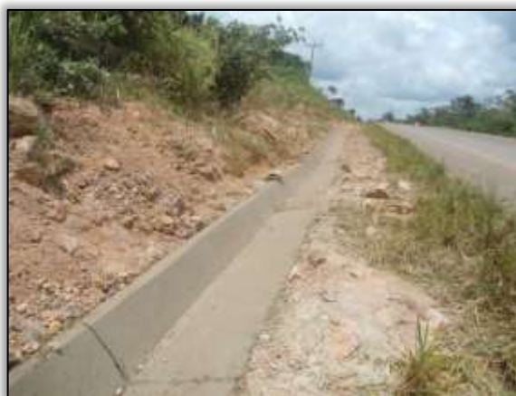
Foto 1153 – Construção de valeta. Lado direito. Estaca 2564. S 03. 36999. W 052. 65012° 27/09/2013.
