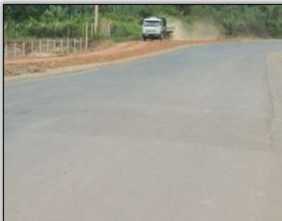
Foto 30- Andamento da pavimentação do lote 05 (sentido Brasil Novo e Altamira).
