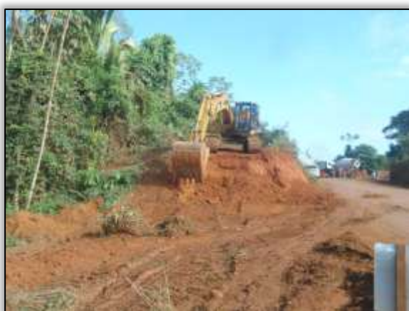
Foto 1223 – Limpeza com máquina. Lado Esquerdo. Estaca 4977. S 03.54960° W 051.11388° 28/08/2013
