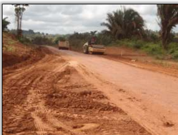
Foto 599 – Atividades de terraplenagem e compactação do solo na rodovia. Estaca 4575. S 03.59304° W 051.05669° 21/08/2013
