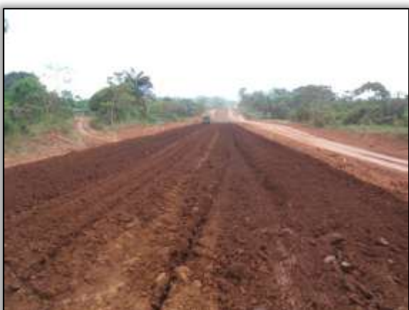
Foto 829 – Terraplanagem. Estaca 3573. S 03 43316° W 052. 81557° 20/08/2013.
