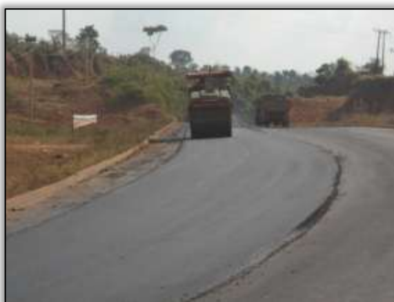
Foto 739- Máquinas trabalhando em mais uma camada de asfalto. Lado esquerdo. Estaca 4788. S 03.10805° W 051.82986° 22/10/2013
