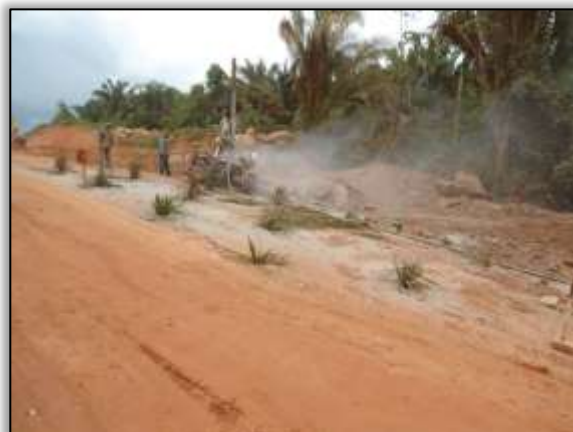
Foto 622 – Perfuração de pontos para detonação. Lado direito. S 03.63314° W 051.00311 20/11/2013
