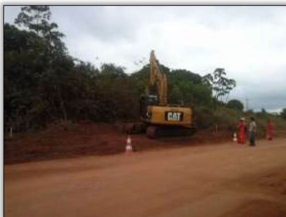
Foto 1213 – Maquinário fazendo a limpeza da faixa de domínio. Lado esquerdo, S 05.17901° W 049.37054° 21/10/2013
