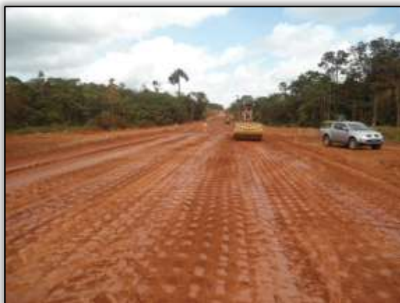
Foto 809 – Compactação do solo. Estaca 3321. S 03. 41170° W 052. 77778° 14/08/2013
