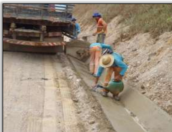
Foto 1184 – Construção de valeta. Lado direito. Estaca 1586. S 03.29901° W 052.49601° 13/12/2013.
