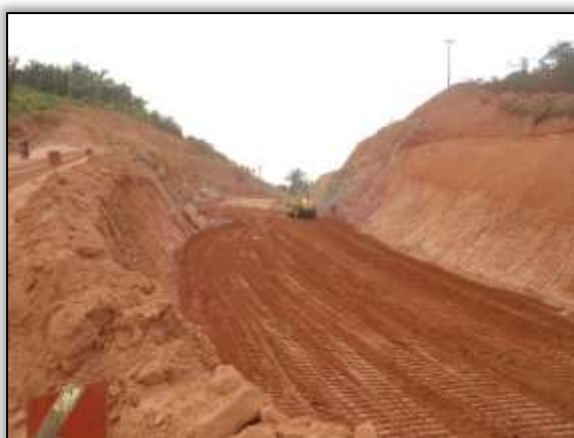
Foto 652 – Corte da rodovia e talude na ladeira do canteiro (Depois 23/10/2013). Lado direito. Estaca 1238. S 03.84726° W 050.54377°
