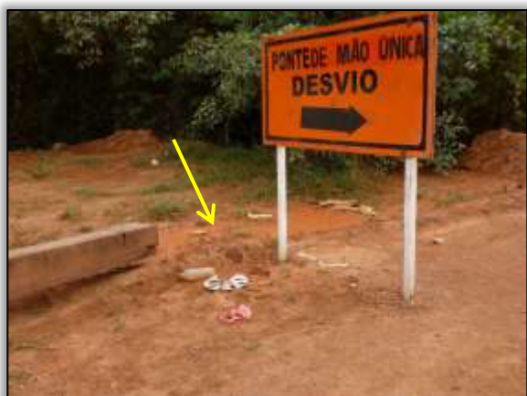
Foto 1439 – Ponto 47 – Lixo as margens. 3.320154° S 52.567838° W (09/10/2013).
