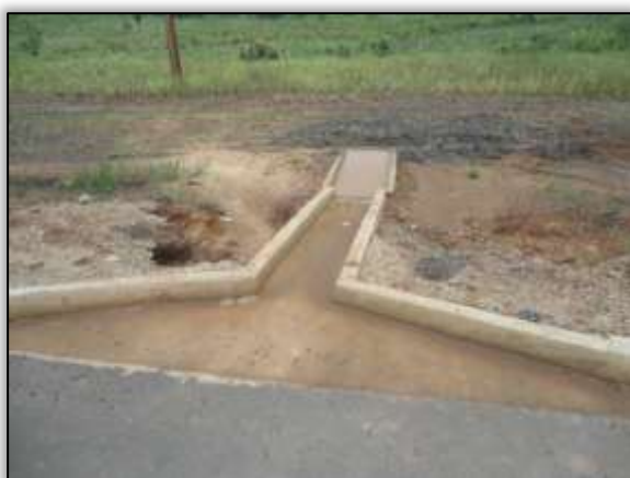
Foto 889 – Saída d'água concluída. Lado direito. Estaca 2138. S 03. 33343° W 052. 53392° 28/01/2014
