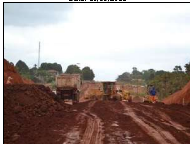
Figura 39. Máquinas trabalhando em serviços de terraplenagem na rodovia. Data: 15/10/2013
