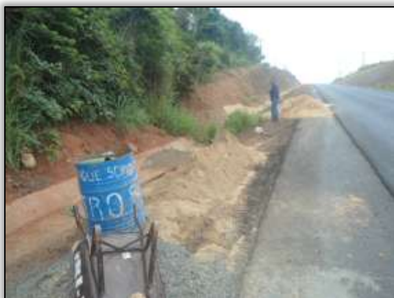
Foto 1172 – Construção de drenagem. Lado esquerdo. S 03.35649° W 052.62665° 17/12/2013.
