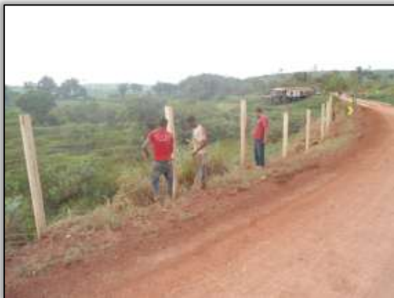
Foto 575 – Instalação de cercas na T.I. Parakanã próximo ao rio Pucuruf. Lado esquerdo. S 04.43354° W 049.92784°. 30/10/2013.
