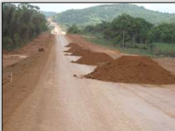
Foto 609 – Material para terraplenagem. Lado direito. Estaca 4600. S 03.59042° W 051.06026° 12/11/2013
