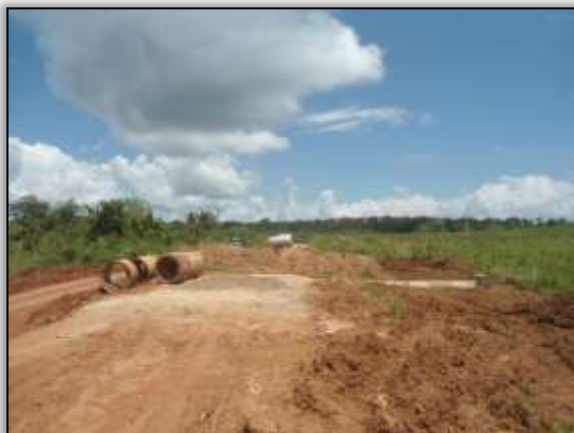
Foto 935 - Implantação de bueiro. S 03.85787° W 054.11796° 21/01/2014
