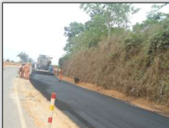
Foto 896 – Pavimentação na entrada da vicinal 12. Lado direito. S 03.28687° W 052.48946° 20/11/2013.
