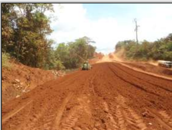
Foto 823 – Máquina gradeando a pista. Estaca 3455. S 03. 42138° W 052. 79944° 20/08/2013.
