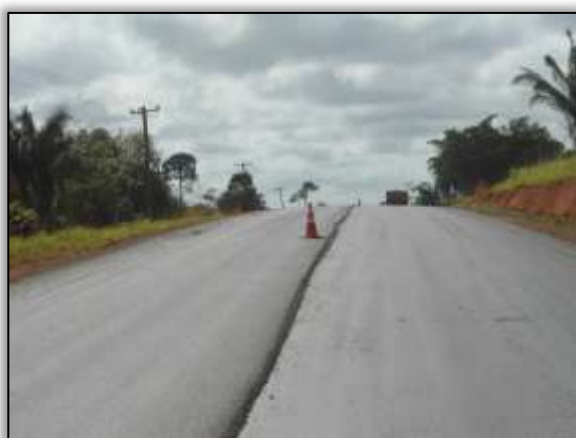
Foto 522 – Primeira camada asfáltica. Lado esquerdo. S 04.15865° W 050.14987° 21/08/2013
