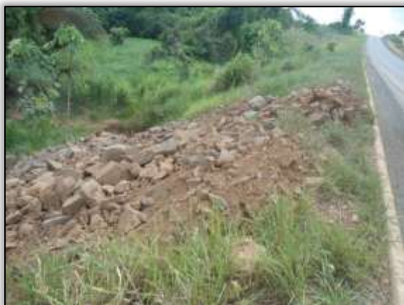
Foto 1193 – Material rochoso na faixa de domínio. Lado esquerdo. Estaca 2606. S 03.37340° W 052.65623° 17/12/2013.
