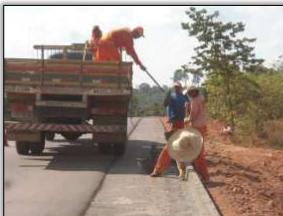
Foto 735 - Construção de sistema de drenagem (meio fio). Lado direito. Estaca: 3604. S 03.10646° W 051.63851° 22/10/2013
