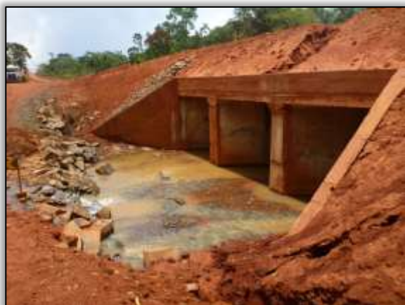
Foto 1455 – Ponto 50 – Montante – Construção galeria. S 3.411988° W 52.777656° (09/10/2013).
