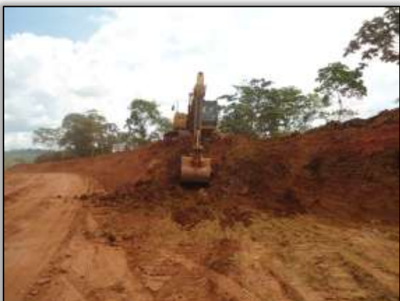
Foto 827 – Corte em talude. Lado direito. Estaca 3549. S 03. 43055° W 052. 81358° 20/08/2013.
