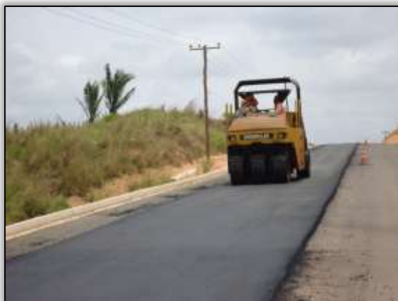
Foto 534 – Compactação da segunda camada asfáltica. Lado direito. S 04.23867° W 049.95618° 18/08/2013
