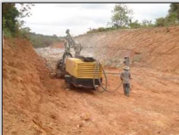
Foto 621 – Preparação para detonação. Lado esquerdo. Estaca 4265. S 03.62515° W 051.01154° 12/11/2013
