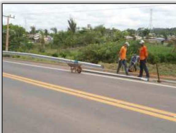
Foto 706– Instalação de defesa metálica. Estaca 3292. Lado Direito. S 03.13557° W 051.59121° 06/12/2013.
