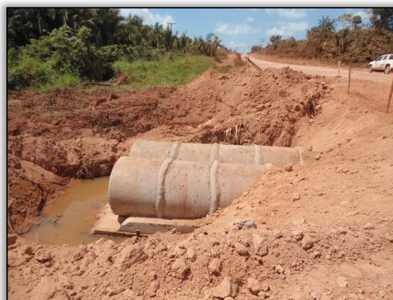
Foto 268 - Bueiro duplo tubular de concreto (BDTC). Estaca: 3404. S 03. 12188° W 051. 60652° . 31/01/2012
