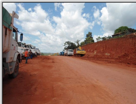
Foto 287 - Retirando material do corte para aterro. Lado esquerdo. S 03. 22643° W 051. 50595° 17/07/2012
