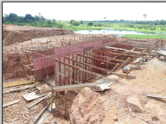
Foto 526 - Substituição de bueiro. Estaca 2428+12,00. S 03. 24552° W 051. 48267°. 17/07/2012
