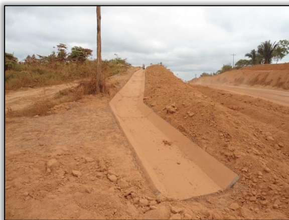
Foto 276 - Valeta de proteção de corte. Lado esquerdo. Estaca 888 a 901. S 03.41267° W 051.26416° 07/08/2012
