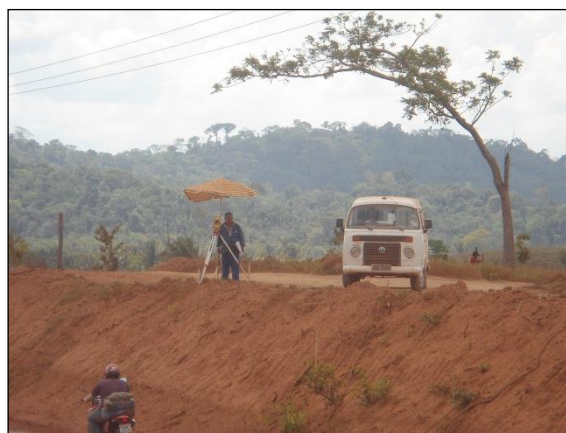
Foto 196 - Atividade de topografia. Estaca 4998. Lado direito. S 03.94000° W 050.30908° 07/08/2012
