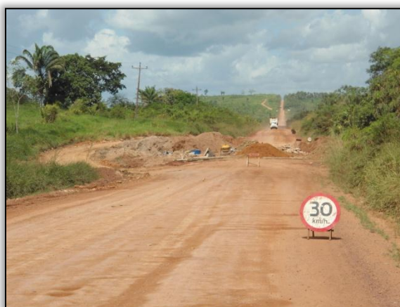
Foto 237 – Sinalização vertical temporária indicando redução de velocidade e desvio, devido à construção de um bueiro. Lado esquerdo. Estaca 724. S 03.19019° W 052.19188°. 16/05/2012.
