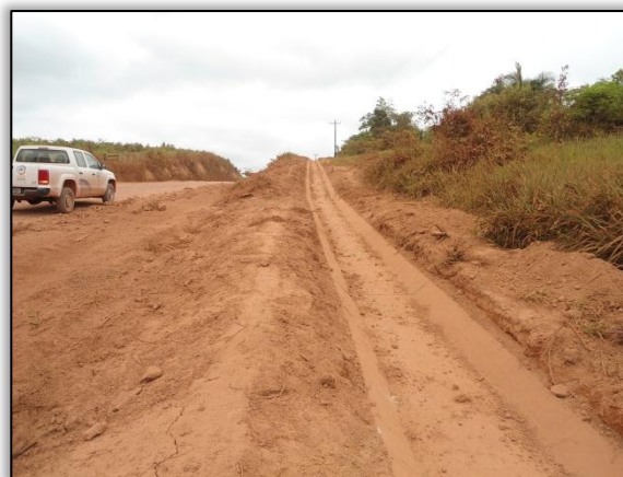
Foto 275 - Valeta de proteção de corte. Lado direito. Estaca 860 a 878. S 03.41528° W 051.26014° 07/08/2012
