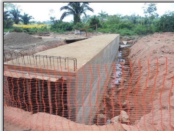
Foto 527 - Substituição de bueiro. Estaca 2122+4,00. S 03. 28419° W 051. 44317°. 17/07/2012
