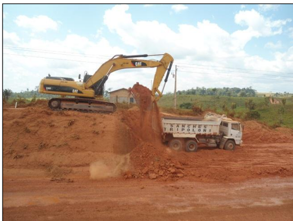
Foto 199 - Retroescavadeira realizando corte. Estaca 4996. Lado direito. S 03.94044° W 050.30848° 07/08/2012
