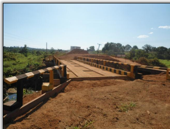
Foto 489 – Construção de uma ponte de madeira. S 03.90579° W 050.36257°. 31/072012.
