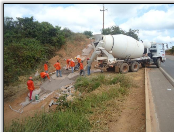
Foto 362 - (Depois) Recomposição do dispositivo de drenagem. Lado esquerdo. Estaca 08. S 03.54973° W 050.20805°. 08/08/2012
