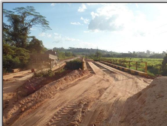
Foto 574 – Construção de uma ponte pela CCM sobre o rio Penetecal I. Lado direito. Estaca 2800. S 03.38600° W 052.68743° 06/06/2012.
