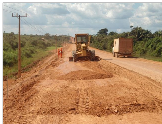
Foto 192 - Execução da regularização do subleito. Lado esquerdo. Estaca - 4448. S 04.00773° W 050.27768° 18/07/2012
