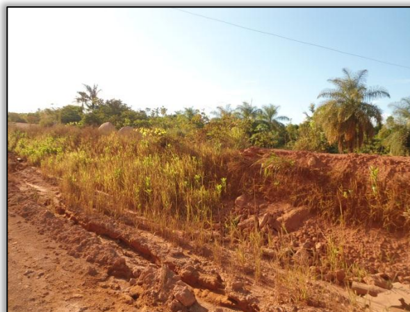
Foto 366 – Foi realizado hidrossemeadura para conter e estabilizar o processo erosivo. Lado Direito. S 03.13098º W 051.72387º. 28/06/2012.
