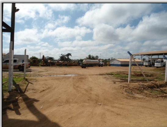
Foto 314 – Canteiro de Obra. S 03.20626° W 052.21759° 13/08/2012
