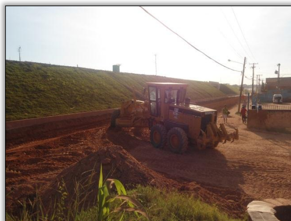
Foto 150 - Atividades de Terraplenagem. Lado esquerdo. S 05.35031° W 049.11914° 04/05/2012
