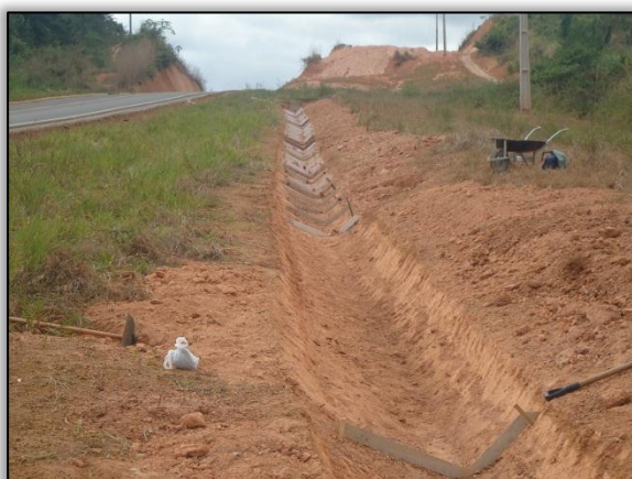
Foto 494 – Construção de um dispositivo de drenagem do tipo sarjeta. Lado esquerdo. Estaca 205. S 03.53887° W 050.22634°. 08/08/2012
