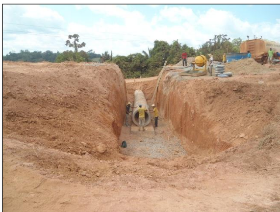
Foto 203 - Instalação de bueiro simples tubular. Estaca - 4952. S 03.94375° W 050.30177° 07/08/2012
