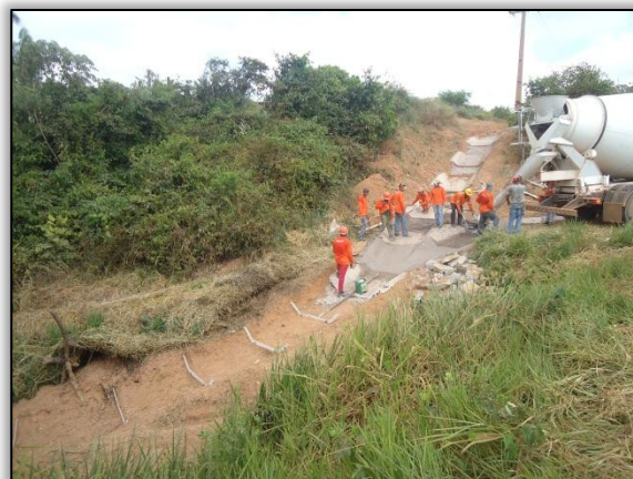
Foto 497 – (Depois) Recomposição do dispositivo de drenagem. Lado esquerdo. Estaca 08. S 03.54973° W 050.20805°. 08/08/2012
