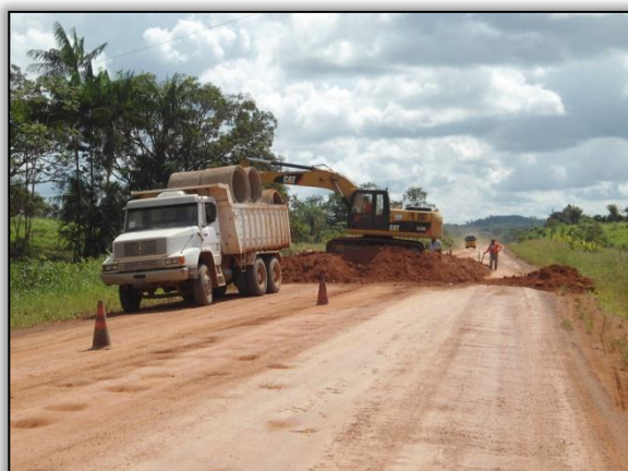
Foto 516 – Construção de um bueiro tubular simples. Lado esquerdo. Estaca 1319. S 03.36780° W 051.32667°. 18/05/2012.
