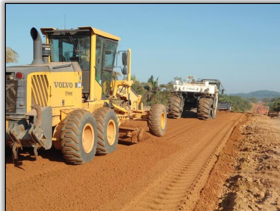
Foto 539 - Recicladora e niveladora. Estaca 1231. S 03. 37528° W 051. 31285°. 01/08/2012
