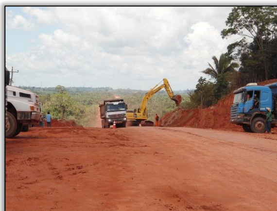
Foto 525 - Retirando material do corte para aterro, Lado esquerdo. S 03. 22643° W 051. 50595°. 17/07/2012
