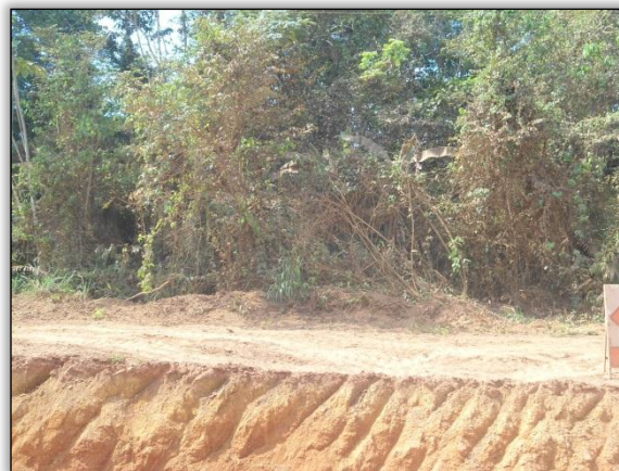
Foto 38 - Área da castanheira suprimida. Lado direito. 14/06/2012 - S 03.94481W 050.30010
