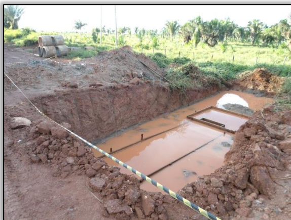
Foto 244 - Construção de bueiro, lado direito. S 03.19460° W 051.54248°. 04/06/2012.
