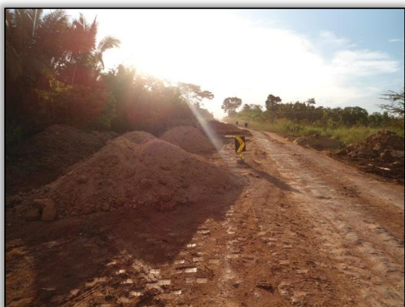
Foto 506 - Construção de bueiro de concreto tubular simples, presença de material. S 03.21997° W 051.51466. 04/06/2012.
