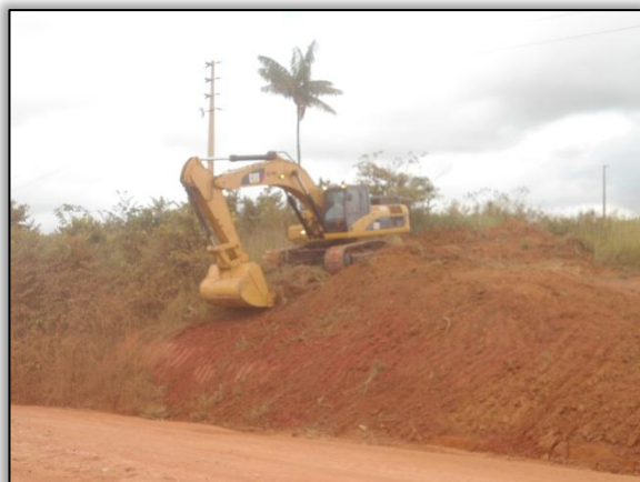
Foto 15 - Atividades de supressão vegetal em talude na estaca 4530. Lado esquerdo. S 03. 99469° W 050. 27066° 29/05/2012.
