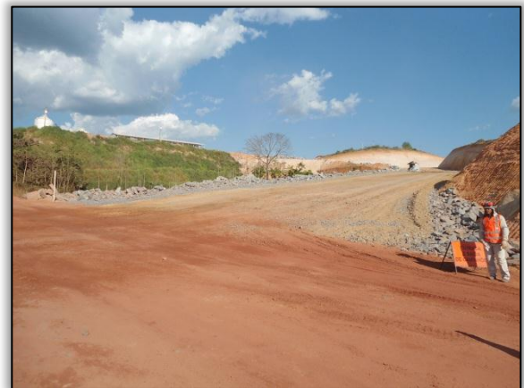
Foto 12 - Acesso para o Canteiro de Belo Monte. Lado Esquerdo. S 03.12574° W 051.77224° 30/07/2012.
