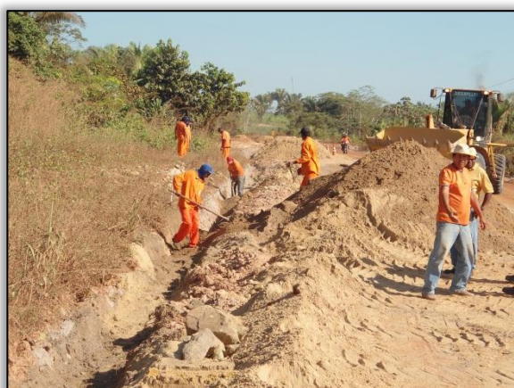
Foto 534 - Construção de dreno Profundo, Lado esquerdo. Estaca 1684 ate 1702. S 03. 32384° W 051. 37743°. 01/08/2012
