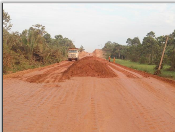
Foto 303 - Preparação para subleito. Estaca 2323. S 03.25790° W 051.46801° 08/08/2012
