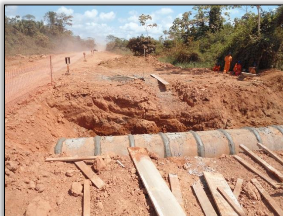
Foto 271 - Bueiro simples tubular de concreto (BSTC). Estaca 3492+16. S 03. 11448° W 051.62073° 31/07/2012
