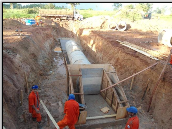
Foto 514 – Construção de um bueiro tubular simples. Lado esquerdo/direito. Estaca 724. S 03.19019° W 052.19188°. 16/05/2012.
