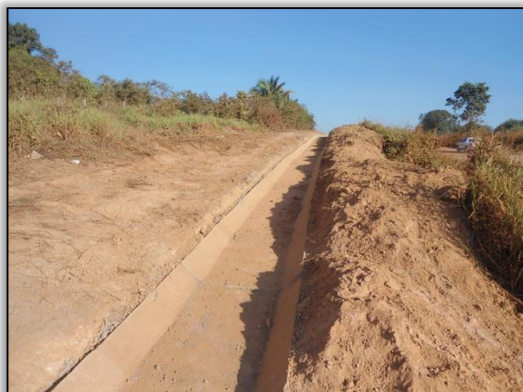
Foto 532 - Construção de valeta de Proteção, Lado esquerdo. Estaca 936. S 03. 40794° W 051. 27147°. 01/08/2012
