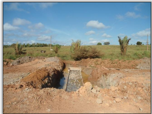
Foto 186 - Implantação de bueiro na estaca 4850. S 03.95074° W 050.28477° 04/07/2012
