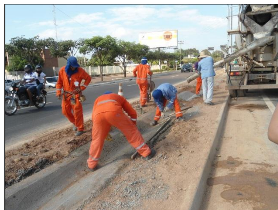
Foto 178 - Atividades do tipo sarjeta no eixo da rodovia. S 05.35862° W 049.12273° 05/07/2012
