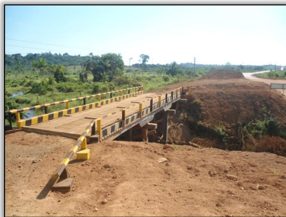
Foto 229 – Construção de uma ponte de madeira. S 03.90579° W 050.36257° 31/07/2012
