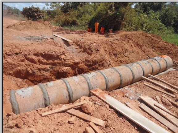
Foto 538 - Bueiro Simples Tubular de Concreto (BSTC). Estaca 3492+16. S 03. 11448° W 051.62073°. 31/07/2012
