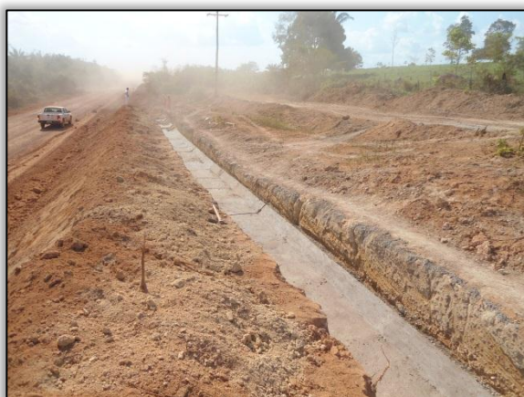
Foto 263 - Construção de valeta de proteção. Lado direito. Estaca 707 até 715. S 03.43180° W 051.23972° 31/07/2012
