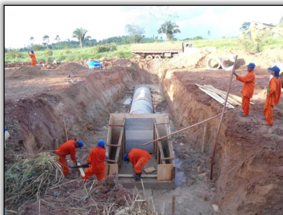
Foto 238 – Construção de um bueiro tubular simples. Estaca 724. S 03.19019° W 052.19188° 16/05/2012.
