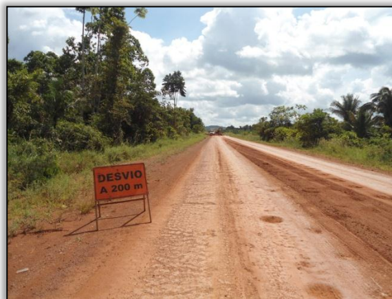
Foto 499 – Sinalização vertical temporária, indicando um desvio devido a construção de um bueiro. Lado esquerdo. Estaca 1319. S 03.36780° W 051.32667°. 18/05/2012.
