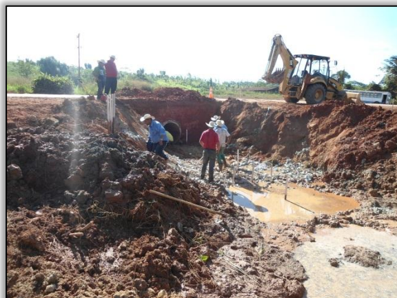
Foto 179 - Prolongamento de bueiro estaca 4262. LD. S 04.03774° W 050. 29283° 31/05/2012
