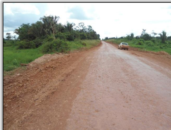
Foto 241 – (Depois). Obra concluída pela CCM. Estaca 2214. S 03.19805° W 051.53867. 18/05/2012.
