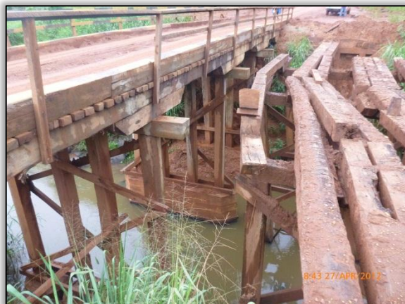
Foto 466 – Ponto 50 – Ponte nova e antiga sobre o Igarapé Capará. S 3.411988° W 52.777656°
