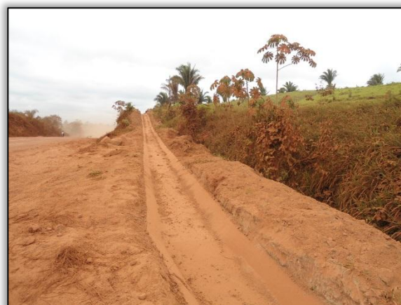
Foto 273 - Valeta de proteção de corte. Lado direito. Estaca 758 a 770. S03. 42655° W051. 24513° 07/08/2012
