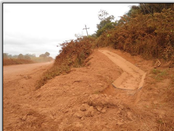
Foto 274 - Valeta de proteção de corte. Lado direito. Estaca 814 a 820. S 03.41975° W 051.25304° 07/08/2012
