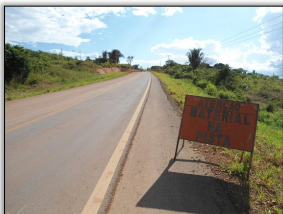
Foto 221 – Sinalização vertical temporária do trecho em obra. Lado direito. S 03.85349° W 050.46634° 27/06/2012.
