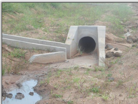
Foto 317 - Bueiro desassoreado. Lado direito. S 05.34983° W 049.11438° 03/05/2012
