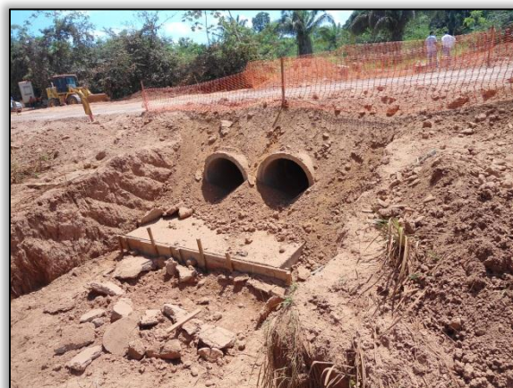
Foto 537 - Bueiro Duplo Tubular de Concreto (BDTC), Estaca: 3462+16. S03. 11676° W051. 61563°. 31/07/2012
