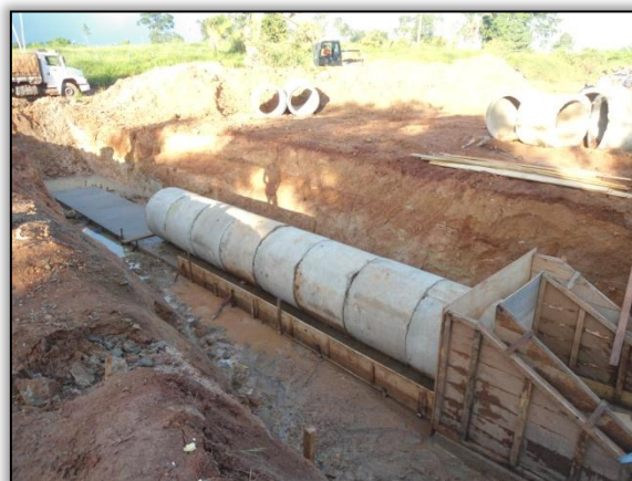
Foto 513 – Construção de um bueiro tubular simples. Lado esquerdo/direito. Estaca 724. S 03.19019° W 052.19188°. 16/05/2012.
