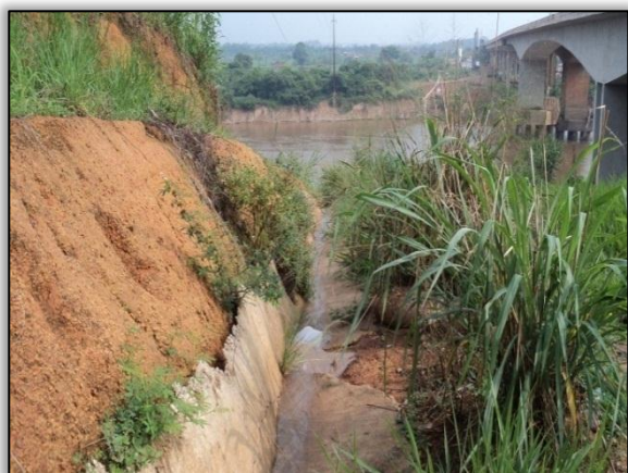
Foto 389 - Rede de drenagem pluvial. 5.357422° S 49.121869° W
