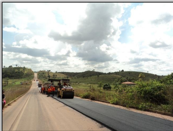
Foto 235 – Recapeamento. Lado direito. S 03.50405° W 050.35286° 08/08/2012
