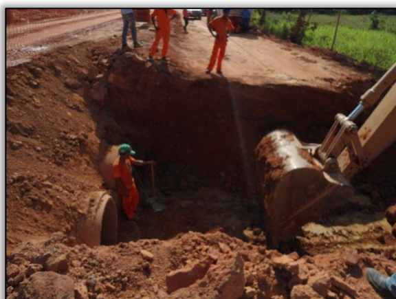
Foto 558 - Bueiro duplo tubular de concreto. Lado direito. Estaca 3545. S 03.11070° W 051.62909°. 06/08/2012
