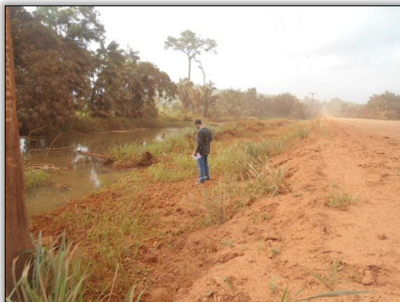
Foto 343 - Vegetação suprimida depositada em leito de córrego. Lado esquerdo em 20/12/2011. S 04.02807° W 050.28773°
