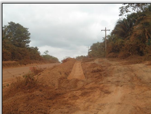
Foto 554 - Valeta de proteção de corte. Lado direito. Estaca 1132+10 a 1154. S 03.38658° W 051.29927°. 07/08/2012
