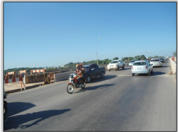
Foto 160 - Rodovia Pavimentada com 12 cm de CBUQ. S 05.34968° W 049. 12185°. 06/06/2012.
