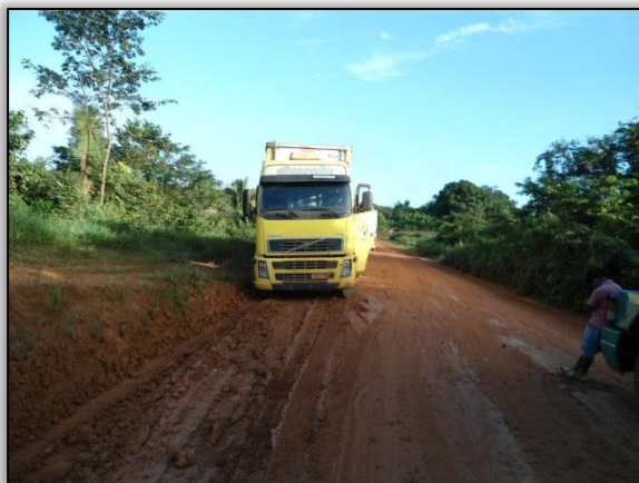
Foto 213 – Área sensível de atoleiro, caminhão deslizou na pista. Lado esquerdo. S 03.59355° W 051.05624° 05/06/2012.
