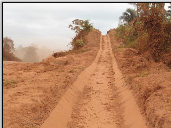
Foto 550 - Valeta de proteção de corte. Lado Direito. Estaca 758 a 770. S03. 42655° W051. 24513°. 07/08/2012
