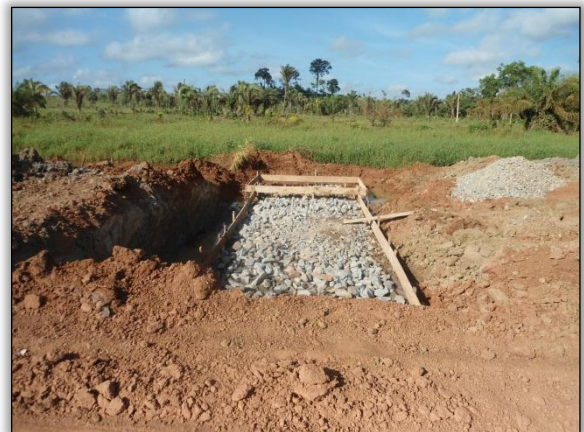
Foto 188 - Substituição de bueiro na estaca 4893. S 03.94729° W 050.29176° 04/07/2012
