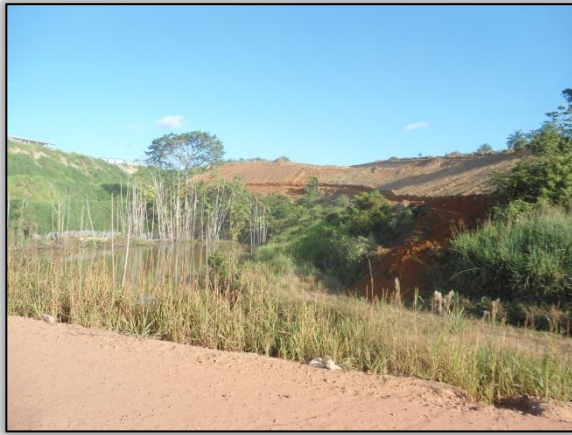
Foto 9– Canal escoamento para drenagem. Lado esquerdo. S 03. 125600° W 051. 775636° 20/06/2012
