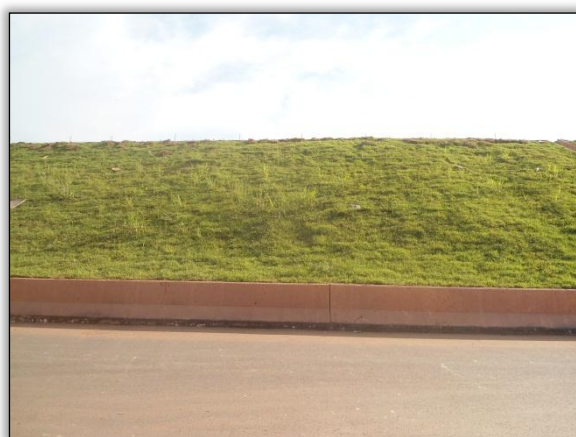
Foto 321 - Talude em processo de recuperação. Lado direito. S 05.35017° W 049.11828° 09/05/2012.
