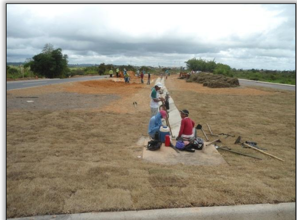
Foto 472 - Limpeza no canteiro central e revestimento de gramíneas. S 05.35818° W 049.12263° 05/07/2012
