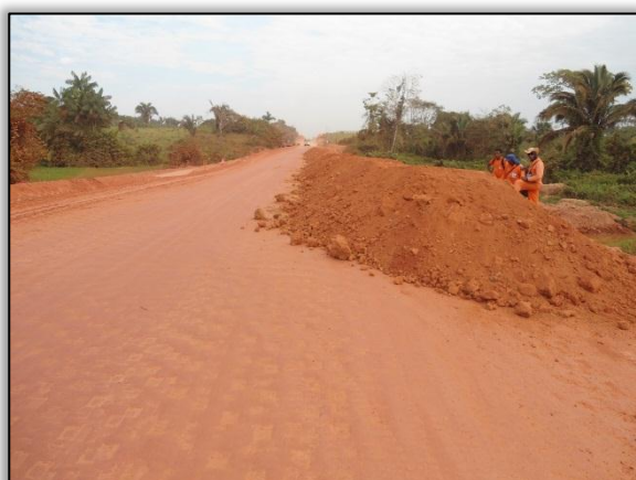
Foto 566 - Ultima camada de aterro. Estaca 2124. S 03.28365° W 051.44292° . 08/08/2012
