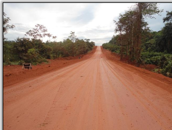
Foto 73 – Supressão vegetal ao longo da faixa de domínio. Lado direito e esquerdo. Estaca 1983. S 03.30045° W 051. 42433° 05/07/2012
