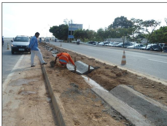
Foto 177 - Atividades do tipo sarjeta no eixo da rodovia. S 05.35869° W 049.12271° 05/07/2012
