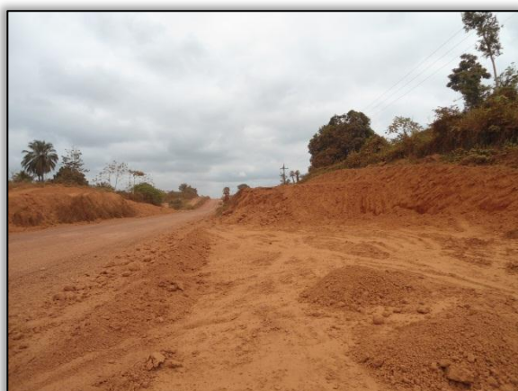
Foto 564 - Corte e Empréstimo. Lado esquerdo. Estaca 1875 a 1915. S 03.31043° W 051.40954° . 08/08/2012
