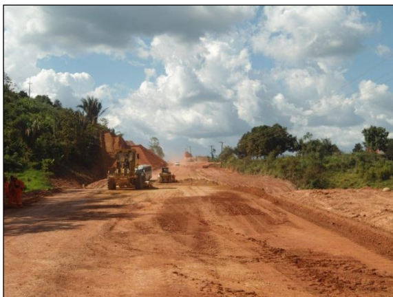
Foto 193 - Procedimento de aterro. Estaca - 4592. S 03.98498° W 050.26575° 18/07/2012
