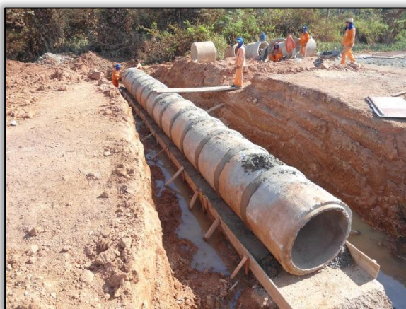
Foto 284 - Bueiro simples tubular de concreto. Estaca 3565. S 03.10929° W 051.63231° 06/08/2012
