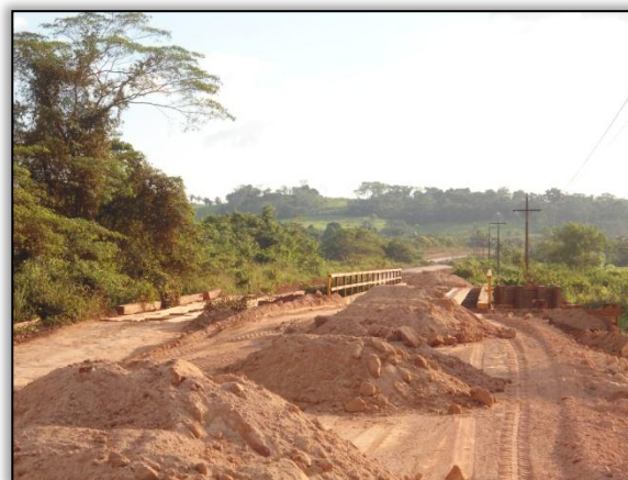
Foto 573 - Construção de uma ponte pela CCM sobre o rio Penetecal I. Lado direito. Estaca 2800. S 03.38600° W 052.68743° 06/06/2012.
