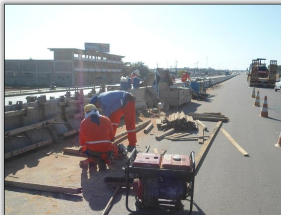
Foto 164 - Serviço de construção da barreira New Jersey no eixo da rodovia. S 05.35059° W 049. 11973°. 06/06/2012.
