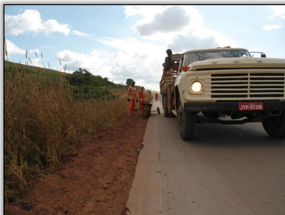
Foto 252 – Construção de meio fio, lado esquerdo. S 03. 12514° W 051. 78182° 28/06/2012.
