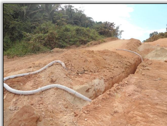
Foto 555 - Dreno longitudinal profundo. Lado direito. Estaca 1981. S 03.30014° W 051.42395°. 08/08/2012
