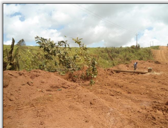
Foto 36 - Corte de castanheira na estaca 4954 LE. 14/06/2012 - S 03.94388 W 050.30244
