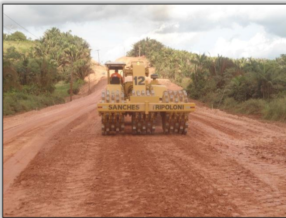
Foto 185 - Atividades de compactação do solo. Lado direito. S 04.03731° W 050.29250° 02/07/2012
