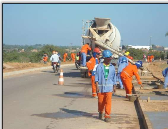
Foto 166 - Colaboradores executando atividades de meio-fio na marginal. Lado direito. S 05.34994° W 049. 12049°. 06/06/2012.
