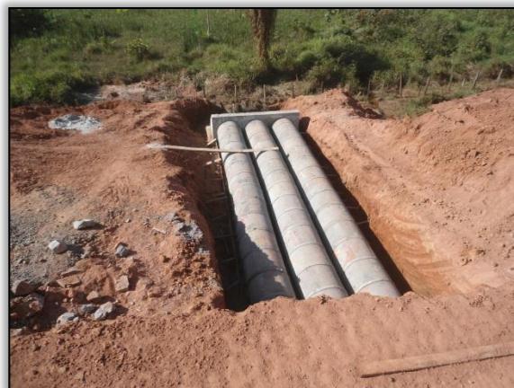
Foto 491 - Construção de um bueiro tubular triplo. Lado direito. Estaca 1109. S 03.84663 W 050.52212. 31/07/2012.
