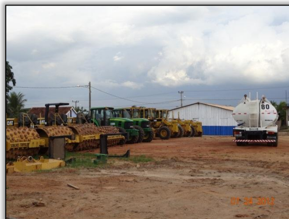
Foto 5 - Canteiro de obras da Sanches Tripoloni - Lote Altamira - Medicilândia. S 3.308983° W 52.536569° 24/07/2012
