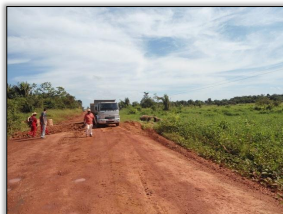
Foto 519 – (Antes) CCM retirando um bueiro celular simples que se encontrava obstruído. Estaca 2214. S 03.19805° W 051.53867. 09/05/2012.
