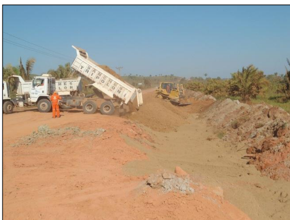
Foto 201 - Reconformação da pista. Lado direito. S 03.95049° W 050.28505° 31/07/2012
