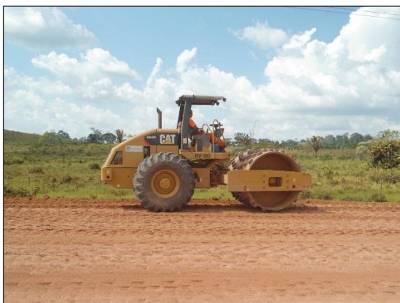
Foto 197 - Compactação do solo. Lado direito. S 03.95042° W 050.28539° 07/08/2012
