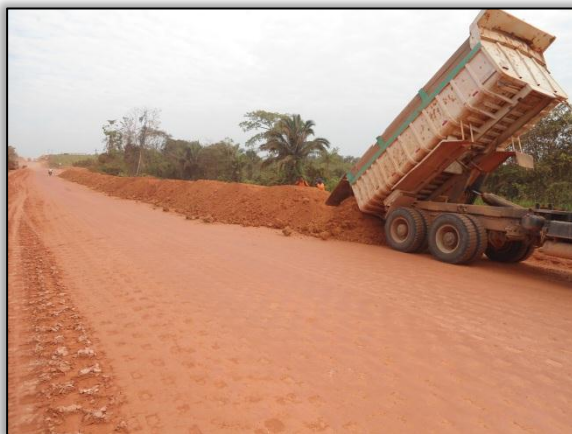
Foto 301 - Última camada de aterro. Estaca 2124. S 03.28365° W 051.44292° 08/08/2012
