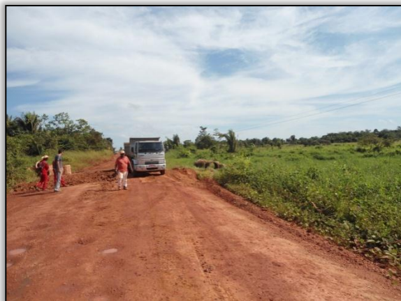
Foto 240 – (Antes) CCM retirando um bueiro celular simples que se encontrava obstruído. Estaca 2214. S 03.19805° W 051.53867. 18/05/2012.
