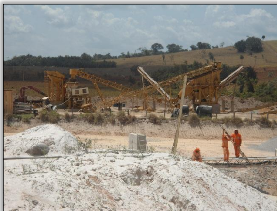
Foto 209 - Visão ampla do britador. S 04.16450° W 050.17685° 14/08/2012
