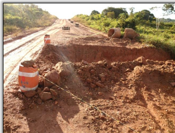
Foto 243 – Construção de bueiro, lado direito. S 03.18911° W 051.54747°. 04/06/2012.
