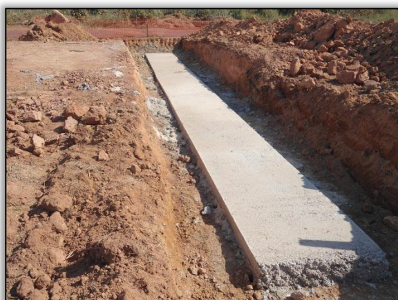
Foto 560 - Base de concreto para bueiro simples tubular de concreto. Estaca 3575. S 03.10868° W 051.63405°. 06/08/2012
