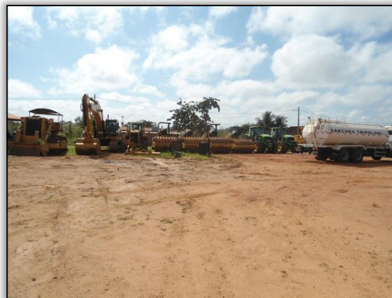
Foto 313 – Máquinas no pátio. S 03.20626° W 052.21759° 13/08/2012
