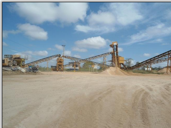
Foto 172 - Visão ampla do britador. S 05.36738° W 049.05880° 17/05/2012
