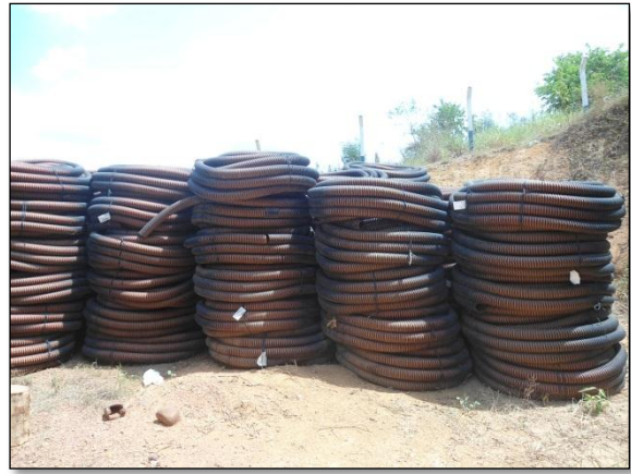
Foto 206 - Acondicionamento adequado de material de drenagem profunda. S 04.23835° W 049.95459° 14/08/2012
