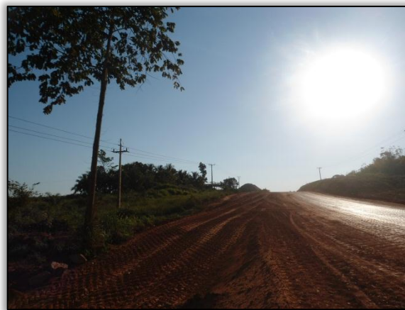
Foto 65 – Área de supressão vegetal ao longo da faixa de domínio. Lado esquerdo. Estaca 1293. S 03.84692º W 050.55413º 31/07/2012.
