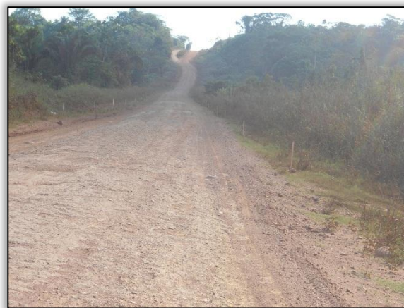
Foto 311 – Trecho com Estacas. S 03.43991° W 052.83541° 13/08/2012
