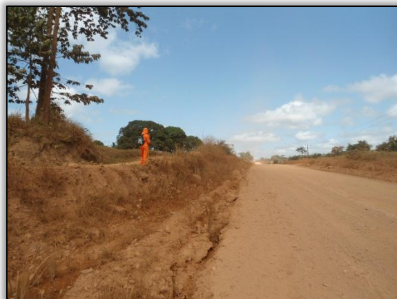
Foto 586 – Medição de topografia. Lado esquerdo S 03.34228° W 052.59820° 27/07/2012
