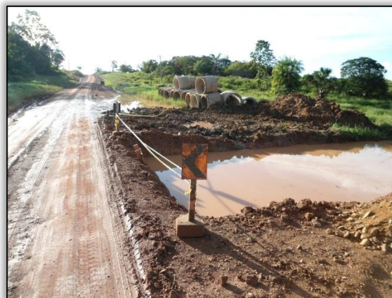
Foto 245 - Construção de bueiro, lado direito. S 03.19639° W 051.54084°. 04/06/2012.
