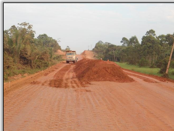
Foto 569 - Preparação para subleito. Estaca 2323. S 03.25790° W 051.46801°. 08/08/2012
