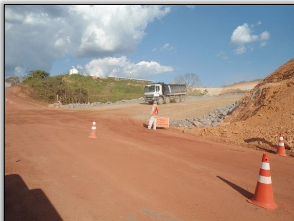
Foto 544 – Novo acesso ao canteiro de belo monte. Lado esquerdo. S 03.12574° W 051.77224° . 30/07/2012
