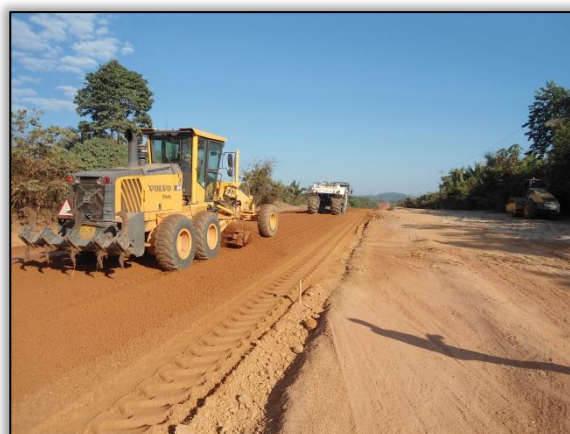
Foto 289 - Recicladora e Niveladora. Estaca 1231. S 03. 37528° W 051. 31285° 01/08/2012
