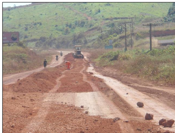
Foto 194 - Terraplenagem no trecho urbano do município de Novo Repartimento. Lado direito. S 04.00323° W 050.27526° 31/07/2012
