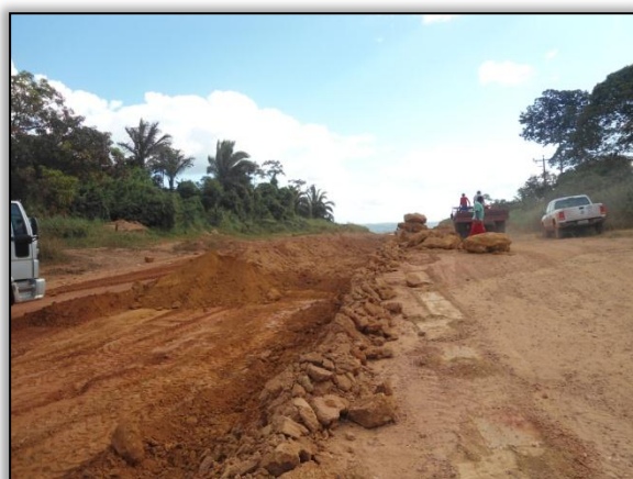
Foto 576 - Serviço de manutenção da rodovia pela CCM. Estaca 2530. S 03.36653° W 052.64393° 06/06/2012.
