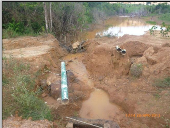
Foto 396 – Turbidez da água devido a fortes chuvas e erosão nas margens (Ponto 42). 3.096142° S 51.850755° W
