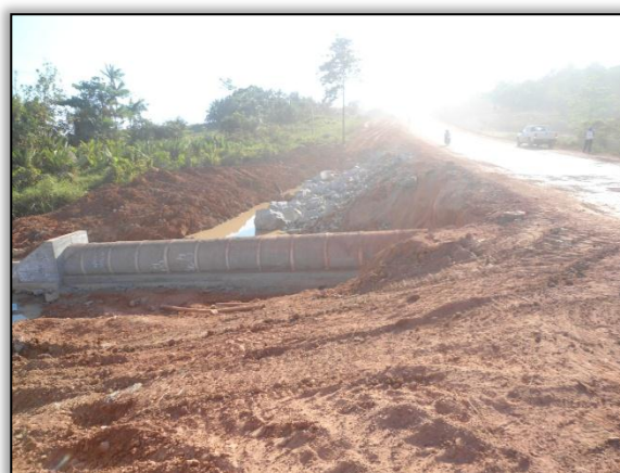
Foto 493 - Construção de um bueiro tubular simples. Lado esquerdo. Estaca 1289. S 03.84696 W 050.15535. 31/07/2012
