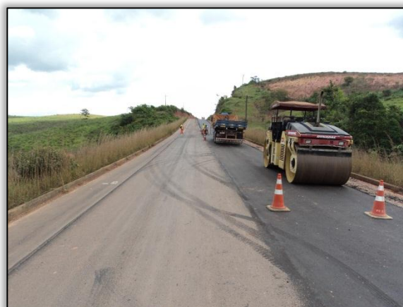
Foto 495 – Recapeamento dos 10 km de massa asfáltica, próximo a cidade de Pacajá. Lado direito. S 03.50405° W 050.35286°. 08/08/2012
