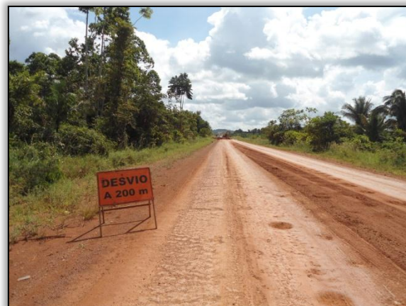
Foto 515 – Sinalização vertical temporária, indicando um desvio devido a construção de um bueiro. Lado esquerdo. Estaca 1319. S 03.36780° W 051.32667°. 18/05/2012.
