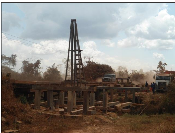
Foto 204 - Construção da ponte sobre o rio Traíra. S 04.10580° W 050.27393° 14/08/2012
