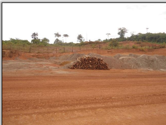
Foto 70 – Material enleirado na faixa de domínio. Lado esquerdo. S 03.35355° W 051. 34491° 05/07/2012
