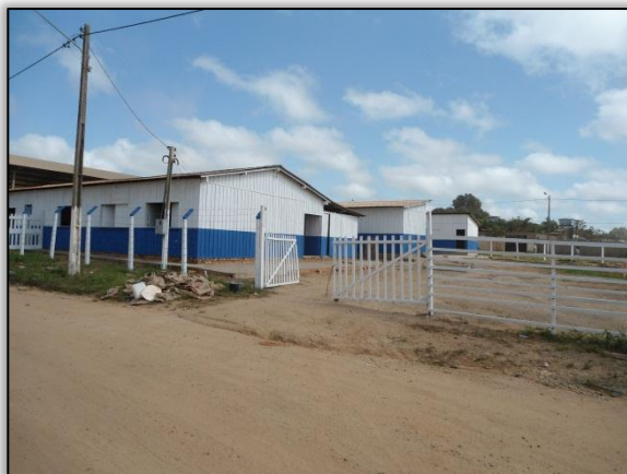
Foto 312 – Dormitório e refeitório. S 03.20626° W 052.21759° 13/08/2012
