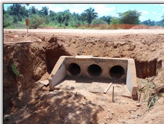
Foto 535 - Bueiro Triplo Tubular de Concreto (BTTC), Estaca 3368+18. S 03.12525° W 051. 60105°. 31/07/2012
