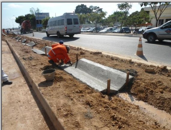
Foto 471 - Serviço de instalação de sarjeta. S 05.35869° W 049.12271° 05/07/2012
