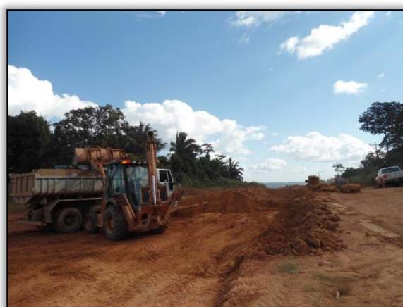
Foto 577 - Serviço de manutenção da rodovia pela CCM. Estaca 2530. S 03.36653° W 052.64393° 06/06/2012.
