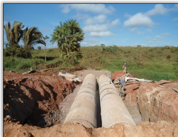
Foto 190 - Substituição de bueiro duplo na estaca 4807. S 03.95536° W 050.27856° 04/07/2012
