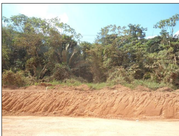
Foto 39 - Área da castanheira suprimida. Lado direito. 18/06/2012 - S 03.94482W 050.30010
