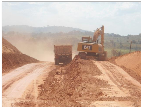
Foto 200 - Atividade de corte. Lado direito. S 03.95942° W 050.27501° 07/08/2012
