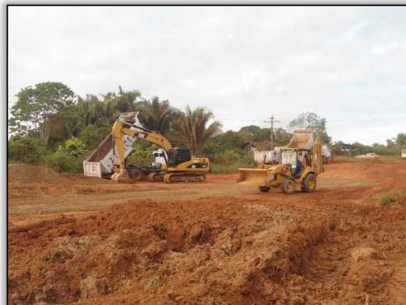
Foto 474 - Maquinário realizando corte para instalação de bueiros. S 04.02491° W 050. 28645° 29/05/2012
