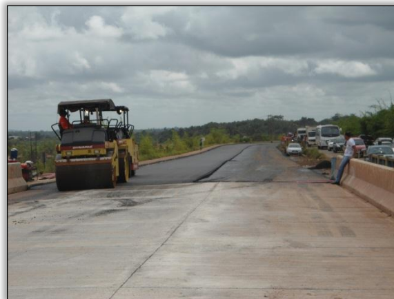
Foto 146 - Compactação da rodovia. S 05.35376° W 049.12149° 17/05/2012
