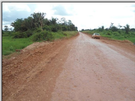
Foto 520 – (Depois). Obra concluída pela CCM. Estaca 2214. S 03.19805° W 051.53867. 18/05/2012.
