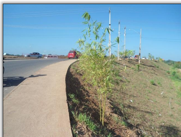
Foto 319 - Vista parcial gabião com proteção de bambus. S 05.34957° W 049.12169° 06/06/2012.
