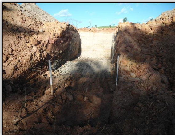
Foto 336 - Corte para instalação de bueiro. Lado esquerdo. S 04.01481° W 050.28121° 05/06/2012
