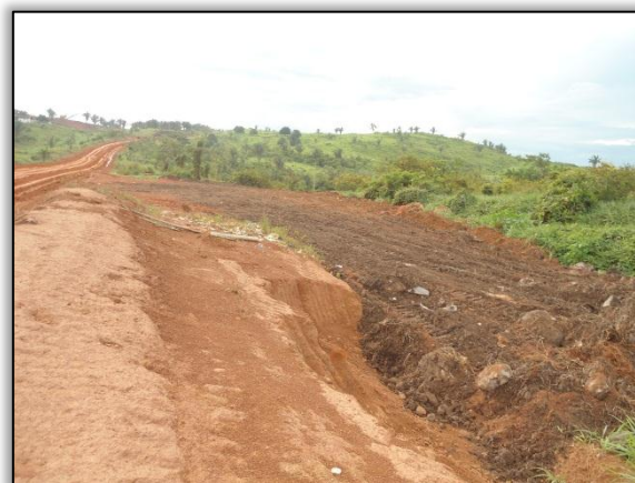
Foto 67 – Material orgânico oriundo da supressão vegetal no bota espera. Lado direito. Estaca 566.
