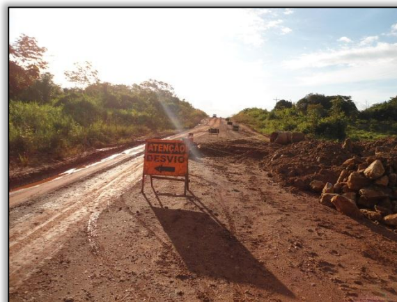
Foto 501 – Construção de bueiro, lado direito. S 03.18911° W 051.54747°. 04/06/2012.
