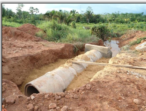
Foto 250 – Construção de bueiro tubular simples. Estaca 2616. S 03.22417° W 051.50886°. 04/06/2012.
