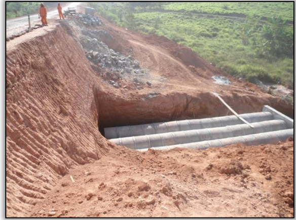
Foto 232- Construção de um bueiro tubular triplo. Lado direito. Estaca 1109. S 03.84663 W 050.52212 31/07/2012
