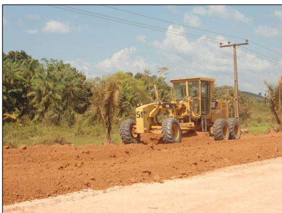
Foto 195 - Serviço de terraplenagem. Lado direito. S 03.95073° W 050.28498° 07/08/2012
