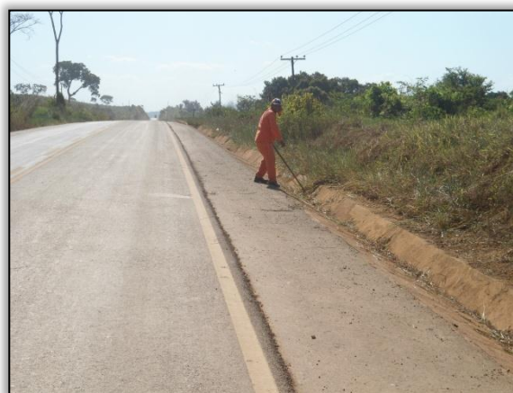
Foto 228 – Colaborador realizando a limpeza da sarjeta as margens da rodovia. Lado direito. S 03.91576° W 050.34739° 31/07/2012
