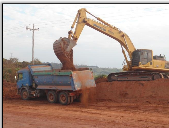
Foto 570 - Rebaixo e corte. Lado direito. Estaca 2599. S 03.22550° W 051.50637°. 08/08/2012
