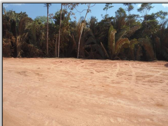
Foto 542 - Área de bota-fora. Lado esquerdo. Estaca: 1541. S 03. 34178° W 051. 35818°. 31/07/2012
