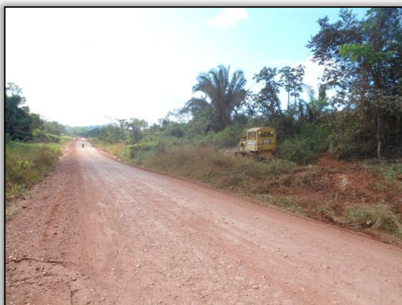
Foto 74 – Supressão vegetal ao longo da faixa de domínio. Lado direito. Estaca 2673. S 03.21799° W 051.51712° 05/07/2012.
