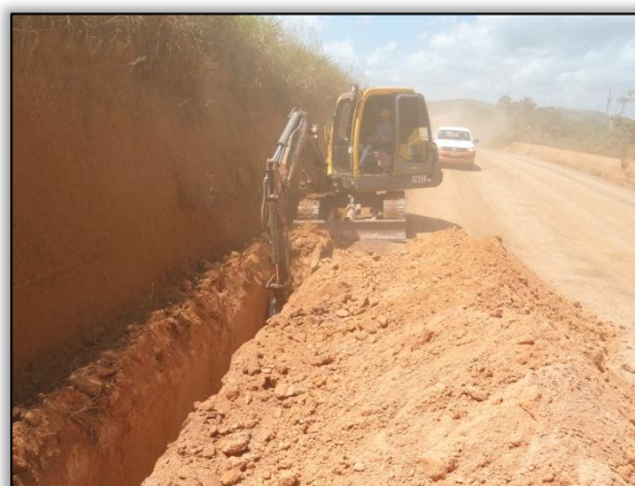
Foto 251 – Dreno profundo, lado direito. S 03.31982° W 051.38707°. 06/06/2012.
