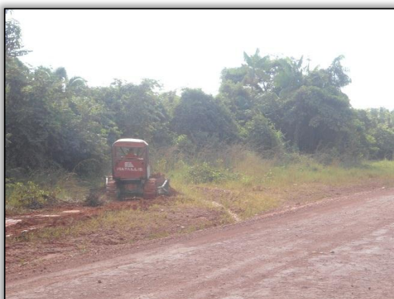
Foto 76 – Maquinário realizando supressão vegetal. Lado esquerdo. S 03.16521° W 051.56519° 05/07/2012.
