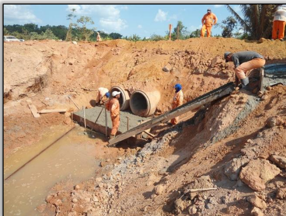
Foto 265 - Construção de bueiro duplo tubular de concreto (BDTC). Estaca 1207. S 03.37735° W 051. 30928° 31/07/2012
