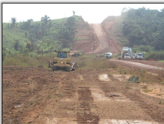
Foto 475 - Reconformação da caixa de empréstimo. S 04.02491° W 050. 28645° 29/05/2012
