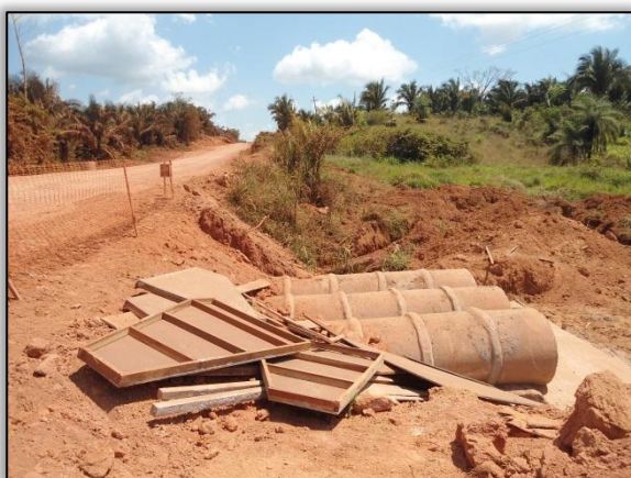
Foto 267 - Bueiro triplo tubular de concreto (BTTTC). Estaca 3368+18. S 03.12525° W 051. 60105° 31/07/2012
