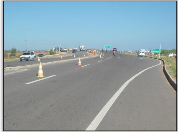
Foto 158 - Sinalização horizontal. Lado direito. 06/06/2012. S 05.35003° W 049. 11798°
