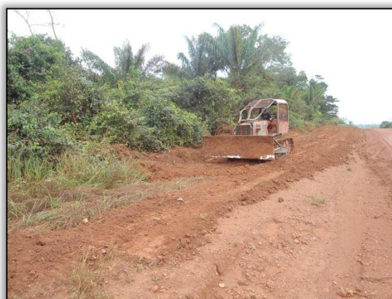
Foto 77 – Supressão vegetal ao longo da faixa de domínio. Lado esquerdo. Estaca 3246 S 03.14137° W 051. 58572° 11/07/2012
