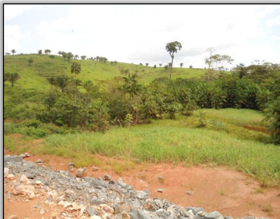
Foto 359 - Área alagada com material avançando para APP. S 03.70309° W 050. 91462° 13/02/2012
