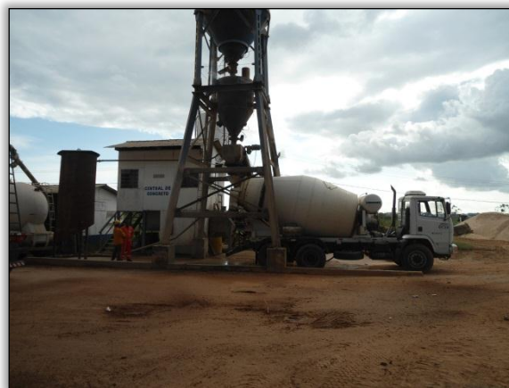
Foto 171 - Fabricação de concreto. S 05.35446° W 049.12172° 17/05/2012
