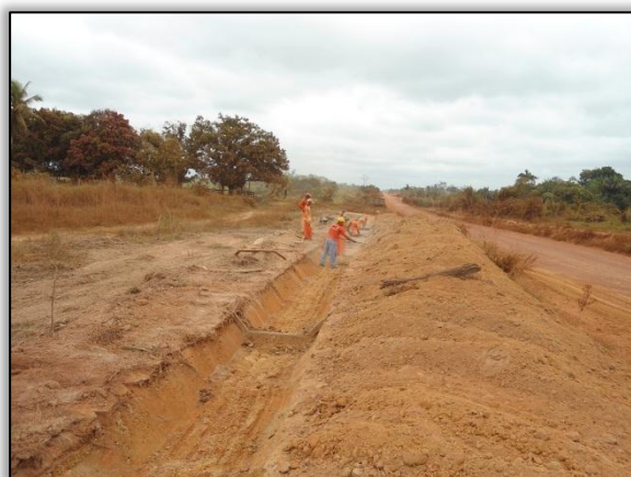
Foto 272 - Valeta de proteção de corte. Lado Esquerdo. estaca 652 a 664+10. S 03. 43869° W 051. 23250° 07/08/2012
