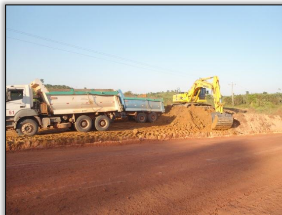
Foto 293 - Retirada de material, Lado direito. Estaca 1875. S 03. 31149° W 051.40791° 01/08/2012
