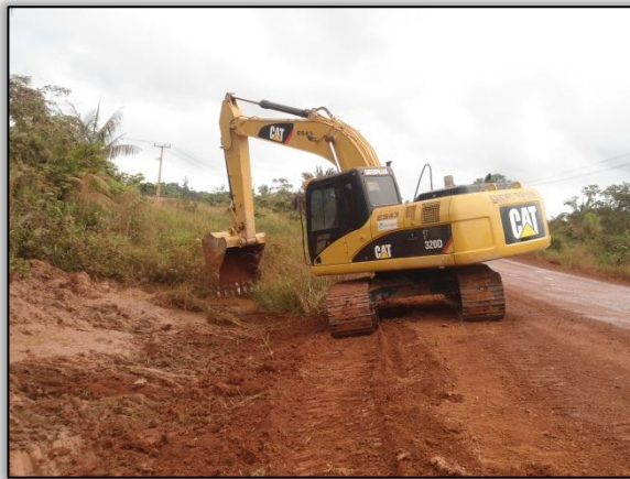
Foto 19 - Atividades de supressão vegetal na estaca 4259. Lado esquerdo. S 04.03839° W 050. 29320° 30/05/2012
