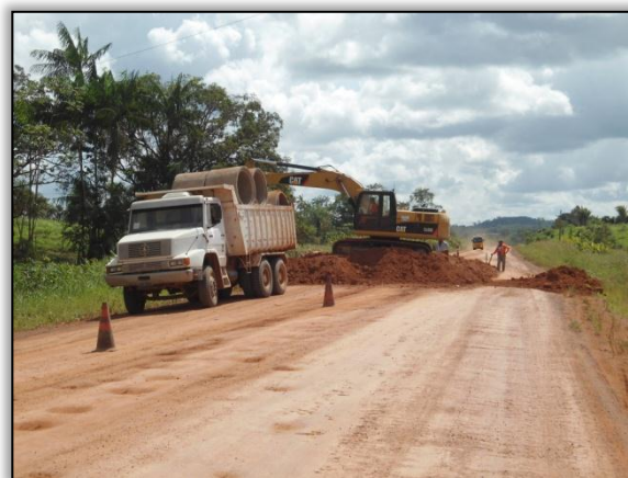
Foto 239 – Construção de um bueiro tubular simples. Lado esquerdo. Estaca 1319 S 03.36780° W 051.32667° 18/05/2012.
