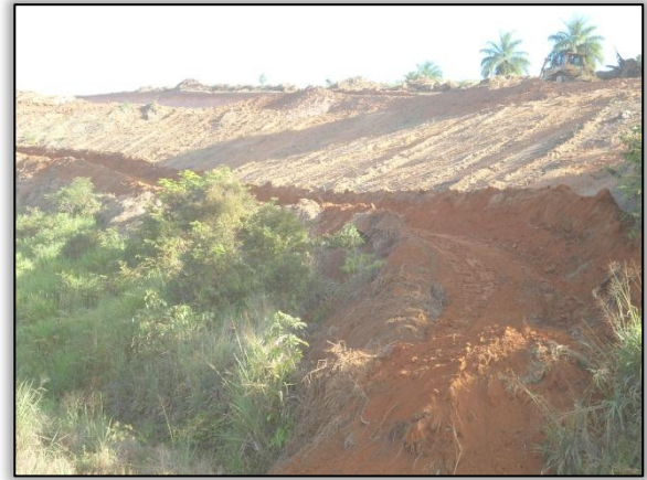
Foto 10 – Vista do canal. Lado esquerdo S 03. 125600° W 051. 775636° 20/06/2012
