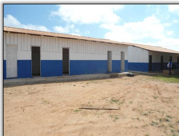
Foto 585 – Canteiro de obra. S 03.20626° W 052.21759° 13/08/2012
