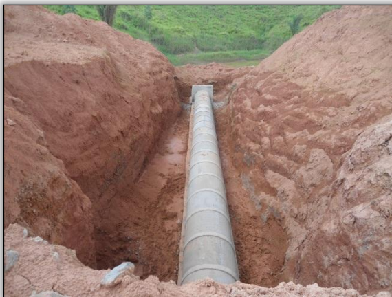
Foto 187 - Substituição de bueiro na estaca 4570. S 03.99269° W 050.26985° 02/07/2012
