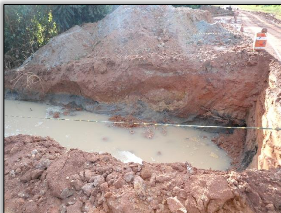
Foto 242 – Construção de bueiro, lado esquerdo. S 03.18088° W 051.55482°. 04/06/2012.
