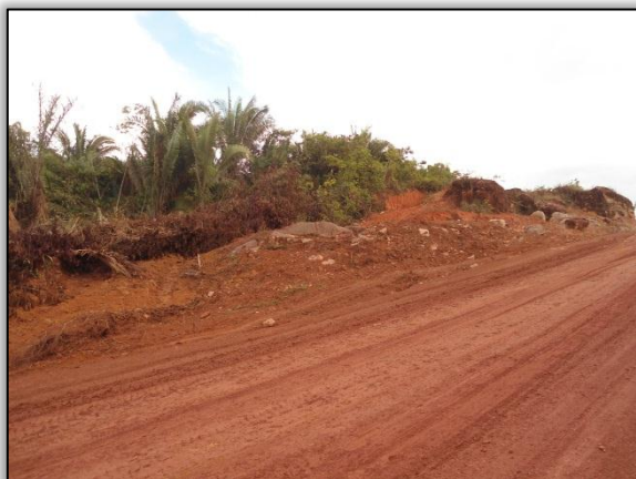
Foto 72 - Supressão vegetal ao longo da faixa de domínio. Lado esquerdo. S 03.34338° W 051.35686° 05/07/2012.
