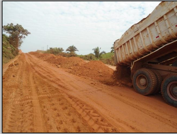
Foto 298 - Complementação de subleito. Estaca 1797. S 03.31653° W 051.39486° 08/08/2012
