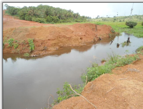
Foto 342 - Assoreamento recuperado. S 04.00426° W 050.27592° 04/07/12
