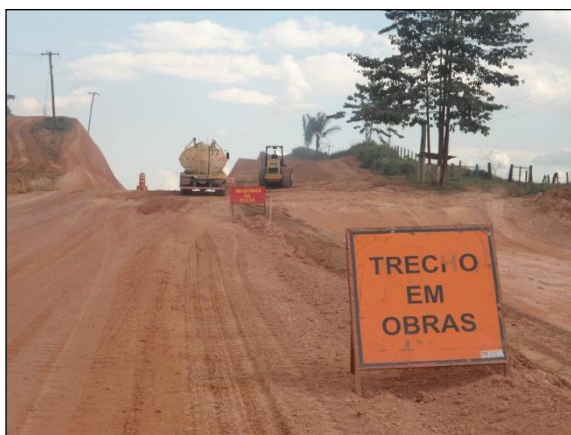
Foto 191 - Sinalização na rodovia. S 04.02037° W 050.28405° 18/07/2012
