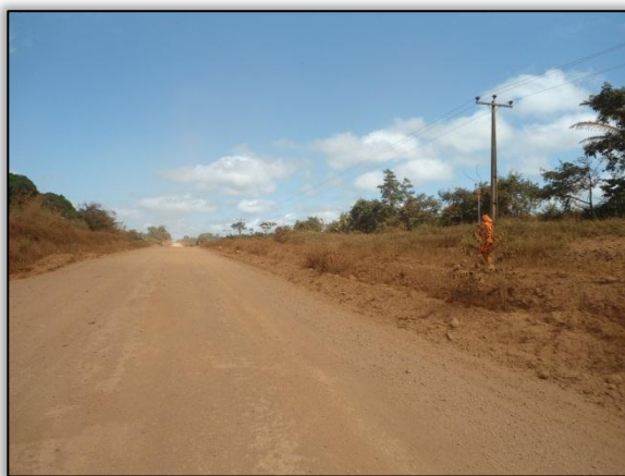
Foto 310 – Medição de topografia. Lado direito. S 03.34228° W 052.59820° 27/07/2012
