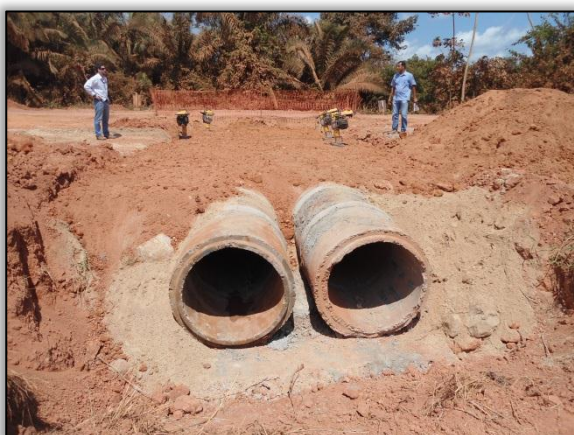
Foto 269 - Bueiro duplo tubular de concreto (BDTC). Estaca: 3462+16. S 03. 11676° W 051. 61563° 31/07/2012
