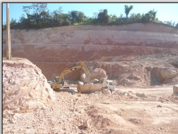
Foto 490 – Conformação do talude de corte. Lado esquerdo. Estaca 1066. S 03.84721° W 050.51476°. 31/07/2012.
