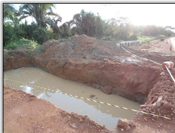
Foto 249 – Construção de bueiro. Estaca 2648. S 03.22087° W 051.51339°. 04/06/2012.
