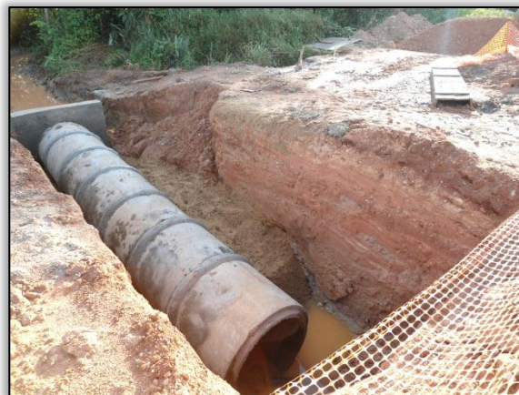
Foto 247 - Construção de bueiro de concreto tubular simples, lado esquerdo. S 03.20085° W 051.53682°. 04/06/2012.
