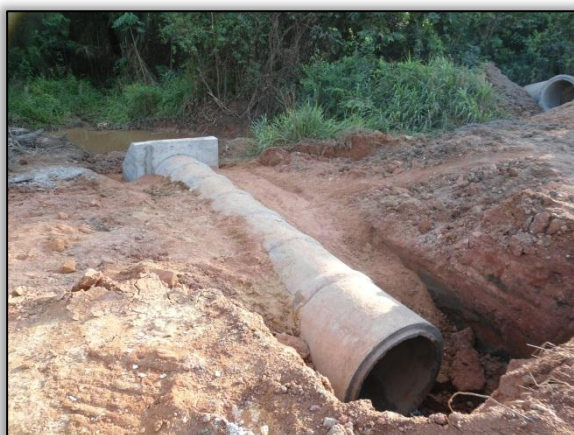
Foto 248 - Construção de bueiro de concreto tubular simples com estrutura já montada. S 03.21997° W 051.51466°. 04/06/2012.
