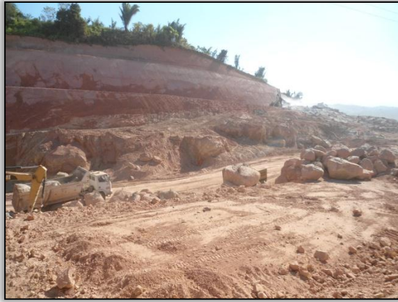
Foto 231 – Conformação do talude de corte. Lado esquerdo. Estaca 1066. S 03.84721° W 050.51476° 31/07/2012
