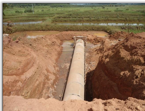
Foto 478 - Substituição de bueiro na estaca 4570. S 03.99269° W 050.26985° 02/07/2012
