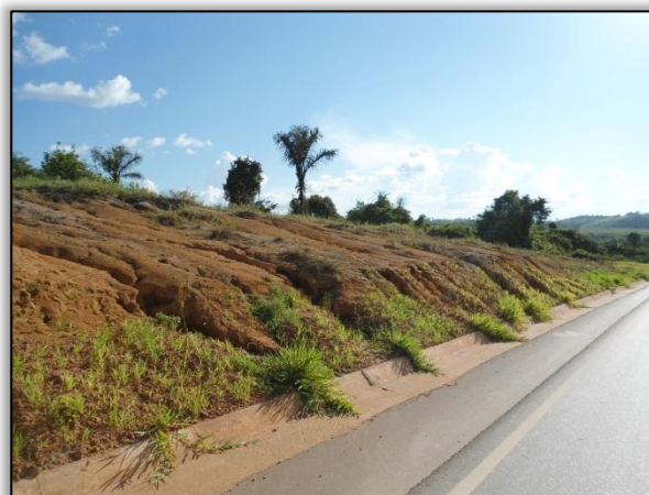
Foto 368 – Realizado hidrossemeadura para conter o processo erosivo. Estaca 4840. Lado Esquerdo.
