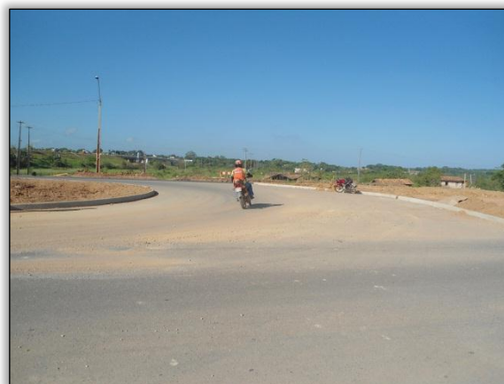
Foto 156 – (Depois) Desvio de acesso à ponte sobre o rio Itacaiúnas pavimentado. S 05.34976° W 049. 11985° 06/06/2012.
