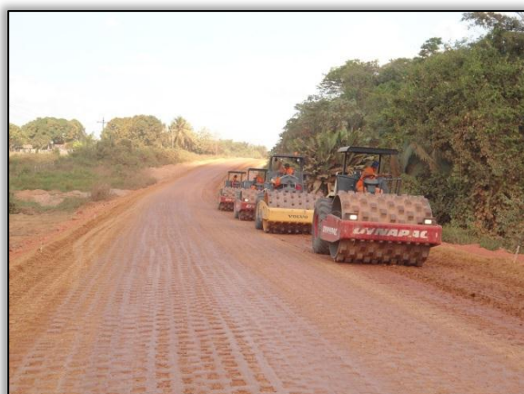
Foto 288 – Atividades de terraplenagem. Estaca 1180. S 03. 37980° W051. 30574° 31/07/2012
