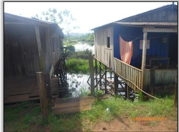
Foto 397 – Água com grande carga de poluição devido às casas de Palafitas (Ponto 45). 3.194507° S 52.195891° W
