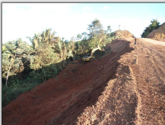
Foto 334 - Atividade de supressão vegetal em saia de aterro. Lado direito. S 03.97944º W 050.26178º 05/06/2012
