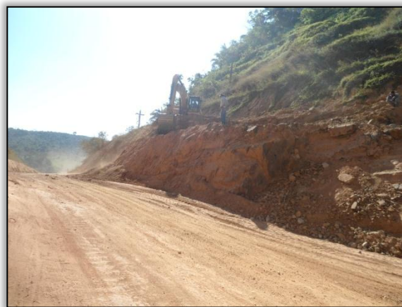
Foto 230 – Maquinário realizando limpeza do talude. Lado direito. Estaca 907. S 03.85369° W 050.49020° 31/07/2012
