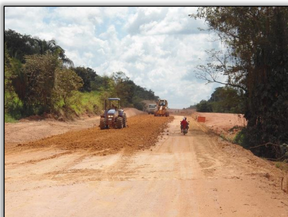
Foto 524 - Terraplanagem. S 03. 29328° W 051. 43354°. 17/07/2012
