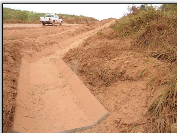
Foto 552 - Valeta de proteção de corte. Lado direito. Estaca 860 a 878. S 03.41528° W 051.26014°. 07/08/2012
