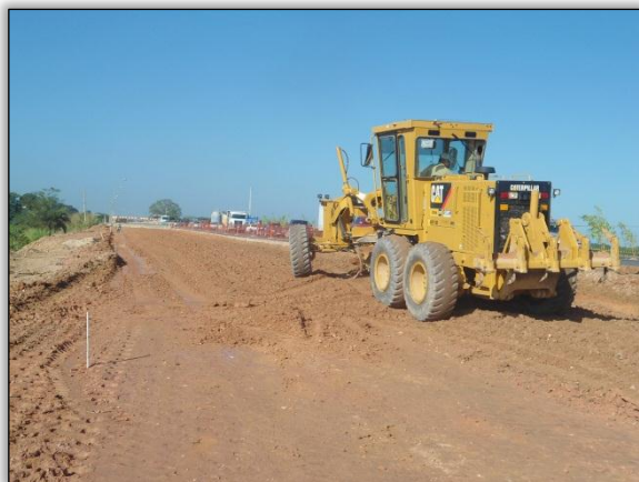
Foto 163 - Atividades de terraplenagem. Lado esquerdo. S 05.35370° W 049. 12139°. 06/06/2012.
