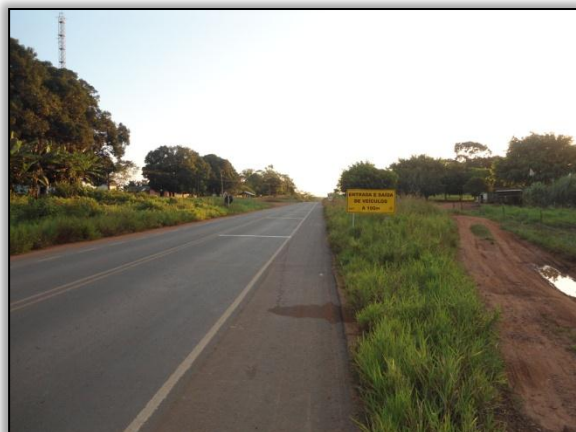
Foto 580 - Sinalização vertical e horizontal próximo a Comunidade Pioneira (Km 30) sentido Altamira/Brasil Novo. Lado direito. S 03.28195 W 052.45302. 06/06/2012.
