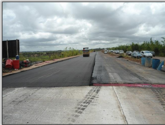
Foto 159 - Pavimentação da rodovia no lado direito com a primeira camada asfáltica. Outra perspectiva. 16/05/2012. S 05.34968° W 049. 12185°
