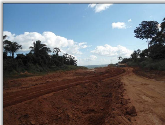
Foto 575 - Serviço de manutenção da rodovia pela CCM. Estaca 2530. S 03.36653° W 052.64393° 06/06/2012.
