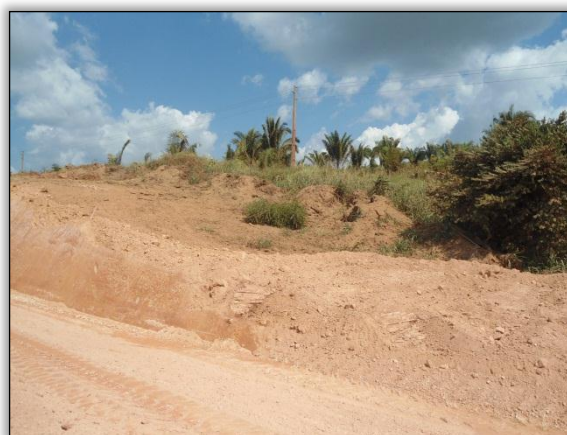
Foto 46 - Área da castanheira suprimida. Lado direito. 18/06/2012 - S 03.94656 W 050.29554
