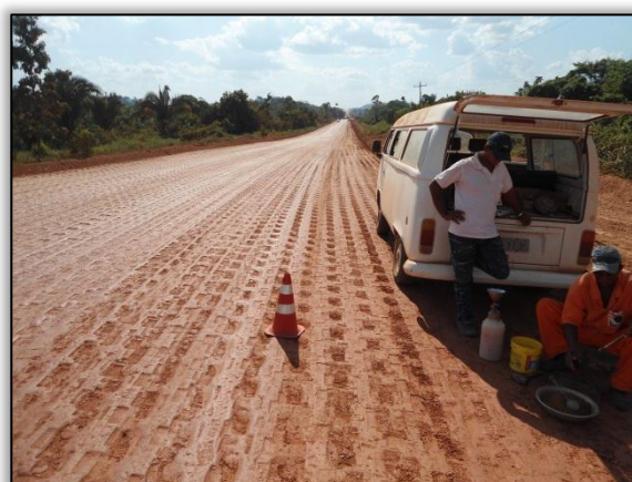
Foto 291 - Análise de compactação da Terraplanagem. Lado direito. Estaca 1350. S 03. 36439° W 051. 33136° 31/07/2012
