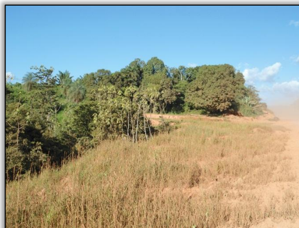
Foto 364 - Realizado hidrossemeadura para conter o processo erosivo. Lado Direito. S 03.15324º W 051.98375º. 28/06/2012.
