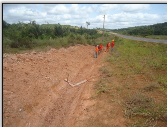
Foto 227 – Construção de dispositivo de drenagem. Lado esquerdo. Estaca 205. S 03.53887° W 050.22634° 08/08/2012
