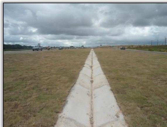
Foto 176 - Canteiro central da marginal após o plantio de gramíneas. S 05.34977° W 049.12132. 02/07/2012
