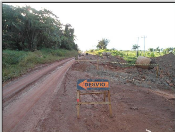
Foto 502 - Construção de bueiro. Lado direito. S 03.19460° W 051.54248°. 04/06/2012.
