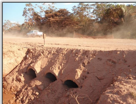
Foto 281 - Bueiro triplo tubular de concreto. Lado esquerdo. Estaca 3155+15. S 03.15285° W 051.57433° 06/08/2012
