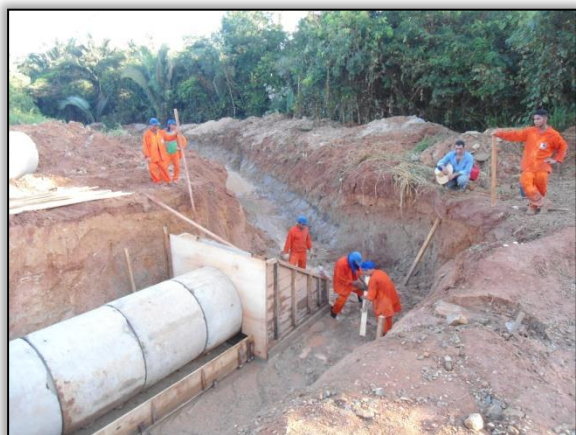
Foto 498 – Construção de um bueiro tubular simples. Estaca 724. S 03.19019° W 052.19188°. 16/05/2012.
