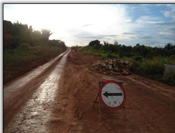
Foto 507 - Construção de bueiro tubular simples e presença de material. Estaca 2616. S 03.22417° W 051.50886°. 04/06/2012.
