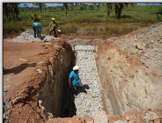
Foto 182- Corte para instalação do BSTC estaca 4280. Lado direito. S 04.03490° W 050.29128°. 01/06/2012
