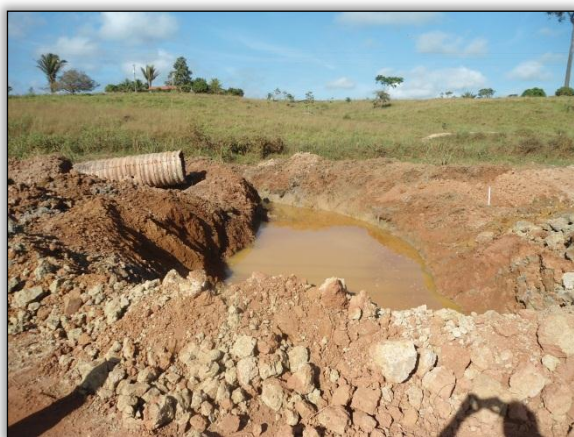
Foto 189 - Substituição de bueiro na estaca 4796. S 03.94904° W 050.28712° 04/07/2012
