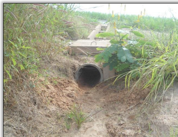
Foto 318 - Foto 41: Bueiro desassoreado. Lado direito. S 05.34996° W 049.11887° 04/05/2012
