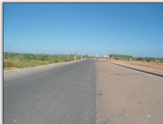
Foto 154 - Marginal após pavimentação. Lado direito. S 05.34979° W 049. 11759° 06/06/2012.
