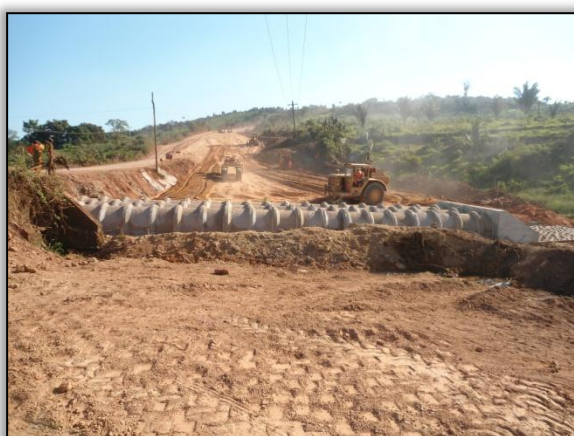
Foto 492 - Construção de um bueiro tubular triplo. Lado direito. Estaca 1203. S 03.84412° W 050.53922°. 31/07/2012.
