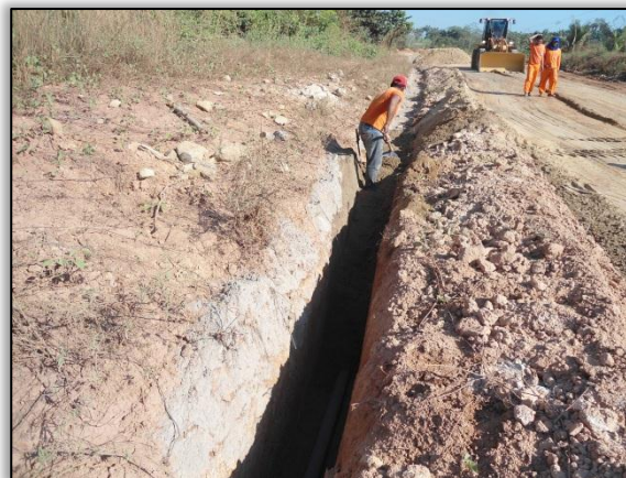
Foto 266 - Construção de dreno longitudinal profundo. Lado esquerdo. Estaca 1684 ate 1702. S 03. 32384° W 051. 37743° 01/08/2012
