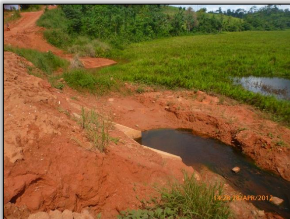
Foto 438 – Ponto 40 – Montante – Bueiro. 3.133422°S 51.717803°W
