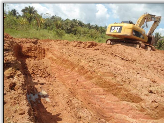
Foto 517 – Construção de um bueiro tubular simples. Lado esquerdo. Estaca 1319. S 03.36780° W 051.32667°. 18/05/2012.
