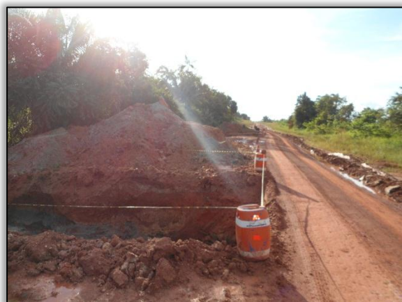
Foto 500 – Construção de bueiro, lado esquerdo. S 03.18088° W 051.55482°. 04/06/2012.
