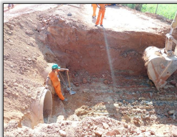
Foto 283 - Bueiro duplo tubular de concreto. Lado direito. Estaca 3545. S 03.11070° W 051.62909° 06/08/2012
