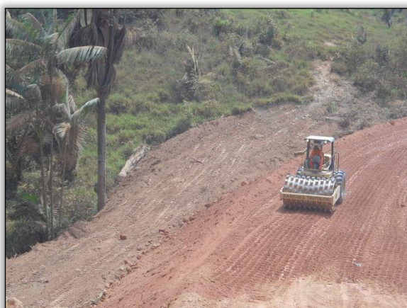
Foto 35 - Área da castanheira suprimida. Lado esquerdo. 14/06/2012 - S 03.94171 W 050.30745
