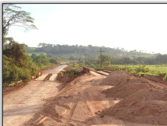
Foto 572 - Construção de uma ponte pela CCM sobre o rio Penetecal I. Lado direito. Estaca 2800. S 03.38600° W 052.68743° 06/06/2012.
