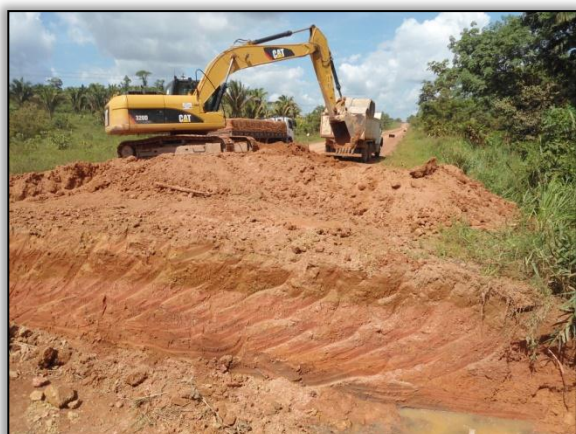
Foto 518 – Construção de um bueiro tubular simples. Lado esquerdo. Estaca 1319. S 03.36780° W 051.32667°. 18/05/2012.
