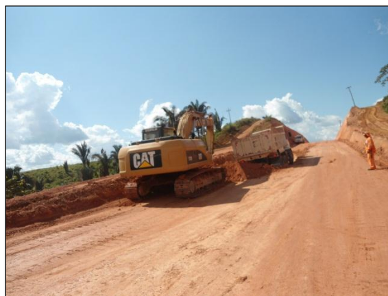
Foto 198 - Atividade de corte e rebaixo. Estaca - 4665. Lado esquerdo. S 04.02376° W 050.28568° 18/07/2012
