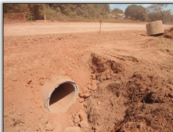
Foto 270 - Bueiro simples tubular de concreto. Estaca 3482. S 03. 11538° W 051. 61885° 31/07/2012
