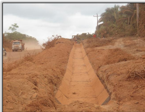
Foto 277 - Valeta de proteção de corte. Lado direito. Estaca 1132+10 a 1154. S 03.38658° W 051.29927° 07/08/2012
