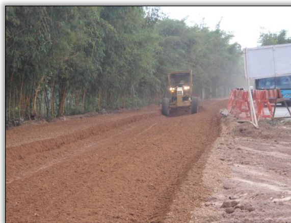
Foto 148 - Terraplenagem na marginal de acesso a ponte sobre o rio Itacaiúnas. S 05.35005° W 049.12070° 17/05/2012
