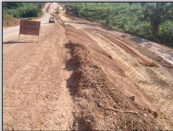
Foto 62 - Supressão vegetal na faixa de domínio. Lado direito. Estaca 1203. S 03.84412° W 050. 53922° 31/07/2012
