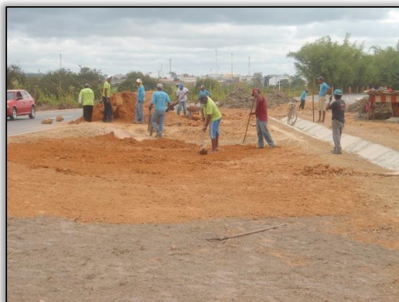
Foto 175 - Limpeza e nivelamento no canteiro central da marginal. S 05.34977° W 049.12132. 25/06/2012
