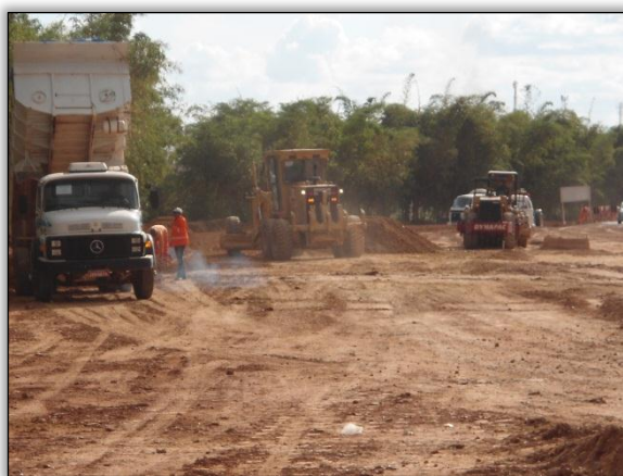
Foto 147 - Implantação do sistema de drenagem profunda. S 05.34996° W 049.12089° 17/05/2012
