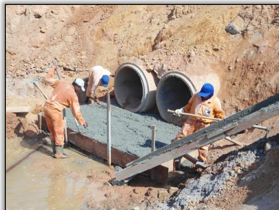
Foto 533 - Construção de Bueiro Duplo Tubular de Concreto (BDTC). Estaca 1207. S 03.37735° W 051. 30928°. 31/07/2012
