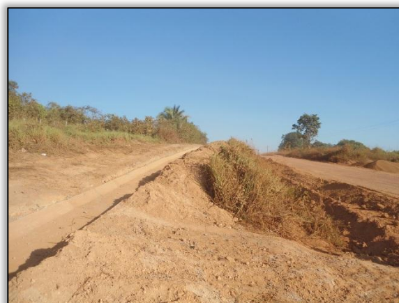
Foto 264 - Construção de valeta de proteção, Lado esquerdo. Estaca 935 até 948. S 03. 40794° W 051. 27147° 01/08/2012
