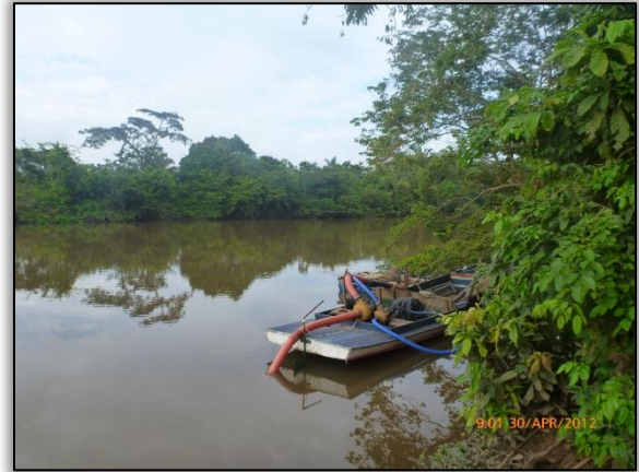
Foto 427 – Ponto 36 – Montante. Barco retirando areia do rio. 3.473318°S 51.196224°W
