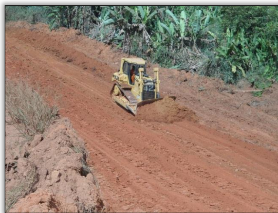
Foto 26 - Abertura de caminho de serviço. Lado direito. S 04.03485° W 050.29123° 30/05/2012.
