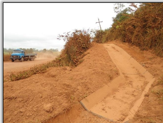
Foto 551 - Valeta de proteção de corte. Lado Direito. Estaca 814 a 820. S 03.41975° W 051.25304°. 07/08/2012
