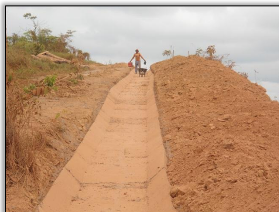
Foto 553 - Valeta de proteção de corte. Lado esquerdo. Estaca 888 a 901. S 03.41267° W 051.26416°. 07/08/2012
