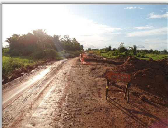
Foto 504 - Construção de bueiro, lado direito. Estaca 2822. S 03.19841° W 051.53903°. 04/06/2012.
