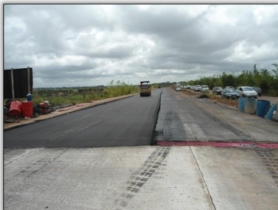
Foto 145 - Pavimentação da rodovia no lado direito com a primeira camada asfáltica. S 05.35376° W 049.12149° 17/05/2012
