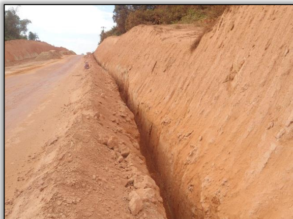
Foto 556 - Dreno longitudinal profundo. Lado direito. Estaca 1981. S 03.30014° W 051.42395°. 08/08/2012
