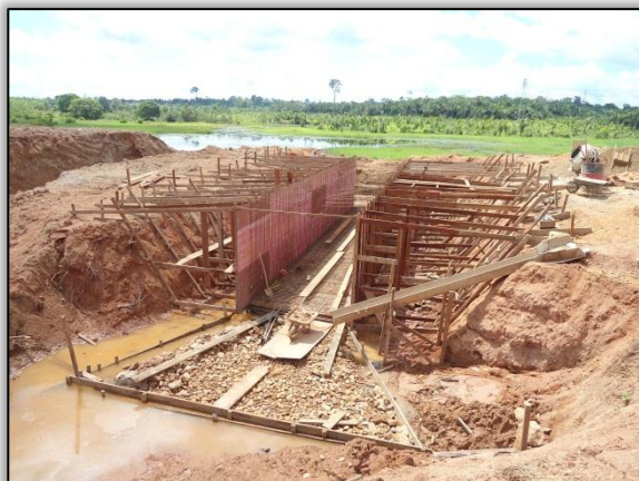
Foto 261 - Substituição de bueiro. Estaca 2428+12,00. S 03. 24552° W 051. 48267° 17/07/2012
