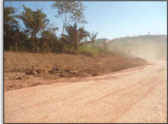
Foto 61 - Atividades de supressão vegetal na faixa de domínio. Lado esquerdo. S 03.84354° W 050. 53780° 31/07/2012
