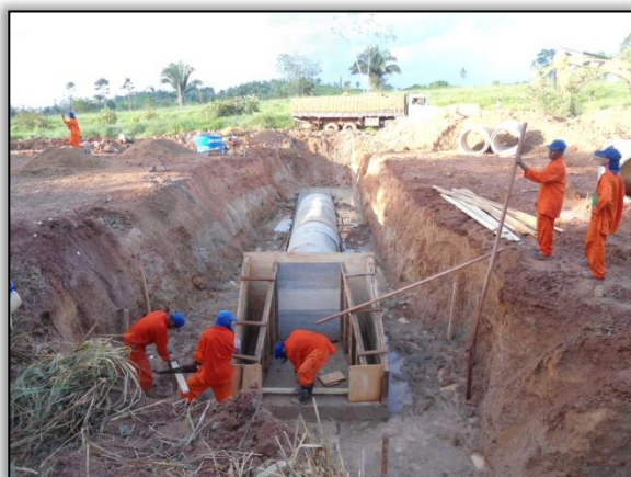
Foto 512 – Construção de um bueiro tubular simples. Lado esquerdo/direito. Estaca 724. S 03.19019° W 052.19188°. 16/05/2012.
