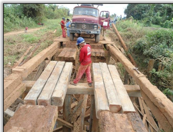
Foto 218 – Substituição das madeiras. CCM. S 03.40500° W 051.27692° . 06/06/2012.
