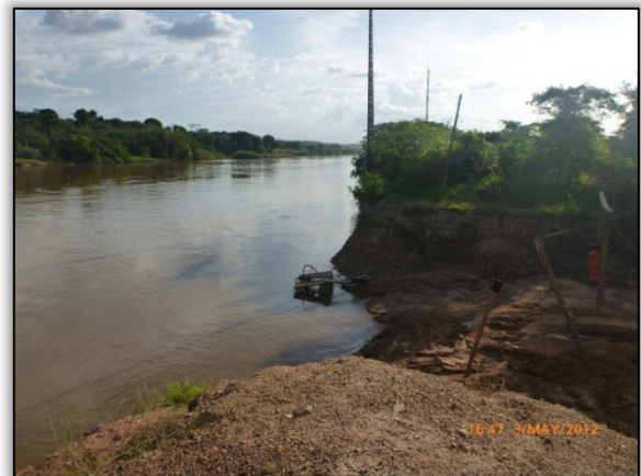
Foto 401 – Ponto 8 – Jusante (Captação de água para fabrica de concreto). 5.357422° S 49.121869° W
