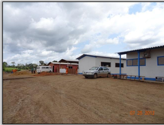
Foto 6 - Canteiro de obras da TORC – Anapu. S 03.449936° W 051.218942° 25/07/2012
