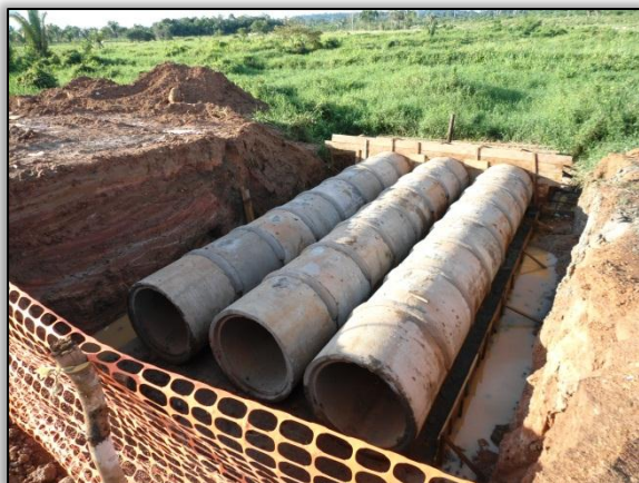
Foto 246 – Construção de bueiro tubular triplo, lado direito. Estaca 2822. S 03.19841° W 051.53903°. 04/06/2012.
