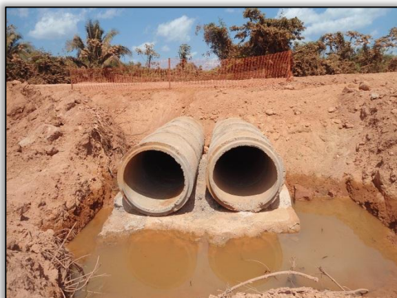
Foto 536 - Bueiro Duplo Tubular de Concreto (BDTC), Estaca: 3404. S 03. 12188° W 051. 60652°. 31/01/2012
