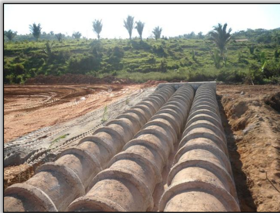
Foto 233 - Construção de um bueiro tubular triplo. Lado direito. Estaca 1203. S 03.84412° W 050.53922° 31/07/2012
