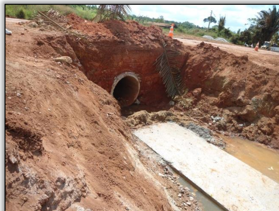
Foto 180 - Galeria sendo instalada no bueiro 4262. Lado direito. S 04.03774°. W 050. 29283° 01/06/2012.
