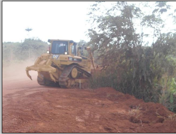
Foto 17 - Atividades de supressão vegetal na estaca 4512. Lado direito. S 04.02491° W 050. 28645° 29/05/2012
