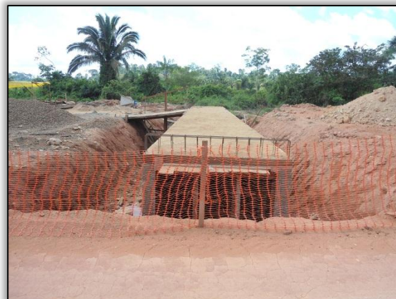
Foto 262 - Substituição de bueiro. Estaca 2122+4,00. S 03. 28419° W 051. 44317° 17/07/2012
