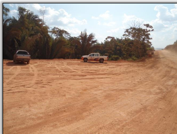
Foto 292 - Área de bota-fora. Lado esquerdo. Estaca 1541. S 03. 34178° W 051. 35818° 31/07/2012
