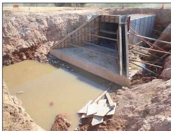
Foto 202 - Substituição de bueiro. S 03.97551° W 050.26126° 31/07/2012
