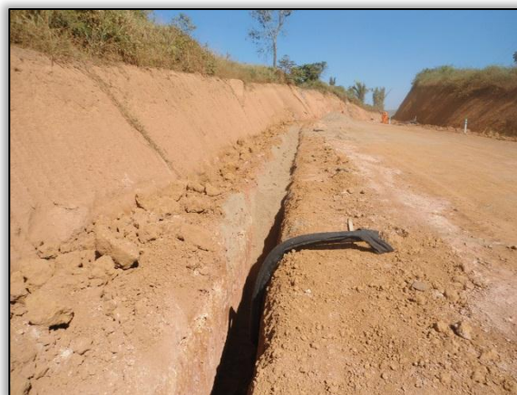
Foto 226 – Drenagem profunda. Lado esquerdo. S 03. 85345° W 050. 46827° 19/07/2012.
