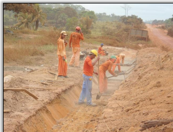
Foto 549 - Valeta de proteção de corte. Lado esquerdo. Estaca 652 a 664+10. S 03. 43869° W 051. 23250° . 07/08/2012
