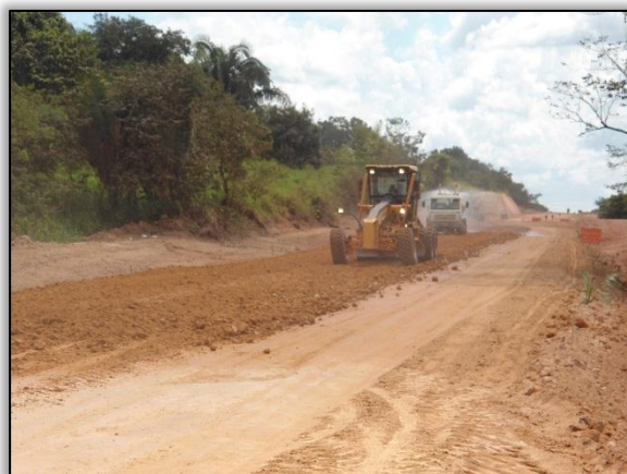
Foto 286 - Terraplanagem. S 03. 29328° W 051. 43354° 17/07/2012
