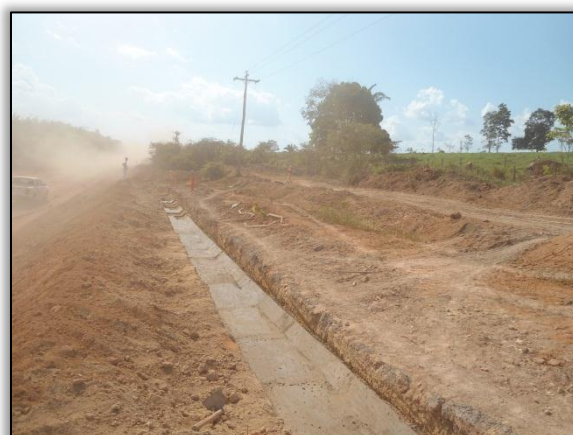
Foto 531 - Construção de valeta de Proteção. Lado direito. Estaca 707 até 715. S 03.43180° W 051.23972°. 31/07/2012
