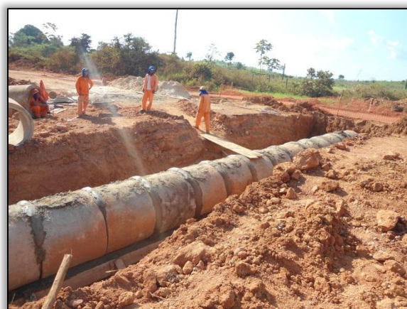
Foto 559 - Bueiro simples tubular de concreto. Estaca 3565. S 03.10929° W 051.63231°. 06/08/2012
