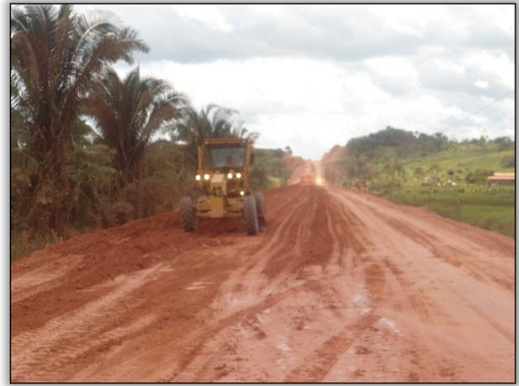
Foto 184 - Atividades de Terraplenagem. Lado esquerdo. S 04.01662° W 050.28220° 04/07/2012
