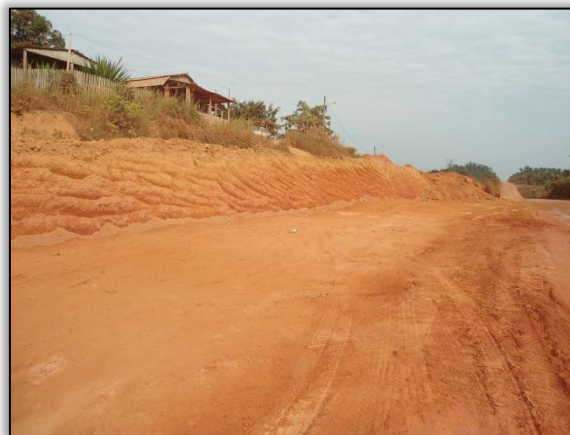
Foto 300 - Corte e empréstimo. Lado esquerdo. Estaca 1875 a 1915. S 03.31043° W 051.40954° 08/08/2012
