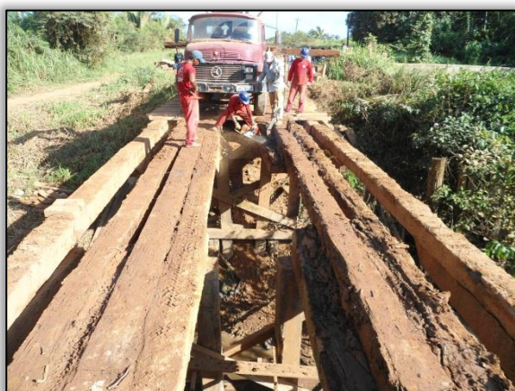
Foto 217 – Início da manutenção da ponte, trabalhadores retirando madeira antiga. CCM. S 03.40500° W 051.27692° . 06/06/2012.
