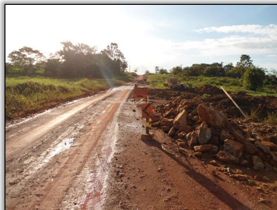
Foto 503 - Construção de bueiro, lado direito. S 03.19639° W 051.54084°. 04/06/2012.
