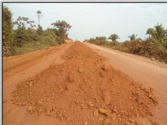
Foto 562 - Complementação de subleito. Estaca 1797. S 03.31653° W 051.39486° . 08/08/2012
