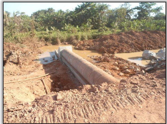
Foto 234 - Construção de um bueiro tubular simples. Lado esquerdo. Estaca 1289. S 03.84696 W 050.15535 31/07/2012
