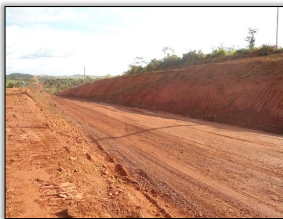
Foto 16 - Talude após a supressão vegetal. Lado esquerdo. S 03. 99469° W 050. 27066° 29/05/2012.
