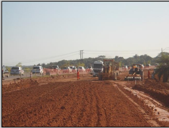
Foto 469 - Atividade de terraplenagem. S 05.35317° W 049.12101° 05/06/2012
