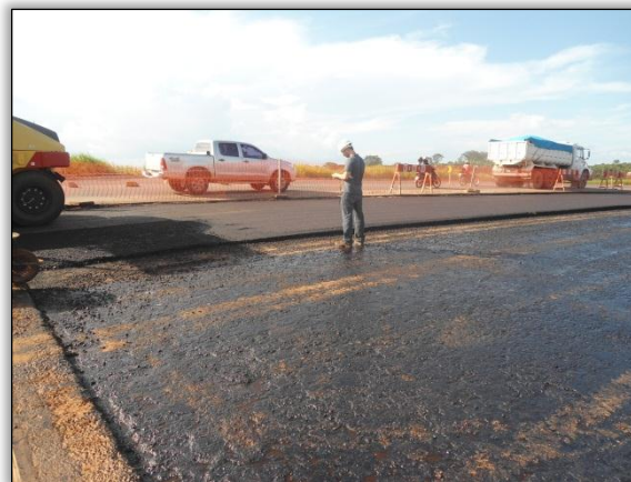
Foto 152 - Pavimentação da primeira camada asfáltica lado esquerdo. S 05.35019° W 049.11874° 04/05/2012.
