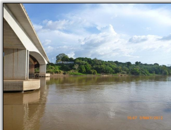
Foto 390 - Ponte do Rio Itacaiúnas. 5.357422° S 49.121869° W
