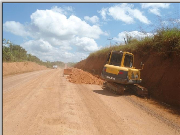
Foto 508 – Dreno profundo, lado direito. S 03.31982° W 051.38707°. 06/06/2012.
