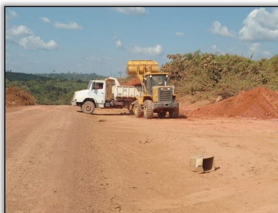
Foto 305 - Corte. Lado esquerdo. Estaca 3666. S 03.10492° W 051.64874° 06/08/2012
