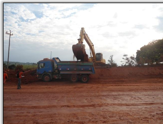
Foto 304 - Rebaixo e corte. Lado direito. Estaca 2599. S 03.22550° W 051.50637° 08/08/2012
