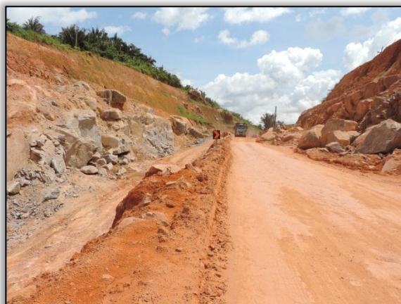
Foto 33– Registro dos trabalhos no Canteiro – Pacajá/PA, para a Ed. 5ª do Jornal Informativo. 24/04/2015
