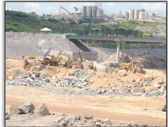
Foto 74 – Vistoria no desvio – Ponte na Transamazônica concluída – Lote 4 (Altamira/Anapu). Altamira/PA. 01/06/2015
