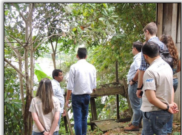
Foto 39 – Sr. Paulo Sérgio da - Supervisora de Obras, da construtora Maia Melo esclarecendo algumas dúvidas. 23/04/2015
