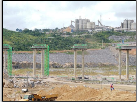
Foto 41 – Ponte em construção na rodovia Transamazônica, próximo ao desvio de 3,5 Km realizado na rodovia pela Norte Energia para possibilitar a escavação do Canal de Fuga da Casa de Força principal da Usina, localizado entre Altamira e Anapu/PA. 23/04/2015
