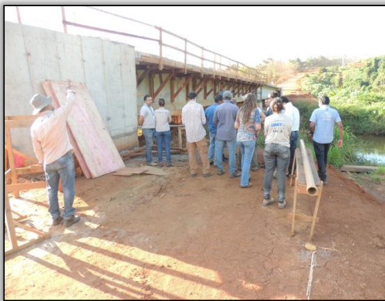
Foto 71 – Vistoria na Ponte do Ambé (Transamazônica). Altamira/PA. 30/06/2015
