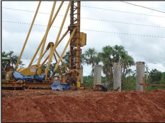
Foto 344 - Armação para concretagem de pilares/ Igarapé Ambé. Lado esquerdo.
