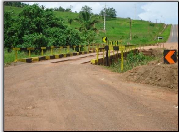
Foto 378 - Reconformação em cabeceira da ponte penetecal. Lado direito
