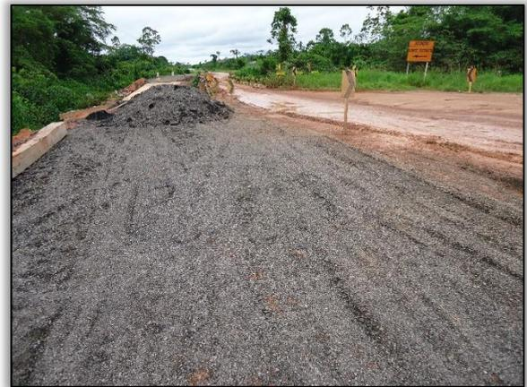
**Foto 364 – Reconformação em cabeceira da ponte provisória no rio Praiado. Lado direito.
