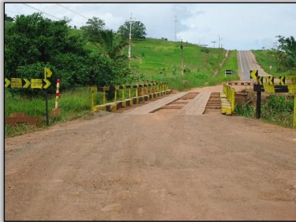
Foto 377 - Reconformação em cabeceira da ponte penetecal. Lado esquerdo
