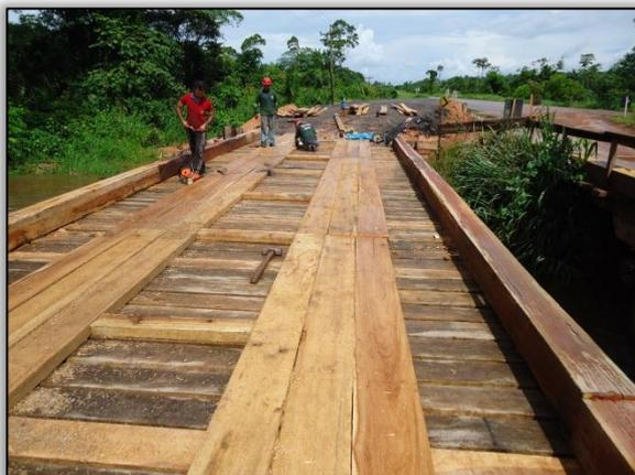
Foto 365 – Construção de ponte provisória no rio Praiado. Lado direito.
