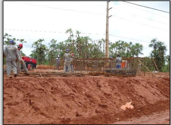
Foto 345 - Armação para concretagem de pilares/ Igarapé Ambé. Lado esquerdo.
