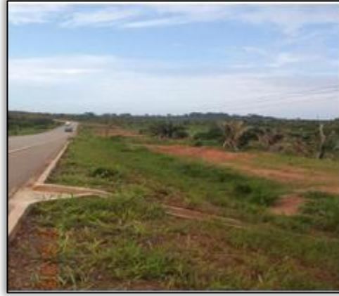
No mês de Junho de 2015 foram executados serviços de reconformação de processos erosivos, implantação de meios fio, e recuperação da pista de rolagem, dos pontos notificados através das CNC's 01 (E: 4628) e 02 (E:4640) de 2015 pela Supervisora Ambiental, conforme imagem abaixo:
