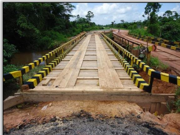
Foto 366 – Construção de deslizantes e sinalização da ponte. Lado direito.
