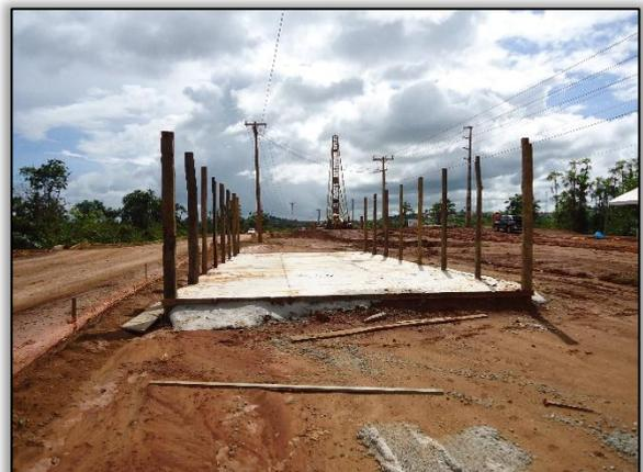
Foto 343 - Armação para concretagem de pilares/ Igarapé Ambé. Lado esquerdo
