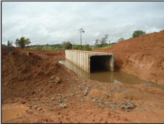
Foto 401 - Construção de galeria. Estaca 7672.
