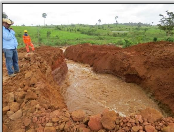
Figura 51. Desobstrução de bueiro acompanhada pela equipe de resgate de fauna, entre Placas e Rurópolis Lote 03-B. Data: 06/04/2015 Coord. UTM 21M SAD 69 E-0783103/N-9569256
