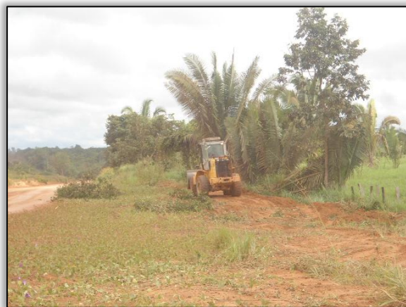
Foto 173 – Supressão vegetal (CELPA). Lado direito. S 03.88754° W 054.34650° 26/05/2015.
