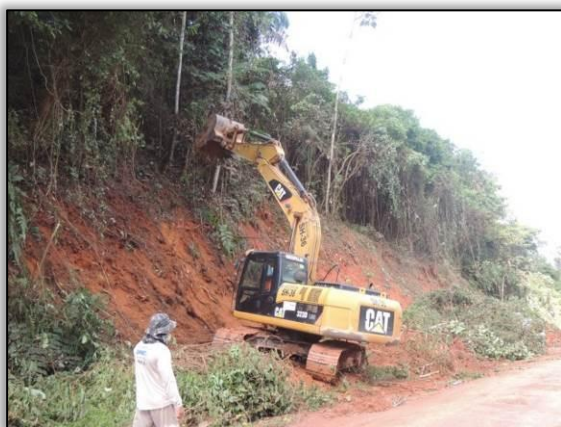
Figura 83. Acompanhamento de limpeza de talude entre Cajazeiras e Novo Repartimento – Lote 01-A.
