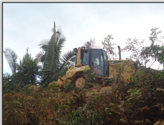
Foto 22 – Limpeza no bordo da rodovia. Lado esquerdo. S 04.81656° W 049.56150° 14/05/2015
