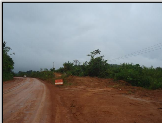
Foto 7 – Área após supressão vegetal. Lado direito. S 04.82254 W 049.55210° 04/05/2015
