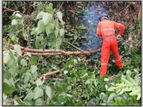
Figura 86. Acompanhamento de frente de supressão vegetal no trecho entre Uruará e Placas – Lote 02-B. Data: 22/05/2015 Coord. UTM 22M SAD 69 E-0168377/N-9572348
