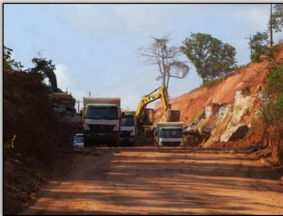
Figura 15. Acompanhamento de atividade de empréstimo – Lote 02-A. Data: 27/01/2015 Coord. UTM 22M SAD 69 E-0553904/N-9574567
