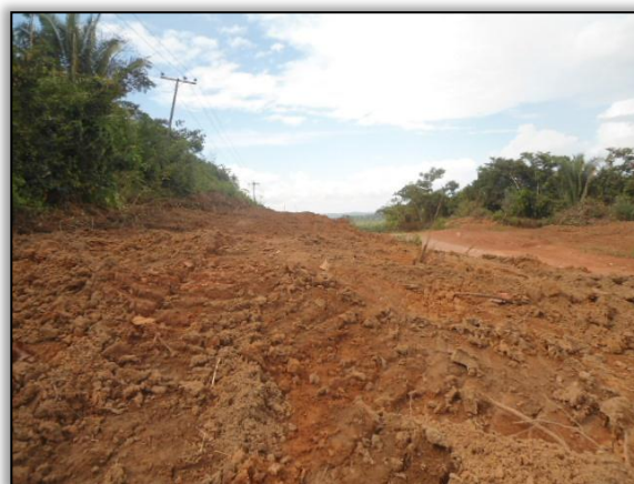
Foto 82 - Limpeza. Lado direito. Estaca 6700. S 03.86433° W 053.94629° 30/04/2015. Final.
