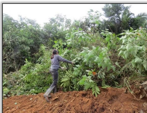
Figura 60. Vistoria prévia de área a ser suprimida com motosserra no trecho entre Uruará e Placas – Lote 02-B. Data: 24/04/2015
