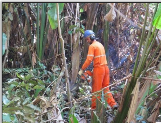
Figura 104. Acompanhamento de supressão vegetal entre Uruará e Placas – Lote 02-B.
