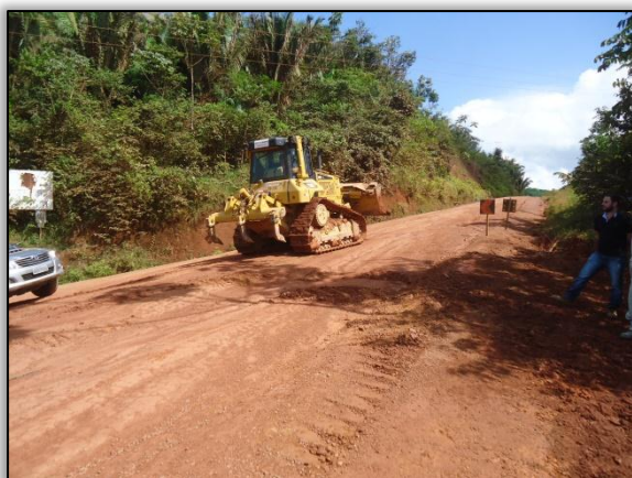
Foto 19 – Limpeza no bordo da rodovia. Lado esquerdo. S 04.81656° W 049.56150° 13/05/2015
