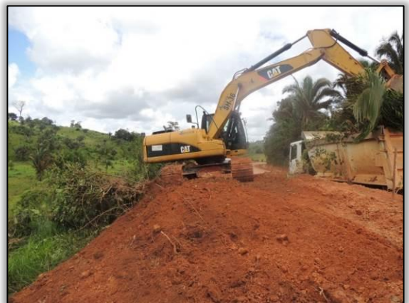
Figura 72. Acompanhamento de limpeza lateral entre Cajazeiras e Novo Repartimento – Lote 01-A. Data: 08/05/2015 Coord. UTM 22M SAD 69 E-0660631/N-9466722
