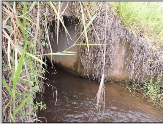
Figura 549. Boca do BSCC à jusante (maio de 2015). Ponto 23 - local II _ Lote 02-A Coord. UTM 22M SAD 69 E-581997 /N-9560528
