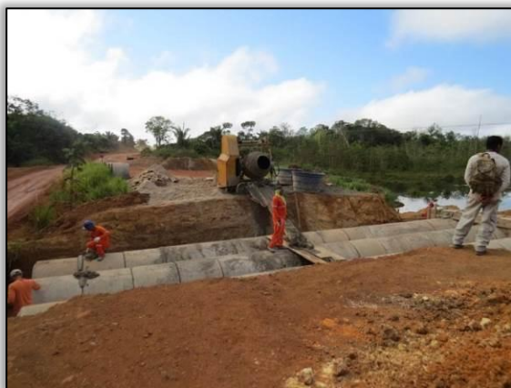
Figura 103. Acompanhamento de locação de bueiro entre Placas e Rurópolis – Lote 03-B.
