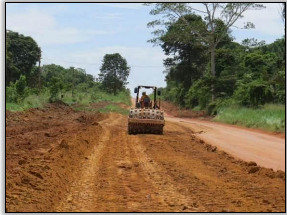
Figura 32. Acompanhamento de terraplenagem no trecho entre Placas e Rurópolis – Lote 03-B.
