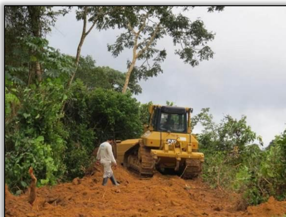
Figura 55. Vistoria de área de limpeza da faixa de domínio entre as cidades de Placas e Rurópolis – Lote 03-B.
