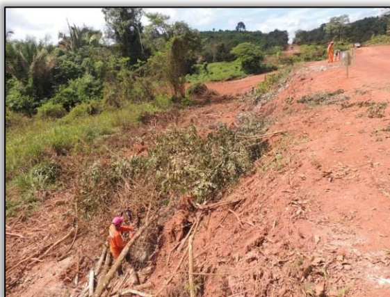
Figura 95. Acompanhamento de limpeza da faixa de domínio entre Cajazeiras e Novo Repartimento – Lote 01-A. Data: 28/05/2015 Coord. UTM 22M SAD 69 E-0658904/N-9468246
