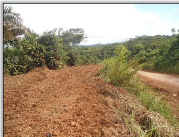
Foto 80 - Limpeza. Lado esquerdo. Estaca 6740. S 03.86433° W 053.94629° 30/04/2015. Final.
