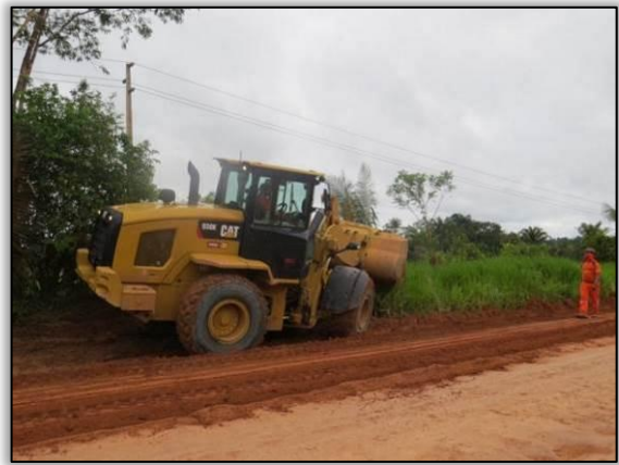
Figura 34. Acompanhamento de limpeza da faixa de domínio no trecho entre Placas e Rurópolis – Lote 03-B. Data: 09/03/2015
