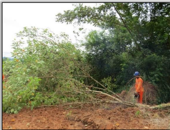
Figura 65. Acompanhamento de supressão vegetal e enleiramento entre Uruará e Placas – Lote 02-B. Data: 30/04/2015 Coord. UTM 21M SAD 69 E-0172847/N-9575719
