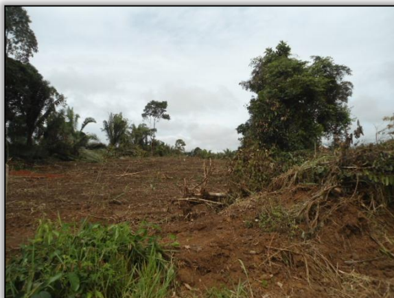
Foto 133 – Limpeza e supressão vegetal. Lado esquerdo. Estaca 7689. Início S 03.86263° W 054.09711° 25/03/2015.
