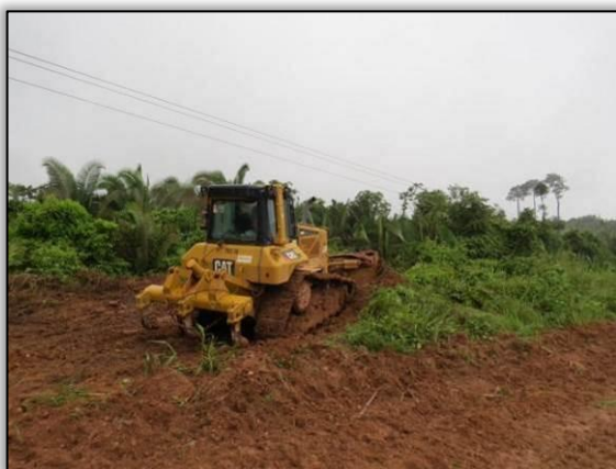
Figura 23. Acompanhamento de limpeza lateral na faixa de domínio da rodovia, entre Uruará e Placas – Lote 02-B. Data: 19/02/2015
