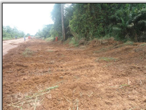
Foto 146 – Limpeza. Lado direito. Estaca 10578 a 10592. S 03.93058° W 054.59311° 18/03/2014.
