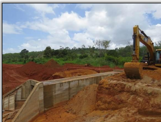
Figura 52. Acompanhamento de aterramento de bueiro, entre Placas e Rurópolis – Lote 03-B. Data: 06/04/2015 Coord. UTM 21M SAD 69 E-0772427/N-9567249
