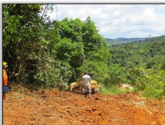
Figura 59. Vistoria de área de limpeza lateral na rodovia entre as cidades de Uruará e Placas – Lote 02-B.
