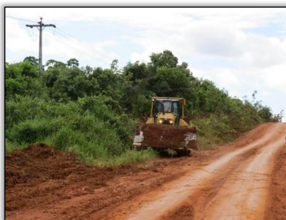
Figura 58. Acompanhamento de limpeza lateral entre Uruará e Placas – Lote 02-B.
