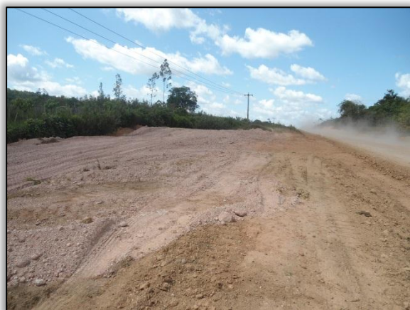
Foto 119 – Limpeza. Lado esquerdo. Estaca 7018 a 7035. S 03.86334° W 053.98538° 27/07/2015.
