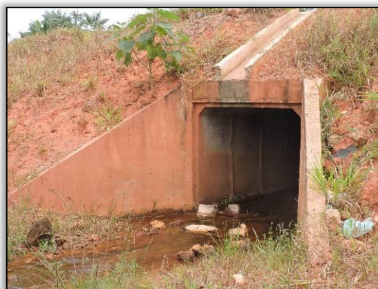
Figura 587. BSCC, montante (outubro de 2014). Ponto 76 _ Lote 02-A Coord. UTM 22M SAD 69 E-604592/N-9538664
