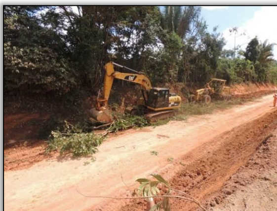
Figura 73. Acompanhamento de limpeza da faixa de domínio no trecho entre Cajazeiras e Novo Repartimento – Lote 01-A. Data: 11/05/2015 Coord. UTM 22M SAD 69 E-0659868/N-9467268
