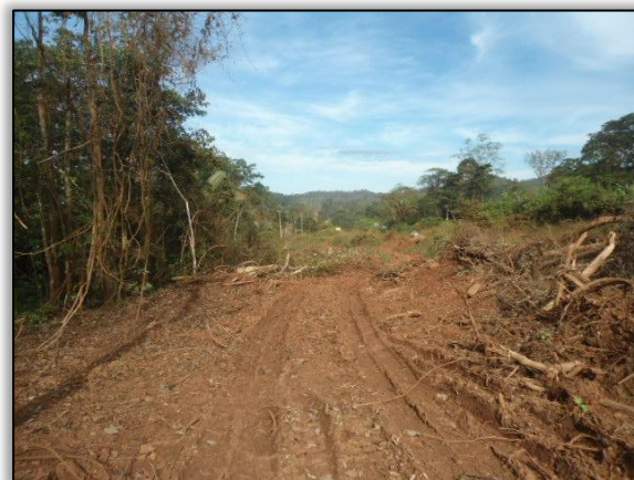
Foto 138 – Supressão vegetal. (CELPA). Lado esquerdo. S 03.74847° W 053.82711° 19/05/2015.
