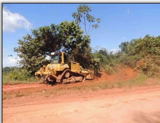
Figura 74. Acompanhamento de limpeza lateral entre Cajazeiras e Novo Repartimento – Lote 01-A. Data: 13/05/2015 Coord. UTM 22M SAD 69 E-0658493/N-9469220
