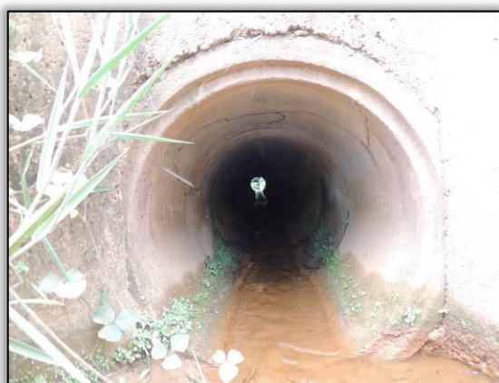
Figura 536. Interior do BSTC com leito úmido (junho de 2014). Ponto 05_Lote 01-A Coord. UTM 22M SAD 69 E- 672938 /N-9440146
