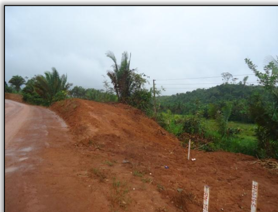
Foto 9 – Área após supressão vegetal. Lado direito. S 04.81876 W 049.55827° 04/05/2015
