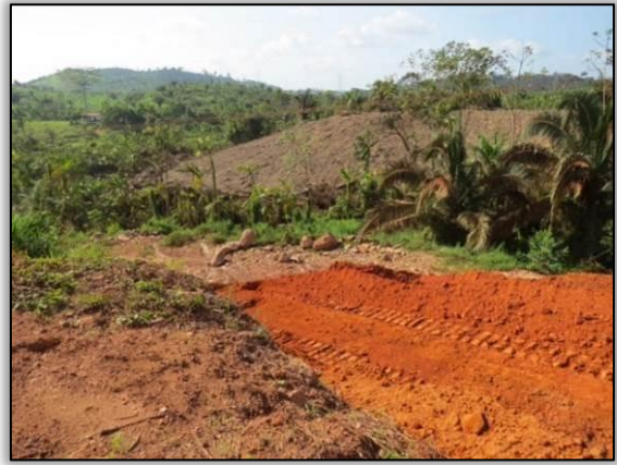
Figura 14. Terraplenagem acompanhada pela equipe, próximo a Pacajá-Lote 02-A. Data: 25/01/2015 Coord. UTM 22M SAD 69 E-0551246/N-9575154
