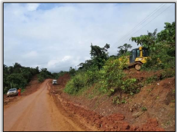
Figura 64. Acompanhamento de limpeza de talude entre Uruará e Placas – Lote 02-B. Data: 29/04/2015 Coord. UTM 22M SAD 69 E-0173725/N-9576640
