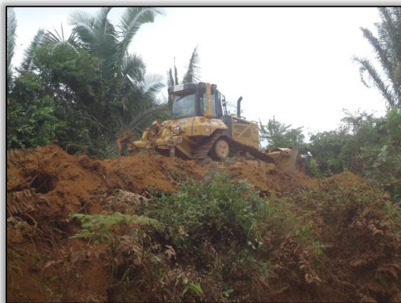
Foto 21 – Limpeza no bordo da rodovia. Lado direito. S 04.81656° W 049.56150° 14/05/2015
