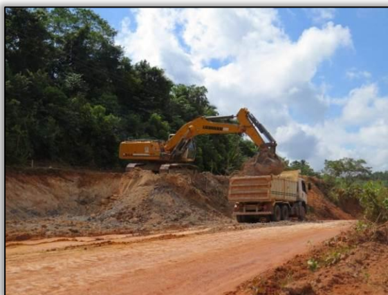
Figura 107. Acompanhamento de atividade de rebaixamento de pista no trecho entre Uruará e Placas – Lote 02-B. Data: 15/06/2015
