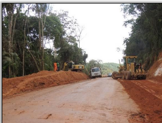
Figura 97. Acompanhamento de terraplenagem entre Cajazeiras e Novo Repartimento – Lote 01-A. Data: 29/05/2015 Coord. UTM 22M SAD 69 E-0659341/N-9467668
