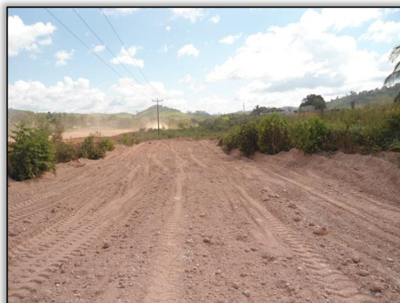
Foto 120 – Limpeza. Lado esquerdo. Estaca 7018 a 7035. S 03.86334° W 053.98538° 27/07/2015.
