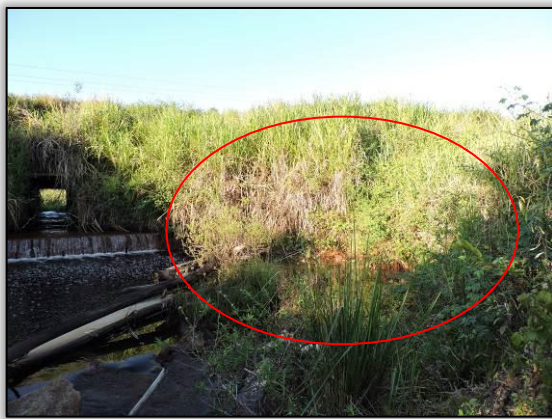
Figura 557. Terreno de difícil acesso (ME). Ponto 25 - local II _ Lote 02-A Coord. UTM 22M SAD 69 E-576501/N-9564628
