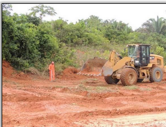
Figura 21. Acompanhamento de limpeza na faixa de domínio da rodovia , entre Uruará e Placas – Lote 02-B. Data: 13/02/2015
