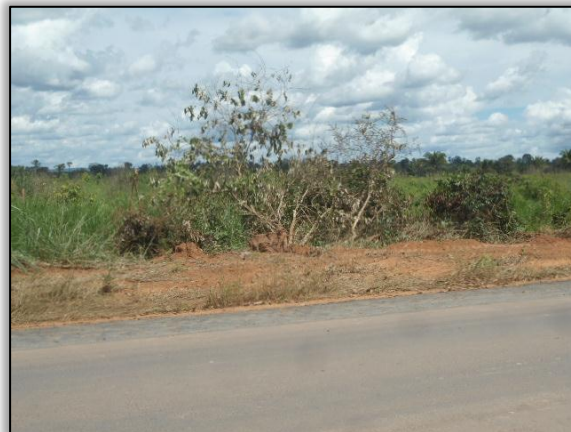
Foto 167 – Supressão vegetal (CELPA). Lado esquerdo. Estaca 8645. S 03.88411° W 054.26051°. 19/05/2015.
