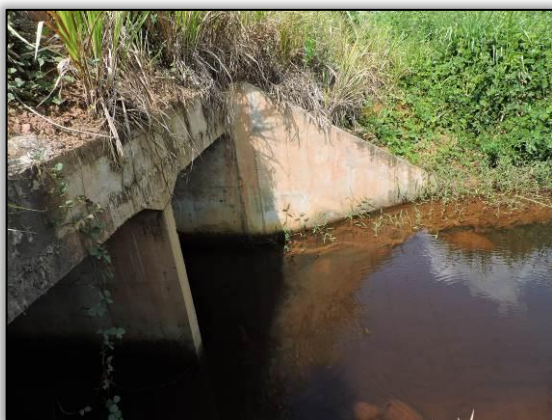
Figura 559. Boca do BDCC a montante (maio de 2015). Ponto 38 _ Lote 03-A Coord. UTM 22M SAD 69 E-484080/N-9610099
