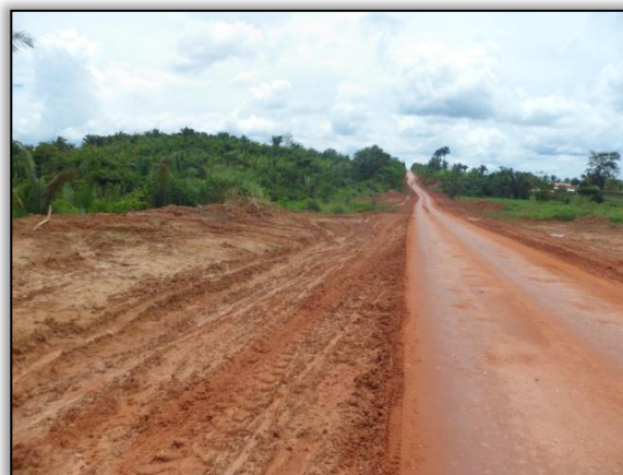
Foto 70 - Limpeza. Lado esquerdo. Estaca 6789 a 6804. S 03.84560° W 053.95069° 25/02/2015.
