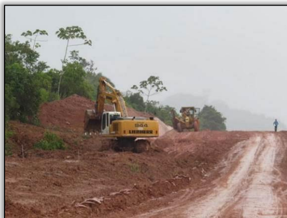
Figura 24. Acompanhamento de alargamento de pista na rodovia, entre Uruará e Placas – Lote 02-B.
