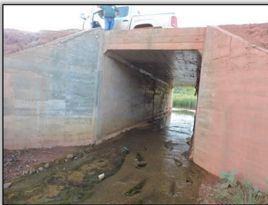
Figura 575. Nível de água no interior da OAC, montante (maio de 2015). Ponto 67 _ Lote 03-B Coord. UTM 21M SAD 69 E-785774/N-9569456
