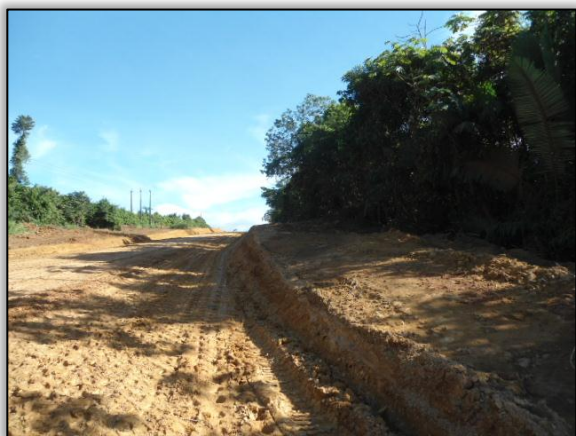
Foto 160 – Limpeza. Lado direito. Estaca 10860 a 10910. S 03.95022° W 054.63634° 14/04/2015.
