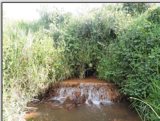
Figura 533. Jusante do BSTC com leito úmido (maio de 2015). Ponto 05_Lote 01-A Coord. UTM 22M SAD 69 E- 672938 /N-9440146
