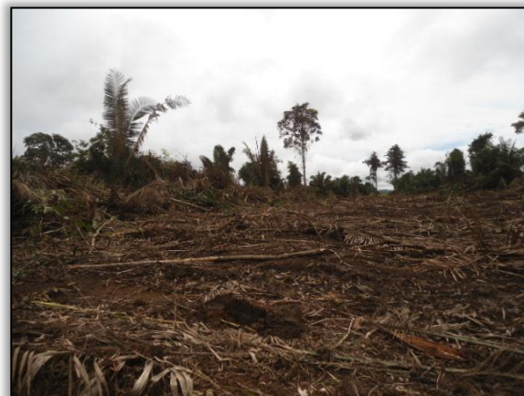
Foto 134 – Limpeza e supressão vegetal. Lado esquerdo. Estaca 7714. Final. S 03.86292° W 054.10183° 25/03/2015.
