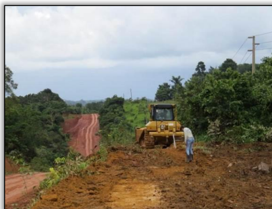
Figura 56. Vistoria de área de limpeza lateral na rodovia entre as cidades de Placas e Rurópolis – Lote 03-B. Data: 13/04/2015
