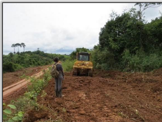
Figura 26. Acompanhamento de limpeza lateral de pista entre Uruará e Placas – Lote 02-B.
