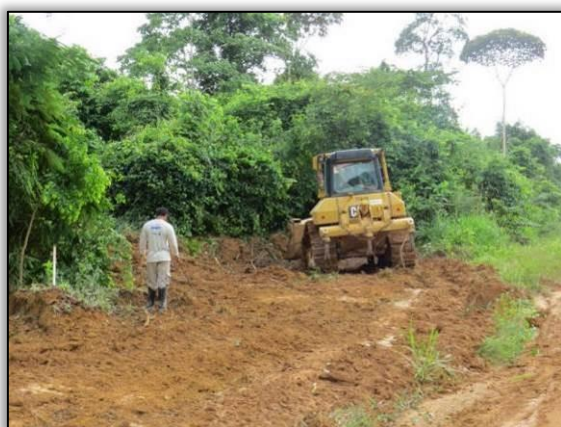
Figura 45. Vistoria de área após limpeza lateral no trecho entre Placas e Rurópolis – Lote 03-B. Data: 24/03/2015 Coord. UTM 21M SAD 69 E-0768969/N-9565734
