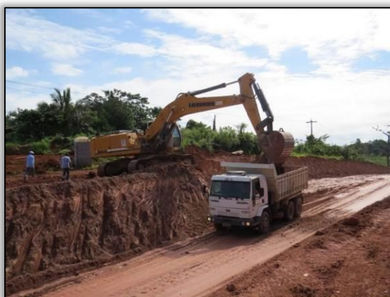
Figura 79. Acompanhamento de obra de terraplenagem no trecho entre Uruará e Placas – Lote 02-B.
