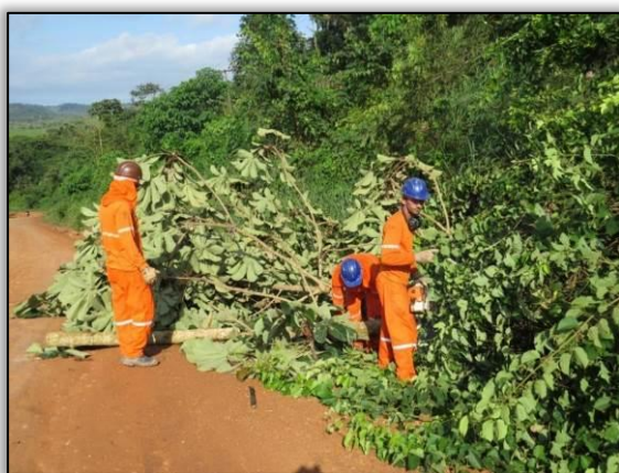
Figura 75. Acompanhamento de supressão vegetal e enleiramento no trecho entre Uruará e Placas – Lote 02-B. Data: 14/05/2015 Coord. UTM 22M SAD 69 E-0172616/N-9575502
