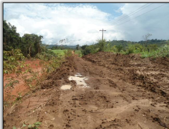
Foto 78 - Limpeza. Lado direito. Estaca 6484. S 03.80163° W 053.92294° 30/04/2015. Final.
