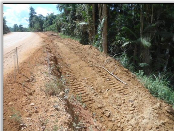
Foto 100 – Limpeza. Lado esquerdo. Estaca 7006-7054. S 03.86849° W 053.98742° 02/06/2015. Final.
