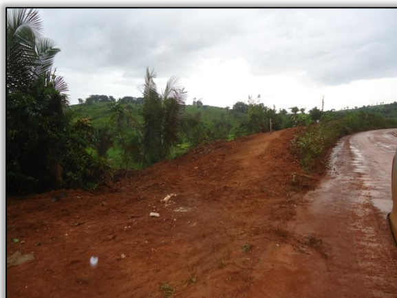
Foto 8 – Área após supressão vegetal. Lado direito. S 04.82118 W 049.55343° 04/05/2015
