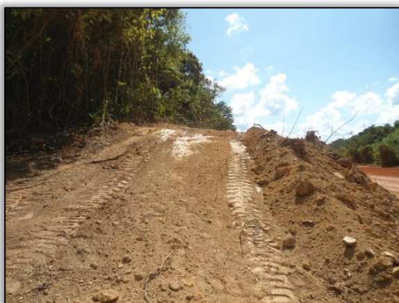
Foto 123 – Limpeza. Lado esquerdo. Estaca 7062 a 7077. S 03.86911° W 053.98865° 27/07/2015.
