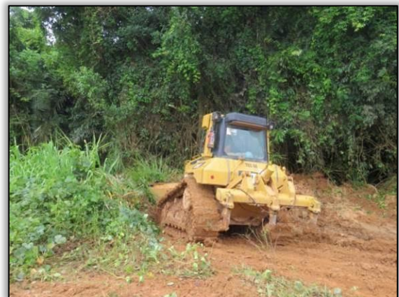
Figura 42. Acompanhamento de limpeza da faixa de domínio entre Placas e Rurópolis – Lote 03-B. Data: 19/03/2015 Coord. UTM 21M SAD 69 E-0776379/N-9565178
