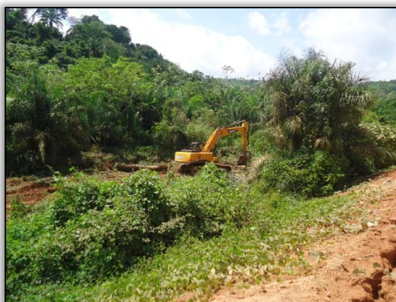
Foto 62 – Limpeza no bordo da rodovia. Lado esquerdo. S 04.79637° W 049.57729° 14/05/2015
