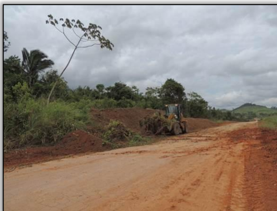
Figura 19. Limpeza de talude entre Uruará e Placas Lote 02-B. Data: 12/02/2015
