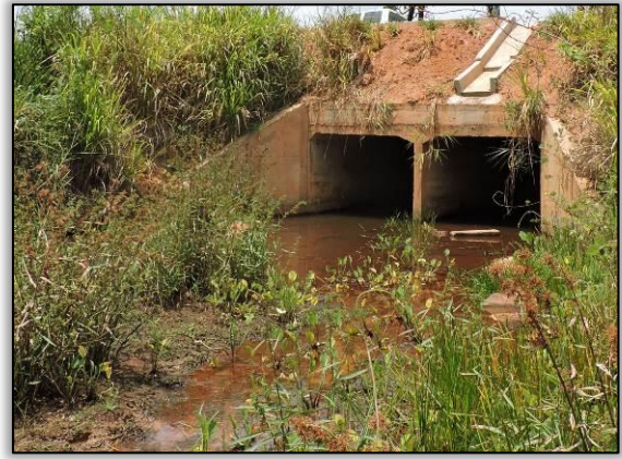
Figura 562. Boca do BDCC a jusante (setembro de 2014). Ponto 38 _ Lote 03-A Coord. UTM 22M SAD 69 E-484080/N-9610099
