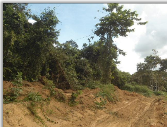
Foto 171 – Supressão vegetal (CELPA). Lado esquerdo. Estaca 8930 a 8960. S 03.89021° W 054.30777° 19/05/2015.
