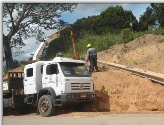
Foto 169 – Implantação de poste (CELPA). Lado esquerdo. S 03.88913° W 054.26949° 19/05/2015.
