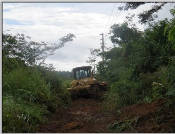
Figura 33. Acompanhamento de supressão vegetal na faixa de domínio entre Placas e Rurópolis – Lote 03-B. Data: 06/03/2015
