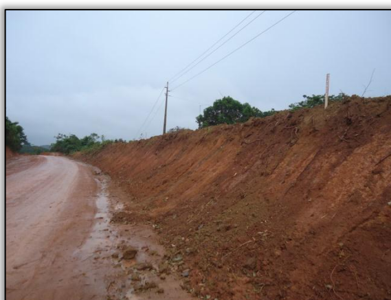
Foto 10 – Área após supressão vegetal. Lado direito. S 04.81876 W 049.55827° 04/05/2015
