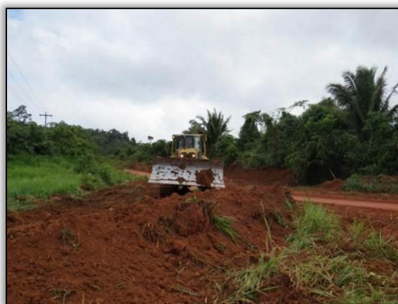
Figura 28. Acompanhamento de limpeza lateral entre Uruará e Placas – Lote 02-B.
