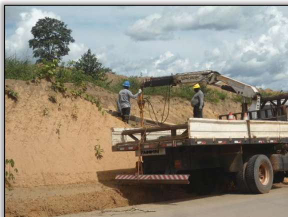
Foto 168 – Implantação de poste (CELPA). Lado esquerdo. S 03.88913° W 054.26949° 19/05/2015.
