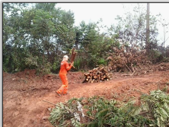
Foto 11 – Enleiramento de madeira. Lado esquerdo. S 04.8332 W 049.55069° 06/05/2015
