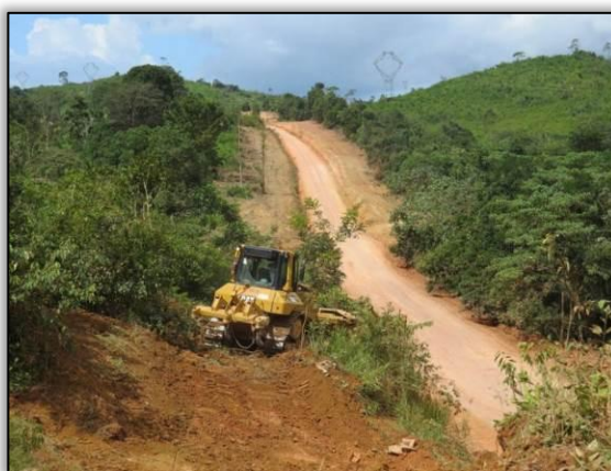
Figura 94. Acompanhamento de limpeza lateral no trecho entre Uruará e Placas – Lote 02-B. Data: 28/05/2015 Coord. UTM 21M SAD 69 E-0832158/N-9572237
