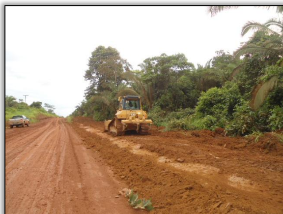
Foto 157 – Limpeza. Lado direito. Estaca 10306 a 10391. S 03.91149° W 054.54683° 30/03/2015.
