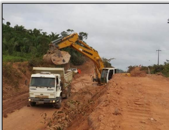
Figura 110. Acompanhamento de atividade de rebaixamento de pista no trecho entre Uruará e Placas – Lote 02-B. Data: 18/06/2015 Coord. UTM 21M SAD 69 E-0831288/N-9572482
