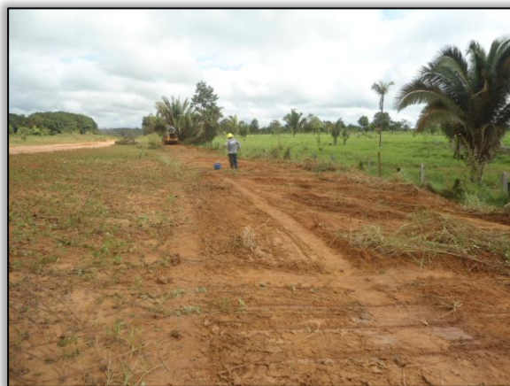
Foto 172 – Supressão vegetal (CELPA). Lado direito. S 03.88754° W 054.34650° 26/05/2015.
