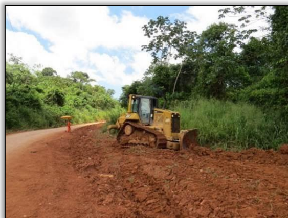
Figura 29. Acompanhamento de limpeza lateral entre Uruará e Placas – Lote 02-B.
