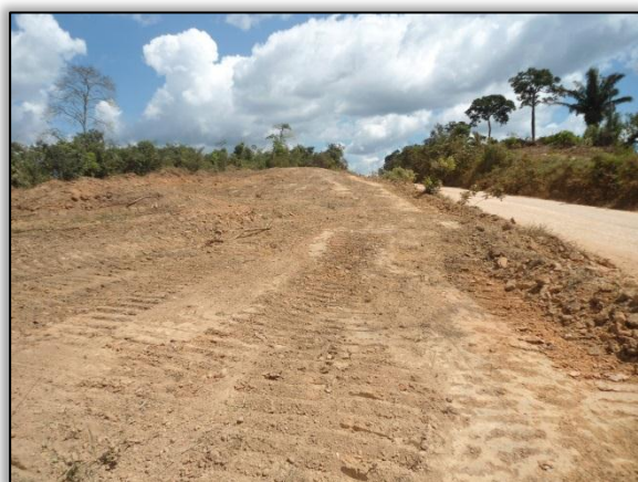
Foto 117 – Limpeza. Lado esquerdo. Estaca 6823 a 6836. S 03.85038° W 053.95380° 27/07/2015.
