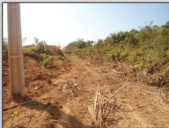
Foto 140 – Supressão vegetal (CELPA). Lado esquerdo. Estaca 8003 a 8013. S 03.85136° W 054.15067° 15/07/2015.
