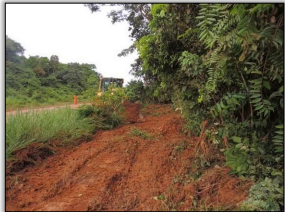
Figura 36. Acompanhamento de limpeza da faixa de domínio no trecho entre Placas e Rurópolis – Lote 03-B.
