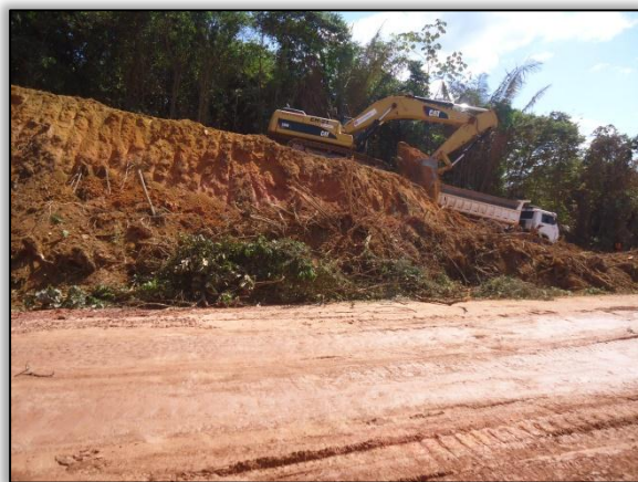
Foto 48 – Área após supressão vegetal. Lado direito. S 04.80309° W 049.57092° 21/07/2015
