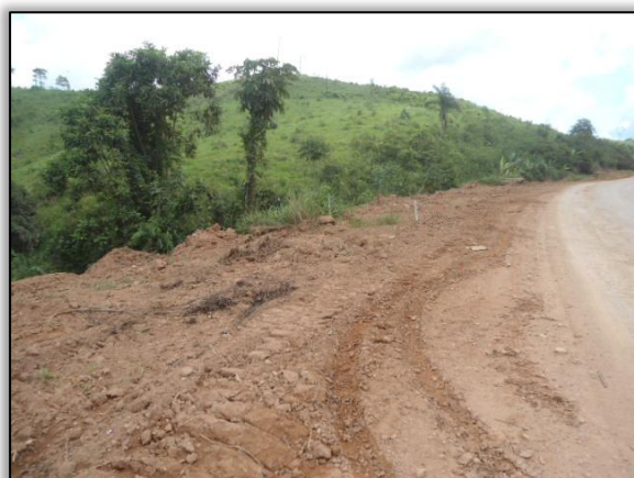
Foto 99 – Limpeza. Lado esquerdo. Estaca 7006-7054. S 03.86326° W 053.98363° 02/06/2015. Inicial.
