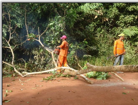
Foto 14 – Seccionamento de madeira. Lado esquerdo. S 04.81656° W 049.56150° 15/05/2015
