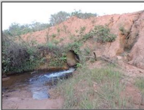
Figura 572. Nível de água na entrada do BTCC (maio de 2015). Ponto 62 _ Lote 03-B Coord. UTM 21M SAD 69 E-769356/N-9565882
