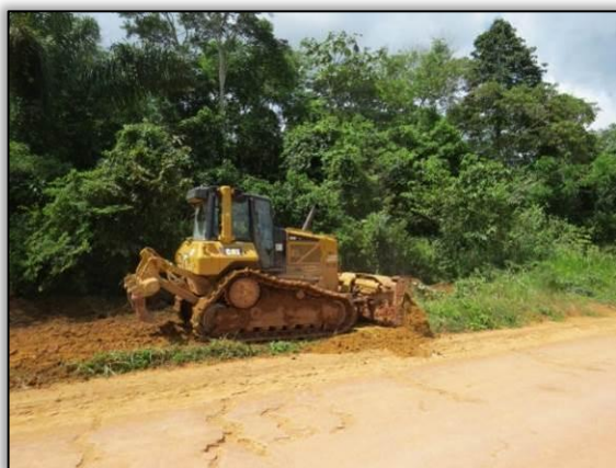
Figura 30. Acompanhamento de limpeza lateral no trecho entre Placas e Rurópolis – Lote 03-B.
