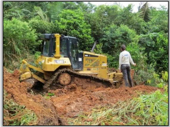
Figura 62. Vistoria de área de supressão vegetal na faixa de domínio entre Uruará e Placas – Lote 02-B. Data: 28/04/2015 Coord. UTM 22M SAD 69 E-0173668/N-9576447
