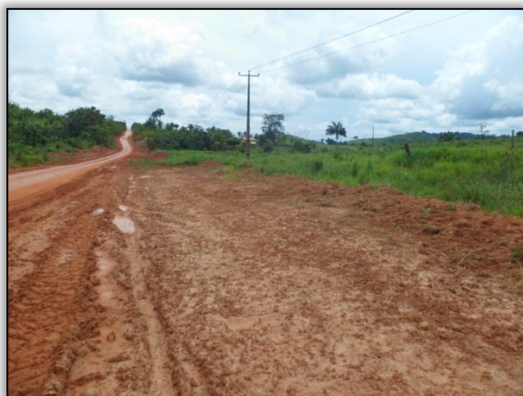
Foto 69 – Limpeza. Lado direito. Estaca 6789 a 6804. S 03.84560° W 053.95069° 25/02/2015.
