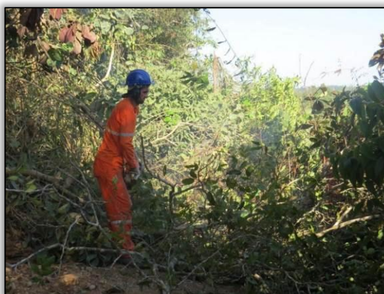
Figura 114. Acompanhamento de supressão vegetal com motosserra no trecho entre Uruará e Placas – Lote 02-B. Data: 24/06/2015 Coord. UTM 21M SAD 69 E-0832640/N-9572097
