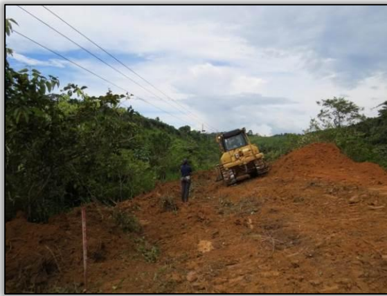
Figura 87. Acompanhamento de limpeza da faixa de domínio no trecho entre Uruará e Placas – Lote 02-B. Data: 25/05/2015 Coord. UTM 22M SAD 69 E-0167649/N-9571890
