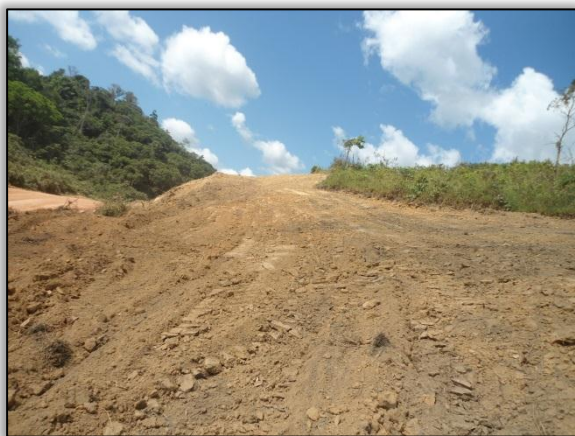
Foto 121 – Limpeza. Lado esquerdo. Estaca 7057 a 7060. S 03.86891° W 053.98756° 27/07/2015.
