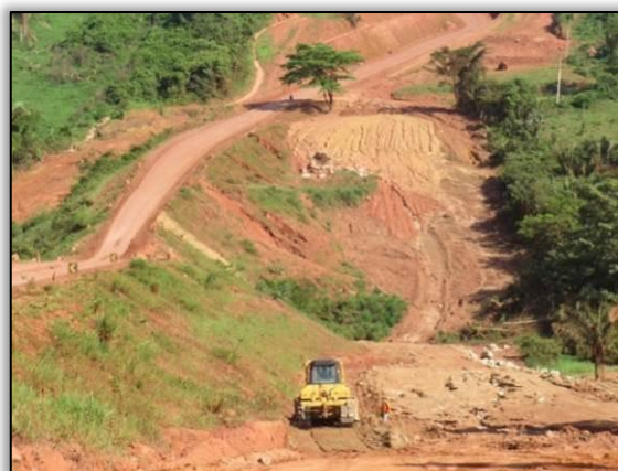
Figura 12. Acompanhamento de atividade de terraplenagem entre Novo Repartimento e Pacajá – Lote 02-A. Data: 25/01/2014
