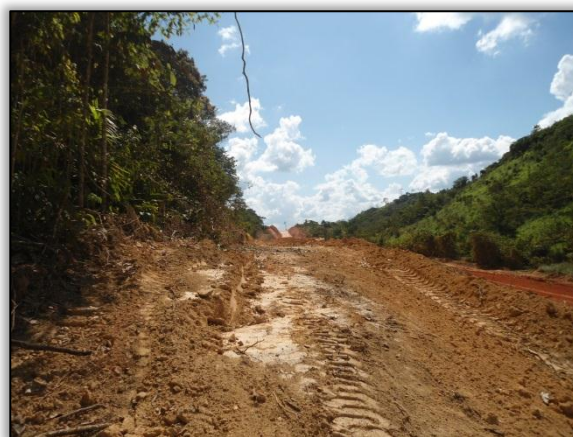
Foto 124 – Limpeza. Lado esquerdo. Estaca 7062 a 7077. S 03.86911° W 053.98865° 27/07/2015.
