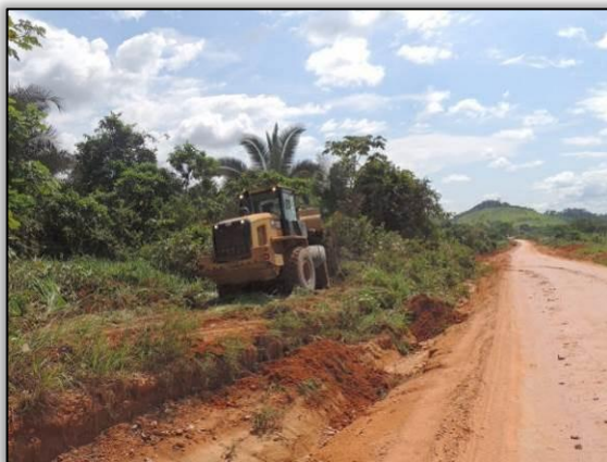
Figura 17. Limpeza lateral na faixa de domínio entre Uruará e Placas – Lote 02-B. Data: 11/02/2015 Coord. UTM 22M SAD 69 E-0109472/N-9572954
