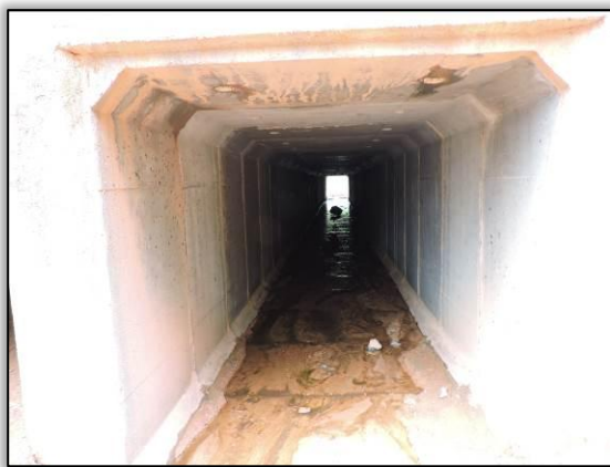
Figura 545. Interior da célula central do BTCC (janeiro de 2015). Ponto 07 - local II _ Lote 01-A Coord. UTM 22M SAD 69 E-669054 /N-9455785
