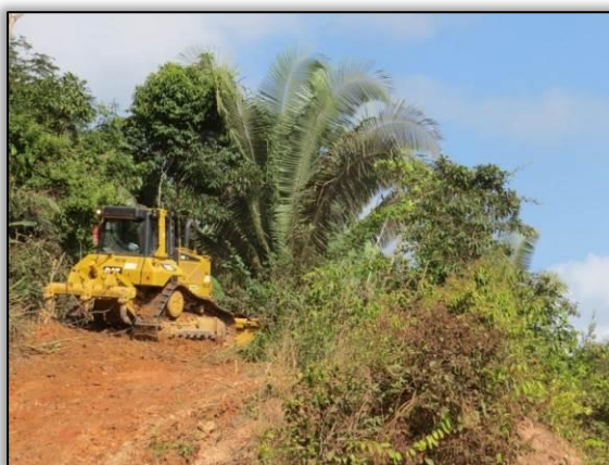
Figura 109. Acompanhamento de atividade de limpeza lateral com máquina no trecho entre Uruará e Placas – Lote 02-B. Data: 17/06/2015 Coord. UTM 21M SAD 69 E-0831120/N-9572486
