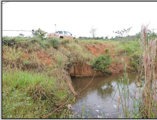
Figura 588. Água represada na saída da OAC (maio de 2015). Ponto 76 Lote 02-A Coord. UTM 22M SAD 69 E-604592/N-9538664
