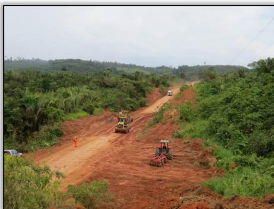
Figura 50. Acompanhamento de limpeza lateral no trecho entre as cidades de Placas e Rurópolis – Lote 03-B. Data: 31/03/2015 Coord. UTM 21M SAD 69 E-0772417/N-9567236
