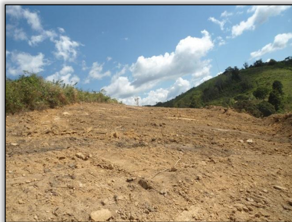
Foto 122 – Limpeza. Lado esquerdo. Estaca 7057 a 7060. S 03.86891° W 053.98756° 27/07/2015.
