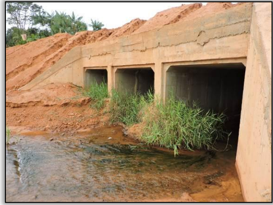
Figura 540. Montante do BTCC com leito úmido em condições normais de NA (janeiro de 2015). Ponto 07 - local I _ Lote 01-A Coord. UTM 22M SAD 69 E- 669455 /N-9455313
