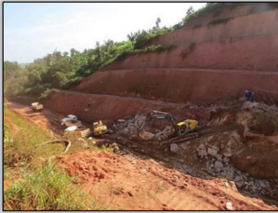
Figura 13. Acompanhamento de corte de talude entre Novo Repartimento e Pacajá – Lote 02-A. Data: 25/01/2015 Coord. UTM 22M SAD 69 E-0553904/N-9574567
