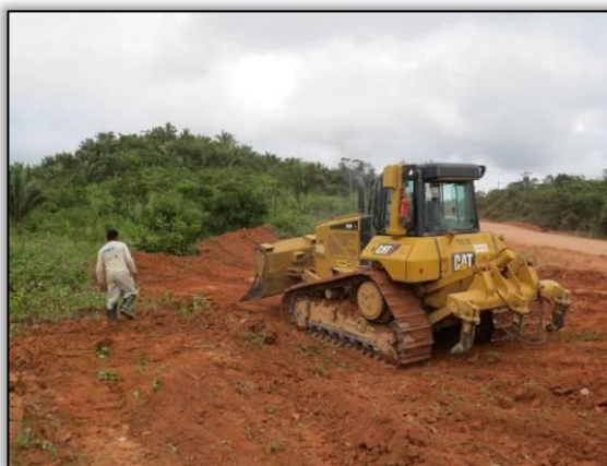
Figura 96. Vistoria de área de limpeza vegetal da faixa de domínio no trecho entre Uruará e Placas – Lote 02-B. Data: 29/05/2015 Coord. UTM 21M SAD 69 E-0831366/N-9572443
