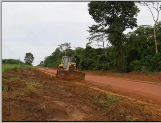
Figura 31. Acompanhamento de limpeza de pista entre Placas e Rurópolis – Lote 03-B.
