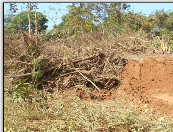
Foto 141 – Supressão vegetal (CELPA). Lado esquerdo. Estaca 8003 a 8013. S 03.85136° W 054.15067° 15/07/2015.
