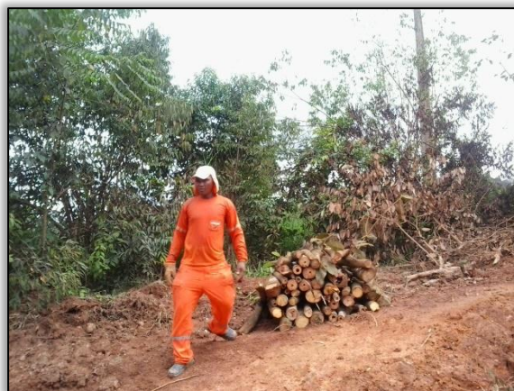
Foto 12 – Enleiramento de madeira. Lado esquerdo. S 04.8332 W 049.55069° 06/05/2015
