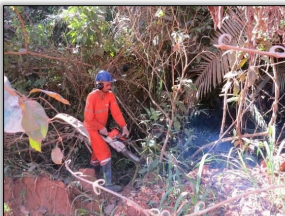
Figura 101. Acompanhamento de atividade de supressão vegetal com motosserra no trecho entre Uruará e Placas – Lote 02-B. Data: 03/06/2015 Coord. UTM 22M SAD 69 E-0173512/N-9576293
