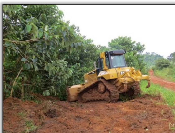
Figura 57. Acompanhamento de limpeza lateral entre Uruará e Placas – Lote 02-B.
