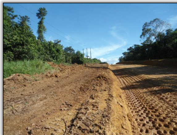
Foto 161 – Limpeza. Lado esquerdo. Estaca 10860 a 10910. S 03.95022° W 054.63634° 14/04/2015.
