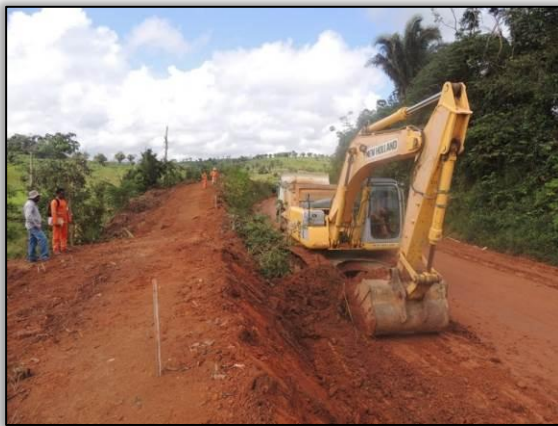
Figura 69. Limpeza de talude no trecho entre Cajazeiras e Novo Repartimento – Lote 01-A. Data: 05/05/2015 Coord. UTM 22M SAD 69 E-0660637/N-9466564
