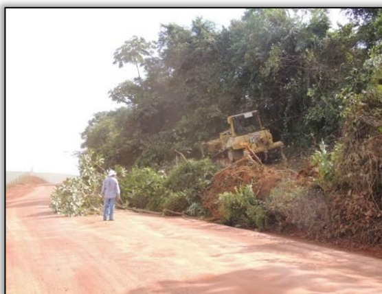
Figura 80. Acompanhamento de supressão vegetal entre Cajazeiras e Novo Repartimento – Lote 01-A.
