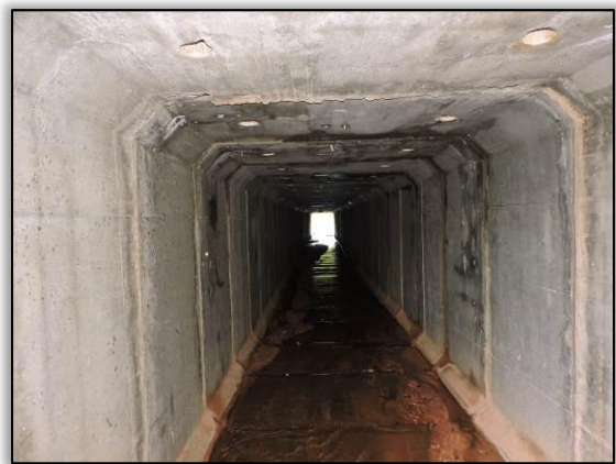
Figura 546. Interior da célula central do BTCC (maio de 2015). Ponto 07 - local II _ Lote 01-A Coord. UTM 22M SAD 69 E-669054 /N-9455785
