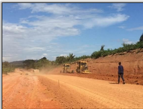
Figura 9. Acompanhamento de terraplenagem no trecho entre Uruará e Placas – Lote 02-B.
