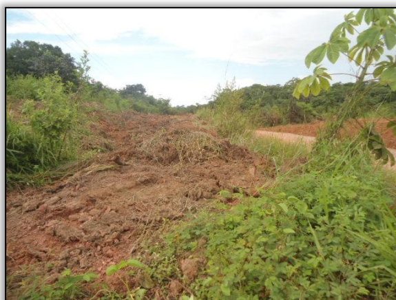
Foto 81 - Limpeza. Lado direito. Estaca 6584. S 03.81311° W 053.93570° 30/04/2015. Início.
