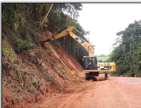
Figura 93. Acompanhamento de limpeza de talude no trecho entre Cajazeiras e Novo Repartimento – Lote 01-A. Data: 27/05/2015 Coord. UTM 22M SAD 69 E-0659328/N-9467714
