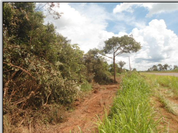
Foto 166 – Supressão vegetal (CELPA). Lado esquerdo. Estaca 8645. S 03.88411° W 054.26051°. 19/05/2015.
