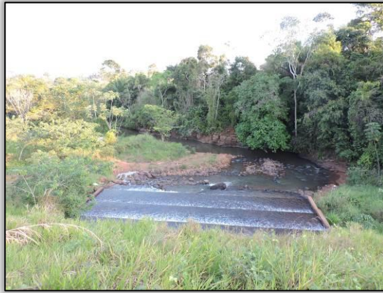
Figura 565. Jusante da OAC, local utilizado constantemente para lazer (banho e camping) Ponto 48 _ Lote 05 Coord. UTM 22M SAD 69 E-346901/N-9638876
