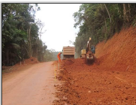
Figura 100. Acompanhamento de atividade de rebaixamento de pista no trecho entre Cajazeiras e Novo Repartimento – Lote 01-A. Data: 02/06/2015 Coord. UTM 22M SAD 69 E-0659363/N-9467642
