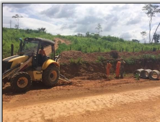
Figura 11. Acompanhamento de abertura de vala para locação de dreno, entre Cajazeiras e Novo Repartimento – Lote 01-A. Data: 25/01/2015
