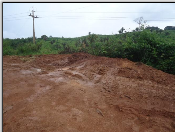
Foto 6 – Área após supressão vegetal. Lado direito. S 04.82486 W 049.55193° 04/05/2015
