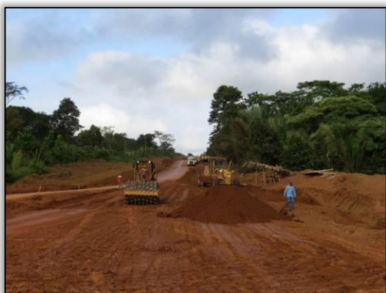
Figura 54. Acompanhamento de frente de terraplenagem entre Placas e Rurópolis – Lote 3-B. Data: 09/04/2015 Coord. UTM 21M SAD 69 E-0772427/N-9567249
