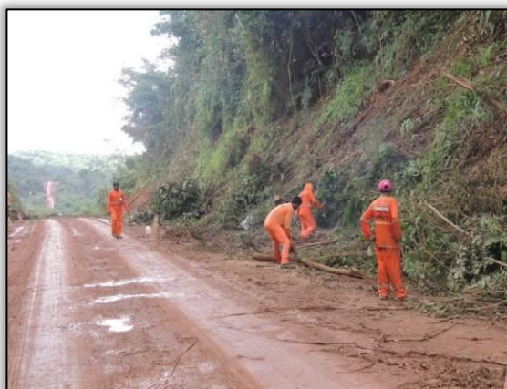
Figura 84. Acompanhamento de supressão vegetal entre Cajazeiras e Novo Repartimento – Lote 01-A.
