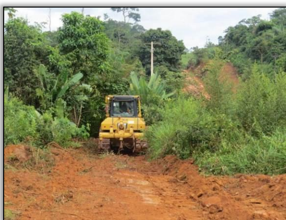
Figura 99. Acompanhamento de atividade de limpeza lateral com máquina no trecho entre Uruará e Placas – Lote 02-B. Data: 02/06/2015 Coord. UTM 21M SAD 69 E-0830838/N-9572602
