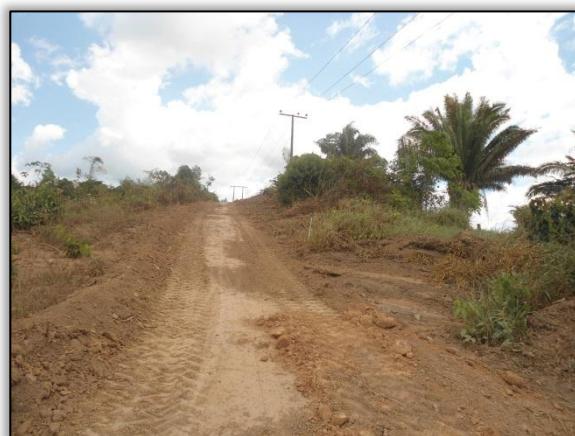
Foto 118 – Limpeza. Lado direito. Estaca 6823 a 6836. S 03.85038° W 053.95380° 27/07/2015.
