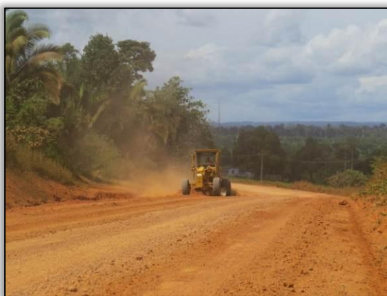
Figura 105. Acompanhamento de terraplenagem no trecho entre Placas e Rurópolis – Lote 03-B.
