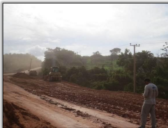
Figura 10. Acompanhamento de terraplenagem entre Novo Repartimento e Pacajá – Lote 02-A.
