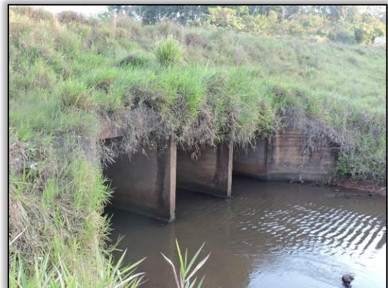
Figura 564. Montante da OAC (setembro de 2014). Ponto 48 _ Lote 05 Coord. UTM 22M SAD 69 E-346901/N-9638876
