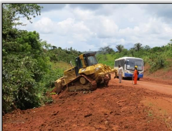
Figura 49. Acompanhamento de limpeza da faixa de domínio no trecho entre Placas e Rurópolis – Lote 03-B. Data: 30/03/2015 Coord. UTM 21M SAD 69 E-0771189/N-9566538
