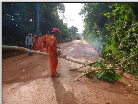
Foto 13 – Seccionamento de madeira. Lado esquerdo. S 04.81656° W 049.56150° 15/05/2015
