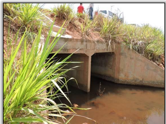
Figura 560. Boca do BDCC a montante (setembro de 2014). Ponto 38 _ Lote 03-A Coord. UTM 22M SAD 69 E-484080/N-9610099
