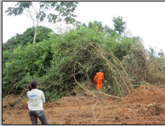
Figura 61. Acompanhamento de frente de supressão vegetal no trecho entre Uruará e Placas – Lote 02-B. Data: 27/04/2015 Coord. UTM 22M SAD 69 E-0172736/N-9575596
