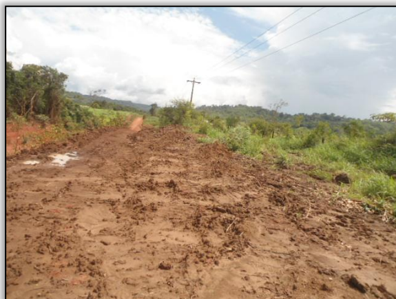
Foto 77 – Limpeza. Lado direito. Estaca 6484. S 03.80163° W 053.92294° 30/04/2015. Início.
