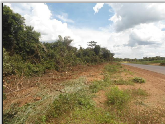
Foto 170 – Supressão vegetal (CELPA). Lado esquerdo. Estaca 8930 a 8960. S 03.89021° W 054.30777° 19/05/2015.
