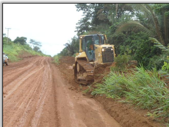
Foto 156 – Limpeza. Lado direito. Estaca 10306 a 10391. S 03.91149° W 054.54683° 30/03/2015.
