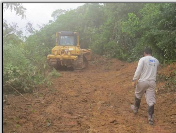
Figura 43. Vistoria de área após supressão vegetal com trator no trecho entre Placas e Rurópolis – Lote 03-B. Data: 20/03/2015 Coord. UTM 21M SAD 69 E-0767807/N-9565332
