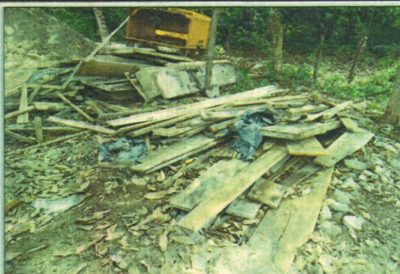
Foto 03 - Deposição inadequada de madeira. Lado direito
