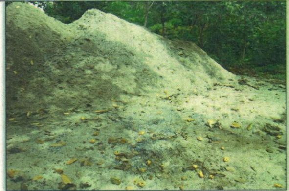
Foto 02 - Areia sem barreira de contenção. Lado Direito.
