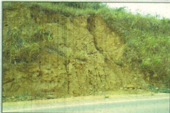
Foto 01 - Processos erosivos em talude de corte.
