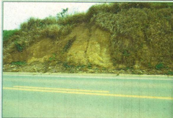
Foto 04- Processos erosivos em talude de corte.
