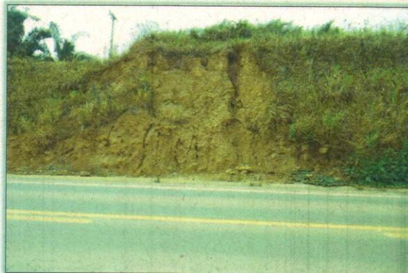
Foto 02 - Processos erosivos em talude de corte.
