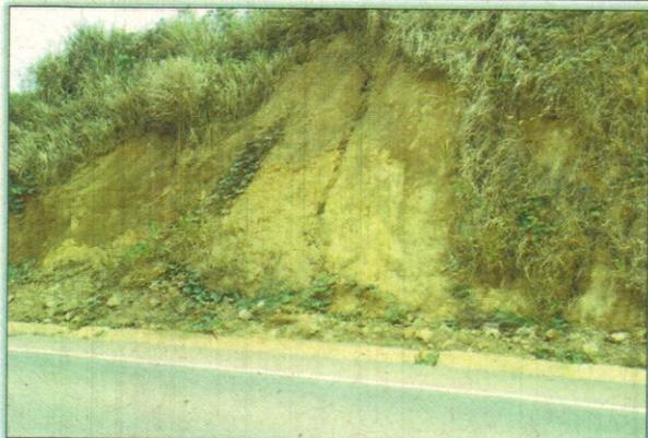
Foto 03- Processos erosivos em talude de corte.
