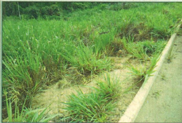
Foto 01 - Hidrossemeadura cobrindo a erosão na saia do aterro.
