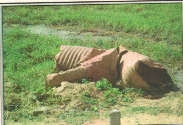
Foto 03 - Bueiro armco faixa de domínio. Lado esquerdo.
