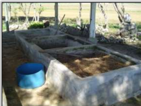
Figura 65 - Depósito de materiais.
