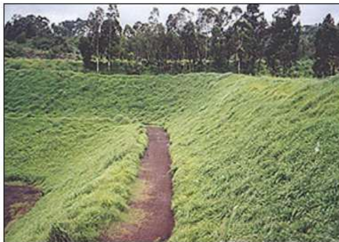
Figura 4 - Exemplo de revestimento de taludes com gramíneas. Fonte: Norma DNIT 074/2006 – ES.
