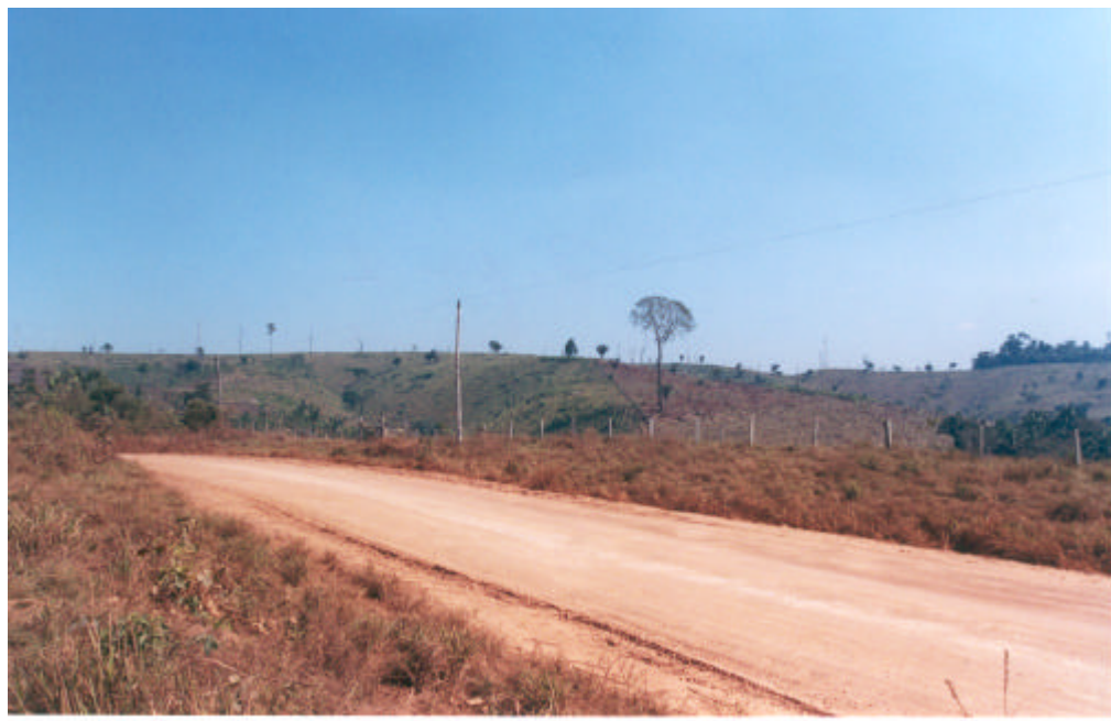
Figura 2: Pista assentada sobre solo original.
