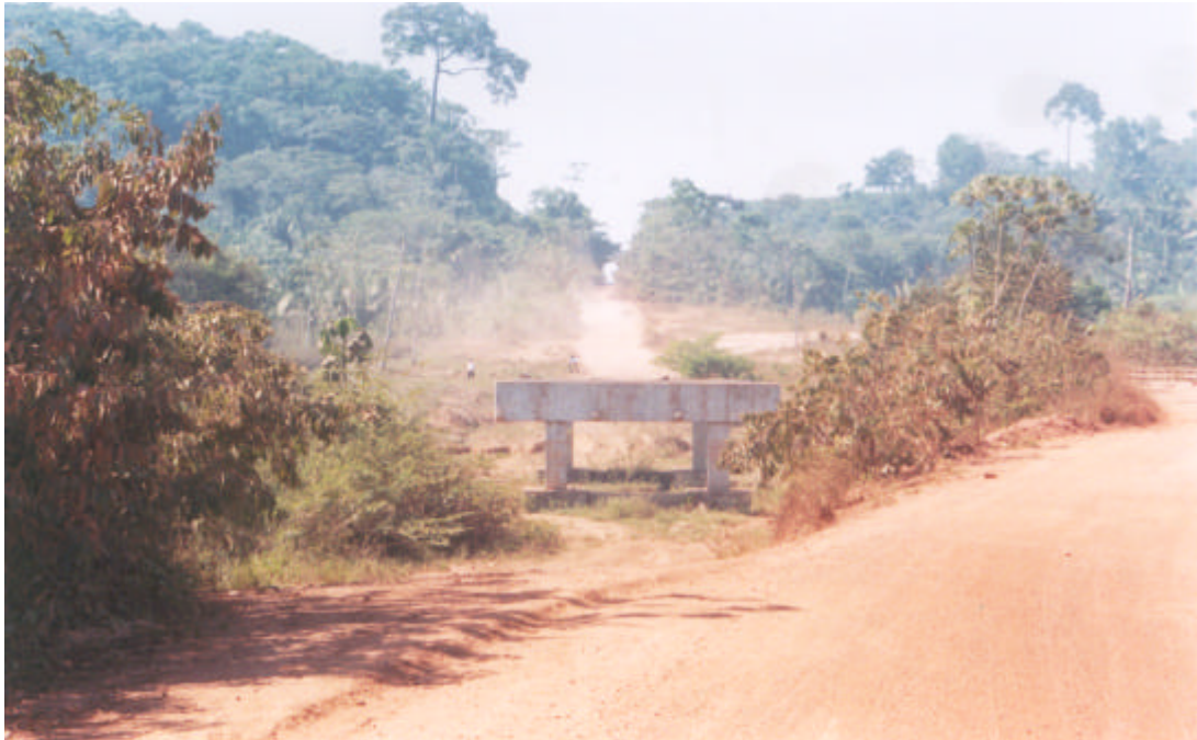
Figura 4: Ponte em construção sobre o igarapé Jacaré, km. 438, 7. Local com interferências constantes.
