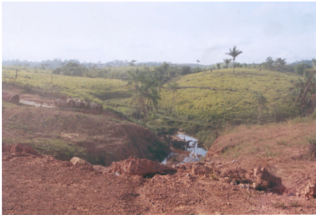
Figura 7: Igarapé canalizado sob a BR230, km 584.
