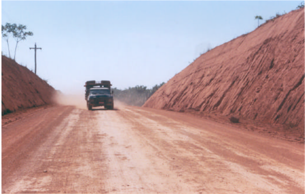
Figura 10: Trecho terraplenado, km 413. Próximo de Pacajás.
