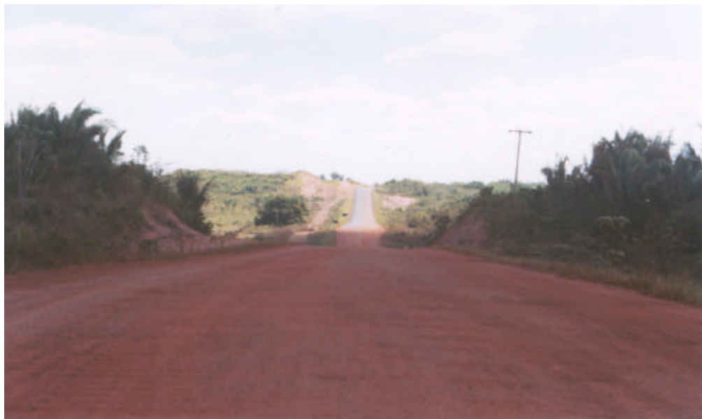
Figura 1: Início do asfalto com a pista já terraplenada (Água Morna, km.18,58).
