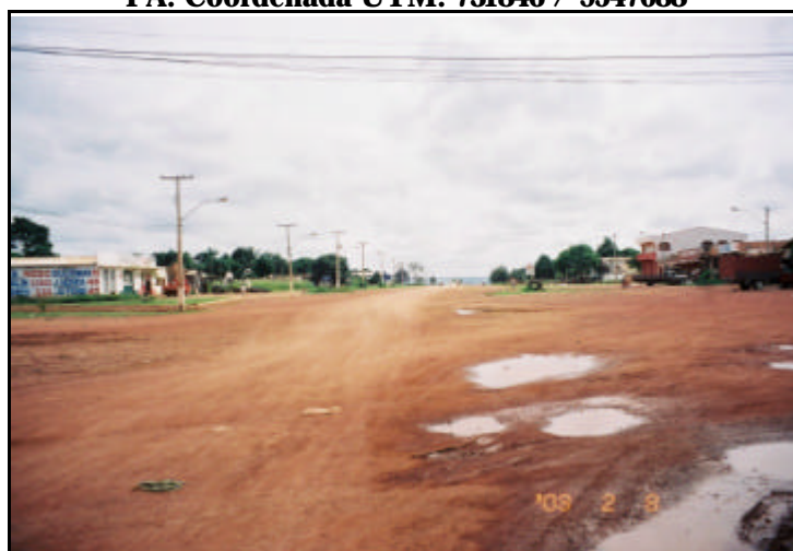
Foto 31 - Cidade de Rurópolis - PA. Aspecto da Rodovia BR-230 dentro da Cidade de Rurópolis. Coordenada UTM: 731846 / 9547088
