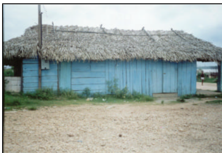
Foto 3- Vila Jarbas Passarinho - Balsa (Palestina - PA). Aspecto das residências na Vila Jarbas Passarinho. Coordenada UTM: 812809 / 9368454
