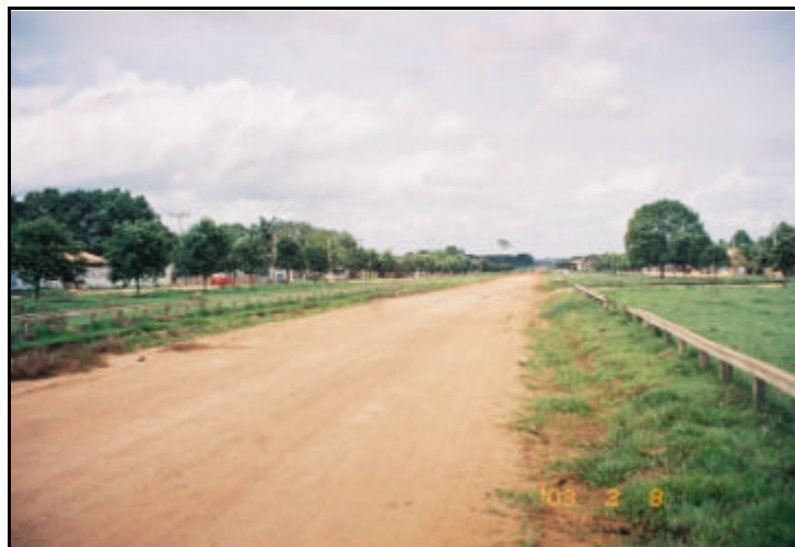
Foto 27 - Cidade de Placas - PA. Aspecto da Rodovia BR-230 dentro da Cidade de Placas. Coordenada UTM: 809468 / 9572008
