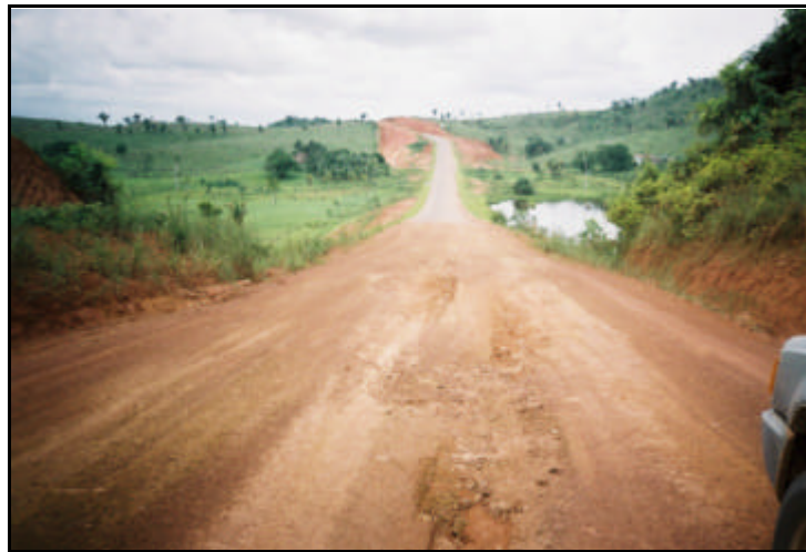
Foto 11 - Início do asfalto próximo a Pacajá - PA (Trecho de 8KM). Coordenada UTM: 547563 / 9575412
