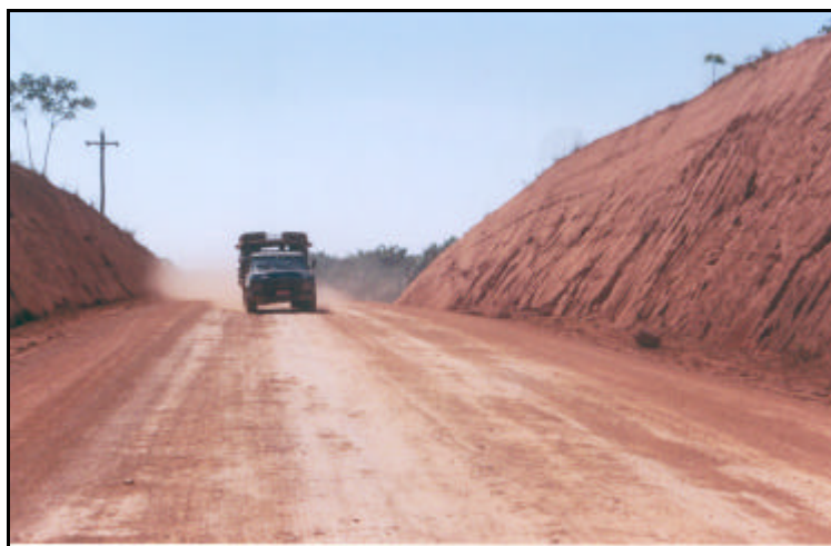
Foto 47 - Trecho terraplenado, km 413. Próximo de Pacajás.
