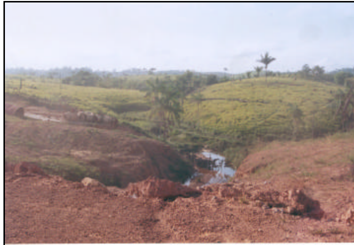
Foto 44 - Igarapé canalizado sob a BR230, km 584.
