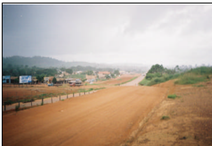
Foto 15 - Município de Anapú - PA. Aspecto da BR-230 em Anapú-PA. Coordenada UTM: 477537 / 9616454
