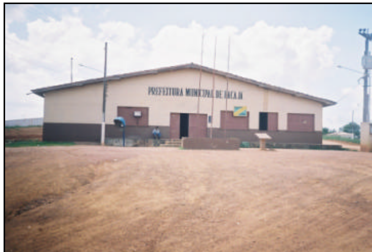
Foto 12 - Prefeitura Municipal de Pacajá - PA. Coordenada UTM: 539925 / 9576614
