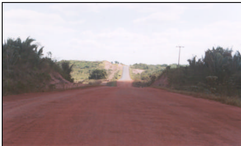
Foto 39 - Início do asfalto com a pista já terraplenada (Água Morna, km.18,58).
