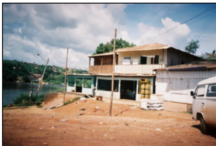
Foto 17 - Vitória do Xingú - PA, Vila Belo Monte 2 (Balsa do Rio Xingú). Coordenada UTM: 422269 / 9654414
