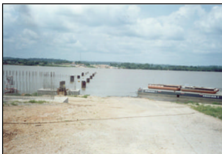
Foto 2- Proximidade do acampamento da Egesa (Araguatins-TO) Fundações da ponte Coordenada UTM: 813466 / 9367896
