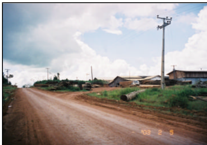
Foto 19 - Rodovia BR-230 no contorno da cidade de Altamira - PA. Coordenada UTM: 363054 / 9646840
