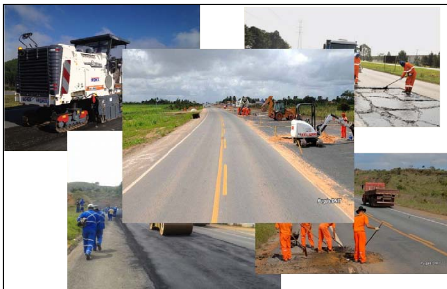
Figura 26 – Obras de manutenção.
