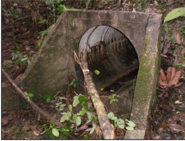
Figura 49 - Bueiro Simples Tubular em Metal da BR-174.
