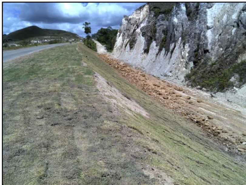
Figura 63 – Talude revegetado com placas de grama. Coordenada UTM: 20N 705.589E/494.490N. Data: 28/01/2014. Fonte: Equipe técnica do DNIT.
