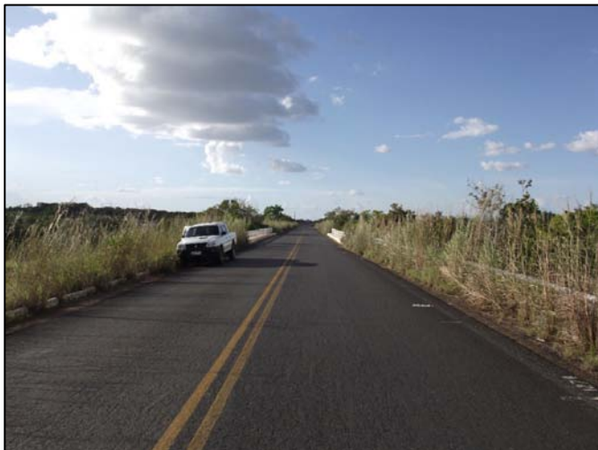
Figura 97 – Trecho da BR-174/RR sem acostamento. Fonte: Equipe DNIT – Nov/2013.
