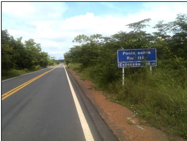
Figura 6 - Segmento da BR-174/RR sem acostamento. Ponte sobre o Rio Itã. Coordenadas: 1°27'6.15"N / 60°45'5.39"W. Fonte: Equipe DNIT – Nov/2013.
