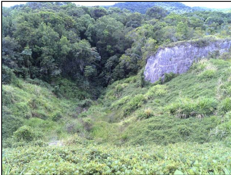
Figura 62 – Área recuperada. Coordenada UTM: 20N 705.827E/494.116N. Data: 28/01/2014. Fonte: Equipe técnica do DNIT.
