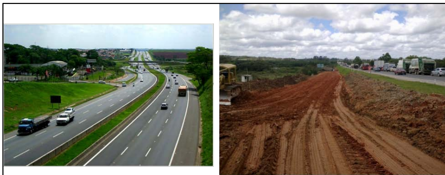
Figura 25 – Rodovia duplicada e obras de duplicação.
