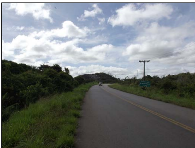
Figura 98 - Trecho da BR-174/RR sem acostamento. Fonte: Equipe DNIT – Nov/2013.
