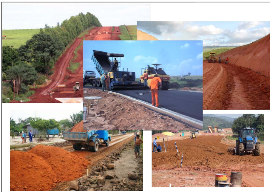
Figura 22 – Atividades típicas de implantação de rodovia.
