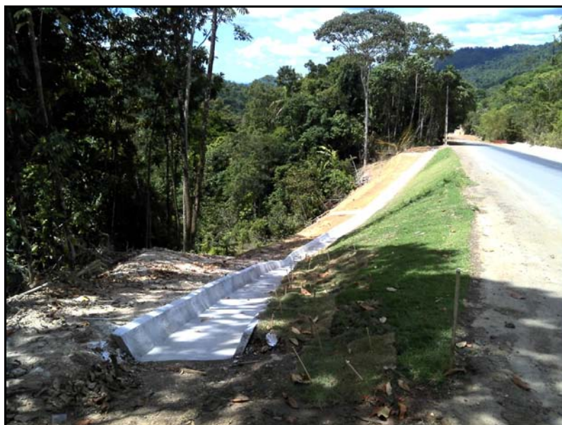
Figura 60 – Talude de aterro revegetado com gramíneas e sistema de drenagem readequado. Coordenada UTM: 20N 708.895E/489.768N Data: 28/01/2014. Fonte: Equipe técnica do DNIT.
