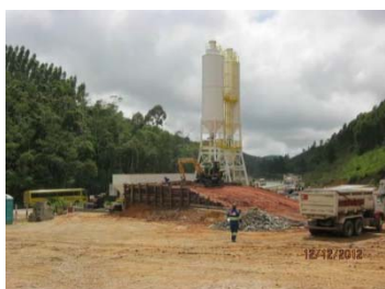
Foto 2.1.h: Instalações industriais provisórias
