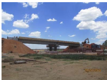
Foto 2.1.g: Implantação de novos viadutos nos novos retornos da rodovia
