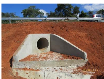
Foto 2.1.d: Execução de sistema de drenagem – Bueiros e galerias
