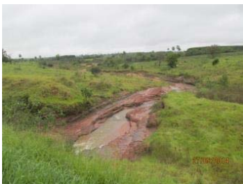
Foto 4.4.c: Área de Preservação Permanente degradada na faixa de domínio
