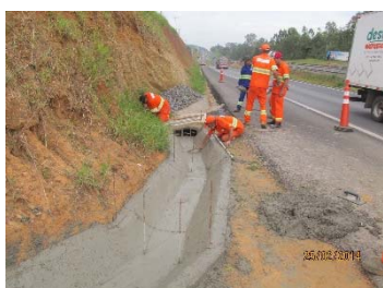
Foto 2.1.c: Execução de sistema de drenagem – canaleta
