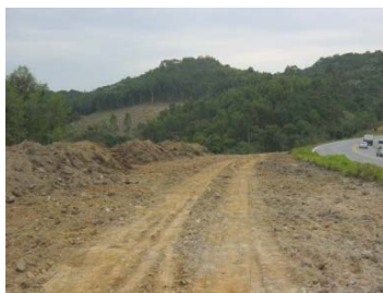
Foto 2.1.a: Limpeza do terreno e remoção da vegetação
