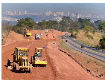
Foto 2.1.b: Terraplanagem e Movimentação de Terra
