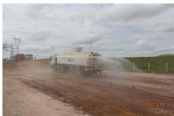
Foto 7.0.c: controle de emissões atmosféricas (suspensão de poeira) – umectação de vias por caminhão-pipa
