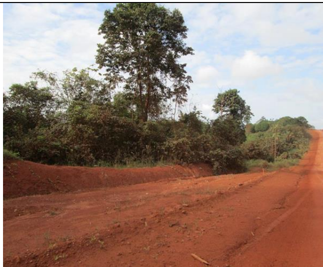
Foto 600 - PAM 87 - Solo exposto aos agentes erosivos. Data: Fevereiro de 2016.
