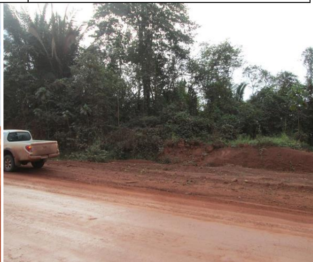
Foto 601 - PAM 87 - Área sem medidas de recuperação. Data: Fevereiro de 2016.
