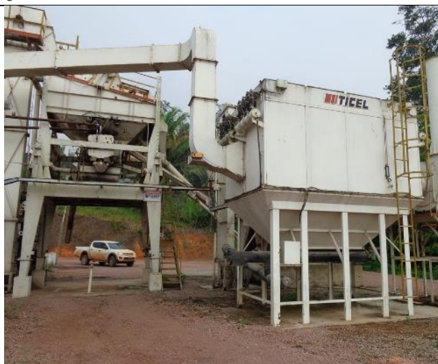
Foto 535 – Usina de asfalto paralisada. Data: Janeiro de 2016.
