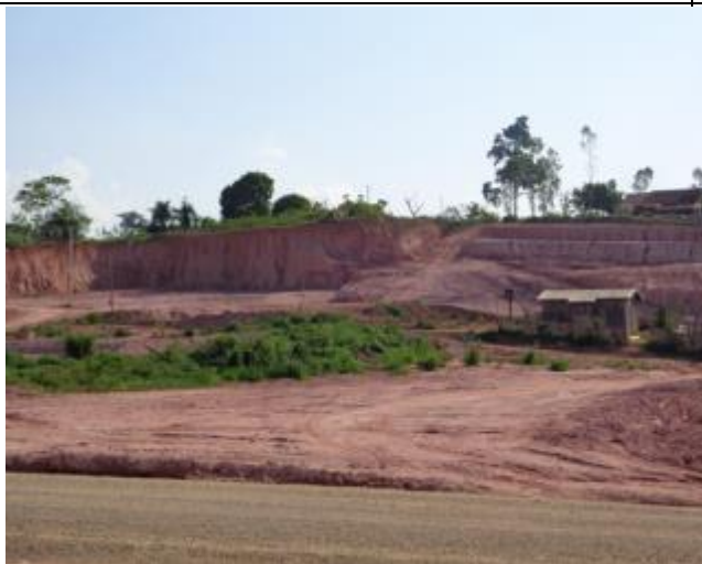
Foto 339 – Construção particular. Data: Novembro de 2014
