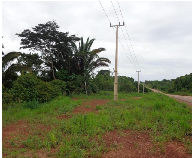
Foto 543 - PAM 04 - Área sem medidas de recuperação. Data: Fevereiro de 2016.
