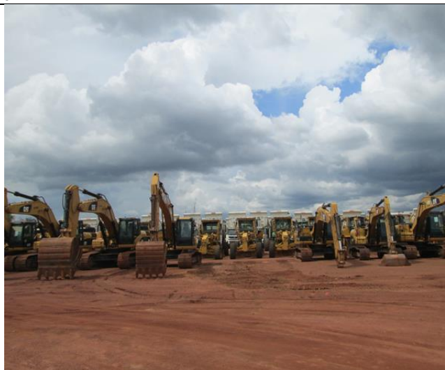
Foto 646 - Maquinários estacionados no pátio do Canteiro de Obras. Data: Fevereiro de 2016.
