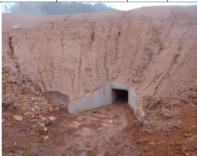
Foto 31 – Ponto 06 - Bueiro Estaca 1857 com processos erosivos em talude (LE). Coordenada UTM 701500-9542776. Data – Dezembro de 2015
