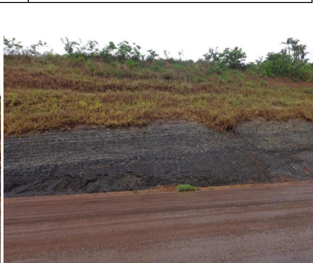
Foto 609 - PAM 91 - Talude exposto aos agentes erosivos. LD. Data: Fevereiro de 2016.
