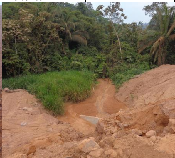
Foto 32 – Ponto 06 - Bueiro Estaca 1857 com assoreamento (LD). Coordenada UTM 701500-9542776. Data – Dezembro de 2015
