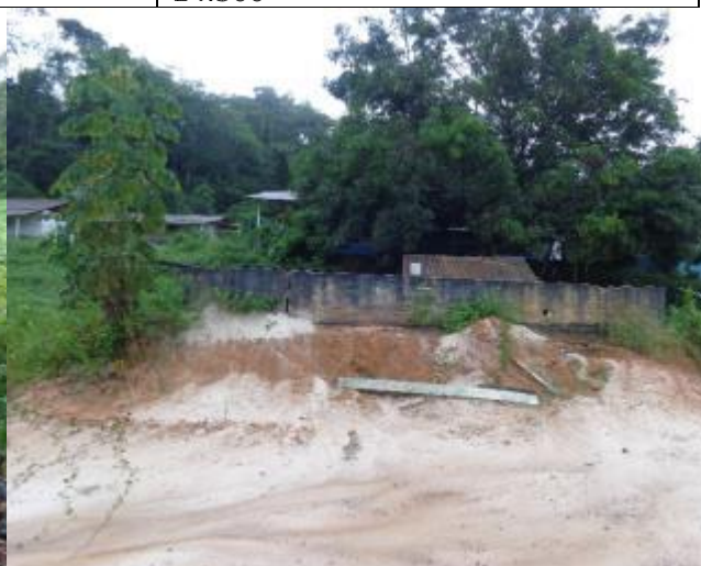
Foto 82 – Posto de abastecimento desativado. Data: Maio de 2016.
