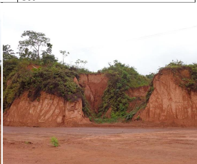
Foto 611 - PAM 92 - Talude com processos erosivos. Data: Fevereiro de 2016.
