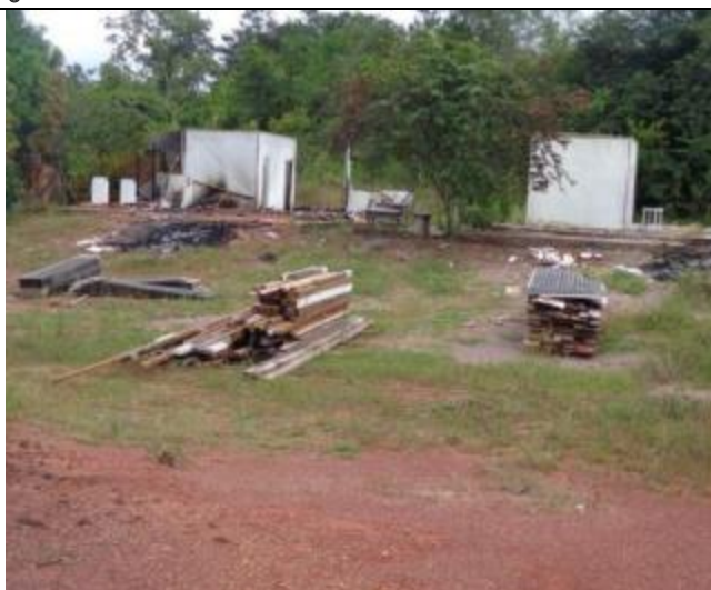
Foto 189 – Estruturas sendo desmontadas. Data: Maio de 2016.
