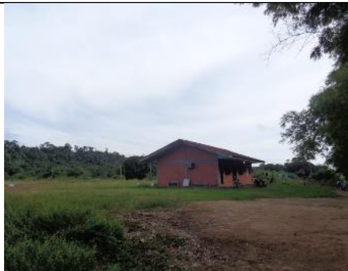
Foto 345 – Canteiro de obras com recuperação incompleta. Há parcelas de solo exposto. Data: Abril de 2016
