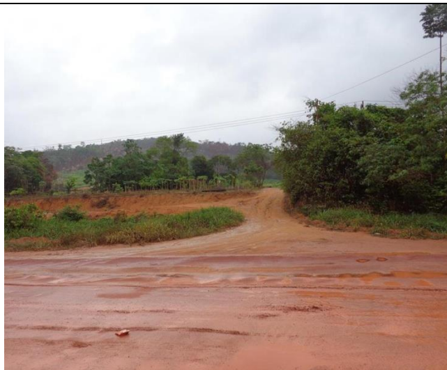
Foto 618 - PAM 96 - Caixa de empréstimo sem medidas de recuperação. Data: Fevereiro de 2016.
