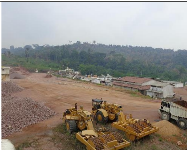
Foto 531 – Canteiro de obras. Data: Janeiro de 2016.
