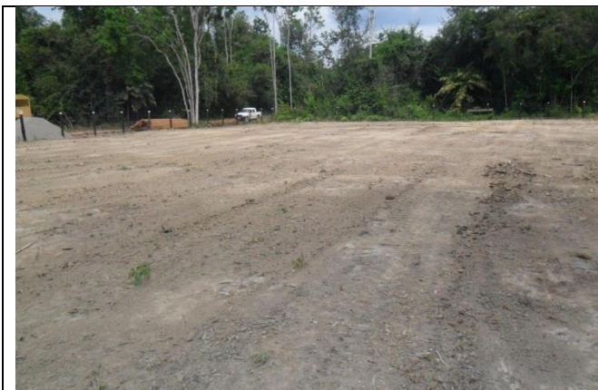
Resultado final do serviço: Terreno totalmente plano e sem irregularidades, pronto para as instalações
