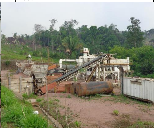
Foto 536 – Maquinários da usina de asfalto. Data: Janeiro de 2016.
