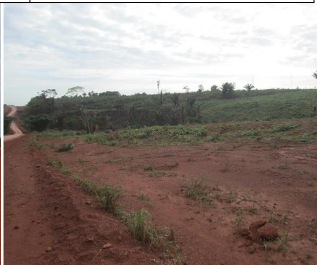
Foto 593 - PAM 83 - Área com carreamento de solo. Data: Fevereiro de 2016.
