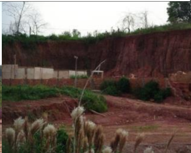
Foto 338 – Novas construções no local. Data: Julho de 2015
