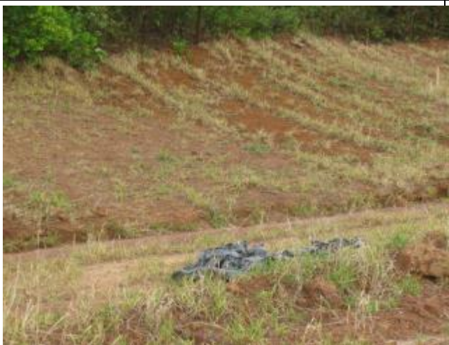
Foto 145 - Cobertura vegetal em desenvolvimento no talude do passivo (LD). Data: Novembro de 2013.
