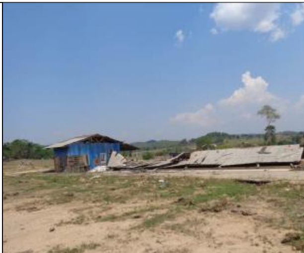
Foto 300 – Estruturas a serem retiradas. Data: Abril de 2016.
