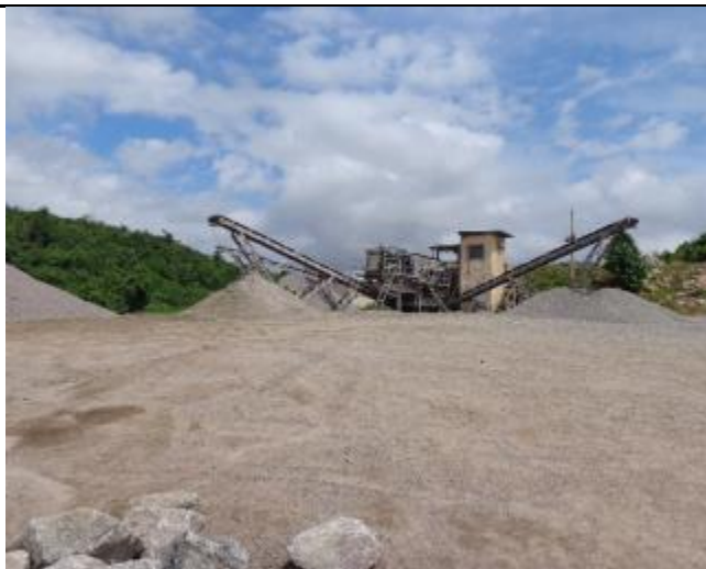
Foto 83 – Vista geral do britador. Data: Maio de 2016
