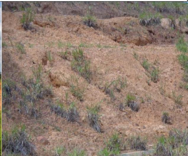
Foto 150 – Focos de processos erosivos. LD. Data: 28/03/2016.
