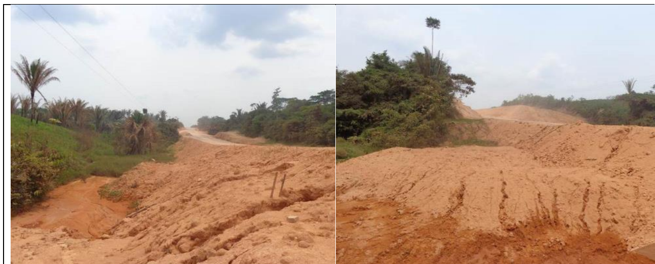
Foto 21 – Ponto 02 - Processo erosivo em talude de aterro. Assoreamento (LD). Coordenada UTM 0593821/9439259. Estaca 15374. Data – Novembro de 2015
