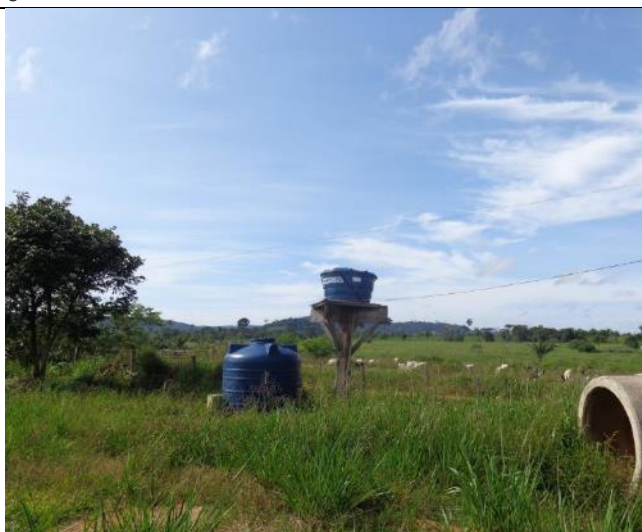
Foto 327 – Caixas d'água que abastecem o canteiro de obras. Data: Maio de 2016
