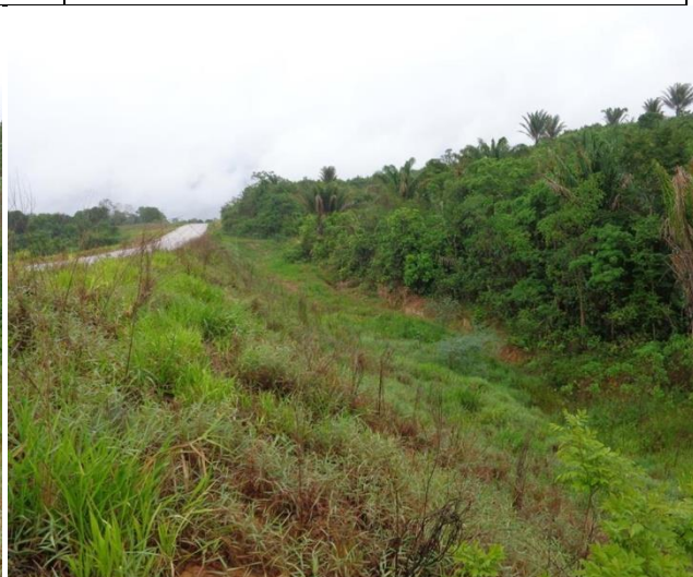
Foto 643 - Canal de drenagem com cobertura vegetal. LE. Data: Fevereiro de 2016.
