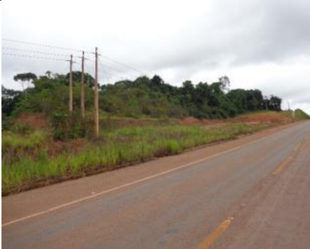
Foto 37 - PAM 06: Área de empréstimo com recuperação incompleta. (LD). Data: Maio de 2016.
