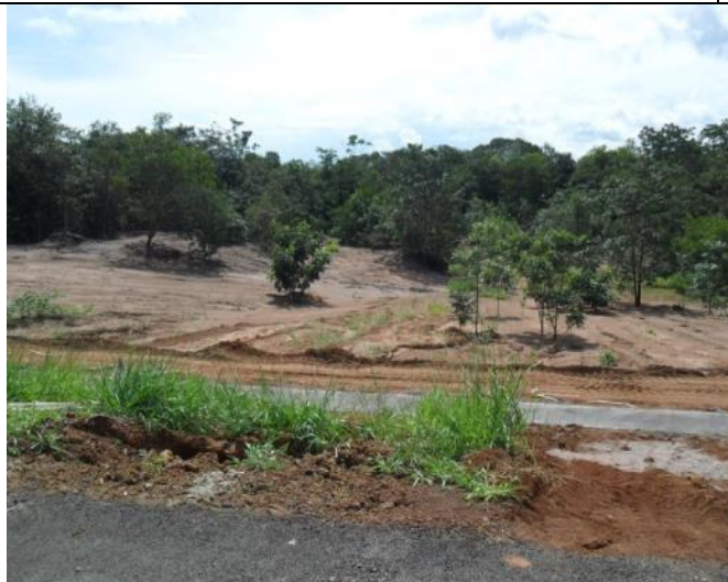
Foto 105 – PAM 02 - Área de aplicação de hidrossemeadura. LE. Data: Janeiro de 2015
