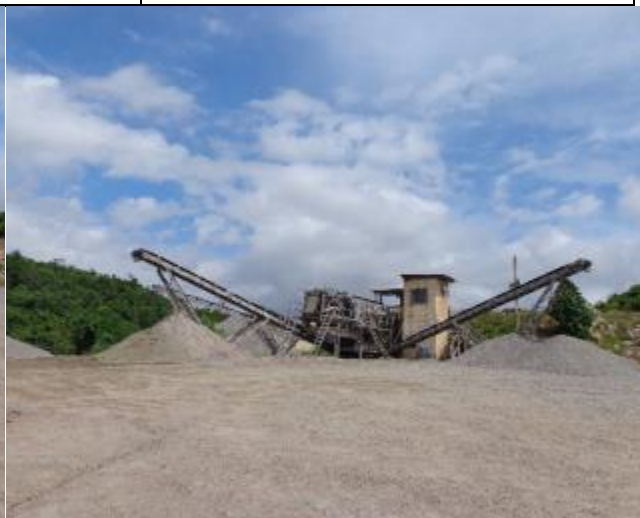
Foto 84 – Vista geral do britador. Data: Maio de 2016.
