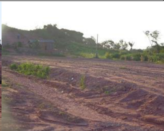
Foto 340 – Início de instalações na área. Data: Julho de 2015
