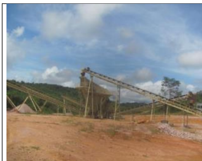
Foto 389 – Equipamento inoperante. Data: Abril de 2016.
