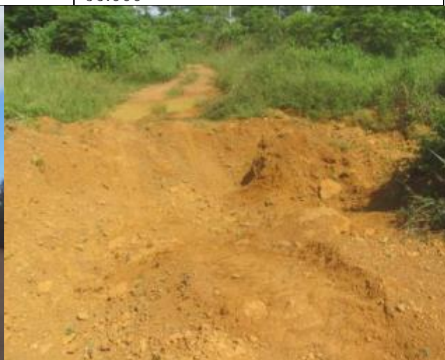
Foto 401 – Construção de uma valeta que impede o acesso à jazida. Data: Abril de 2016.
