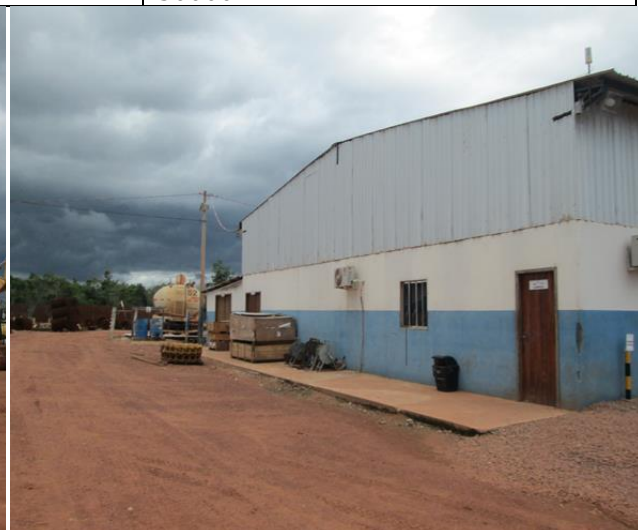
Foto 647 - Almojarifado. Data: Fevereiro de 2016.
