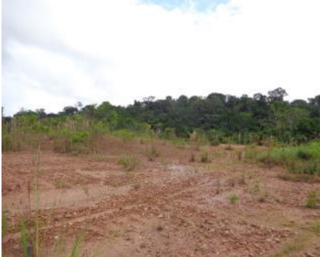
Foto 39 - PAM 07: Antiga de empréstimo transformado em bota-fora, com plantio de espécies vegetal. Data: Maio de 2016.
