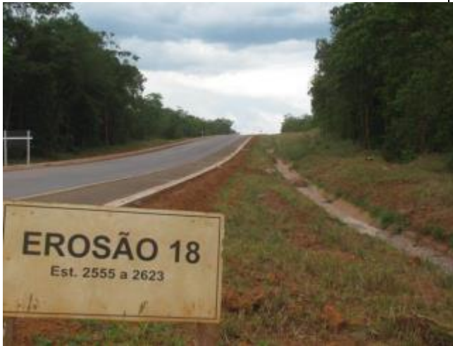
Foto 143 - Passivo recuperado, cobertura do solo implantada e sistema de drenagem superficial (LE). Data: Novembro de 2013.
