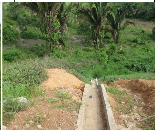
Foto 627 - PAM 100 - Escada dissipadora de energia executada. LD. Data: Fevereiro de 2016.
