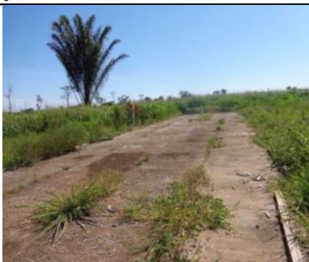
Foto 187 – Base de concreto. Data: Abril de 2016.
