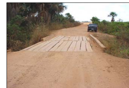
Foto 22 - Detalhe da ponte sobre o Córrego Caaporã.
