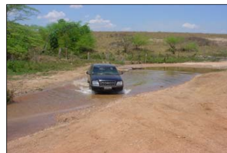
Foto 09 - Córrego Três, desvio pelo leito do rio devido a ponte danificada.
