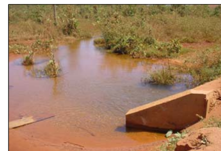
Foto 24 - Córrego Tucunduva, vista do bueiro a montante da BR-158.
