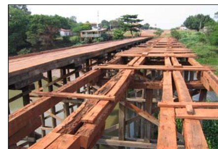
Foto 35 - Rio Tapirapé - Detalhe da ponte antiga.
