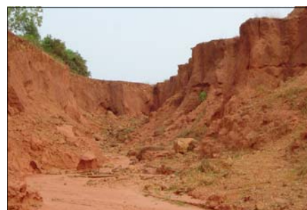
Foto 13 - Voçoroca evoluindo ao longo da faixa de domínio da estrada.
