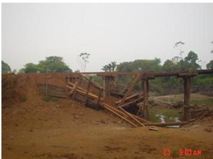
**Figura 6.1.89 - Desmoronamentos na cabeceira da ponte que transpõem o braço do rio Tapirapé ao norte da cidade de Porto Alegre do Norte.**
