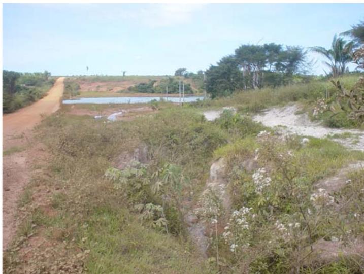
**Figura 6.1.94 - Ocorrência 119 onde ocorre uma voçoroca na faixa de domínio da estrada e em segundo plano uma área alagada.**
