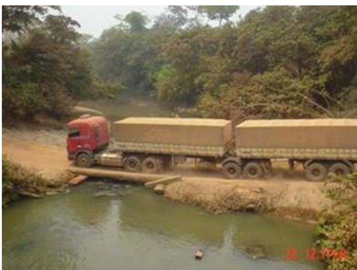
**Figura 6.1.91 - Desvio construído em virtude do desmoronamento da ponte que cruza o braço do ribeirão Santana próximo à divisa do MT/PA.**
