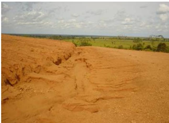
**Figura 6.1.93 - Ocorrência 161 a norte da cidade de Ribeirão Cascalheira onde o processo erosivo teve sua ignição dentro de uma área de extração localizada na faixa de domínio da estrada.**
