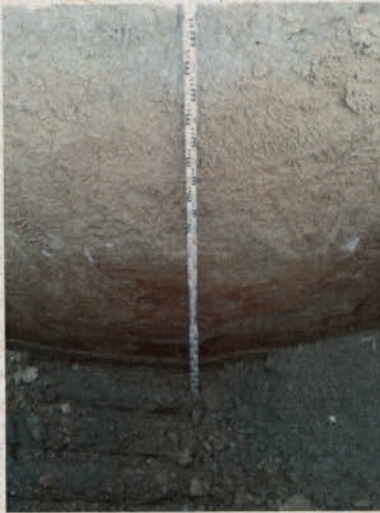
Foto 2.5.3 – Escavação até a marca de 3,6m sem encontro do lençol freático.
