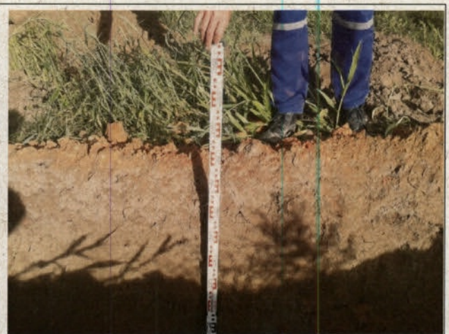
Foto 2.5.2 – Demarcação da profundidade escavada.
