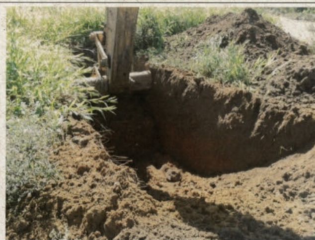
Foto 2.5.1 – Abertura da trincheira.
