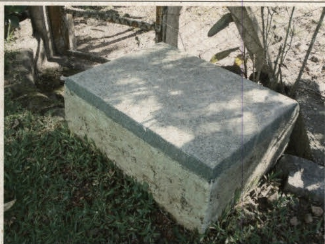
Foto 2.5.1 - Local da bomba do poço.
