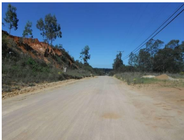
Foto 33. Trecho sobre a Rua Ivon Alcides Dias, limítrofe áreas sub-utilizadas, pavimento de terra.
