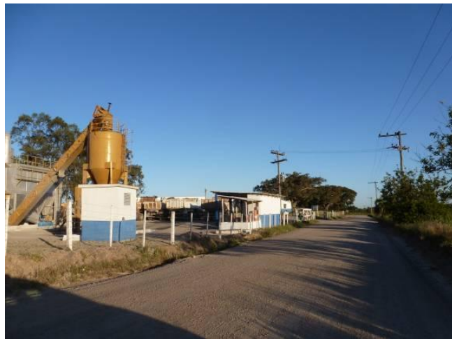
Foto 51. Unidade Mineira, com pedreira, britador e usina de asfalto, verificando-se intenso movimento de veículos pesados.
