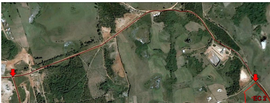
Figura 11. Segmento totalmente sobre piso de terra, inserido em áreas de uso agropastoril, com residências esparsas o aterro sanitário municipal.
