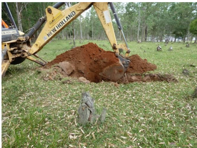
Foto 04. Início de abertura da trincheira.
