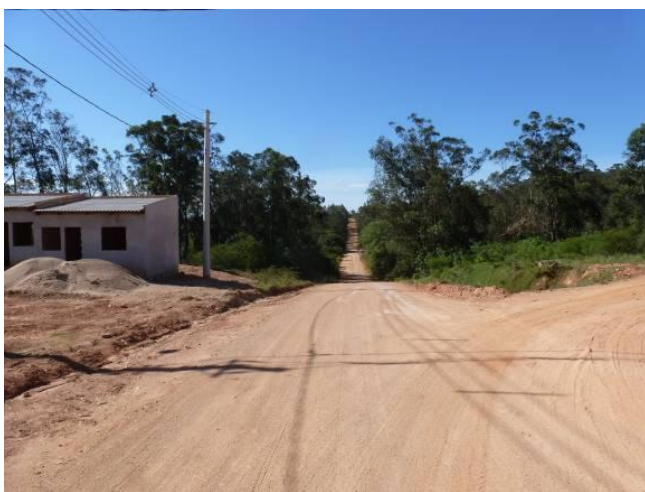
Foto 38. Início do segmento, onde está sendo implantado um loteamento de habitações populares.
