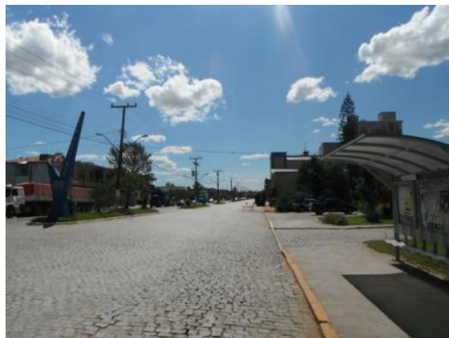
Foto 19. No início do traçado a Av. Loureiro da Silva apresenta pavimento de paralelepípedos com sensível deformação devido ao tráfego de veículos pesados.
