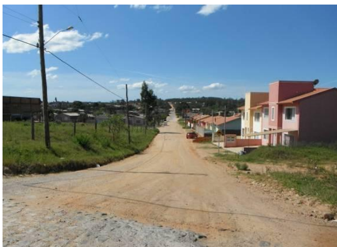
Foto 30. Segmento sobre a rua Coronel Boa Ventura, sobre pavimento de paralelepípedos irregulares e de terra, zona predominantemente residencial.
