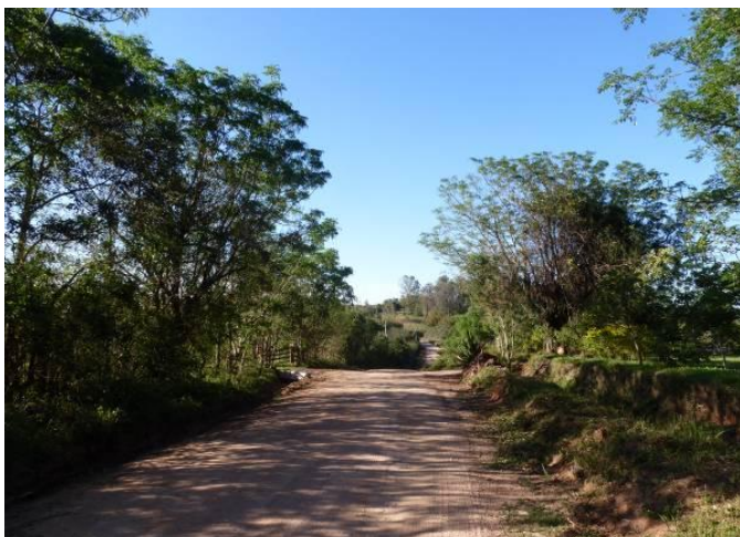
Foto 46. Trecho sobre pavimento de chão batido, inserido em áreas de uso agropastoril.
