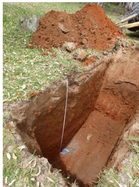
Foto 05. Detalhe da trincheira aberta.
