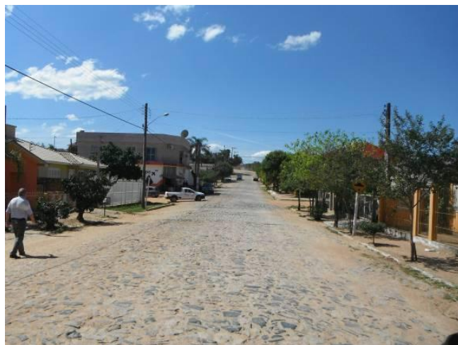
Foto 29. Segmento sobre a rua Coronel Boa Ventura, sobre pavimento de paralelepípedos irregulares, zona predominantemente residencial.
