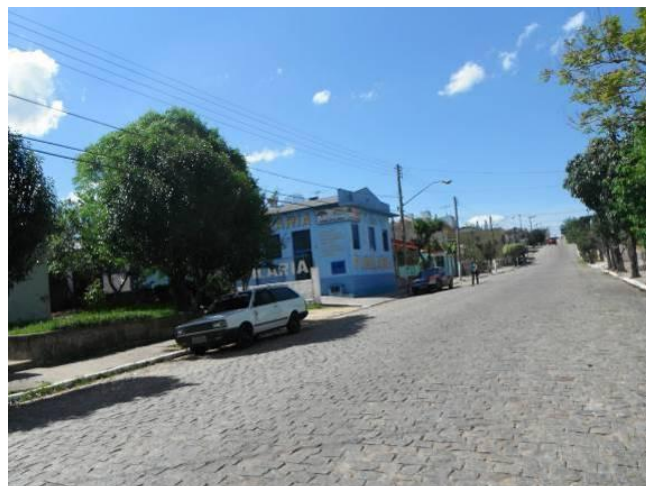
Foto 27. Segmento sobre a rua Coronel Boa Ventura, sobre pavimento de paralelepípedos regulares, zona predominantemente residencial.
