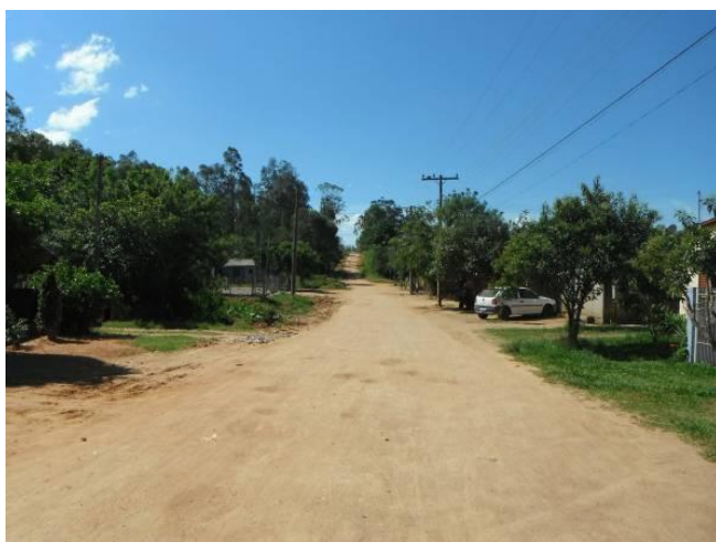
Foto 34. Trecho sobre a Rua Ivon Alcides Dias, limítrofe áreas com residências, pavimento de terra.
