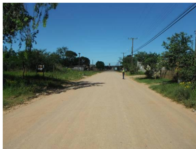
Foto 35. Trecho sobre a Rua Ivon Alcides Dias, limítrofe áreas com residências, pavimento de terra.
