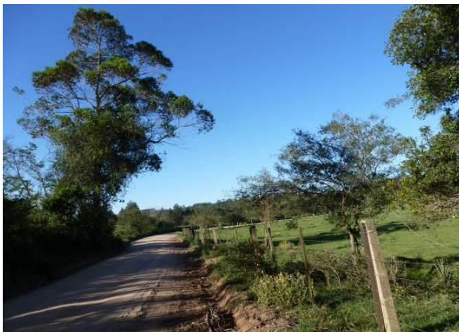
Foto 44. Trecho sobre pavimento de chão batido, inserido em áreas de uso agropastoril.
