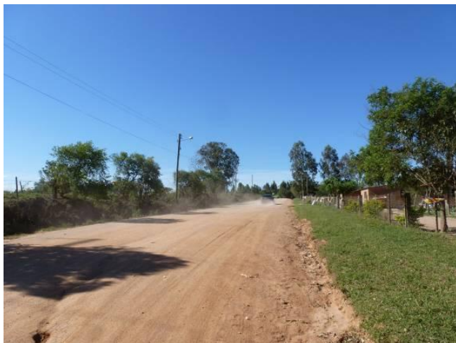
Foto 40. Trecho com áreas limítrofes com ocupação de residências esparsas.
