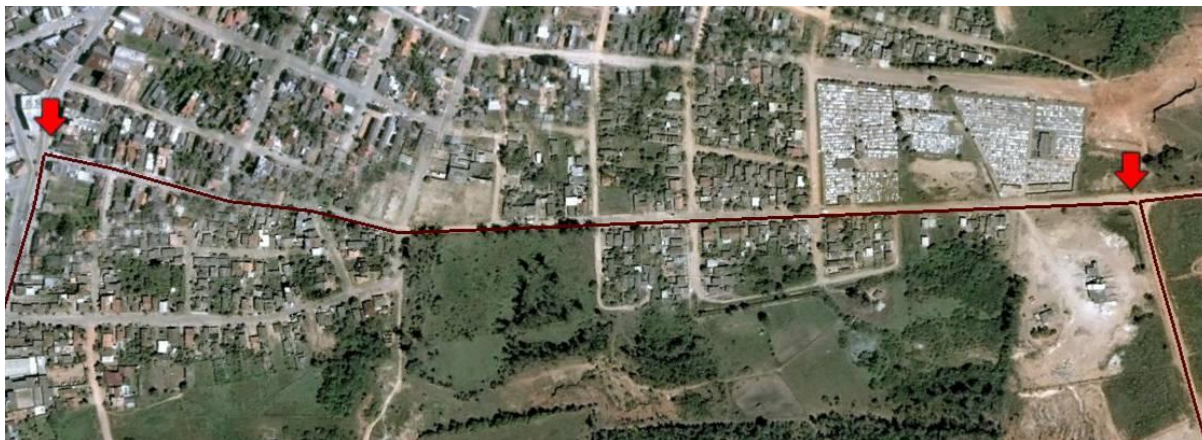
Figura 09. Segmento inserido em área preponderantemente residencial, com pavimento de paralelepípedos regulares e irregulares (potencialmente deformáveis com o trânsito de veículos pesado), bem como trechos de pavimento de saibro,
