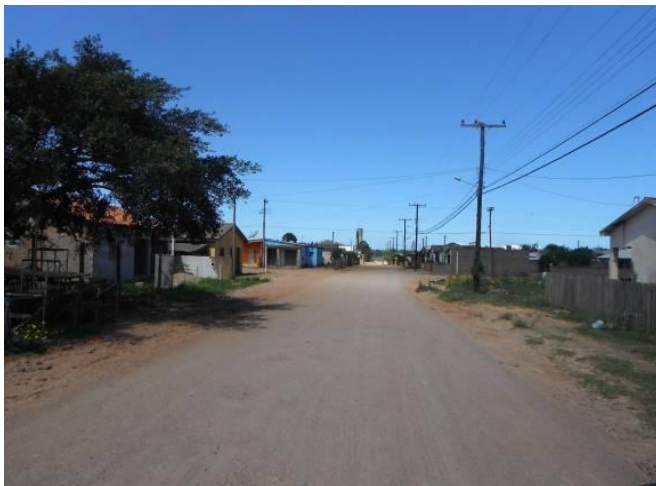
Foto 36. Trecho sobre a Rua Ivon Alcides Dias, limítrofe áreas com residências, pavimento de terra
