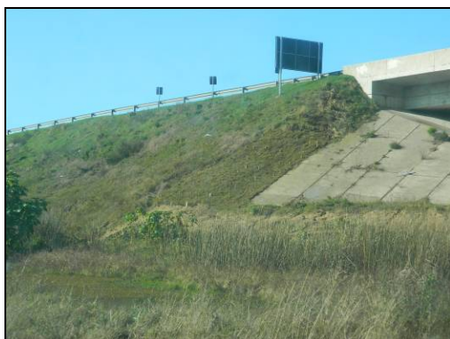
Foto 3. DEPOIS. Enleivamento e contenção do Talude do Viaduto. (L3; km 22+700; Jul/2014).
