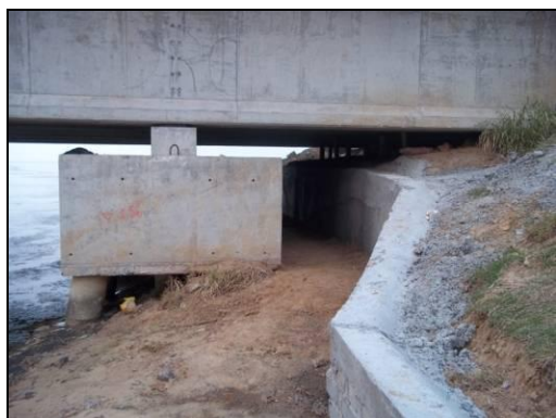
Foto 11. Adaptação original de passagem seca na cabeceira sul da ponte bolacha. Maio de 2012.
