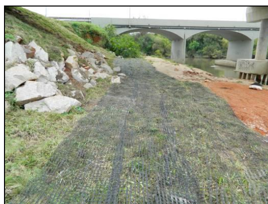
Foto 6. Leiva colocada para contenção do talude e passagem seca. Julho de 2015
