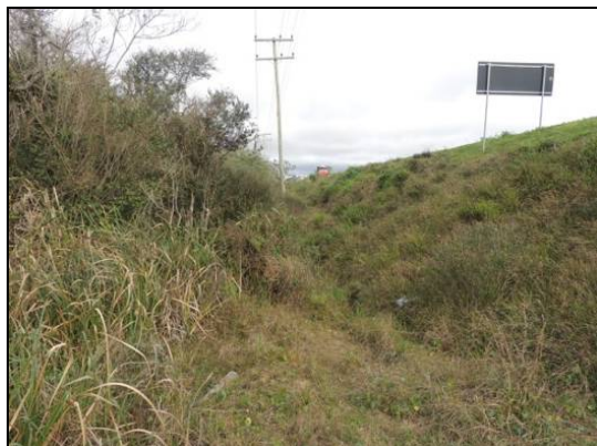
Foto 29. Passagem de fauna do km 38+640 sem tela para gado no limite da faixa de domínio no lado direito, pista nova. Agosto de 2015.
