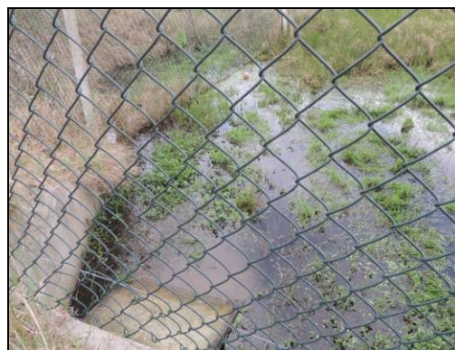
Foto 35. Passagem seca submersa (km 57+500). Agosto de 2015.
