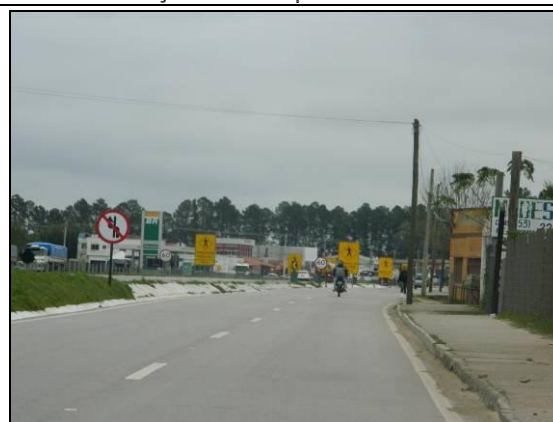
Foto 83. Pista duplicada com sinalização de trânsito implantada (L3; km 25+200; 27/07/2015).
