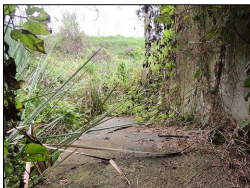
Foto 38. Vegetação obstruindo a passagem seca da passagem de fauna do km 36+420. Gosto de 2015.
