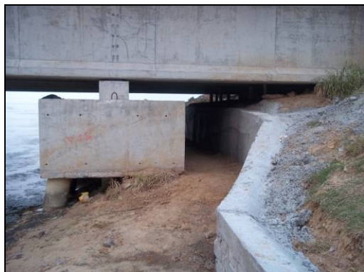
Foto 11. Adaptação original de passagem seca na cabeceira sul da ponte bolacha. Maio de 2012.
