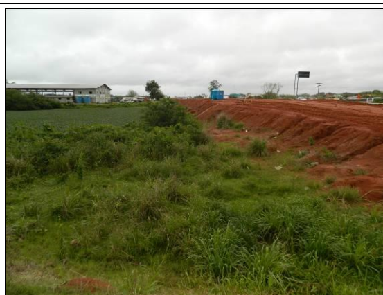
Foto 72. Ponto sensível na área industrial (L1-B; km 66+100; 31/07/2015).
