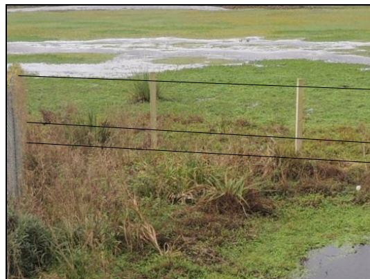
Foto 30. Passagem de fauna do km 51+780 com cerca para gado de 2 m e três fios. Agosto de 2015.
