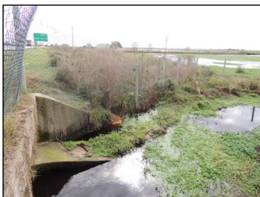
Foto 34. Taipa de solos moles para dar continuidade da passagem seca ao terreno natural vegetado (km 51+780). Agosto de 2015.
