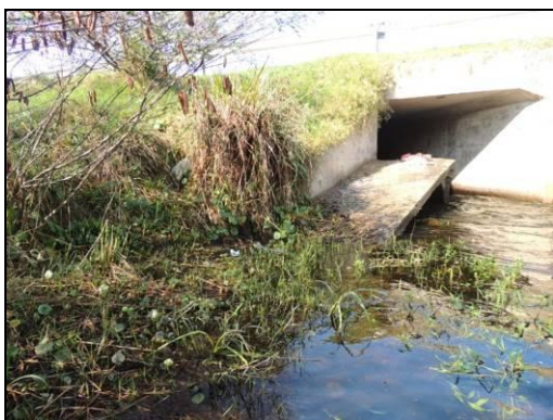
Foto 36. Passagem seca com conectividade ao terreno natural (km 23+413). Agosto de 2015.
