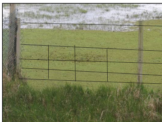
Foto 31. Passagem de fauna do km 57+500 com cerca para gado alterada para 5 fios pelo proprietário. Agosto de 2015.
