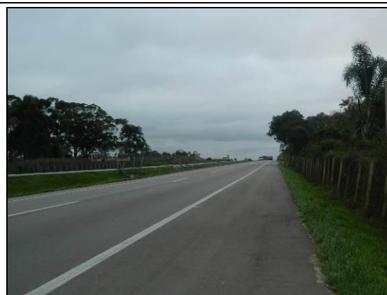
Foto 77. Pista duplicada. Sem dispositivos instalados até o momento (L2; km 38+400; 27/07/2015).
