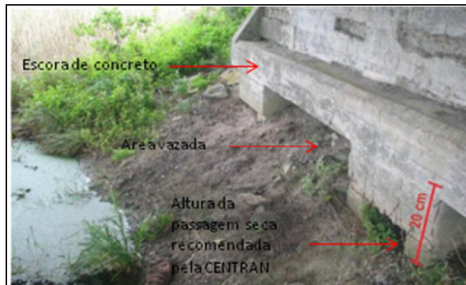
Figura 126 do relatório do CENTRAN recomendando aumentar a plataforma da ponte existente, o que eliminaria as áreas vazadas abaixo da escora de concreto (Ponte sobre o Arroio Várzea III, entre os km 53+499 e 53+525 da BR 39)
