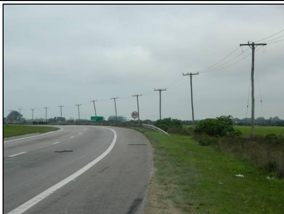
Foto 86. Defensas metálicas a pista existente (L3; km 21+613; 27/07/2015).
