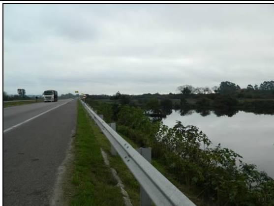
Foto 73. Região de banhado com defesa metálica (L1-B; km 64+900; 27/07/2015).
