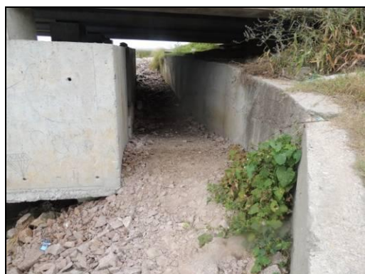
Foto 17. Adequação da passagem com material para manter ela plana e contínua. Agosto de 2014.
