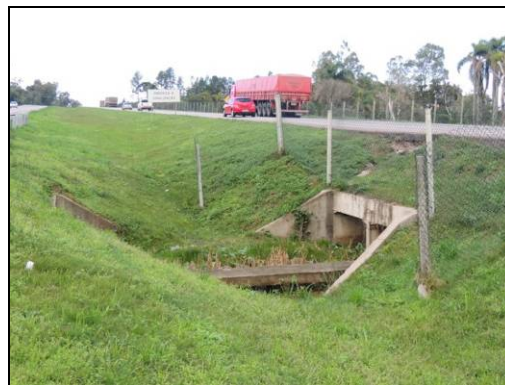
Foto 23. Canteiro central da passagem de fauna do km 36+420 sem tela. Agosto de 2015.
