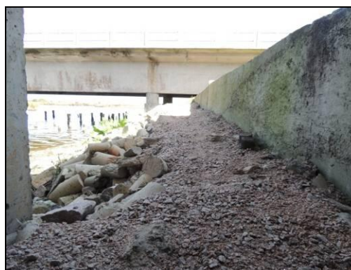
Foto 18. Adequação da passagem com material para manter ela plana e contínua. Agosto de 2014.
