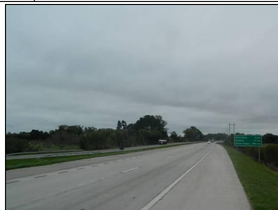
Foto 81. Pista duplicada. Sem dispositivos instalados até o momento (L3; km 28+761; 27/07/2015).
