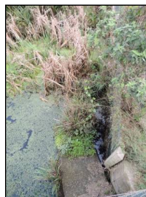
Foto 39. Taipa de solos moles para dar continuação da passagem seca ao terreno natural vegetada parcialmente (km 51+780). Agosto de 2015.
