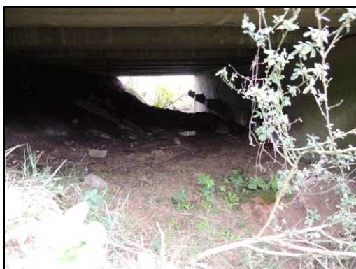
Foto 52. Vão lateral da cabeceira, na pista antiga, do Viaduto da Várzea II sem passagem ótimas para ser utilizado como passagem seca. Agosto de 2015.
