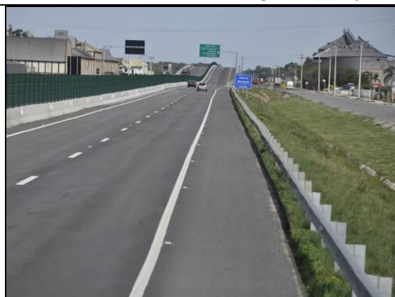
Foto 65. Situação das obras no bairro Sítio Floresta (L1-A; km 519+300; 28/07/2015).
