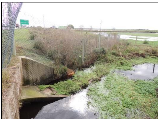
Foto 34. Taipa de solos moles para dar continuação da passagem seca ao terreno natural vegetada (km 51+780). Agosto de 2015.
