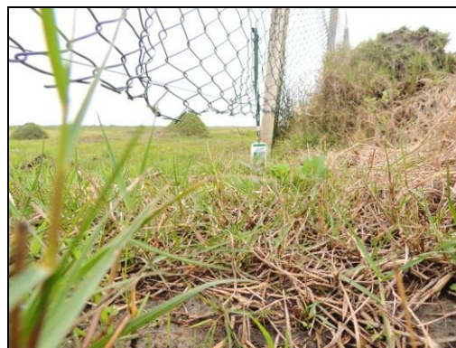
Foto 49. Tela isoladora da Várzea do Canal São Gonçalo com espaços entre a tela e o chão. Agosto de 2015.
