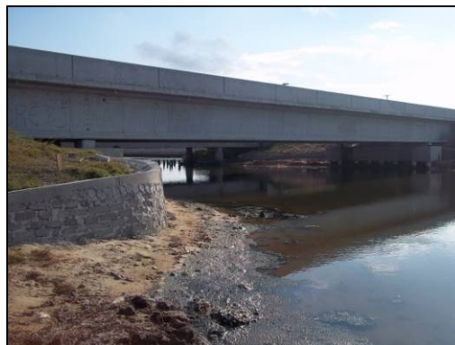
Foto 12. Adaptação original de passagem seca na cabeceira sul da ponte bolacha. Maio de 2012.
