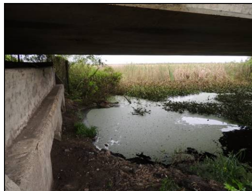
Foto 51. Cabeceira, na Pista Antiga, do Viaduto da Várzea III sem passagem seca adaptada. Agosto de 2015.
