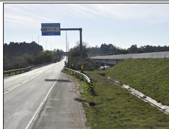
Foto 63. Ponte sobre o Arroio Pelotas (L1-A; km 512+000; 28/07/2015).
