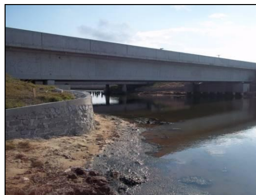
Foto 12. Adaptação original de passagem seca na cabeceira sul da ponte bolacha. Maio de 2012.
