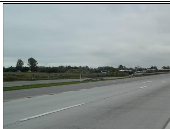
Foto 89. Defensas metálicas a pista duplicada (L3; km 15+750; 27/07/2015).
