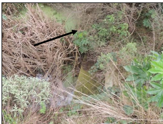
Foto 26. Passagem seca continuada ao terreno natural por meio de uma taipa de solos moles onde a vegetação está se desenvolvendo sem controle ou manutenção.
