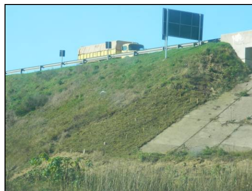
Foto 4. DEPOIS. Enleivamento e contenção do Talude do Viaduto. (L3; km 22+700; Jul/2014).
