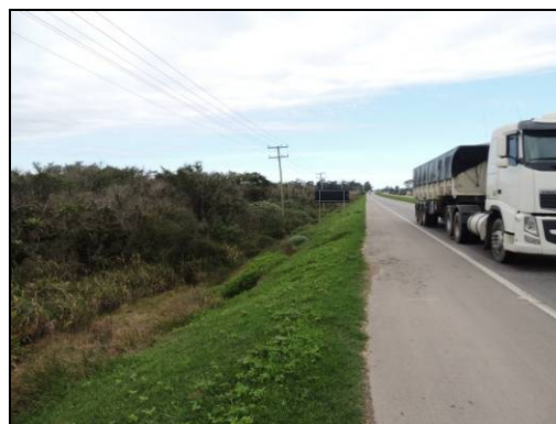
Foto 25. Cabeceiras da passagem de fauna do km 38+640 sem telamento direcionador associado.
