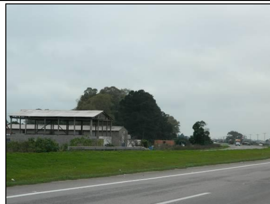
Foto 87. Defensas metálicas a pista duplicada (L3; km 21+613; 27/07/2015).
