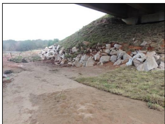
Foto 5. Leiva colocada para contenção do talude e passagem seca. Julho de 2015.
